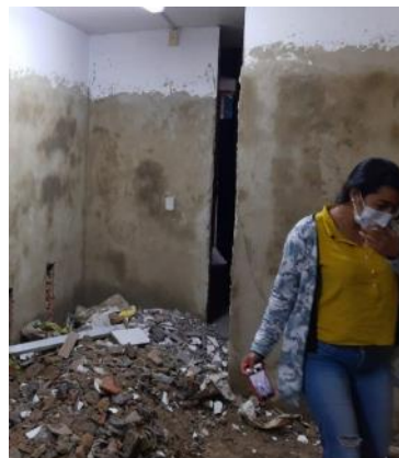
INICIO DE PAÑETE SOBRE MUROS EXISTENTES
