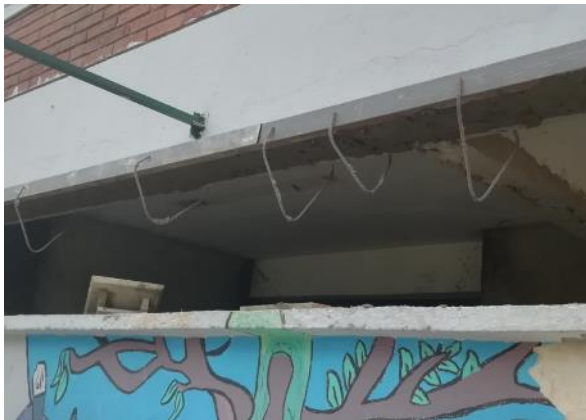
CONFORMACION DE VANOS, FILOS Y DILATACIONES EN BATERIAS SANITARIAS PRIMARIA
