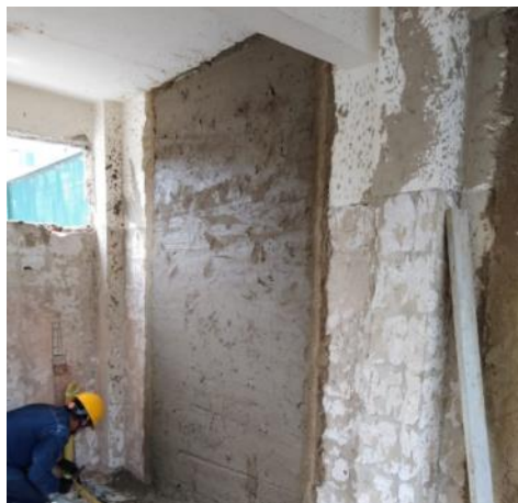
PREPARACION DE MUROS EXISTENTES PARA NUEVO PAÑETE EN BATERIAS SANITARIAS PRIMARIA
