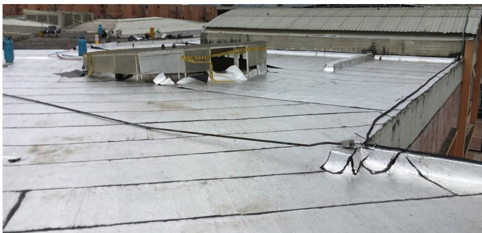
MANTO ASFALTICO INSTALADO Y SELLADO. COSTADO NOROCCIDENTAL
