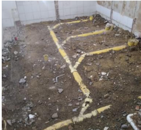
DESMONTE DE REDES HIDROSANITARIAS EXISTENTES
