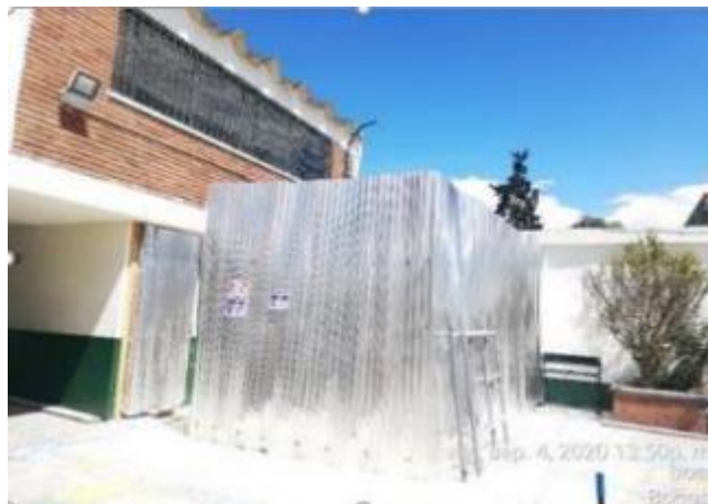
CERRAMIENTO PROVISIONAL DE OBRA
