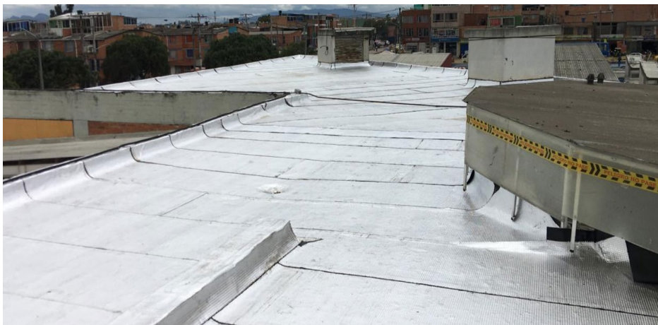
MANTO ASFALTICO INSTALADO Y SELLADO. COSTADO NORTE
