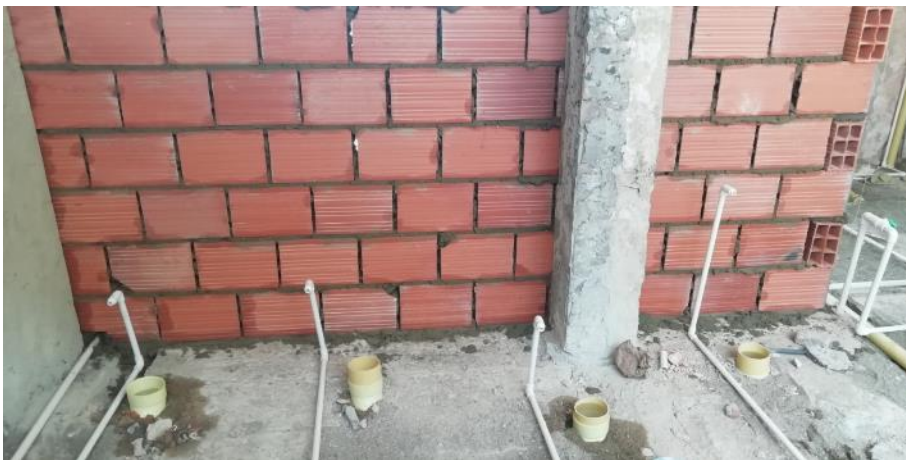
ARRANQUE DE MUROS DIVISORIOS EN MAMPOSTERIA DE ARCILLA TIPO BLOQUE EN BATERIAS SANITARIAS PRIMARIA
