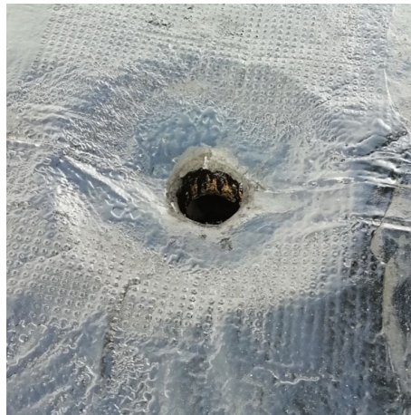
REMATE Y CONFORMACION DE PASES DE DESAGÜES Y SIFONES DE CUBIERTA
