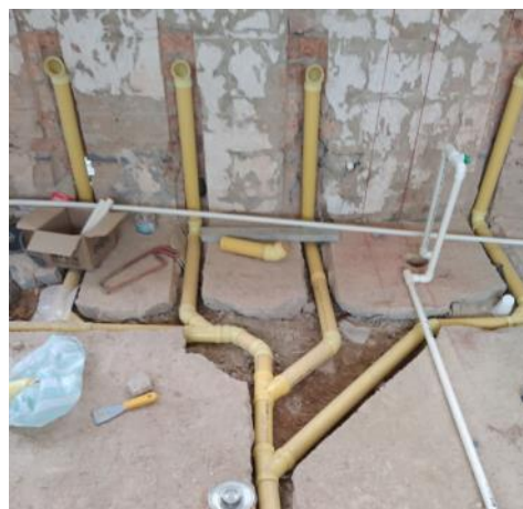
NUEVAS REDES SANITARIAS EN BATERIAS SANITARIAS PRIMARIA
