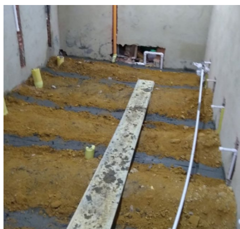
EXCAVACIÓN Y FUNDICION DE RIOSTRAS PARA SOBRE PLACA
