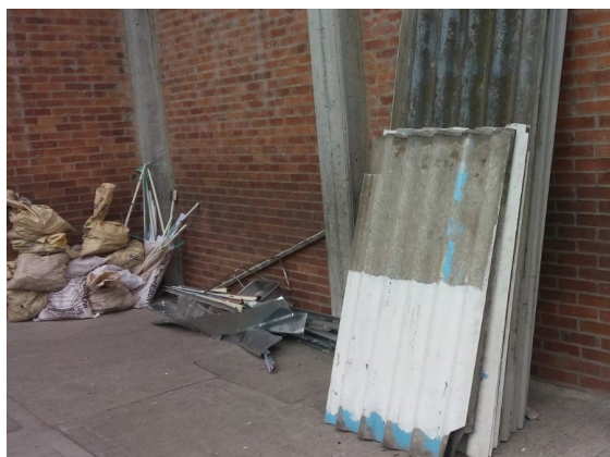
DESMONTE DE CUBIERTA TIPO ASBESTO CEMENTO EN TIENDA ESCOLAR
