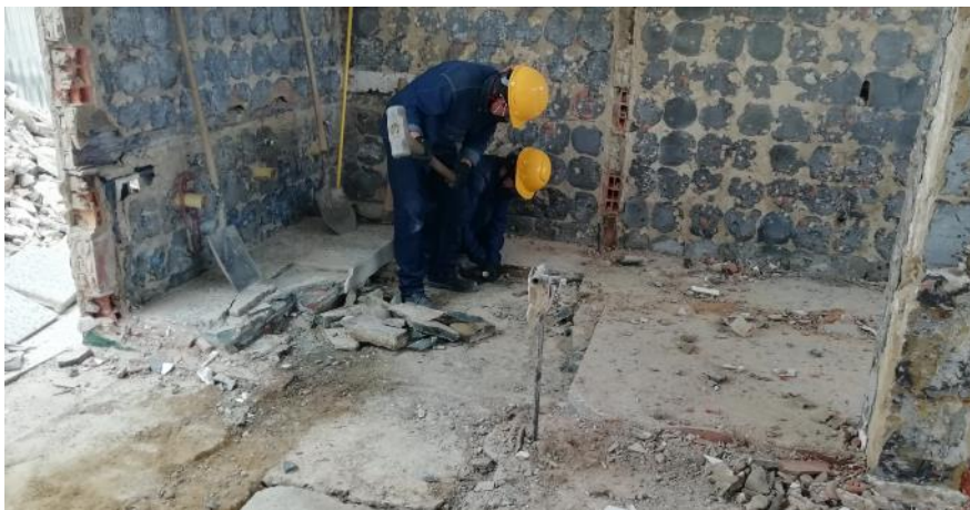
DEMOLICION DE ACABADO Y AFINADO DE PISO EN BATERIAS SANITARIAS PRIMARIA
