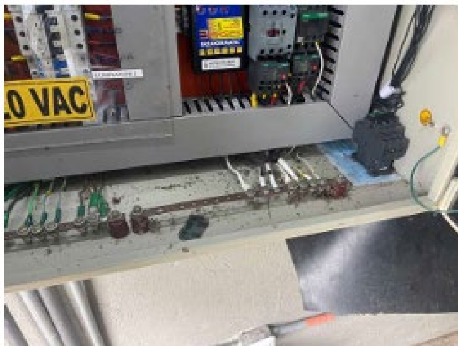
Imagen 4 a 6. Estado de tanques y equipos antes del mantenimiento
