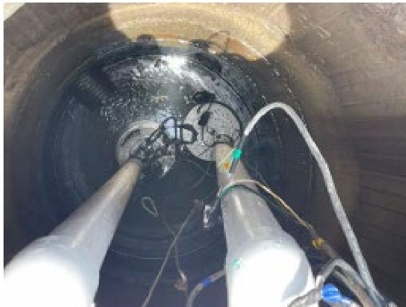
Imagen 39. Instalación de bombas sumergibles.
