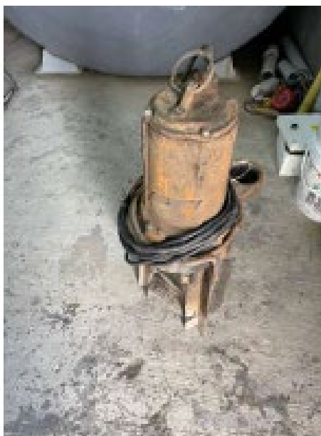
Imagen 34 y 35. Se realiza retiro de bomba existente, se evidencia obstrucción de la misma.
