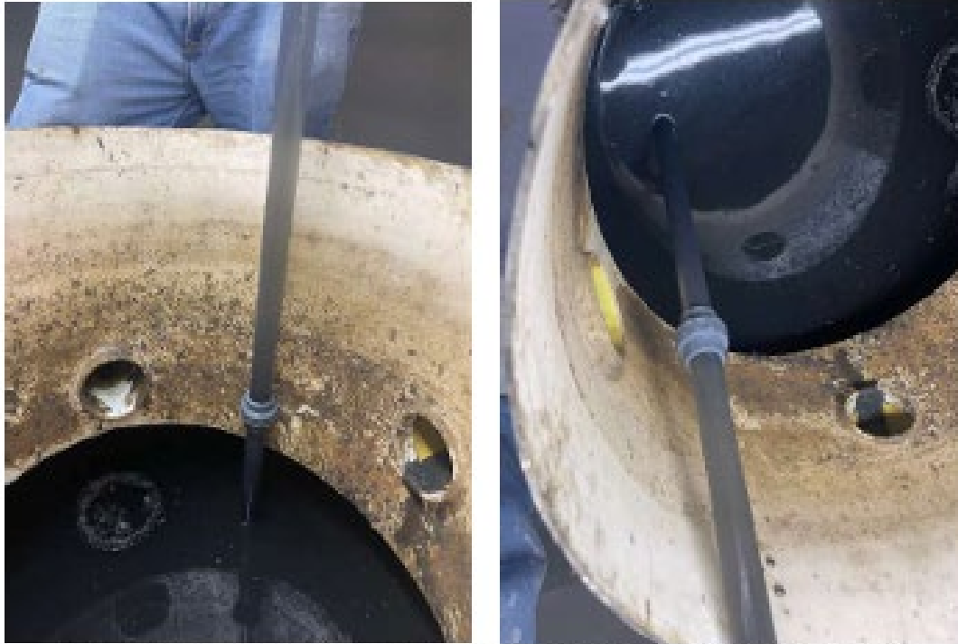
Imagen 11 a 14. Verificación de lodos tanque pretratamiento
