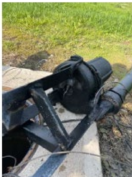
Imagen 34 y 35. Se realiza retiro de bomba existente, se evidencia obstrucción de la misma.
