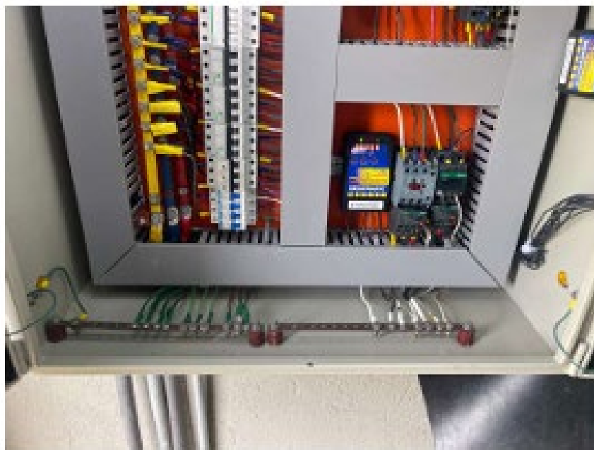
Imagen 26. Mantenimiento tablero eléctrico.
