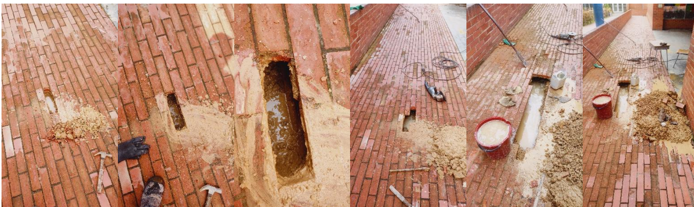
UBICACIÓN Y EXCAVACION PARA REPARACION DE TUBERIA DE 2" ZONA DOMO
