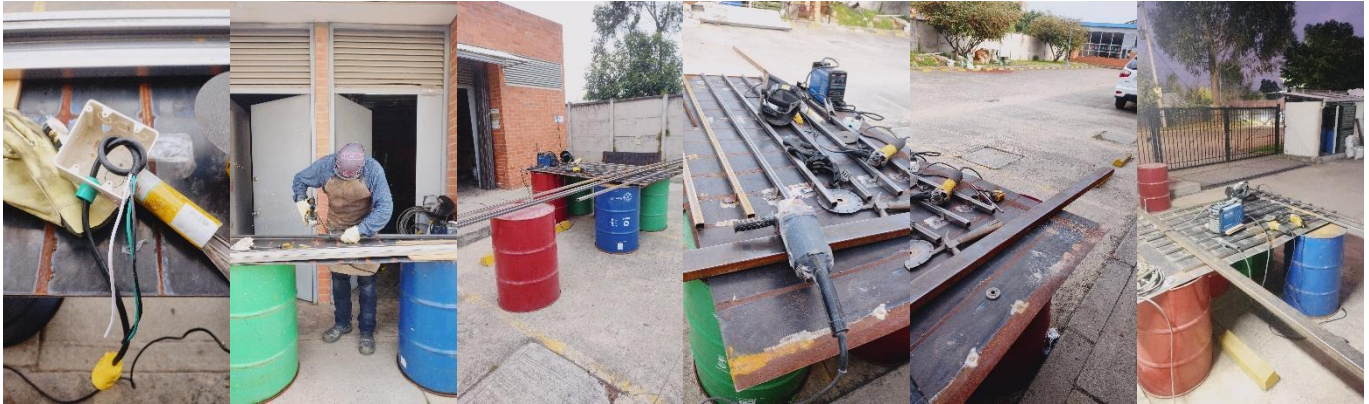
SE RECIVE Y VERIFICA MATERIAL DE FERRETERIA
