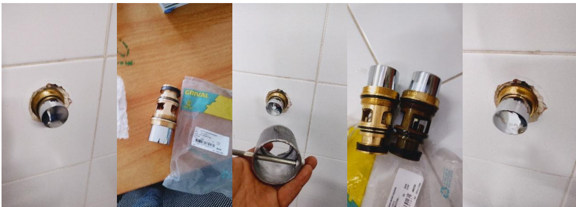
CAMBIO DE PUSH ANTIBANDALICO BAÑO HOMBRES SALA DE PROFESORES
