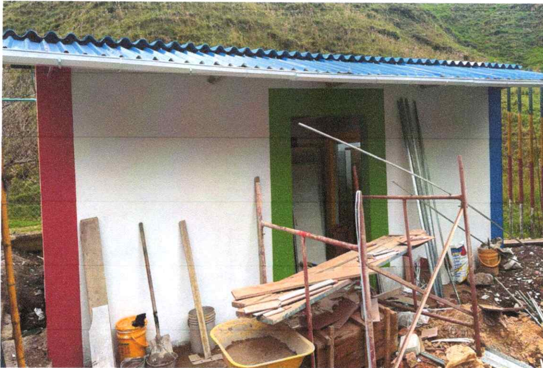
Foto 19. Se aplico vinilo tipo 1 sobre muros en estuco o pañete, logrando un acabado continuo y de calidad.
