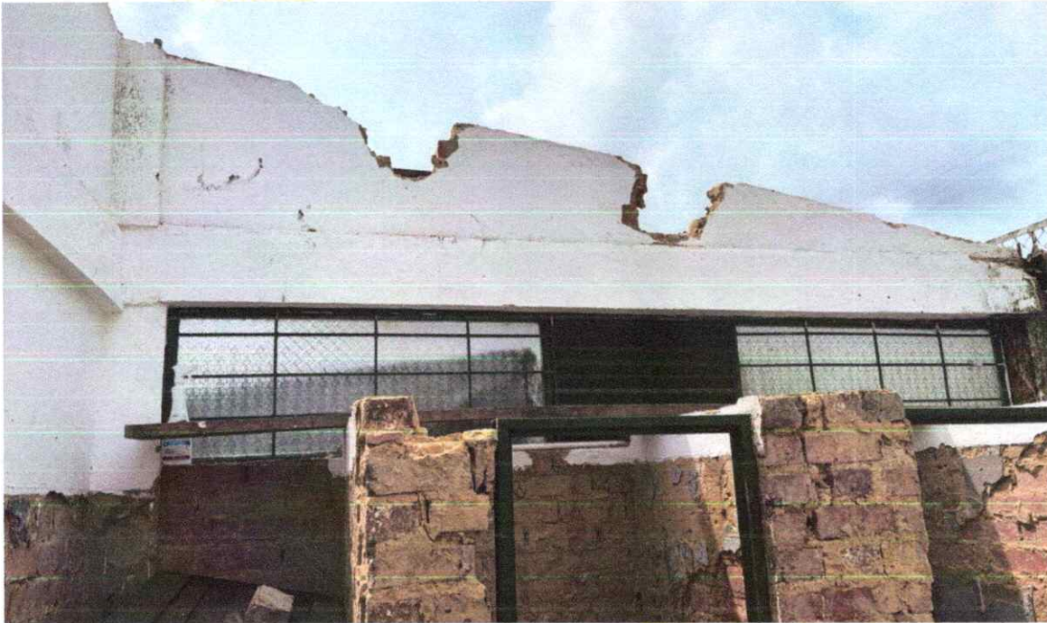
Foto 8. Retiro controlado de las tejas de asbesto de la cubierta existente, Incluyendo acarreo.
