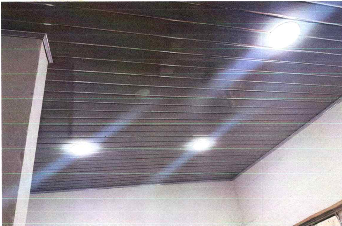
Foto 33. Instalación de paneles LED con su respectivo cableado y conexiones, permitiendo una adecuada iluminación en las áreas intervenidas.
