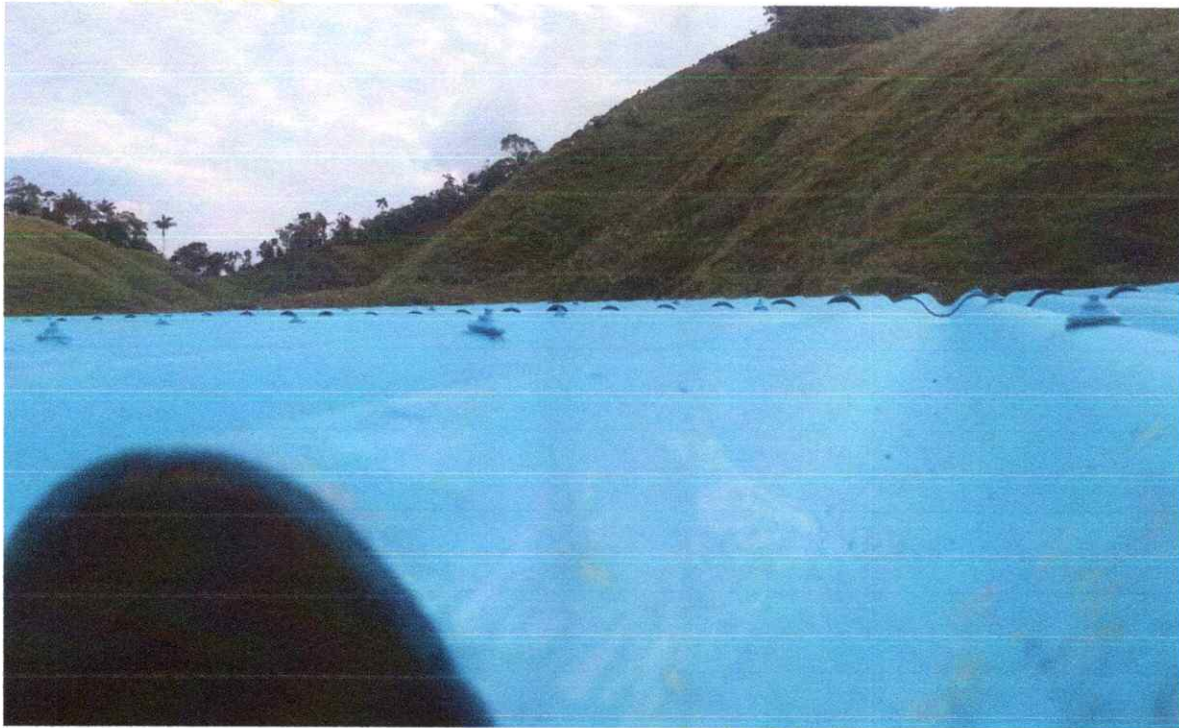
Foto 20. Pintura de alta resistencia al desgaste y antideslizante en tres manos, con el fin de proporcionar una superficie duradera, segura y con acabado uniforme.
