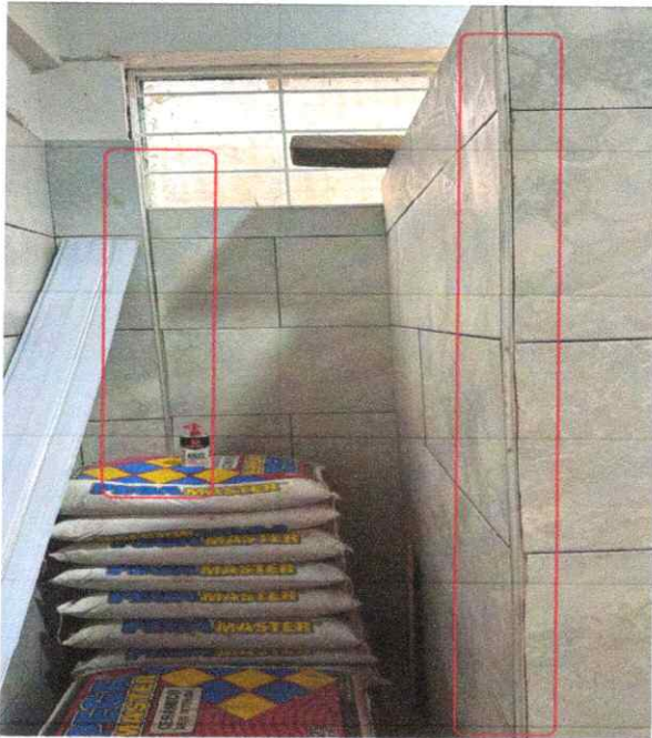
Foto 24. Suministro e instalación de aluminio tipo WIN en muros y mesones.
