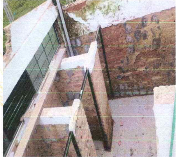
Foto 4. Demolición enchapes muro y mesones.
