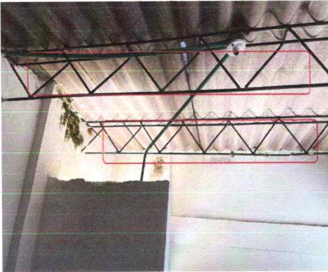
Foto 1. Desmonte Estructura de la Cubierta Existente (Cerchas metálicas)
