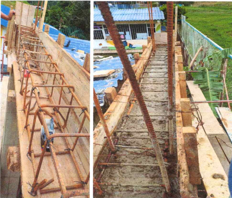
Foto 44. Viga aérea en concreto de 21 MPa.
