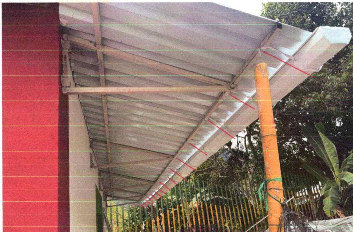
Foto 49. Instalación de soportes metálicos para el sistema de canal de aguas lluvias, incorporando labores de soldadura y aplicación de pintura protectora.
