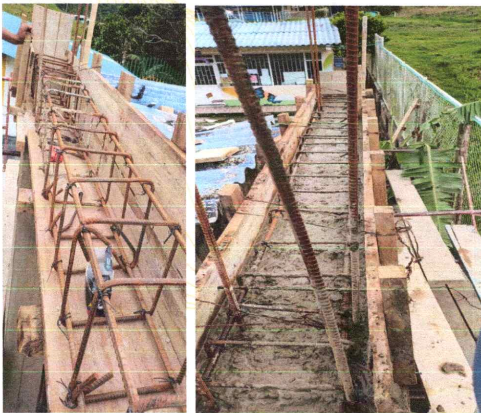
Foto 44. Viga aérea en concreto de 21 MPa.
