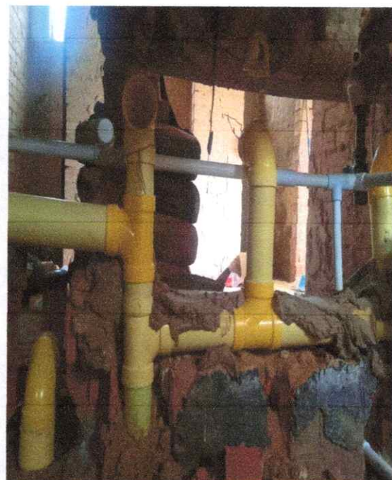
Foto 15. Se realizó la instalación de puntos de desagüe para orinal y duchas, buscando asegurar una correcta conducción y salida de estas.
