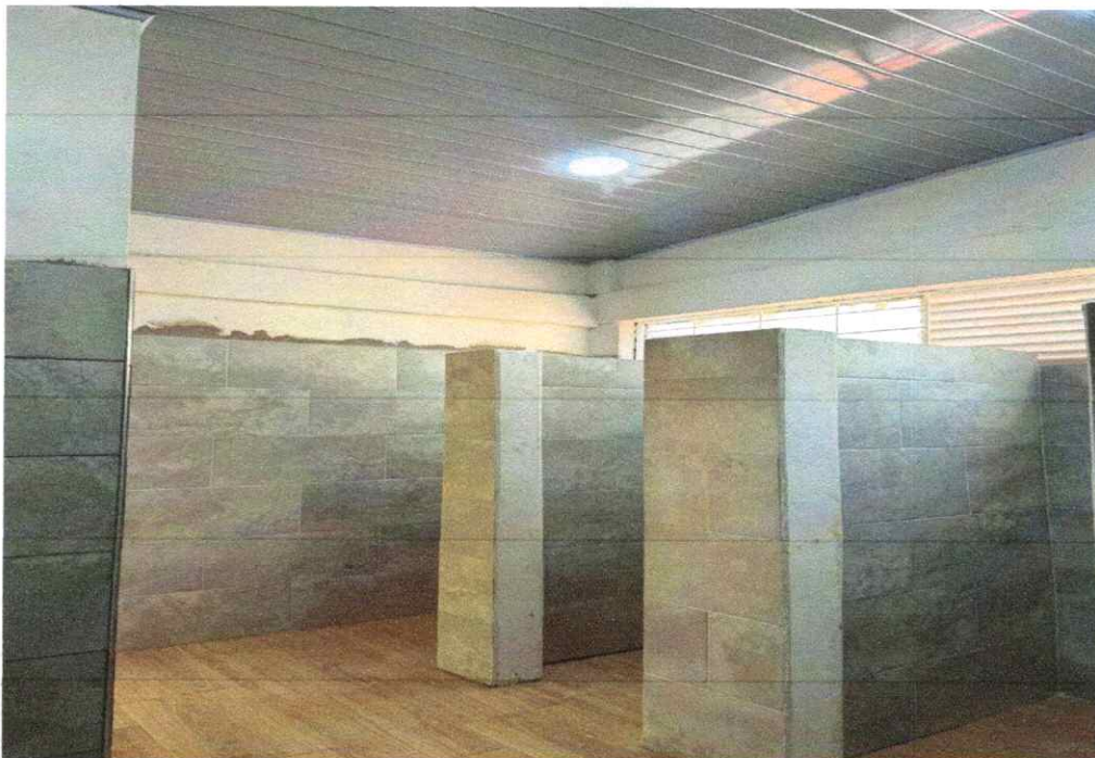
Foto 31. Instalación de cielo raso en láminas de PVC de 7 mm, como acabado final en los espacios intervenidos.
