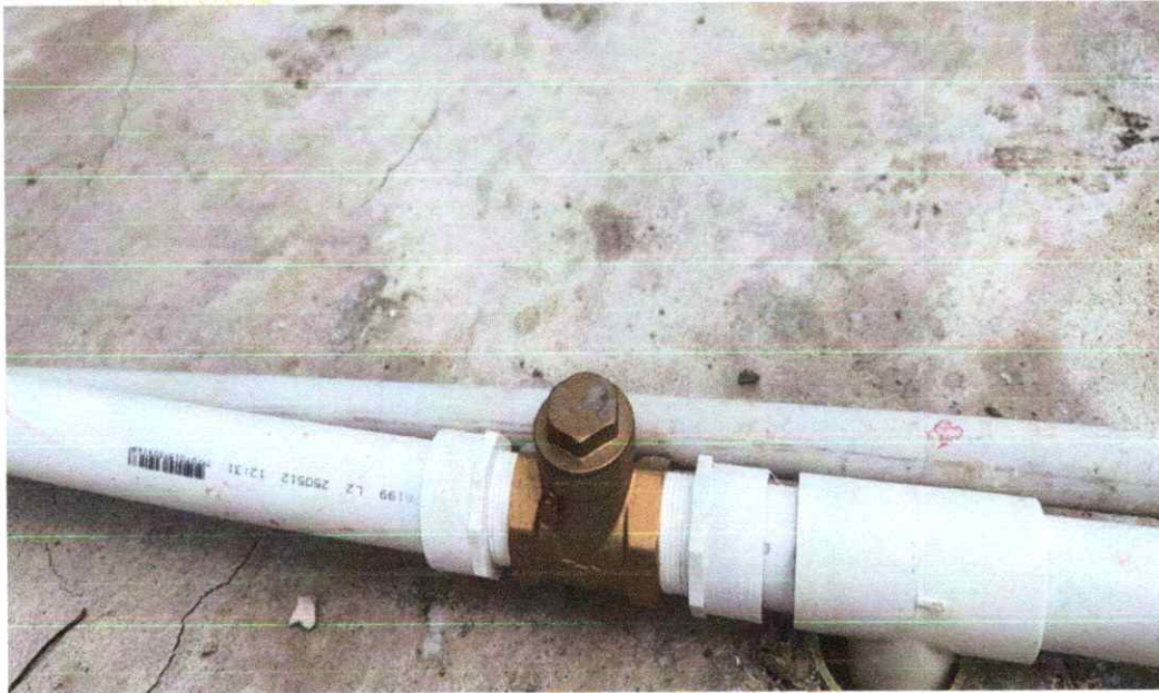
Foto 46. Instalación de cheque en bronce tipo cortina.
