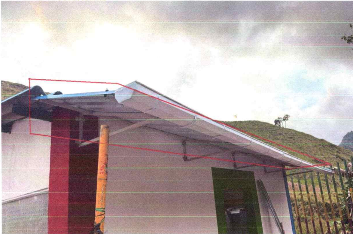
Foto 26. Suministro e instalación de cubierta galvanizada tipo trapezoidal para el voladizo de la fachada frontal.
