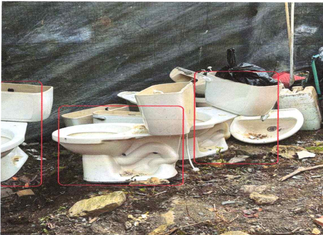
Foto 5. Desmonte de sanitarios de la batería sanitaria.
