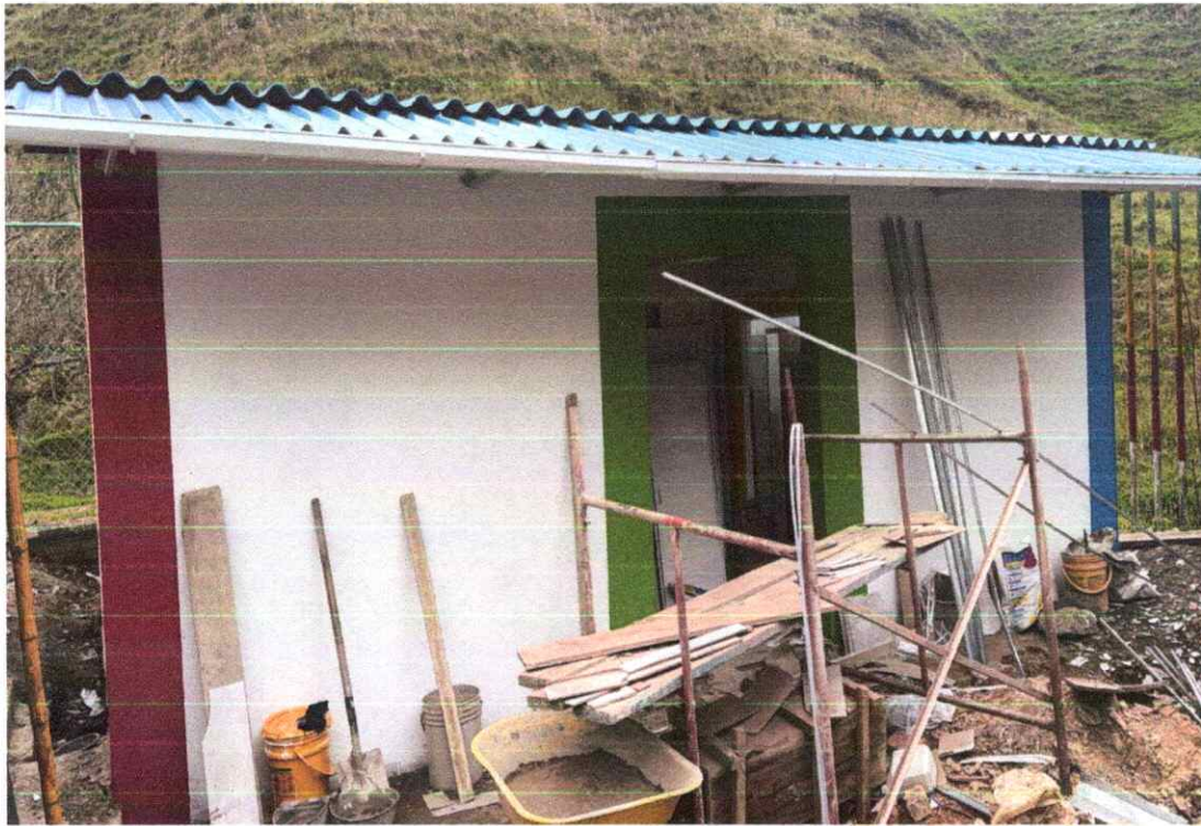
Foto 19. Se aplico vinilo tipo 1 sobre muros en estuco o pañete, logrando un acabado continuo y de calidad.
