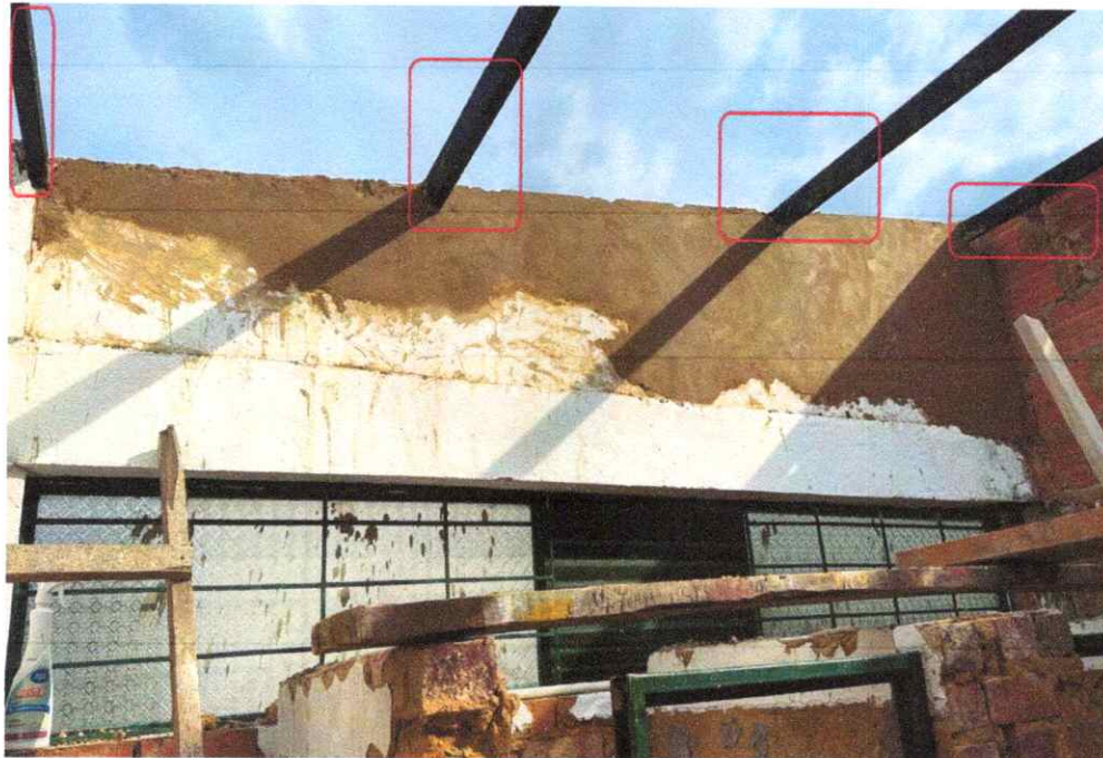
Foto 16. Suministro y aplicación de esmalte en lámina lineal con tres manos, con el fin de garantizar protección, durabilidad y acabado uniforme.
