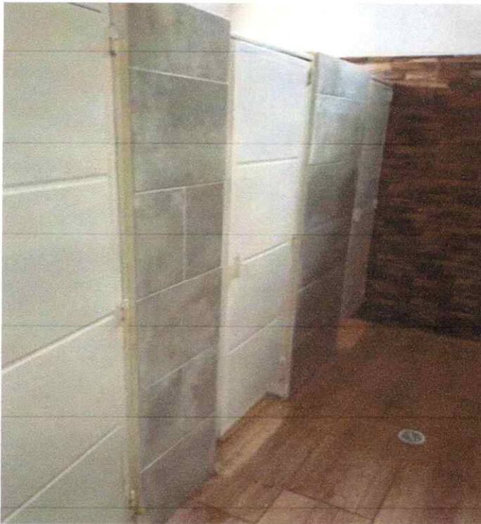
Foto 34. Instalación de puerta en lámina calibre 18.
