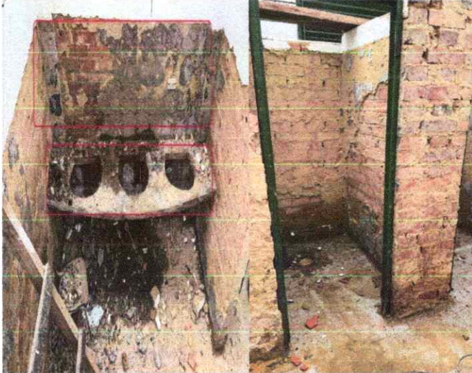
Foto 3. Demolición enchapes muro y mesones.
