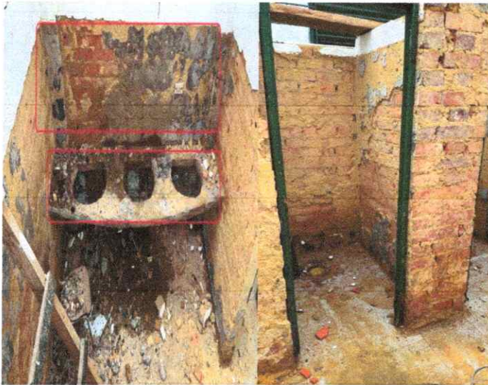
Foto 3. Demolición enchapes muro y mesones.
