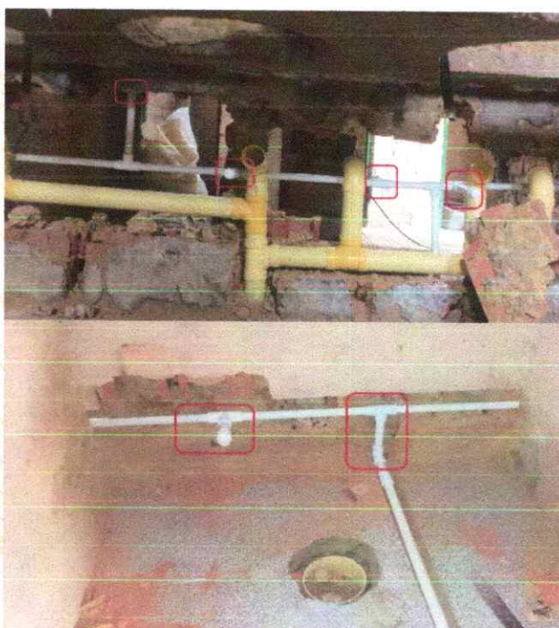
Foto 13. Instalación y suministro de puntos hidráulicos.
