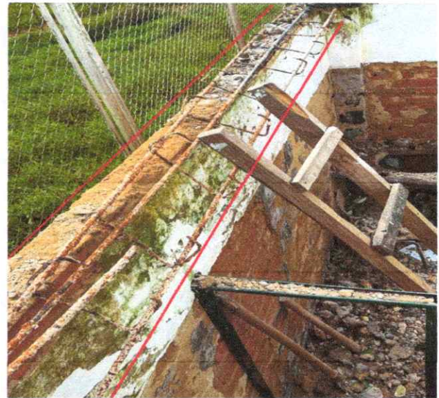
Foto 7. Retiro y demolición de viga aérea en concreto, garantizando la disposición adecuada del material demolido.
