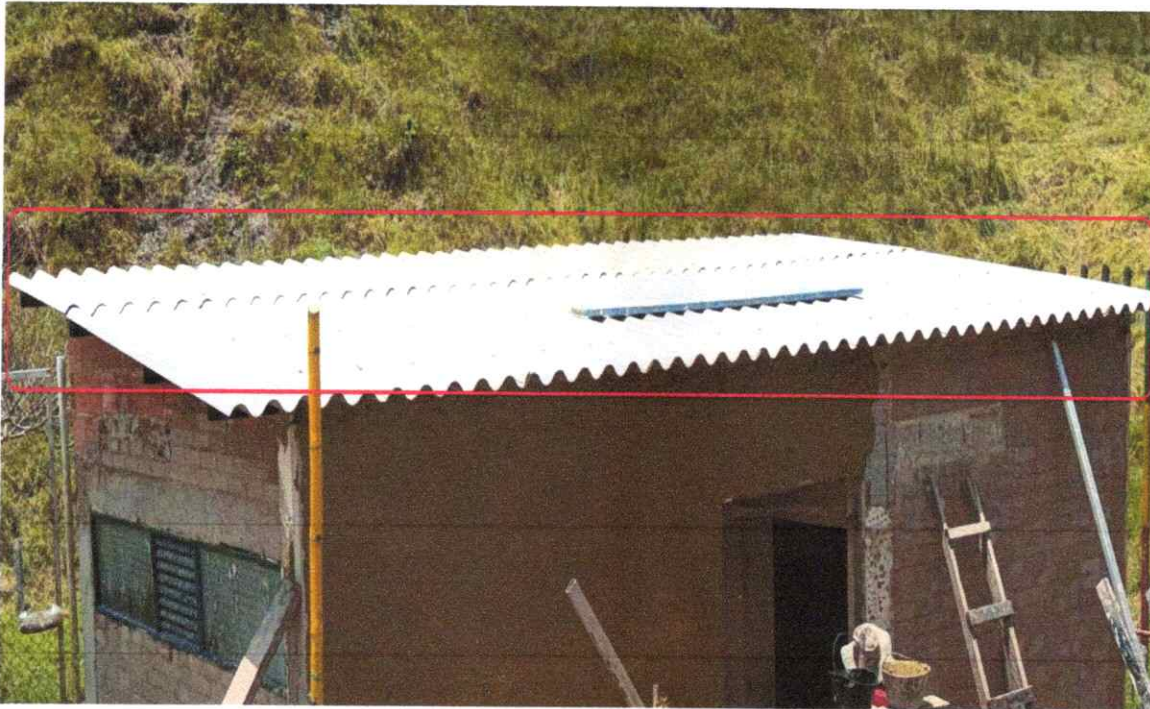
Foto 28. Instalación de una nueva cubierta en la zona intervenida, utilizando tejas de fibrocemento número 10.
