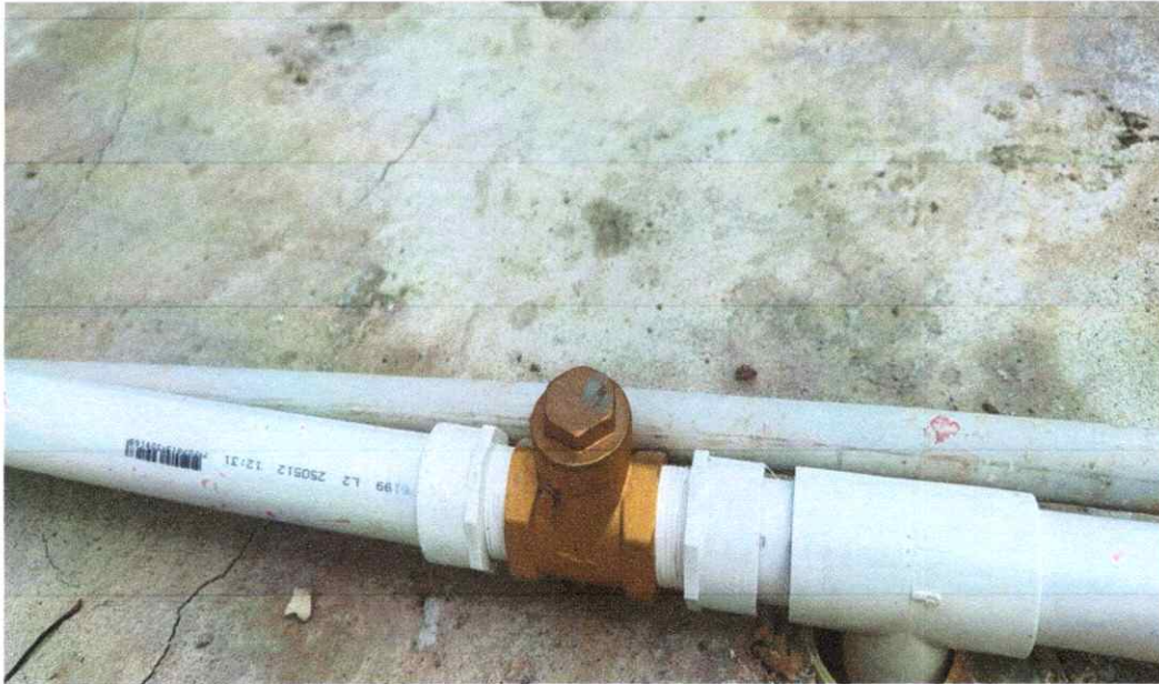
Foto 46. Instalación de cheque en bronce tipo cortina.
