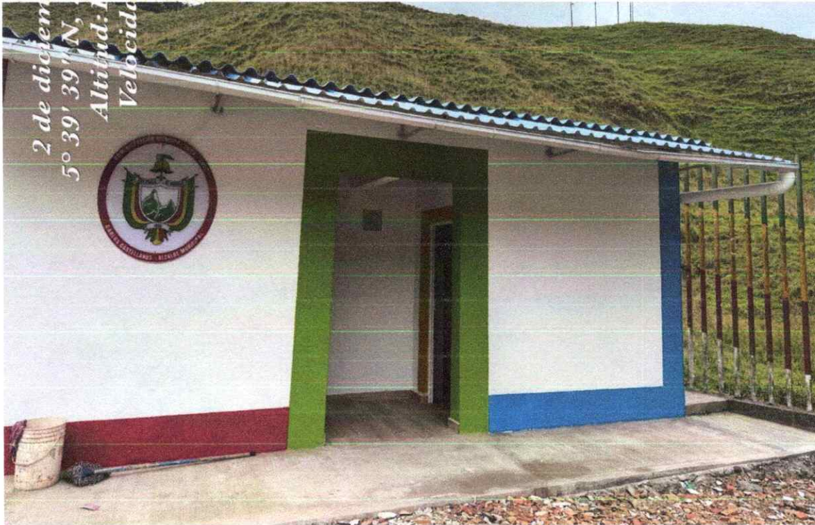
Foto 48. Construcción de andenes en concreto.
