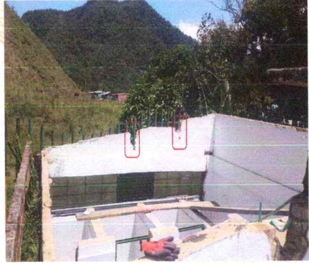
Foto 2. Desmonte Estructura de la Cubierta Existente (Cerchas metálicas)
