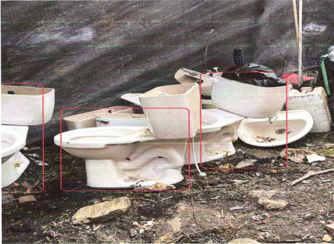
Foto 5. Desmonte de sanitarios de la batería sanitaria.
