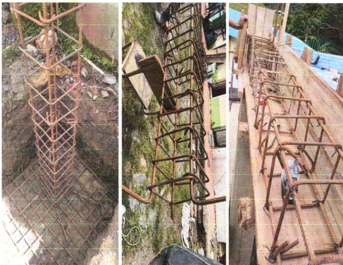
Foto 39, 40 y 41. Suministro, figurado y amarre de acero para las zapatas, columnas, viga y placa para tanques de reserva de agua.
