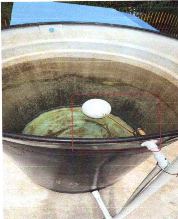
Foto 45. Instalación de válvula con flotador.
