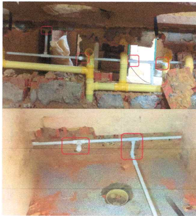
Foto 13. Instalación y suministro de puntos hidráulicos.
