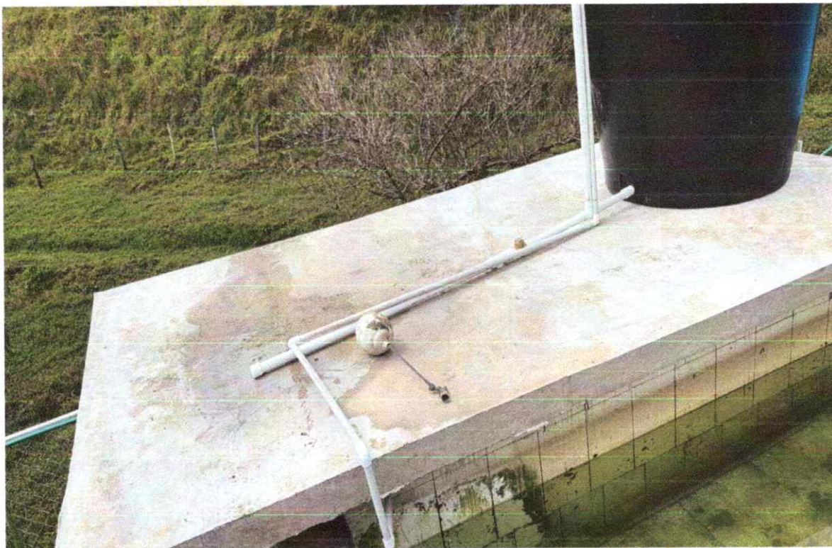
Foto 43. Placa maciza en concreto de 21 MPa.
