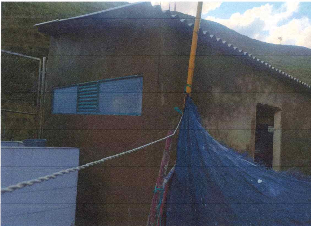
Foto 11. Pañete liso en los muros por ambos lados para lograr una superficie pareja y uniforme.
