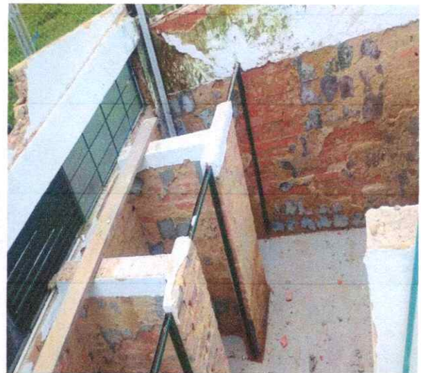
Foto 4. Demolición enchapes muro y mesones.
