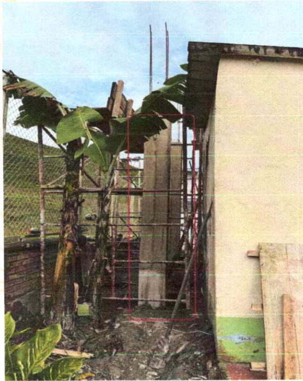
Foto 42. Retiro y demolición de viga aérea en concreto, garantizando la disposición adecuada del material demolido.
