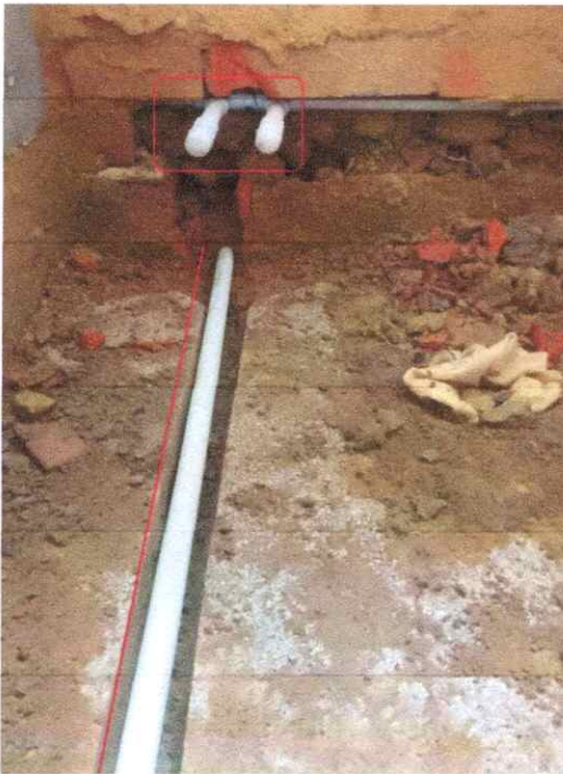
Foto 12. Instalación y suministro de puntos hidráulicos.
