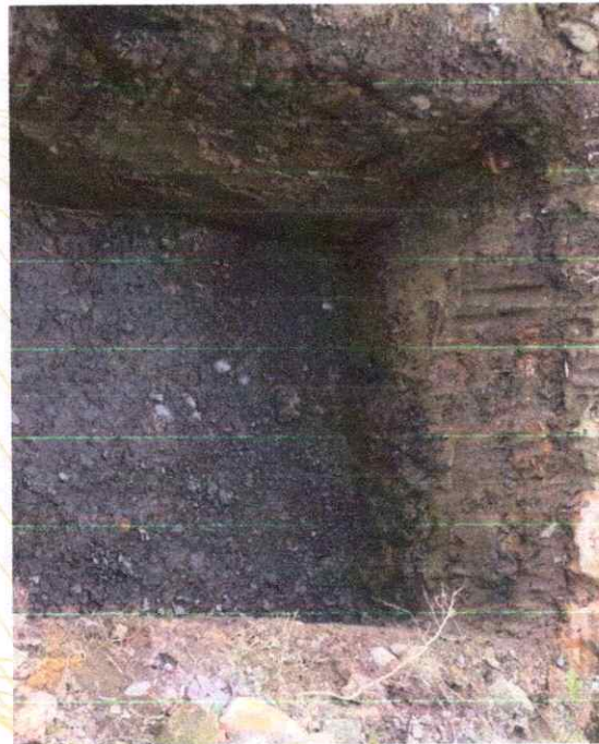
Foto 36. Realizó la excavación para construcción de 2 Zapatas para Tanques de Reserva
