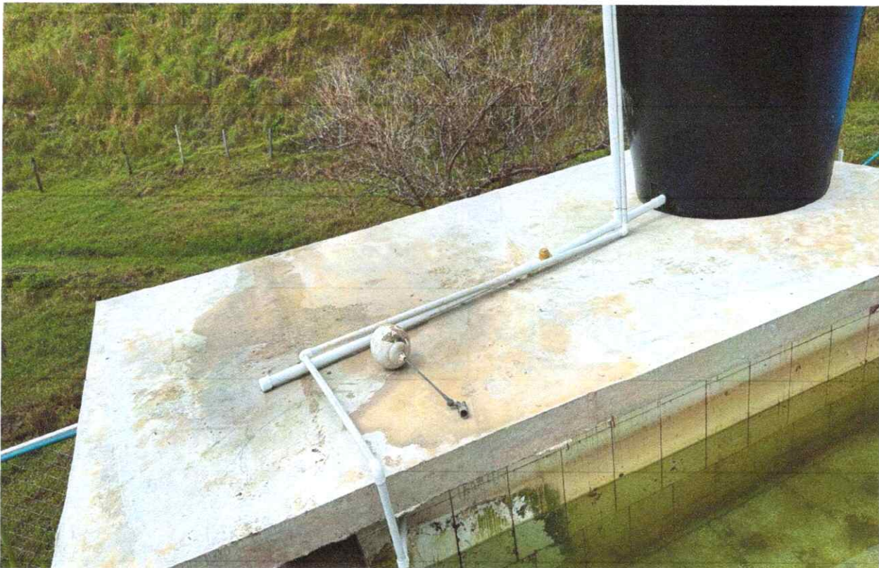
Foto 43. Placa maciza en concreto de 21 MPa.
