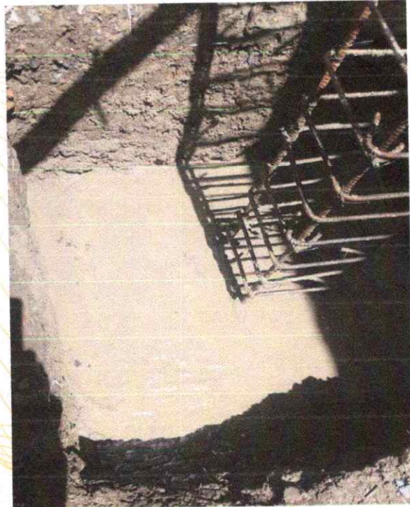
Foto 38. Construcción de 2 Zapatas; para Construcción de Placa para Tanques de Reserva.
