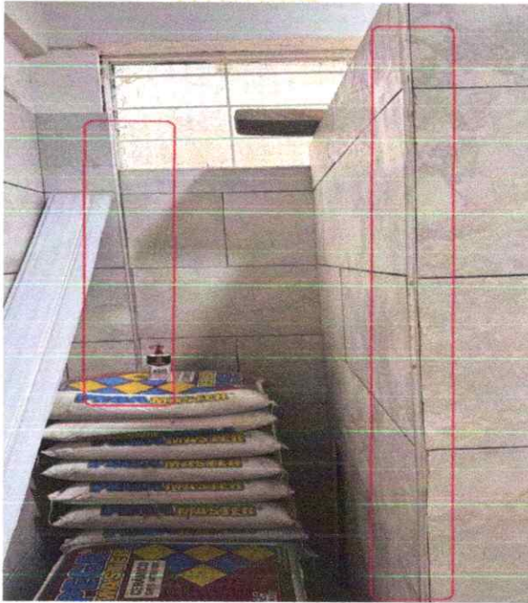
Foto 24. Suministro e instalación de aluminio tipo WIN en muros y mesones.
