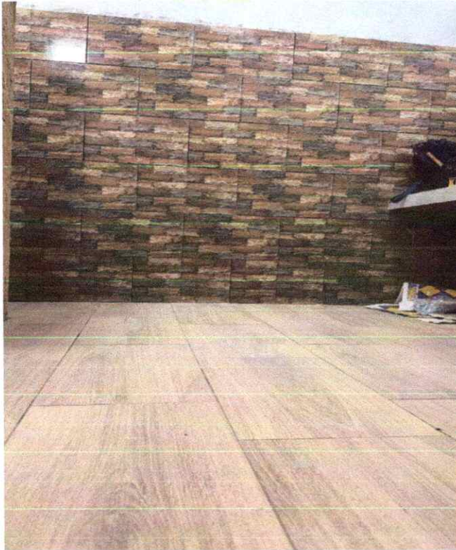
Foto 22. Suministro e instalación de cerámica en pisos y muros, garantizando nivelación, adherencia y acabado uniforme.
