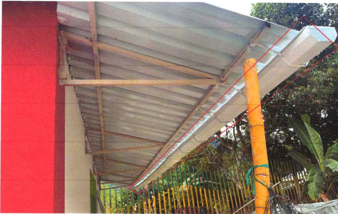
Foto 27. Instalación de canal para recolección de aguas lluvias en lámina galvanizada.
