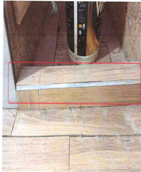
Foto 25. Suministro e instalación de aluminio tipo WIN en muros y mesones.
