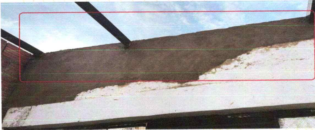
Foto 47. Muro en ladrillo tolete.
