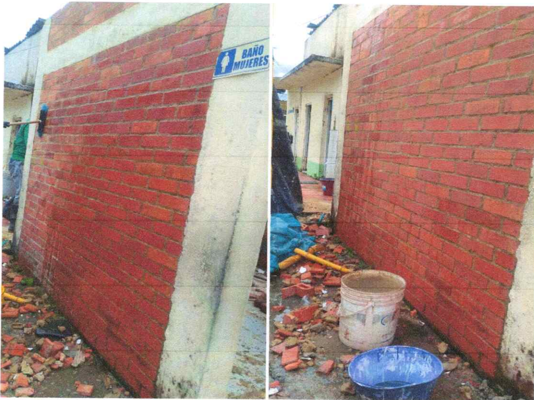
Foto 9. Lavado de la fachada en muros utilizando ácido muriático para mejorar el acabado y eliminar el barniz antiguo y la suciedad acumulada.
