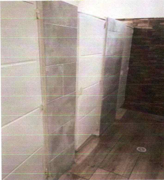
Foto 34. Instalación de puerta en lámina calibre 18.
