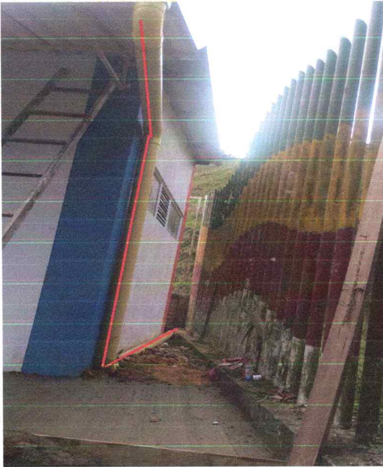
Foto 30. Instalación de bajante en PVC. 7.CIELORASOS
