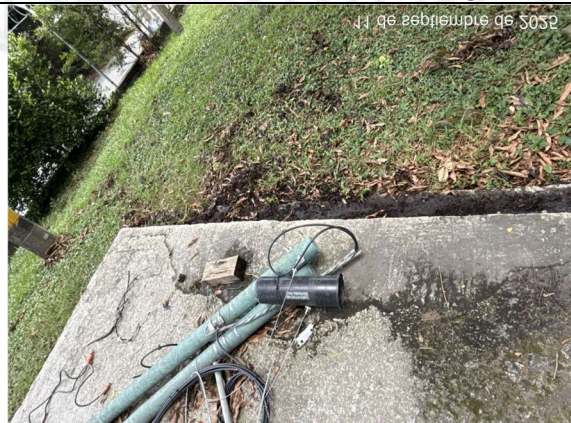
4. Mortero de losa deteriorado del tanque 1
