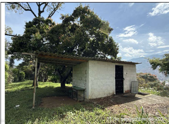
1. Caseta de cuarto de bombas en obra negra
