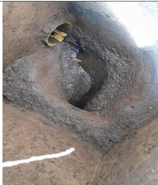
Después Limpieza de la poza séptica retiro de aguas residuales y lodos semilíquidos por medio de succión que se encuentra en las instalaciones del ICA sede via Sevilla - Guacamayal
