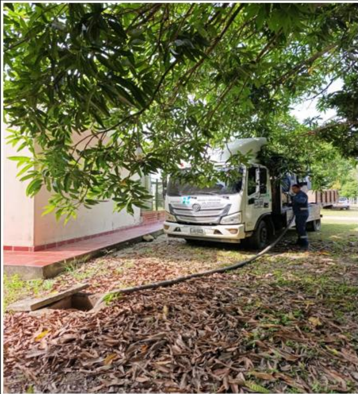
Durante la ejecución de la succión y sondeo de la fosa séptica.
