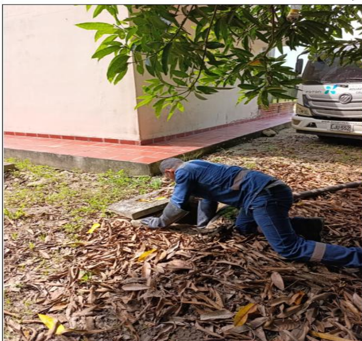
Durante la ejecución de la succión y sondeo de la fosa séptica.
