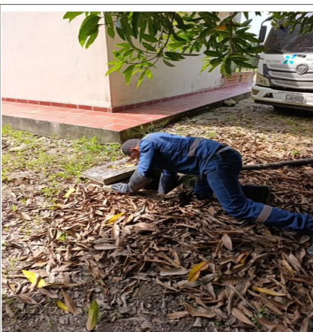
Durante la ejecución de la succión y sondeo de la fosa séptica.
