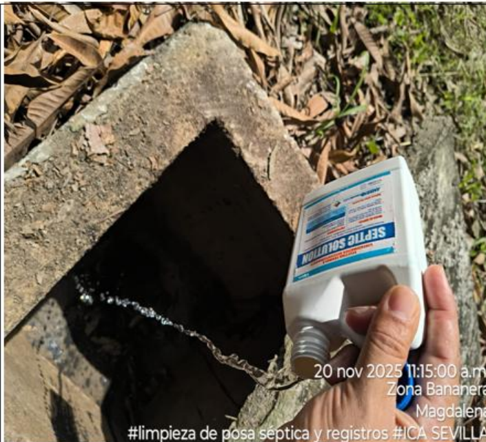
Aplicación de Bacterias para optimizar el almacenamiento de agua residual y disminuir la cantidad de lodos que se generan
