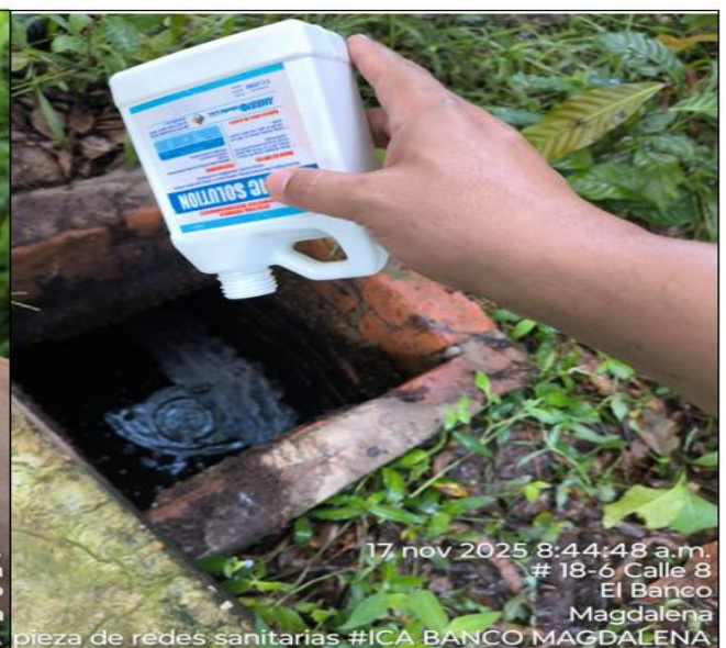
Aplicación de Bacterias para optimizar el almacenamiento de agua residual y disminuir la cantidad de lodos que se generan
