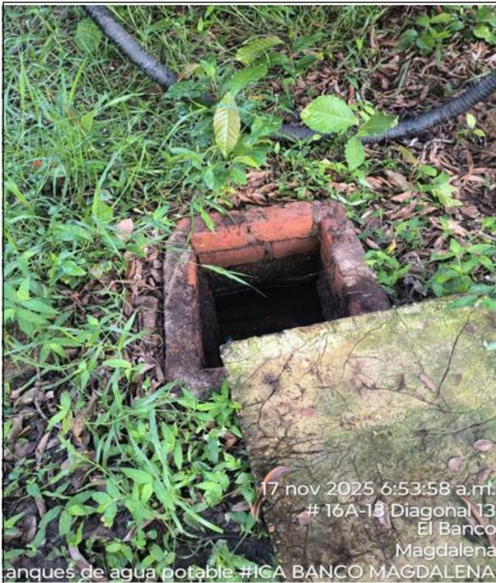
Antes de realizar la actividad registro con agua residual o lodos
