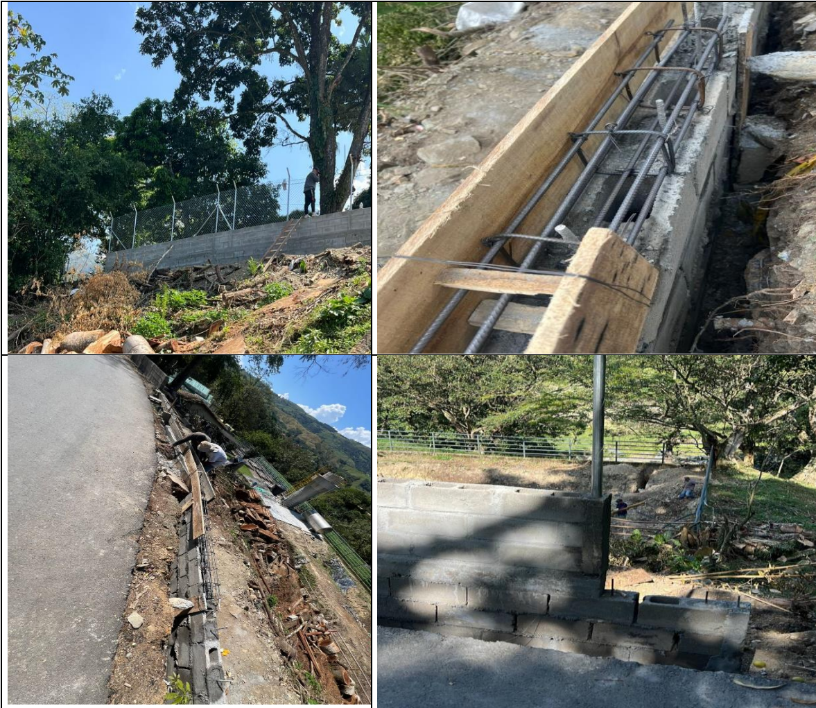
Construcción de columnetas
