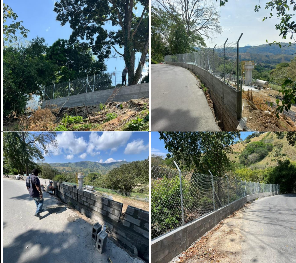
Construcción de mampostería
