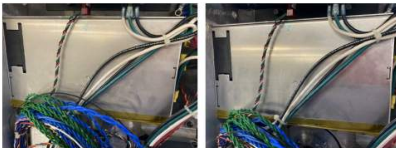
Imagen 6. Antes y después, limpieza de fuentes en upper enclosure.
