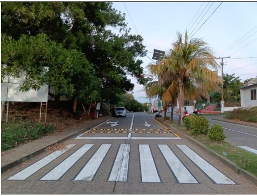
CRUCE PEATONAL: CEBRA Y LINEA DE DETENCIÓN
