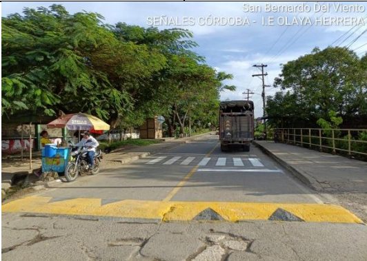
RESALTO EN CONCRETO
