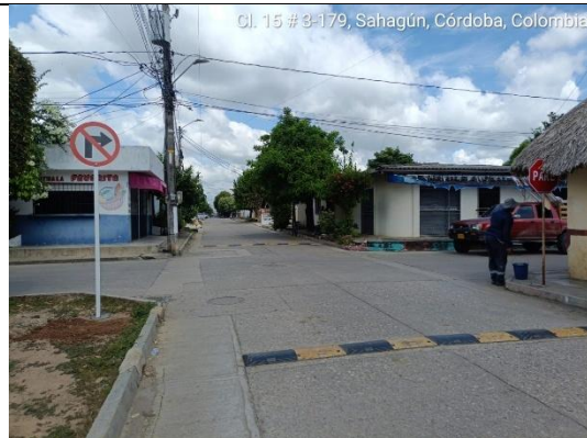
SR08 - PROHIBIDO GIRAR A LA DERECHA CALLE 15 CON 4
