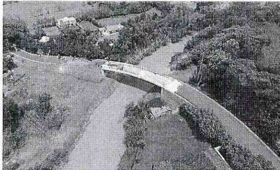
construcción del puente del puente de Papayal en el municipio de Tuluá
