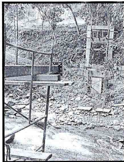
construcción del puente que beneficia a la comunidad KOWONDEV
