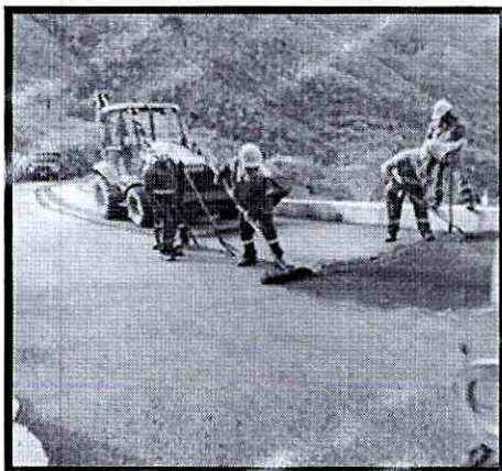
mantenimiento periódico de 50 kilómetros de vías terciarias en los municipios
