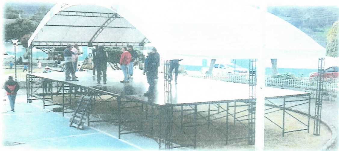
PASARELA EN ESTRUCTURA METÁLICA CON DIMENSIONES DE 1.20 METROS X 7.20 METROS
