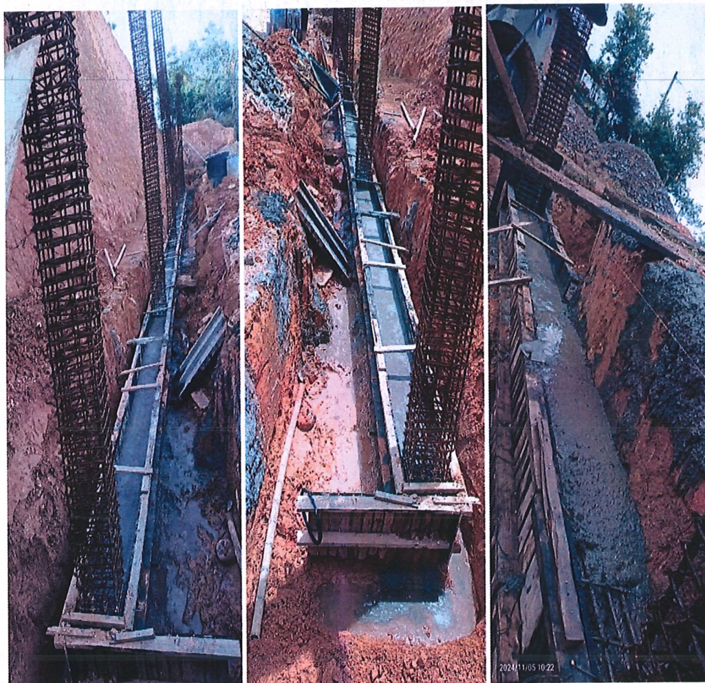
IMAGEN N°12, 13 Y 14. CONSTRUCCIÓN VIGA DE CIMENTACIÓN EN CONCRETO DE 210 KG/CM2- 3000 PSI. VER DISEÑO
