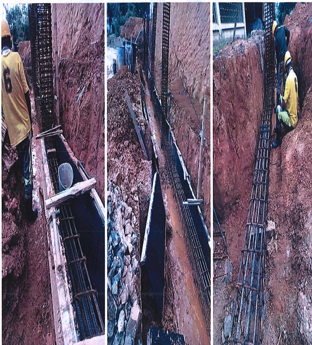
IMAGEN N°15, 16 Y 17. ACERO DE REFUERZO FY=60.000 P.S.I. VIGA DE CIMENTACIÓN.
