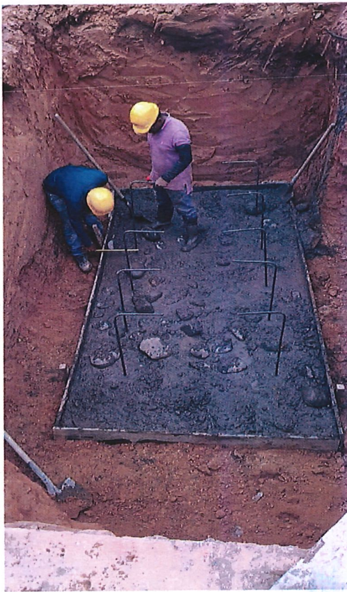
IMAGEN N°5 y 6. CONCRETO CICLÓPEO - 2500 PSI (175 KG/CM2) 60% CONCRETO 2.500 PSI + 40% PIEDRA MEDIA ZONGA
