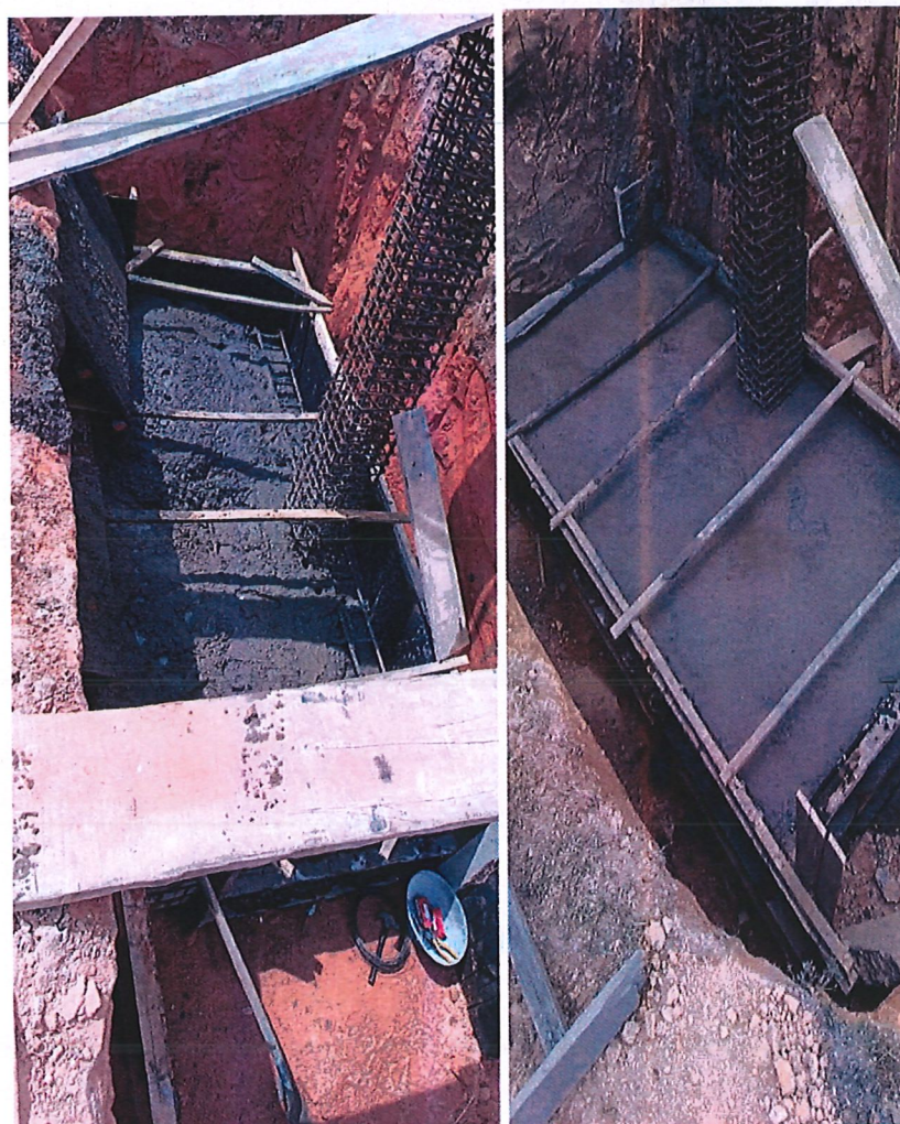
IMAGEN N°7, 8 y 9. ACERO Y CONSTRUCCIÓN ZAPATAS EN CONCRETO 210 KG/CM2-3000 PSI. VER DISEÑO.
