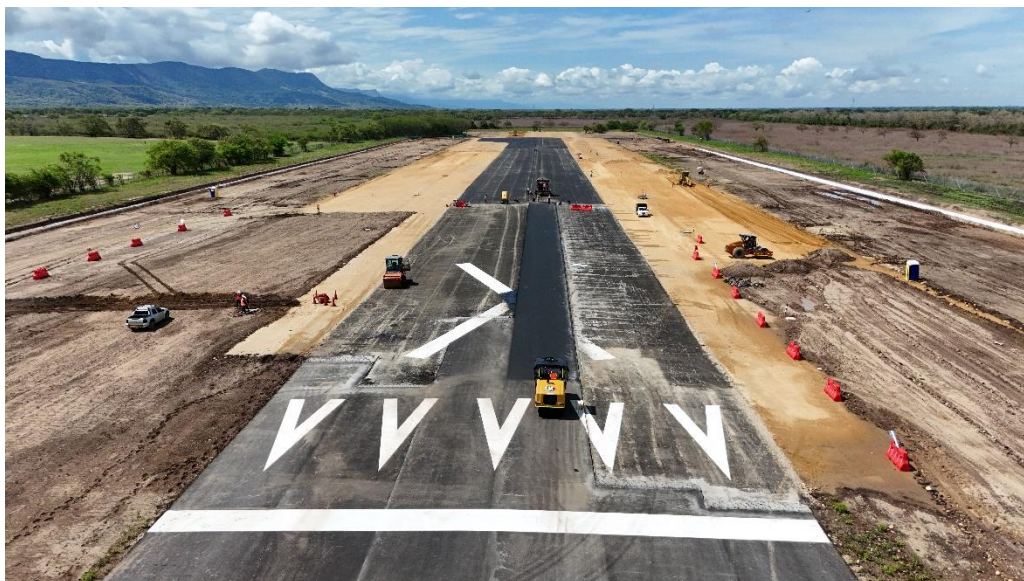
Ilustración 4 Instalación de mezcla asfáltica
