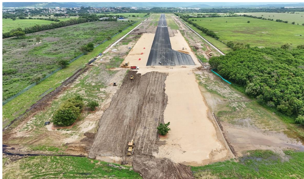
Ilustración 15 Conformación de capa de limo en zona RESA SUR
