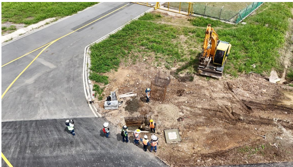
Ilustración 6 Construcción de cajas de inspección hidráulica
