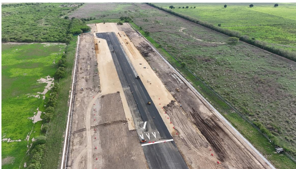
Ilustración 7 Imprimación de base granular K0+000 – K0+485
