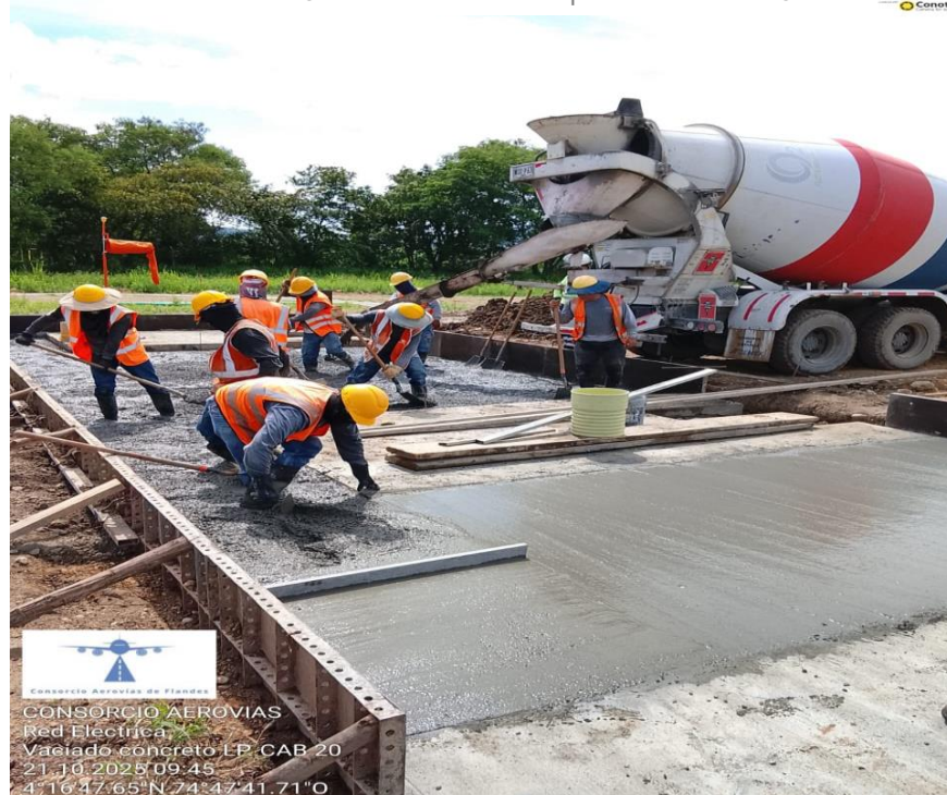
Ilustración 19 Vaciado de concreto para luces PAPI 20
