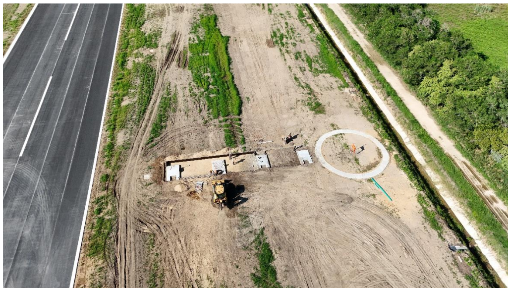
Ilustración 9 Construcción de base para luces PAPI 20
