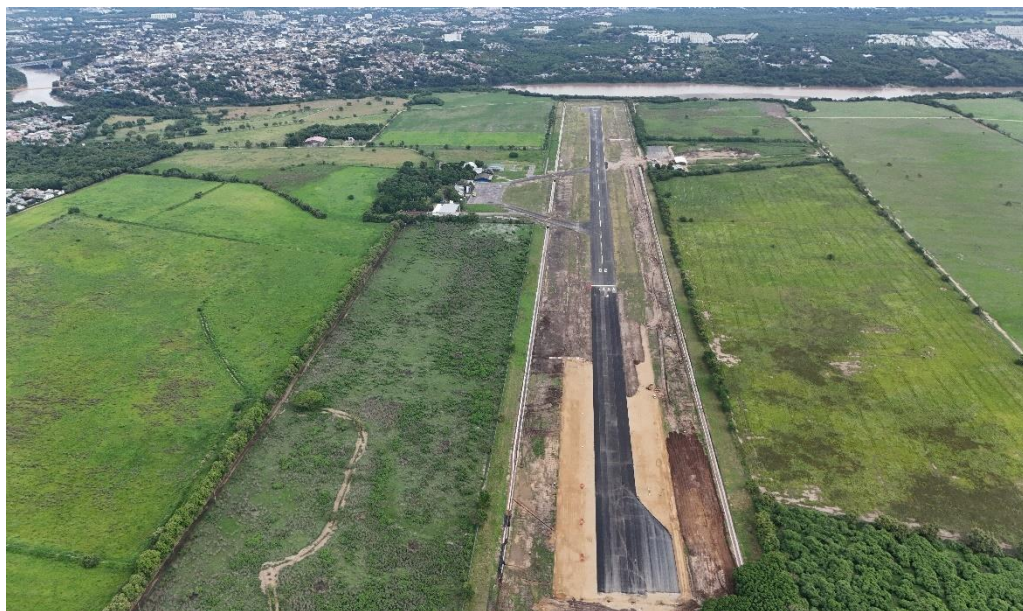
Ilustración 17 Avance de obra corte 31- octubre -2025
