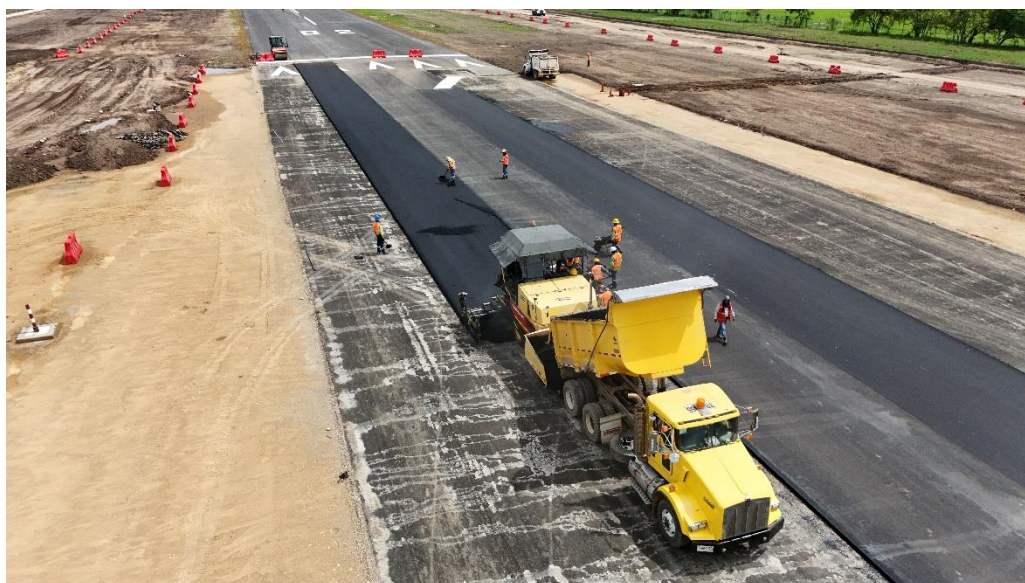
Ilustración 5 Instalación de mezcla asfáltica K0+385
