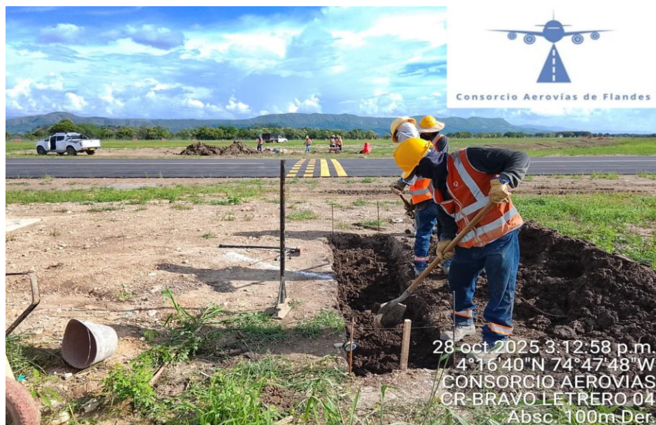
Ilustración 22 Construcción de bases para letreros en calles de rodaje
