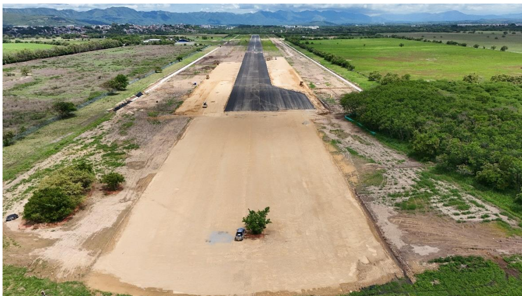
Ilustración 13 Conformación de capa de afirmado B400 en zona RESA SUR
