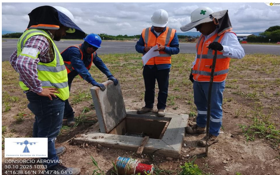
Ilustración 18 Inspección de cajas eléctricas
