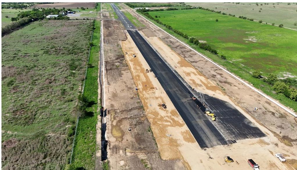
Ilustración 8 Instalación de mezcla asfáltica K0+070 pista
