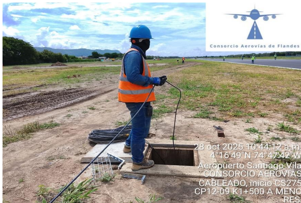
Ilustración 21 Tendido de cable
