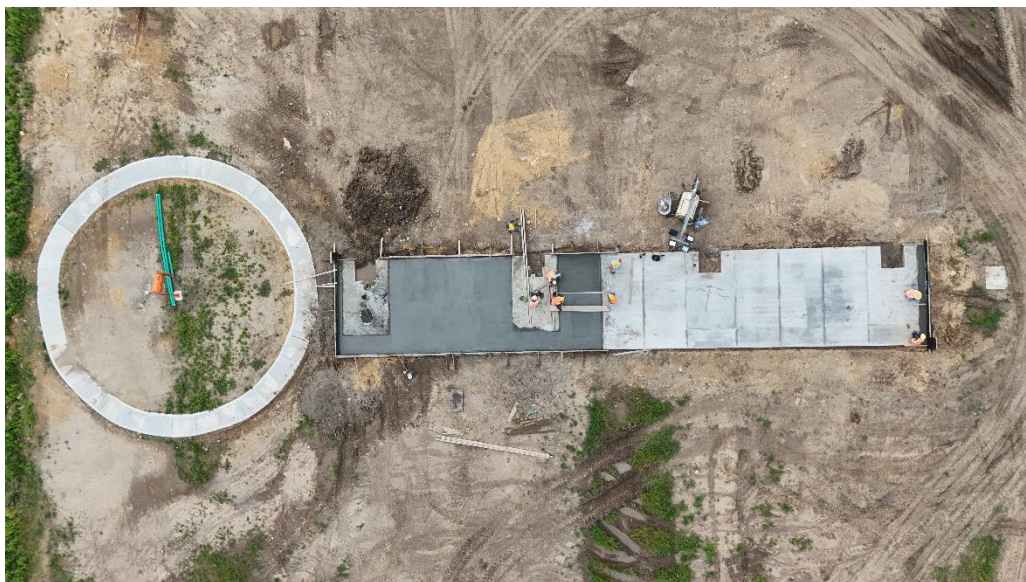
Ilustración 14 Vaciado de concreto para losa de luces PAPI 20
