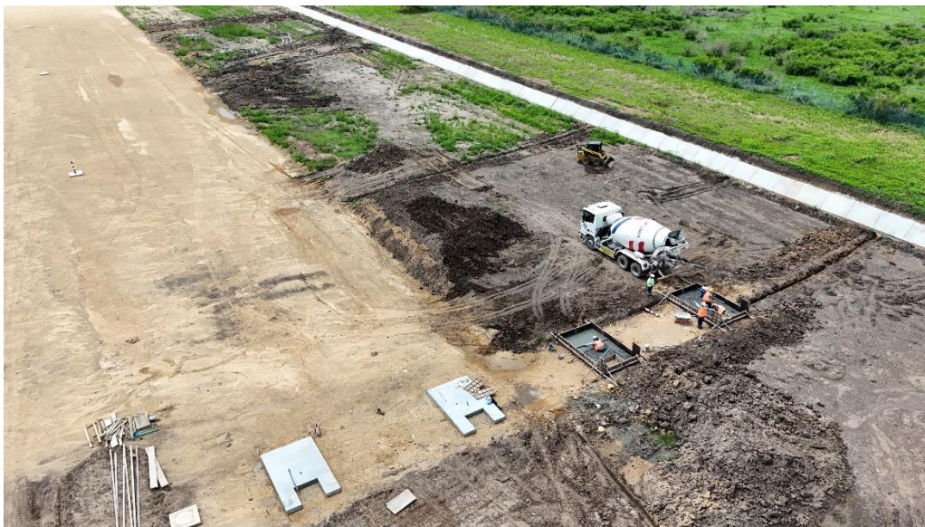
Ilustración 16 Vaciado de bases para luces PAPI 02
