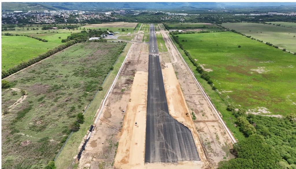
Ilustración 12 Pista totalmente asfaltada
