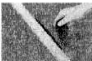
PASO 4: ORGANIZACIÓN Y APLICACIÓN DE RELLENOS (ARENA Y CAUCHO) Y CEPILLADO.
