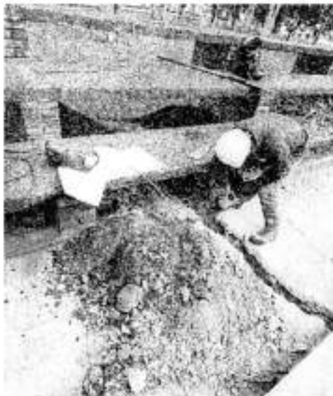
PRD PADEL 12-091 - ACTIVIDADES ELECTRICAS
