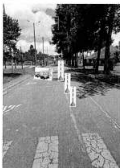
Estacionamiento de mixer , cerramiento de un carril
