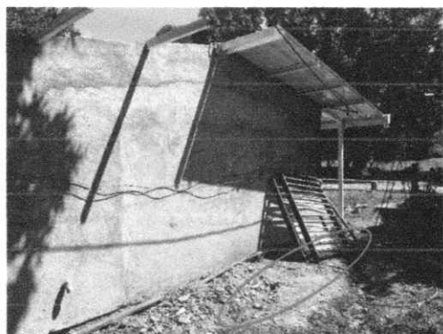
MANEJO DE AGUA POR ESCORRENTIA -CUNETAS-
