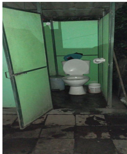
Alquiler de batería sanitaria para provisión de servicios de higiene
