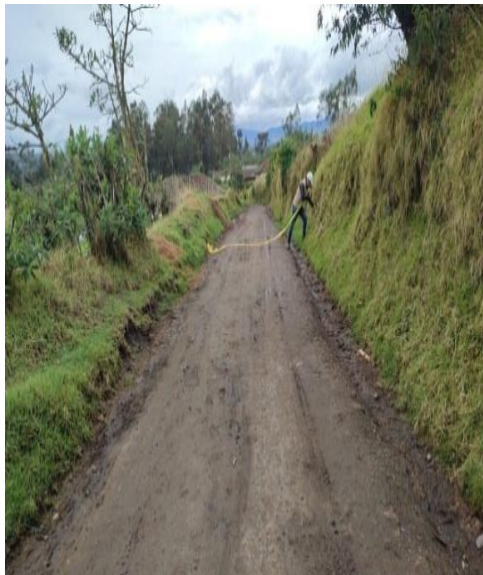
Fotografía No 3 : conducción #1 Se muestra señalización de Zona de trabajo para prevenir dificultades en la zona mientras no se labora
