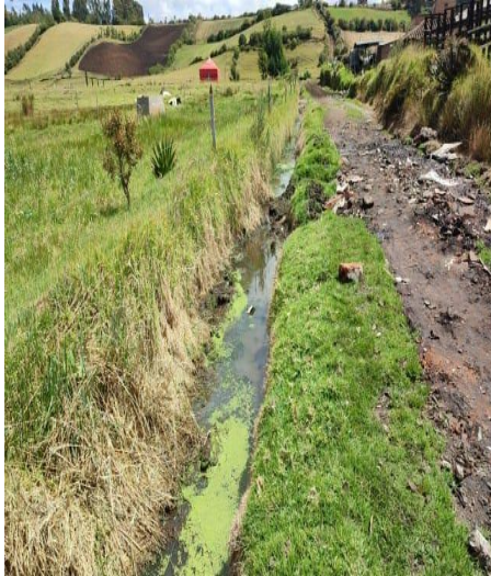
Fotografía No 1: conducción #1 abscisa k2+717 Se muestra zona de humedal y de inspección
