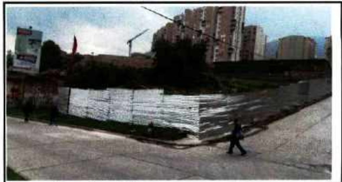
instalación de cerramiento
