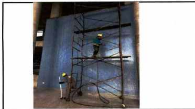
LAVADO DE MUROS PINTADOS
