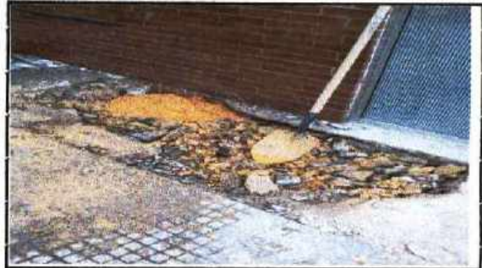
DEMOLICION DE PISO UBICACION DE FILTRACIONES
