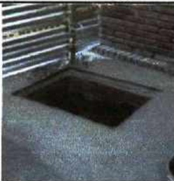
FIBR. Y DILATACIONES PARA TAPAS DE CAJAS
