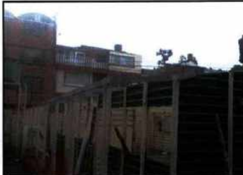
Desmonte de cubierta
