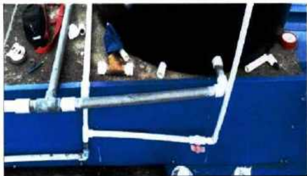
CONEXION DETANQUES TUBERIA PVC.
