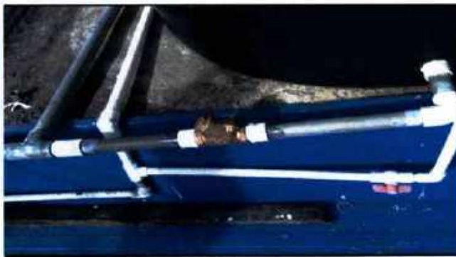
SUMINISTRO E INSTALACION DE CHECK VALVE EN PAPA TANQUE
