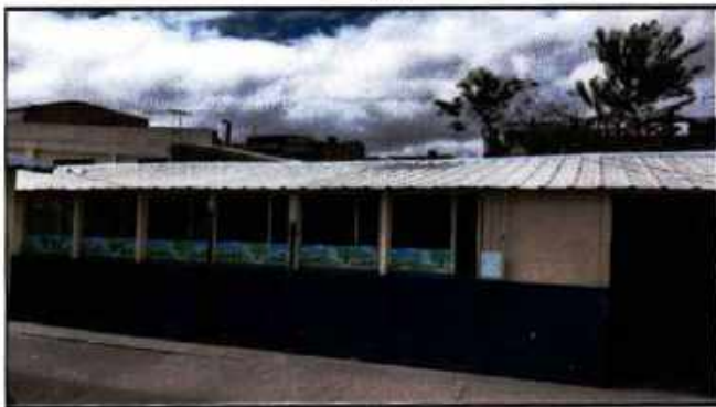
TEJA SIN INSTALAR
