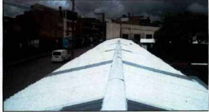
CAMBIO DE CUBIERTA EXISTENTE A CORRIENTE
