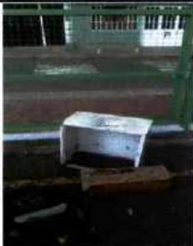
UBICACION CAJA PARA CONTADOR DE GAS
