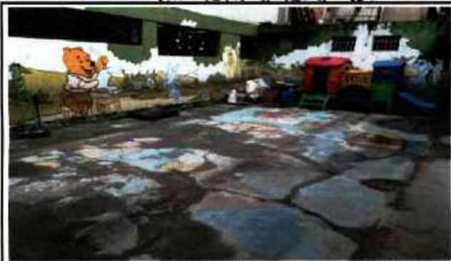
Retiro de tapete.
