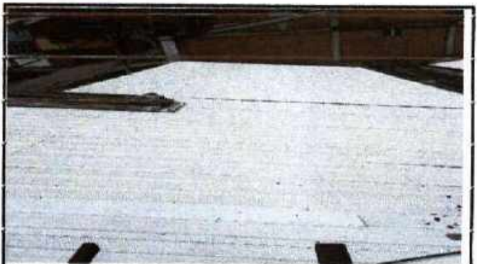
instalacion de cubierta
