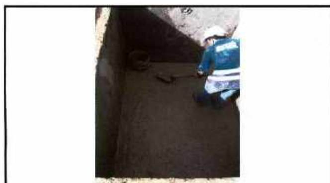
APLICACION MORTERO IMPERMEABILIZANDO ENTENA
