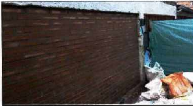
TEP MAMPUESTERIA EXTERIOR
