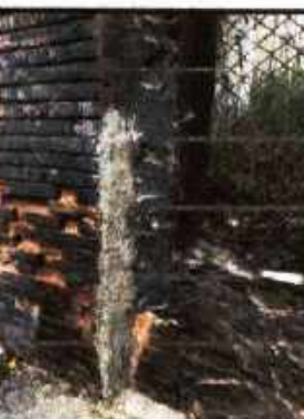
REPARACION MURO Y CUBRIMIENTO DE TUBERIA CON MORTERO
