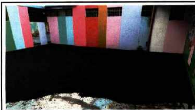
instalación de caucho negro
