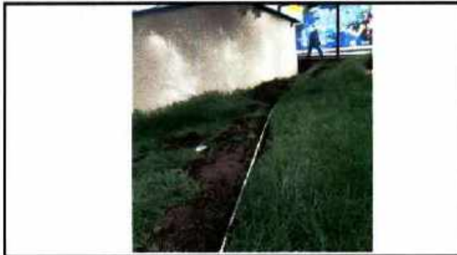
EXCAVACION Y TENDIDA DE TUBERIA
