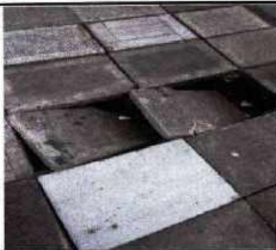
DES MONTE VSQ EN CONCRETO PREFABRICADO.
