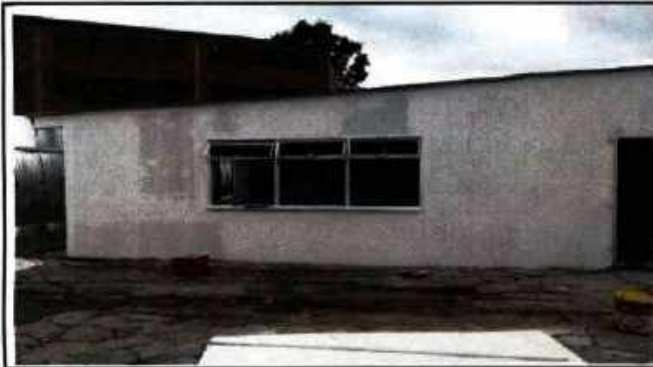
RESANE Y PINTURA DE EXTERIORES
