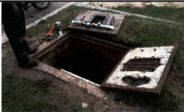
RETIRO DE ELEMENTOS Y TUBERIA EXISTENTE
