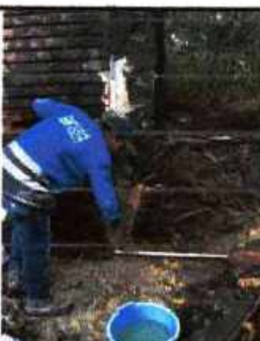
REPARACION MURO Y CUBRIMIENTO DE TUBERIA CON MORTERO
