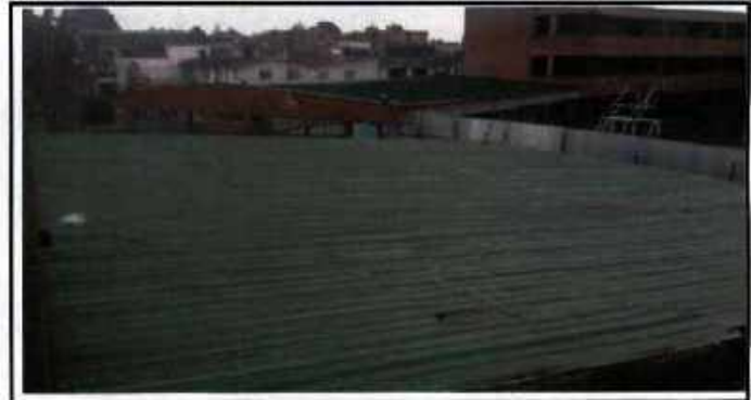
REPOSICION DE CUBIERTA E INSTALACION CIELO RASO EN PVC E ILUMINACION TIPO LED.
