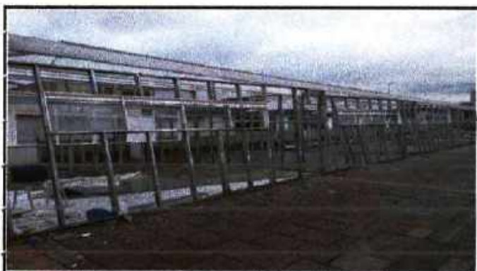
Desmonte de elementos
