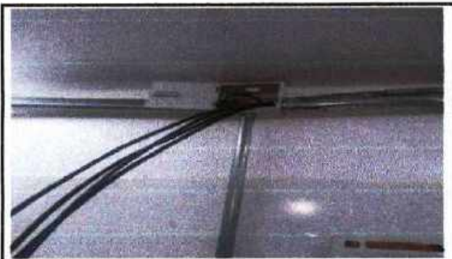
Instalación de caja de paso.
