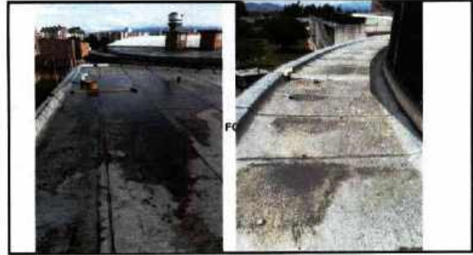
REPARACION IMPERMEABILIZACION MANTO ASFALTICO
