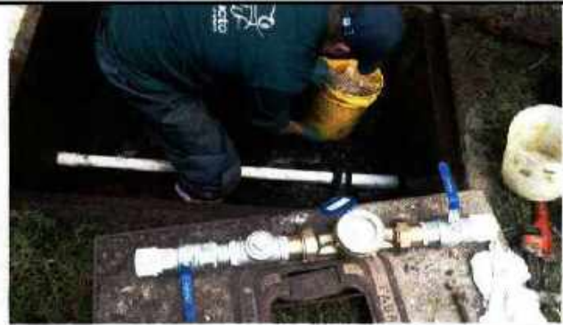
INSTALACION CONTADOR, TUBERIA, REGISTRO-VOLVULAS
