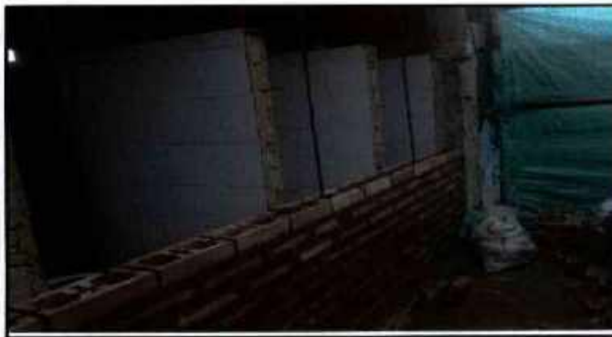
CONSTRUCCION NUEVO MURO MAMPUESTERIA EXTERIOR
