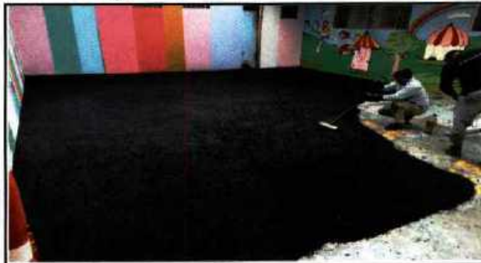
instalación de caucho
