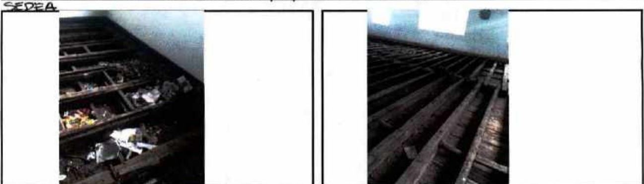
DESMONTE DE PISO EN MADERA EXISTENTE LIMPIEZA EN PISO EXISTENTE
