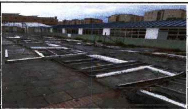
Desmonte de perfil
