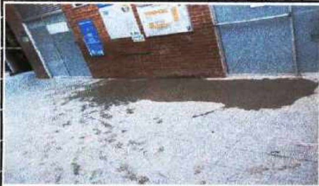
EVIDENCIA FILTRACIONES
