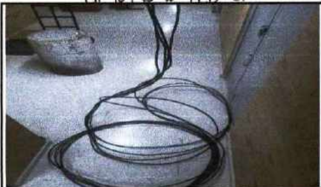
Suministro de cableado.
