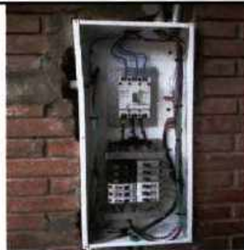
Cambio de tablero
