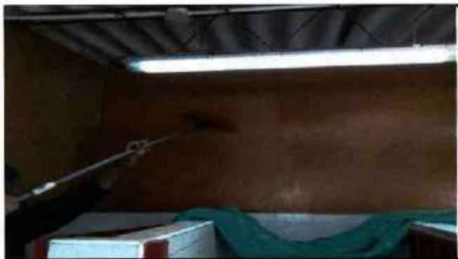
ACABADO INTERIOR EN PINTURA PARA HUMEDADES
