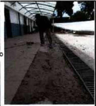
CAMBIO DE TUBERÍAS AGUAS LLUVIAS.
