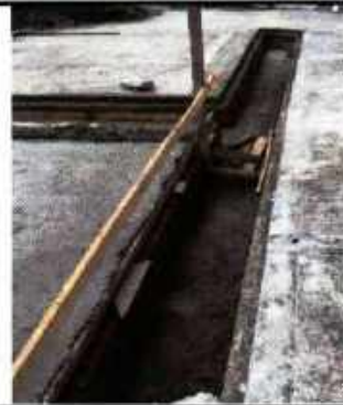
CONSTRUCCION DE CARCAMOS, CONDUCCION DE AGUAS
