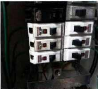
Cambio de breakers
