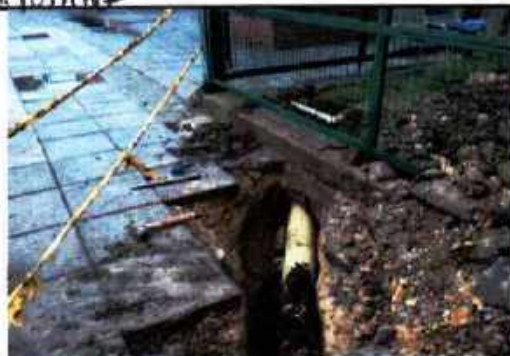
IDENTIFICACION Y MARCADO DE TUBERIAS AGUAS LUVIAS
