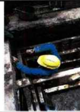
LIMPIEZA Y MEJORA DE BORDILLOS
