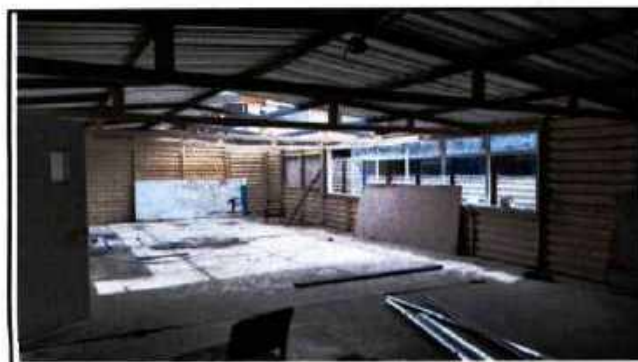
Retiro de material
