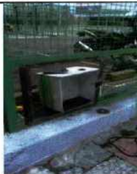
MONTAJE CAJA - GABINETE DE GAS
