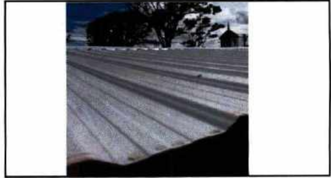
CAMBIO DE CUBIERTA
