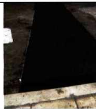
Instalación de asfalto.
