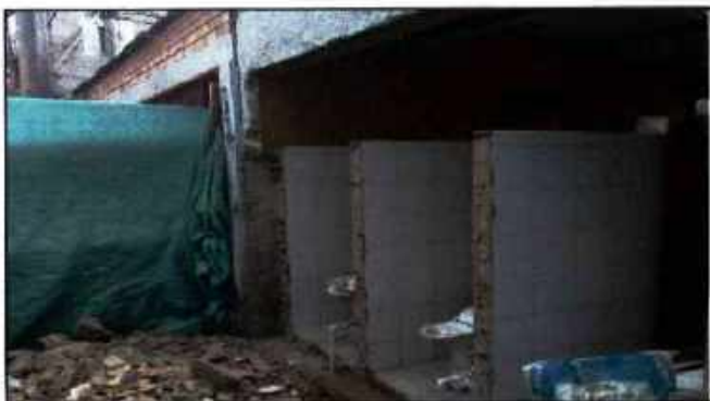
DE MOLUCION DE MUROS BUENOS
