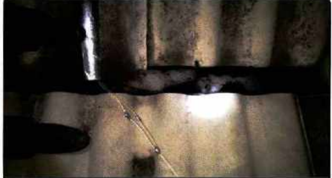
LIMPIEZA CANALES Y CUBIERTAS
