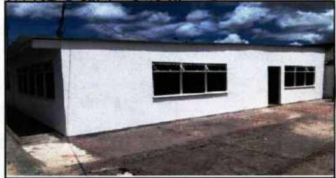
PINTURA DE VENTANERAS - ANEJO Y LIMPIEZA
