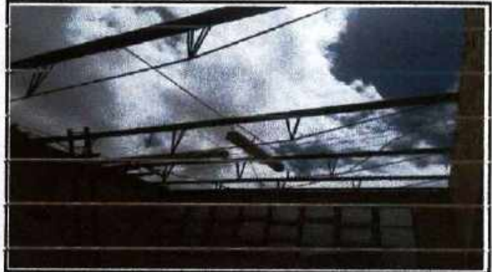
Desmonte de cubierta
