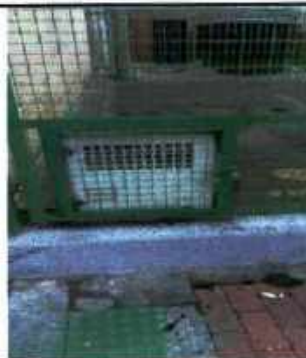
PINTURA, ASEO Y LIMPIEZA.
