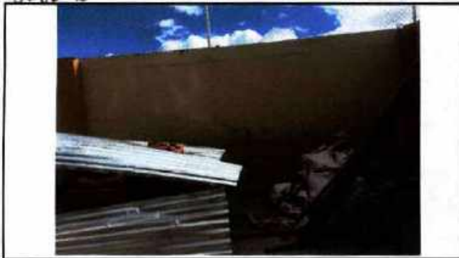
DEMOLICIÓN MURO EN PELIGRO DE CAÍDA
