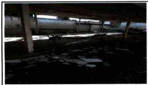
Desmonte de laminas
