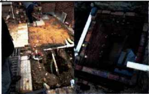
CONSTRUCCIÓN CANAL AGUAS LUVIAS PARA SEPARAR AGUA POTABLE
