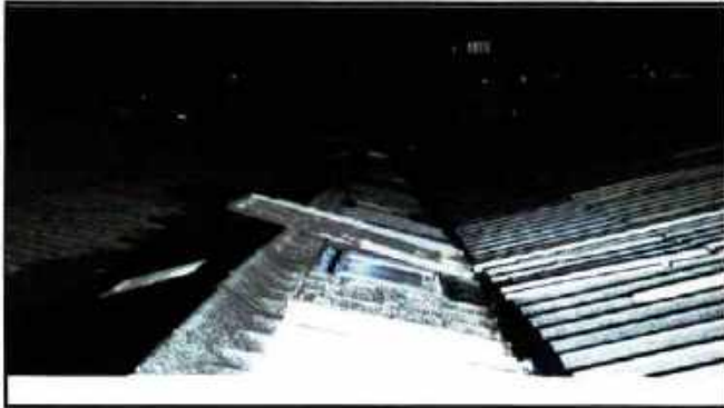
LIMPIEZA CUBIERTA Y CANALES
