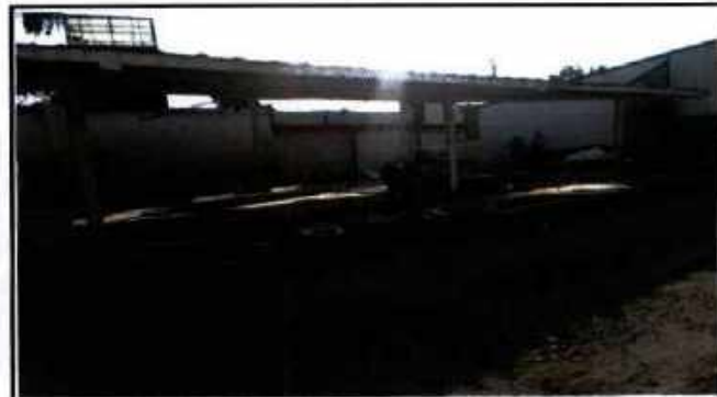
Desmonte de estructura
