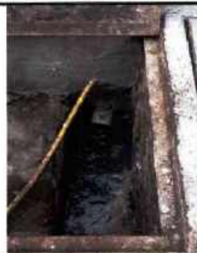
LAVADO Y LIMPIEZA DE CAJA; TRAMPA DE GRASAS
