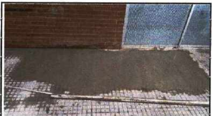
RESANE PISO EXISTENTE
