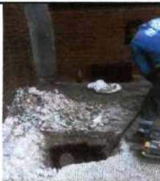
APERTURA Y LIMPIEZA DE CAJAS AGUAS RESIDUALES
