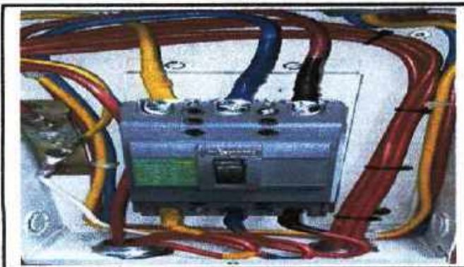
Instalación de break.
