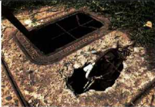
IDENTIFICACION UBICACION NUEVO CONTADOR
