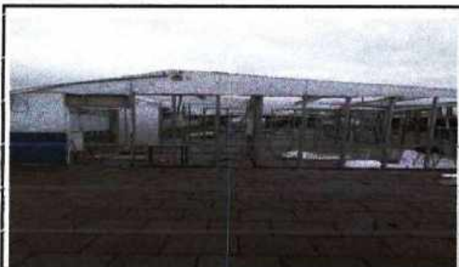
Desmonte de estructura
