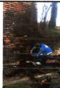
DEMOLICION MURO AFECTADO POR HUMEDAD
