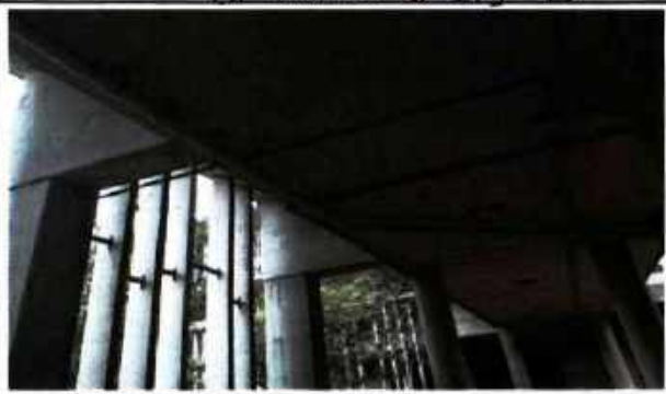
Limpieza de zonas con humedad
