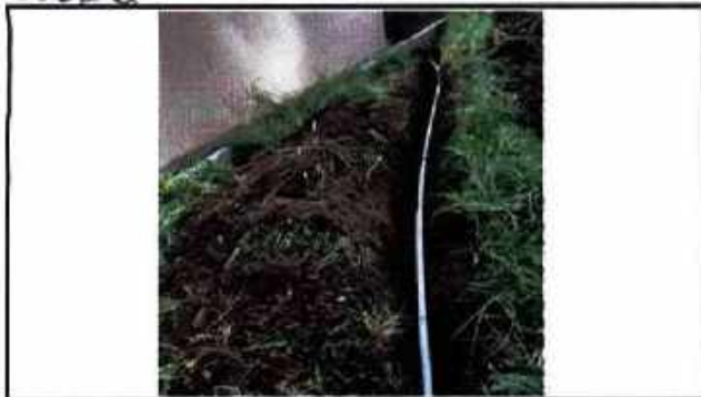
TENDIDA DE TUBERIA PVC PARA CONEXION TANQUE
