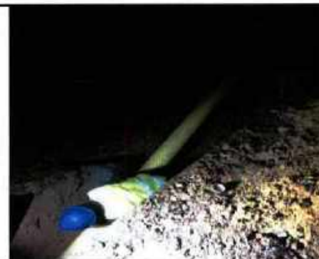
Instalación de tubería
