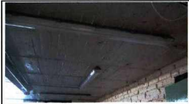
INSTALACIÓN LUMINARIAS HERMETICAS LED
