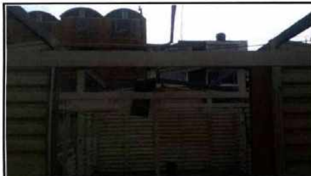
Desmonte de estructura
