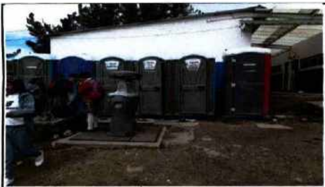
instalación de baterías de baño
