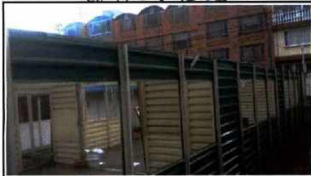
Desmonte de andamios provisionales
