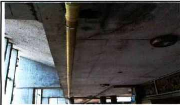
Instalación de red-distribución de placa
