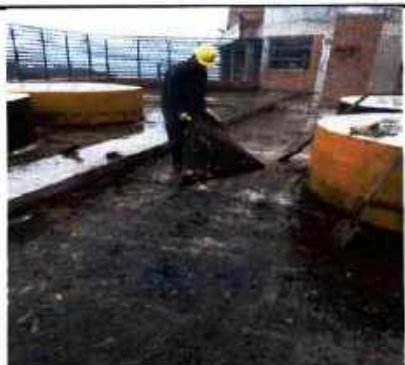
RETIRO MANTO ASINTICO DE CUBIERTA INSTANTE
