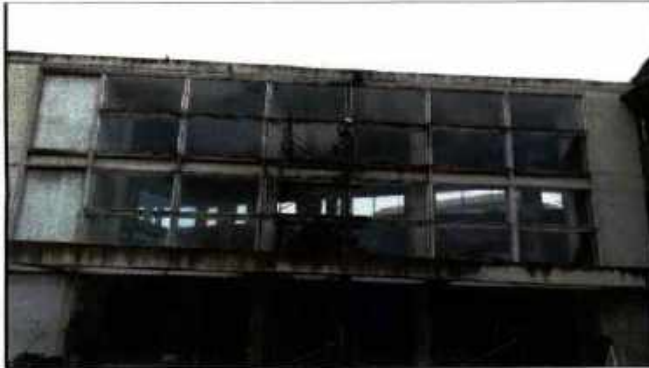
LAVADO Y RECUPERACION DE VENTANERIA.
