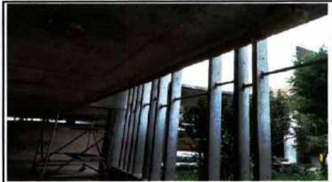
Instalación soportes de tubería
