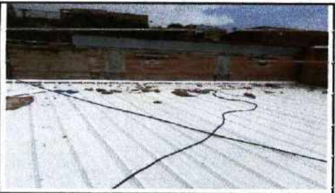
instalación de flanco
