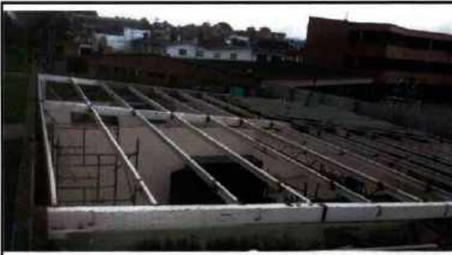
SUMINISTRO E INSTALACION CUBIERTA Y CIELO RASO.
