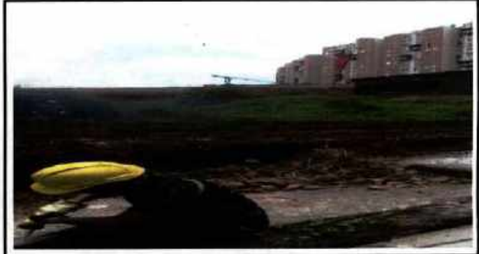
Retiro de escombros sobre la vía
