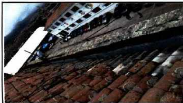
RETIRO CUBIERTA DEGRADADA.
