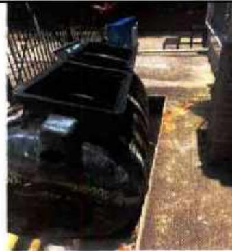
LIMPIEZA TRAMPA DE GRASAS
