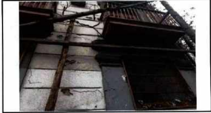
Instalacion de rallizos en madera
