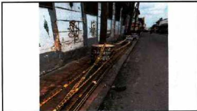
Instalacion de cinta de peligro.
