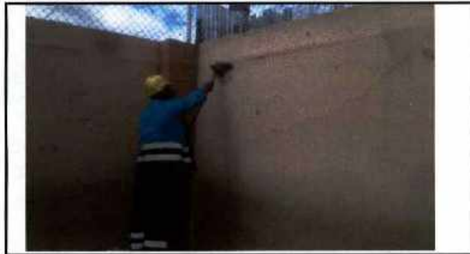
DEMOLICIÓN MURO MANUAL DE MURO
