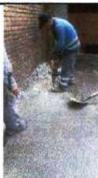
DEMOLICION BORDES DE CAJA
