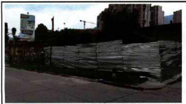
suministro e instalacion de lamina
