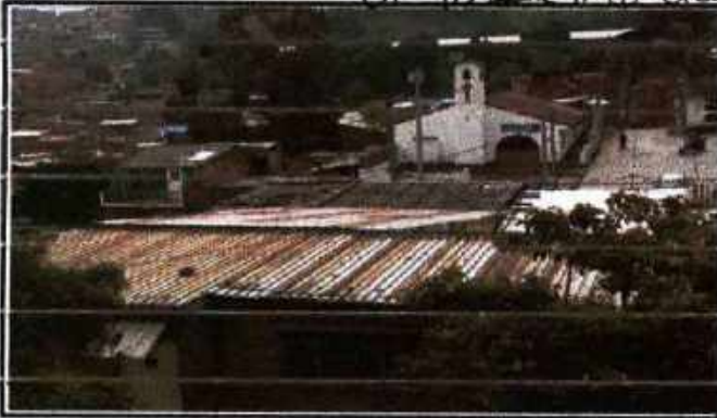
se realiza verificación de cubierta
