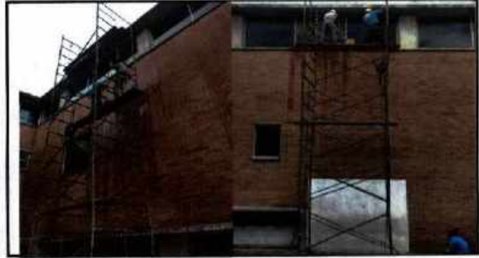
LAVADO DE FACHADA EN MAMPUESTA - HIDROLAVADO
