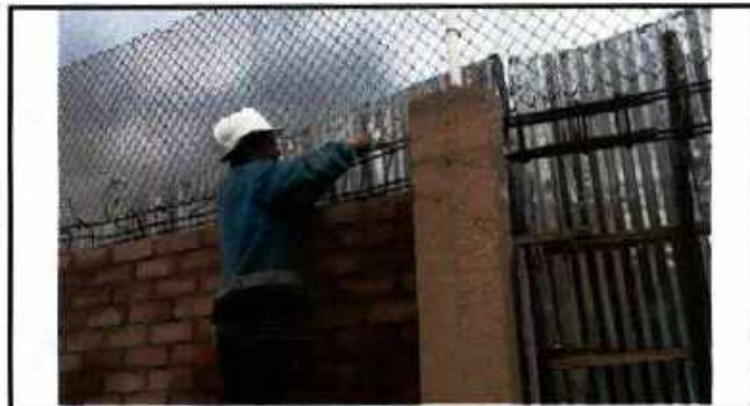
LEVANTAMIENTO DE MURO EN MAMPUESTERÍA CON FINIDO CON VIGA DE CIMENTACIÓN Y ARMADURA SUPERIOR
