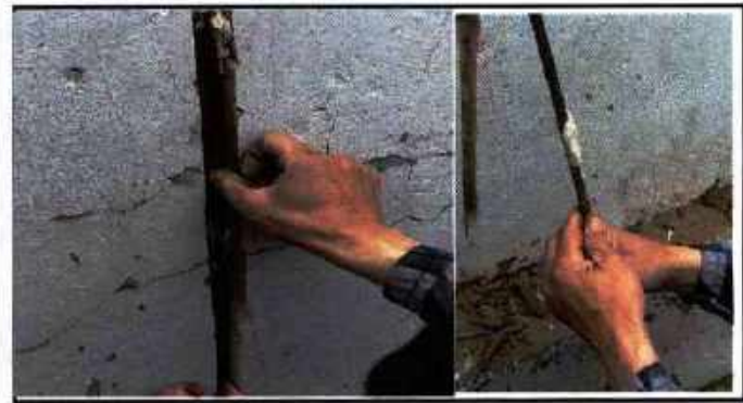
INSTALACIÓN CORTE DE VAPILLA CORRUGADA ASEGURADA CON PEXIDOS
