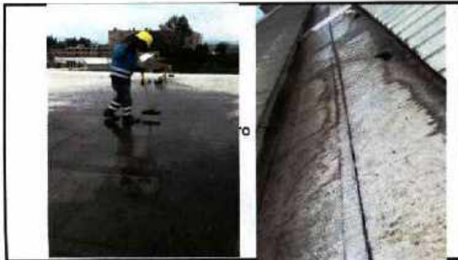
LIPIEZA DE CUBIERTA, CAVALES Y BALANES
