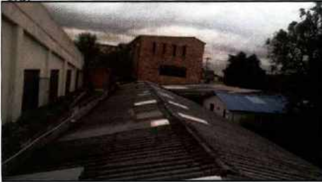
CUBIERTA EXISTENTE - VAYMONTE
