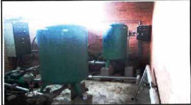
REVISIÓN Y RECONEXIÓN PUNTOS ELÉCTRICOS
