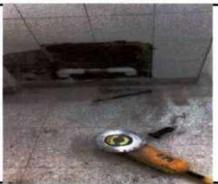
REPARACION TUBERIA CON FUGAS
