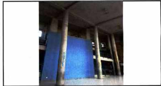
ACABADO EN PINTURA DE MUROS EXISTENTES
