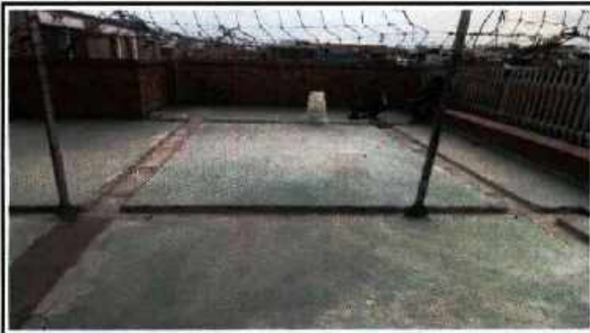
Demolición de juntas
