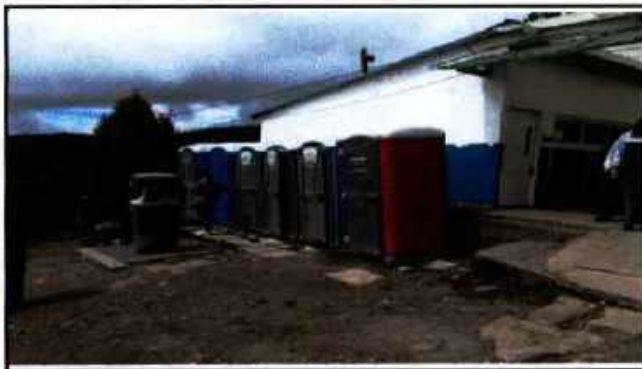
instalación de baterías de mayo
