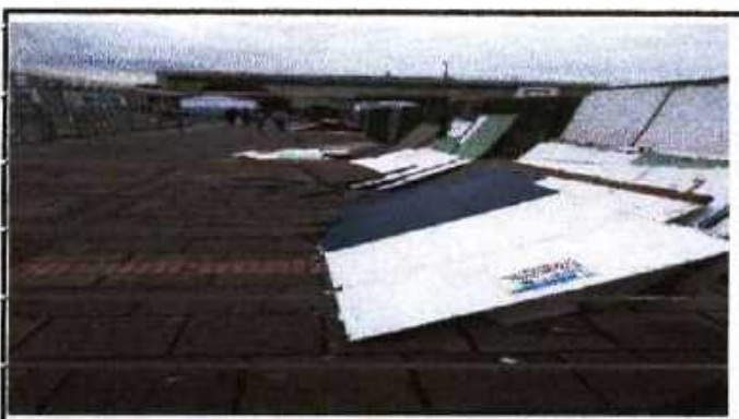
Desmonte de laminas
