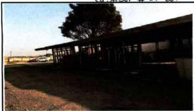
Desmonte de estructuras
