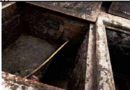
DESTAPE Y LIMPIEZA TRAMPA DE GRASAS
