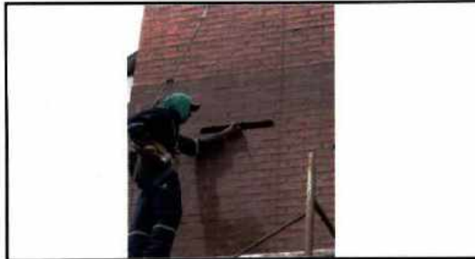
RETIRO PIEZAS EN FACHADA PARA REPARACION.
