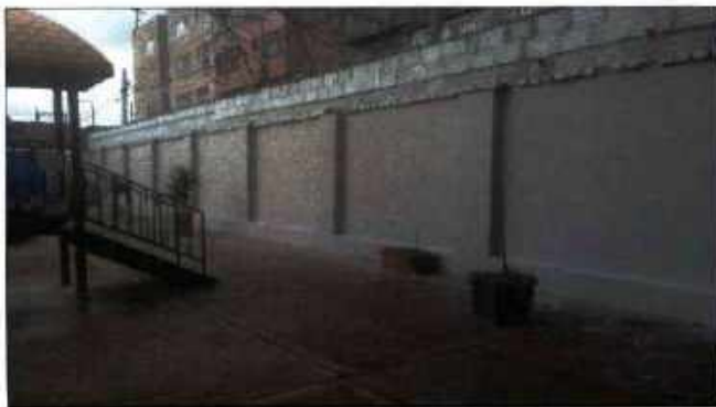
RESANE GENERAL DE MURO LIJADO Y PINTURA
