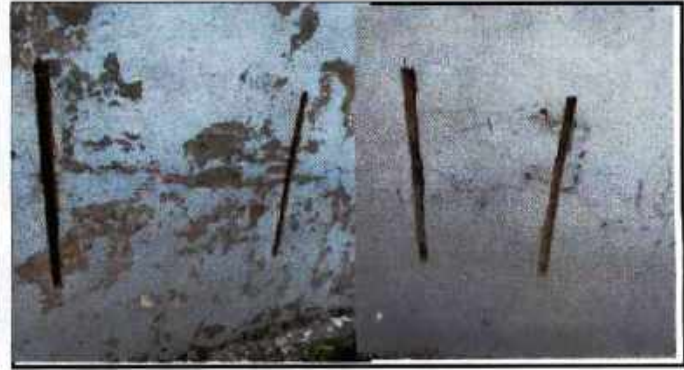
REGATA Y CORTE DE MUROS PARA REFORZAMIENTO
