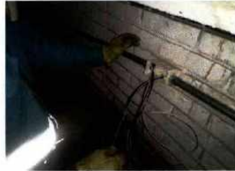
Instalación de tubería Emt
