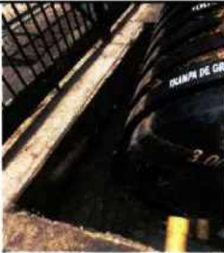
LIMPIEZA ESPACIO TRAMPA DE GRASAS ACTUAL
