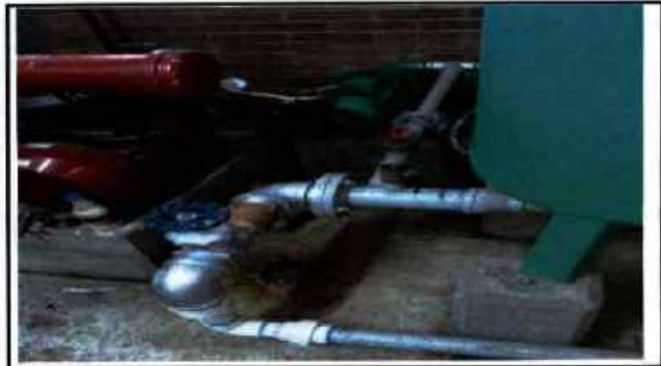
REEMPLAZO ACCESORIOS Y TUBERÍA HD.
