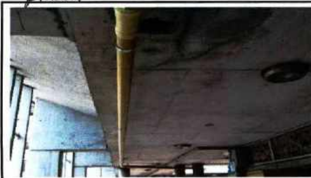
Instalación de tubería pvc
