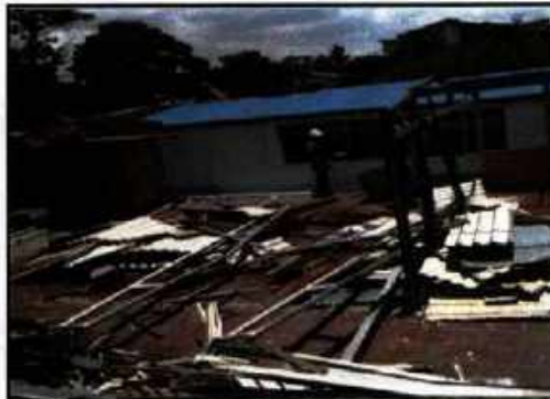
Acopio y disposición de material
