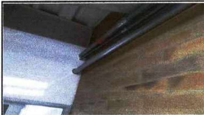
Instalación de tubería emt.
