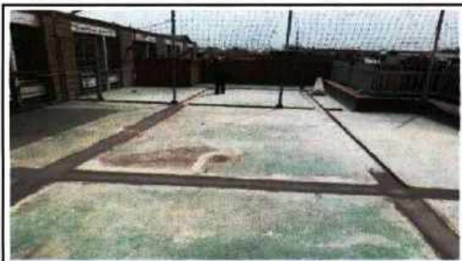
Aplicación adherencia para concreto
