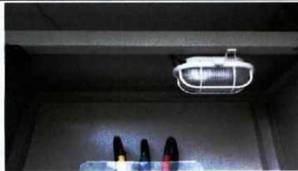
Adecuación de tubería para luminaria
