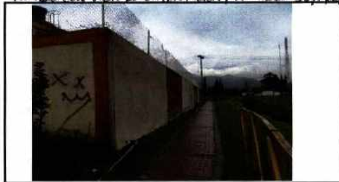
TERMINACIÓN FINAL -ASEO FINAL
