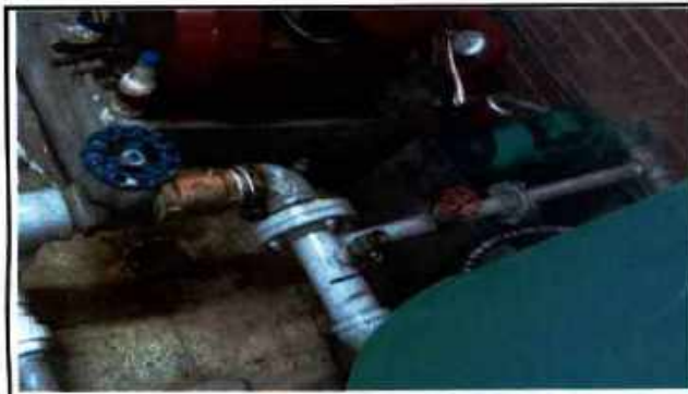
RECONEXIÓN DE TUBERÍAS
