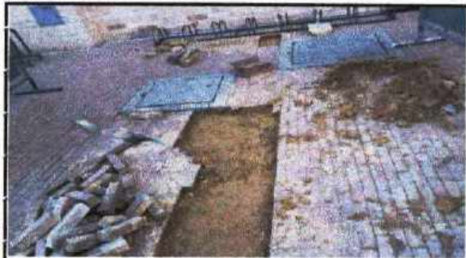
EXCAVACION DE PISO UBICACION TUBERIAS
