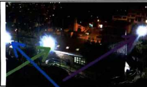
SUMONSTRO INSTALACION ILUMINACION EXTERIOR
