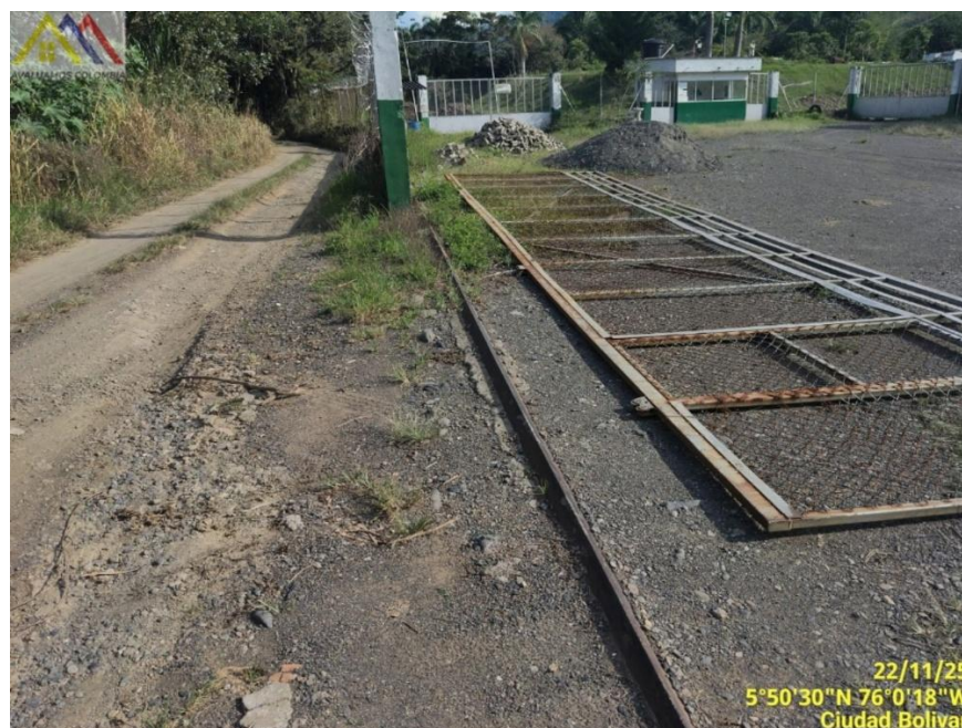
Imagen 7. frente sobre la vía.
