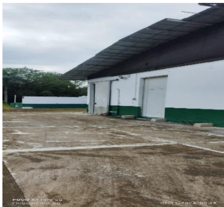
Cubierta de la PBA en mal estado y con terminación en polisombra
