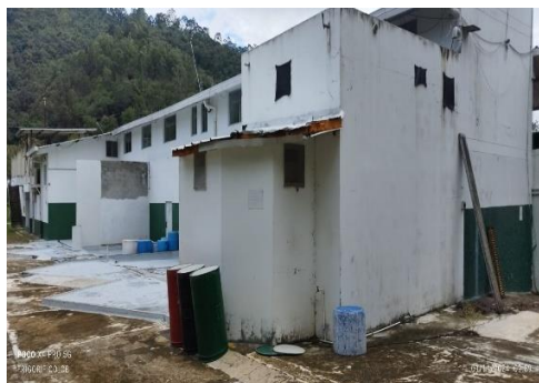
Área de cargue sin terminar
