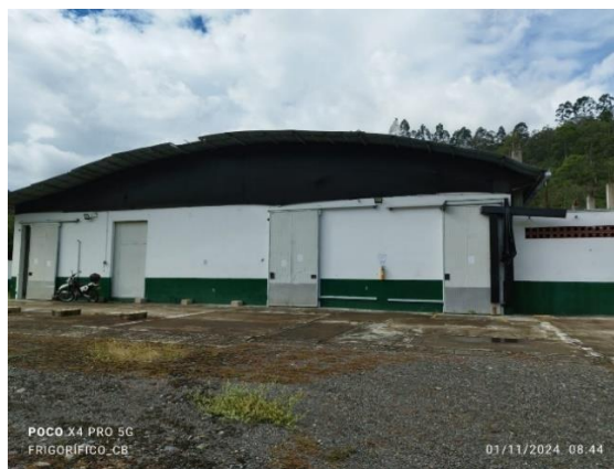
Cubierta de la PBA en mal estado y con terminación en polisombra
