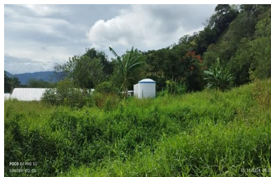
Tanques de almacenamiento deficientes
