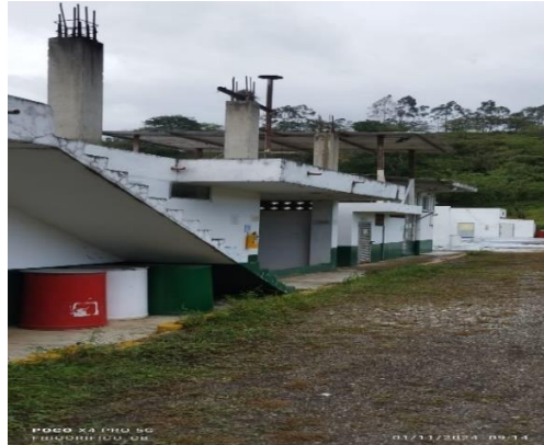
Construcciones sin terminar con hierro en espera
