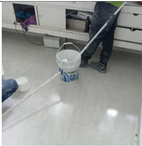
Pintura general de paredes
