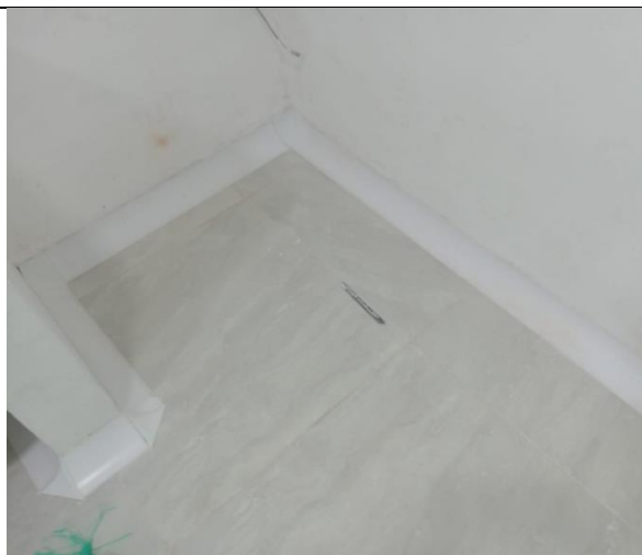
Instalación de mediacaña en PVC
