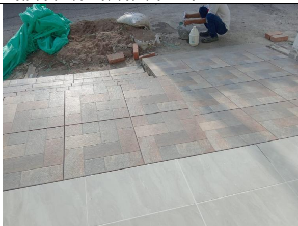
Enchape para rampa y escaleras antideslizante
