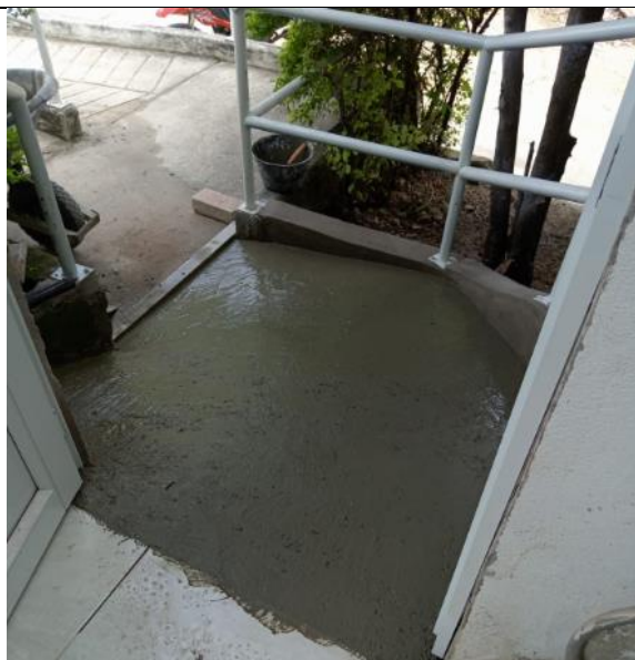
Instalación de la gravilla lavada
