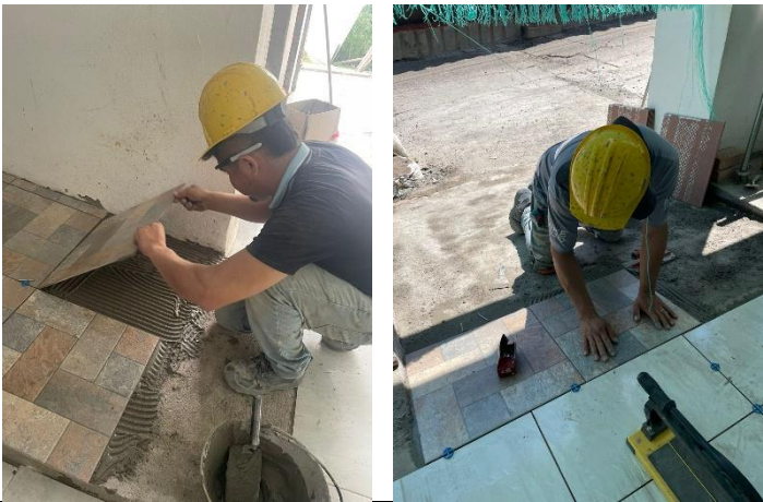
Ilustración.5 Instalación de cerámica para rampas
