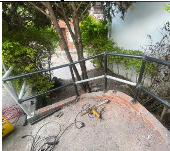
Suministro e instalación de baranda metálica
