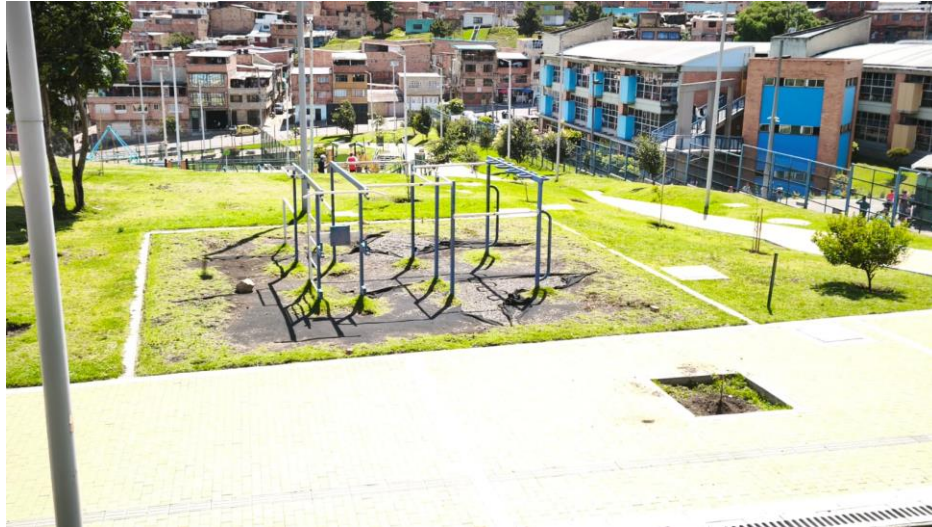
Foto # 5. Mantenimiento al área de multi fuerza se encuentra en mal estado.
