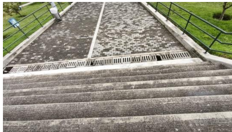
Fotos # 1,2, 3, mantenimiento de rejillas escaleras
