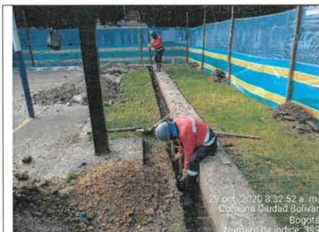
FOTO No. 194. Se revisó y verificó la profundidad de la excavación, parque URBANIZACIÓN LA ESTANCIA. 191-149
