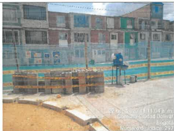
FOTO No. 167. Se revisó y verifico la instalación y almacenaje de los bordillos, parque URBANIZACIÓN LA ESTANCIA 19-150
