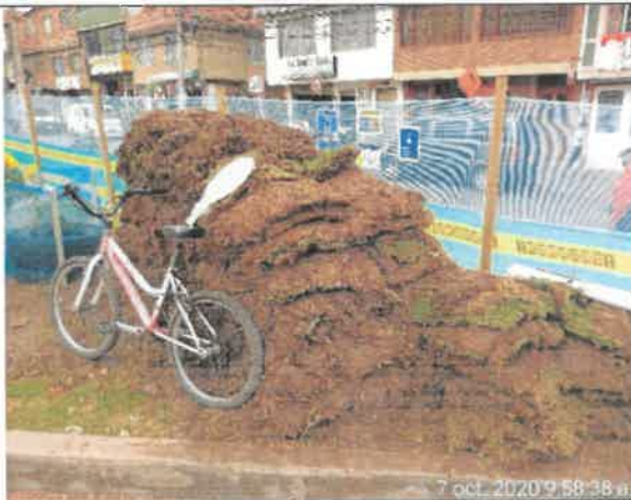
FOTO No. 131. Se revisó y verifico el acopio del sepedón, parque. PARQUE URBANIZACIÓN LA ESTANCIA. 19-038
