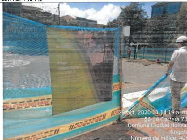
FOTO No. 197. Se revisó y verificó la instalación del pendón de identificación del parque, URBANIZACIÓN LA ESTANCIA. 191-149
