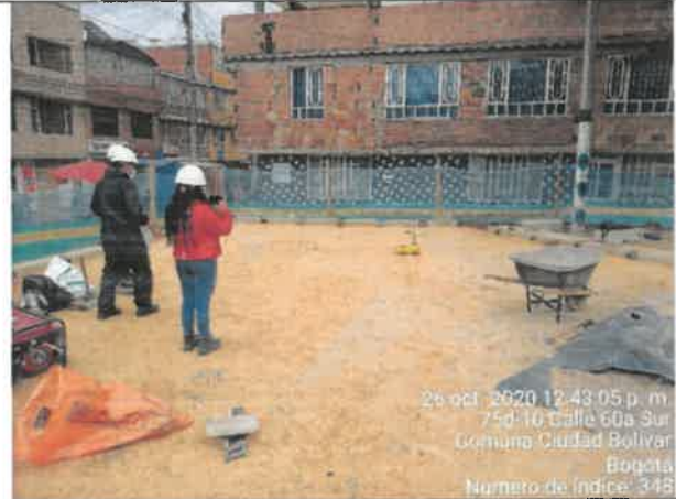
FOTO No. 179. Se revisa y verifica el área de seguridad en la toma de las densidades, parque LAS HUERTAS 19-038
