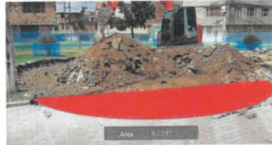
FOTO No 22. Para no afectar con la ejecución de las obras, la Interventoría y la Supervisión del contrato plantean la nueva localización, en la cual el árbol y la protección que la constituye, formará parte integral de la implantación arquitectónica, conservando las determinantes arquitectónicas de la implantación inicial.
