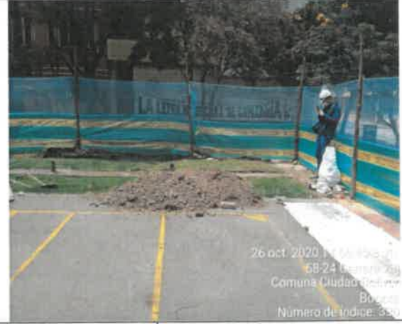
FOTO No. 89. Excavación manual para instalación de malla contra impacto PARQUE URBANIZACIÓN LA ESTANCIA 19-149
