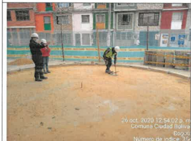
FOTO No. 182. Se revisa y verifica la ubicación del densímetro nuclear por parte de la interventoría ARQUITECTURA URBANA LTDA., parque URBANIZACIÓN LA ESTANCIA. 19-150
