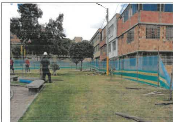
FOTO No. 206. Se revisó y verifiqué el cumplimiento de la instalación del cerramiento perimetral, parque. PARQUE URBANIZACIÓN LA ESTANCIA. 19-038
