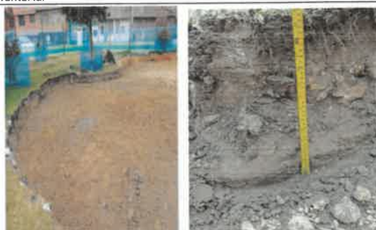
FOTO No 28. La interventoría ARQUITECTURA URBANA LTDA. Revisa y verifica que el contratista CONSORCIO OPORTO realice la actividad de excavación correspondiente al espesor de la estructura avalada por el especialista de geotecnia de la interventoría. La excavación realizada en el área de senderos es de 35 cm y en el área de juegos es de 45 cm, lo determinado por el Especialista. En la FOTO se evidencia la excavación mecánica realizada en el área de juegos infantiles.
