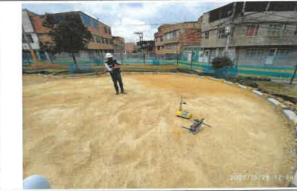
FOTO No 32. La interventoría ARQUITECTURA URBANA LTDA. Toma densidades del material de relleno para verificar los resultados con las tomas realizadas por el contratista CONSORCIO OPORTO. Los resultados de compactación son óptimas y requiere humedecer, como se evidencia en la bitácora de obra. El resultado supera los 95% de compactación arrojando un resultado de 99,8 %.
