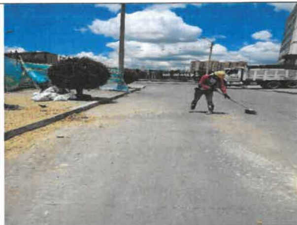
FOTO No. 156. Se revisó y verifico la actividad de limpieza y aseo de vías, parque URBANIZACIÓN CANDELARIA LA NUEVA II SECTOR Iª ETAPA (19-479)
