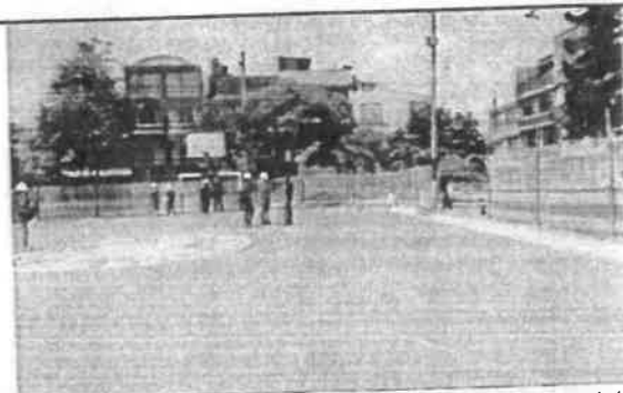
FOTO No 31: El contratista CONSORCIO OPORTO realiza actividad de cerramiento perimetral
