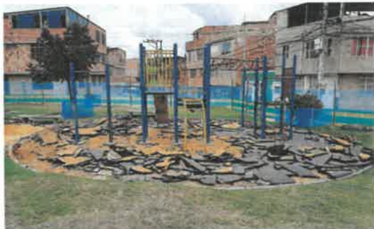
FOTO No 25. La interventoría ARQUITECTURA URBANA LTDA. Revisa y verifica la actividad de demolición de la carpeta asfáltica de la zona de juegos infantiles y determina que el grosor es de 10 cm, y la unidad de pago corresponde a M2, como lo determina las especificaciones técnicas del I.D.R.D. .
