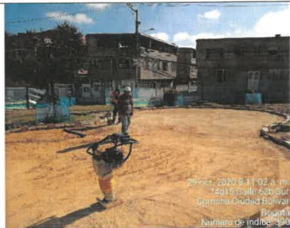
FOTO No. 116 Se revisó y verifico estado de orden y aseo de las zonas de trabajo, parque URBANIZACIÓN LA ESTANCIA. 19-038
