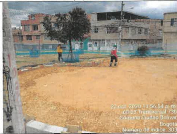
FOTO No. 173. Se revisó y verifico la utilización de los elementos de protección personal en la compactación de la sub base, parque. URBANIZACIÓN LA ESTANCIA. 19-150
