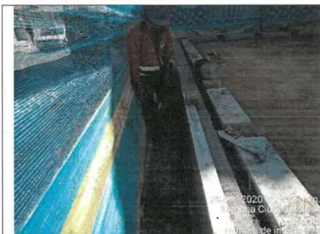
FOTO No. 190. Se revisó y verifico la utilización de los elementos de protección personal, parque URBANIZACIÓN LA ESTANCIA. 19-038
