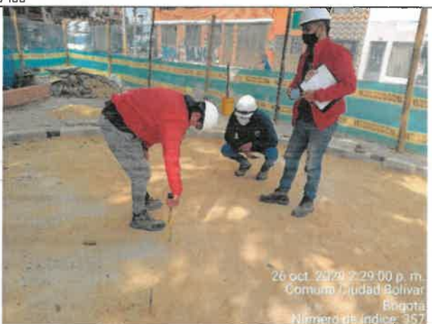
FOTO No. 183. Se revisó y verificó el replanteo y nivelación, parque URBANIZACIÓN LA ESTANCIA. 19-150
