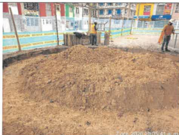
FOTO No. 134. Se revisó y verificó el cumplimiento del protocolo de bioseguridad covid-19 y el acopio del asfalto, parque. URBANIZACIÓN LA ESTANCIA. 19-150.
