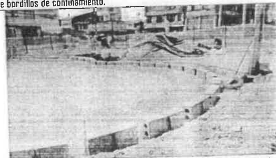
FOTO No 9: El contratista CONSORCIO OPORTO realiza actividad de instalación de bordillos de confinamiento.
