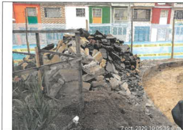
FOTO No. 133. Se revisó y verificó el cumplimiento del protocolo de bioseguridad covid-19 y la demolición de la placa de juegos, parque. URBANIZACIÓN LA ESTANCIA. 19-150
