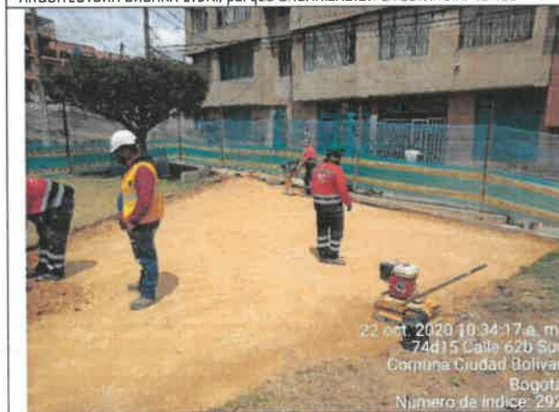
FOTO No. 172. Se revisó y verifico la utilización de los elementos de protección personal en la compactación de la sub base, parque. URBANIZACIÓN LA ESTANCIA. 19-150
