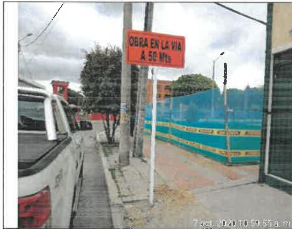
FOTO No. 141. Se revisó y verifico el cumplimiento la existencia de la señalización del plan de manejo de tránsito (PMT).. parque CANDELARIA LA NUEVA II SECTOR 1ª ETAPA (19-479)
