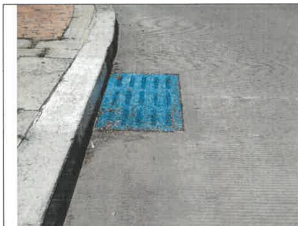
FOTO No. 155. Se revisó y verifico la protección de los sumideros, parque URBANIZACIÓN CANDELARIA LA NUEVA II SECTOR Iª ETAPA (19-479)
