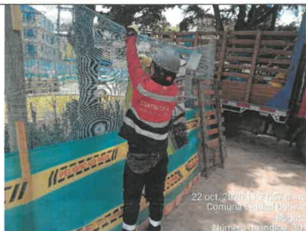
FOTO No. 169. Se revisó y verifico el cumplimiento de la instalación del pendón informativo, parque URBANIZACIÓN LA ESTANCIA 19-150
