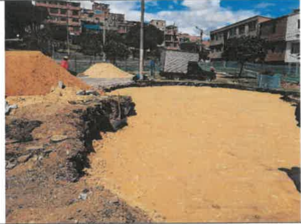
FOTO No. 150. Se revisó y verifico el acopio temporal de material pétreo, sin hacer uso de polietileno en el piso para protección de la zona, parque. URBANIZACIÓN LA ESTANCIA. 19-039
