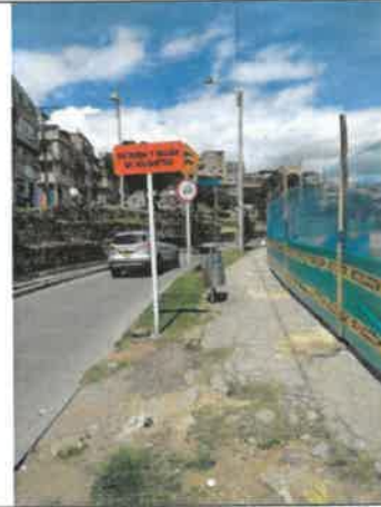
FOTO No. 95. Instalación señalización plan de manejo de tráfico, parque URBANIZACIÓN LA ESTANCIA 19-039
