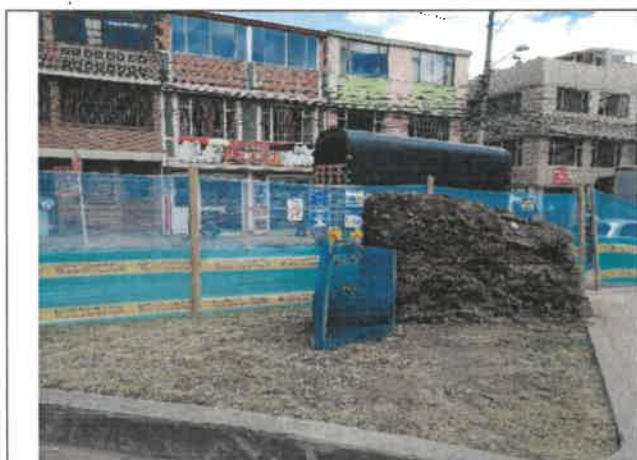
FOTO No. 153. Acopio de césped para reutilización de material en áreas afectadas
