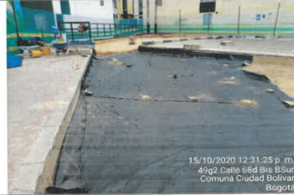
FOTO No 68. La interventoría ARQUITECTURA URBANA LTDA. Revisa y verifica que el contratista CONSORCIO DPORTO haya suministrado el control de calidad de los materiales, como es del GEOTEXTIL GEOST300 Y/O T2100 (SUM+INST), y que cumpla con los requisitos del traslape. La interventoría ARQUITECTURA URBANA LTDA. revisa la documentación suministrada por el contratista y evidencia que el material es certificado por el proveedor y entrega resultados de las pruebas de laboratorio, como es del punzómetro, espesor y fluidez de fibras GEOTEXTIL
