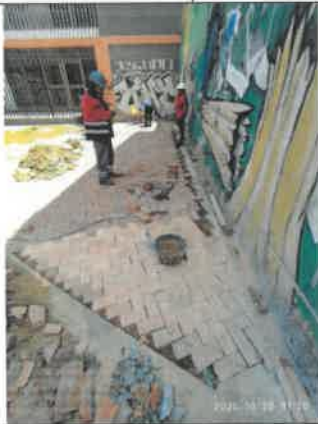
FOTO No 85. La interventoría ARQUITECTURA URBANA LTDA. solicita mediante bitácora de obra reutilizar los adoquines desmontados, los cuales no presentan deterioro
