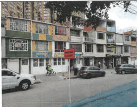
FOTO No. 1. Se revisó y verificó la instalación de señalización, parque URBANIZACIÓN LA ESTANCIA (19-150)
