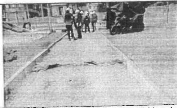
FOTO No 1: El contratista CONSORCIO OPORTO realiza actividad de instalación de relleno en zona de juegos, plazoleta y senderos a nivel de subbase granular.
