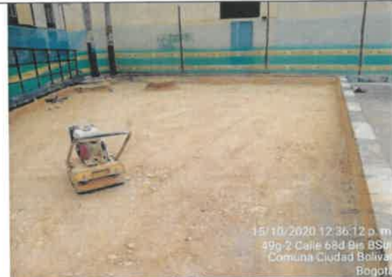
FOTO No 67. La interventoría ARQUITECTURA URBANA LTDA. Evidencia que una vez el contratista cumpla con las profundidades de la excavación de la estructura, debe compactar la su-rasante del terreno de excavación para colocar el GEOTEXTIL. La profundidad de la excavación correspondiente al área de juegos biosaludables de 45 cm determinado por el espesor de la estructura, avalada por el especialista de geotecnia de la interventoría.
