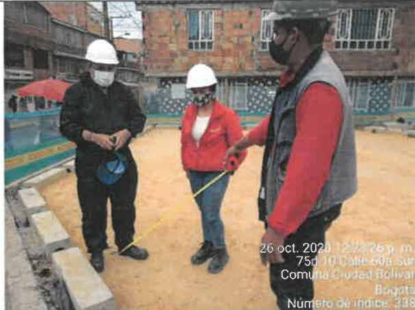
FOTO No. 176. Se revisa y verifica la utilización de los elementos de protección personal (EPP), parque LAS HUERTAS 19-038
