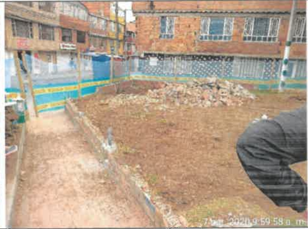
FOTO No. 132. Se revisó y verifico el acopio del material de escombro, parque. PARQUE URBANIZACIÓN LA ESTANCIA. 19-038
