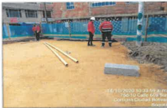
FOTO No 39. Una vez determinado los niveles que se incluyen en el área de trabajo mediante topografía realizada por el contratista y con seguimiento del área de
