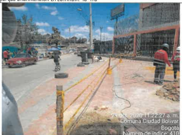
FOTO No. 201 Se revisó y verifico la señalización del parque, URBANIZACIÓN LA ESTANCIA. 19-479
