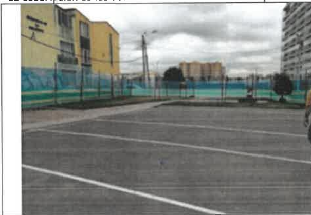
FOTO No 61 La interventoría ARQUITECTURA URBANA LTDA. Revisa y verifica que el contratista CONSORCIO OPORTO realice la actividad de cerramiento perimetral y supervisa que los lineamientos del PLAN DE MANEJO DE TRANSITO P.M.T. se cumplan a cabalidad.
