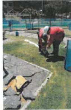
FOTO No 21. La interventoría ARQUITECTURA URBANA LTDA. Revisa y verifica que el contratista CONSORCIO OPORTO realice las actividades de localización y replanteo, se hace necesario desplazar la localización general hacia el costado sur oriental, para no afectar el árbol existente.
