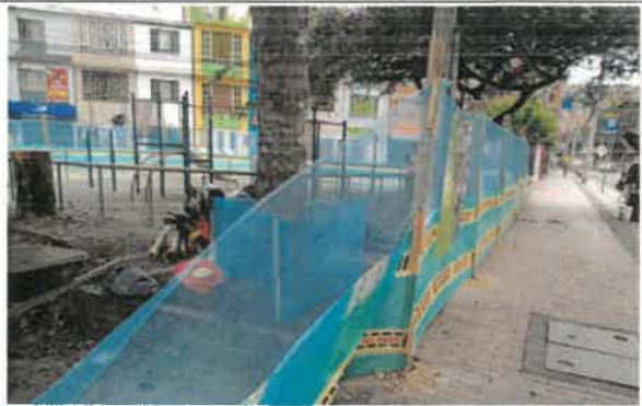
FOTO No. 205. Se revisó y verifico el cumplimiento del protocolo de cerramiento, parque. URBANIZACIÓN LA ESTANCIA. 19-150
