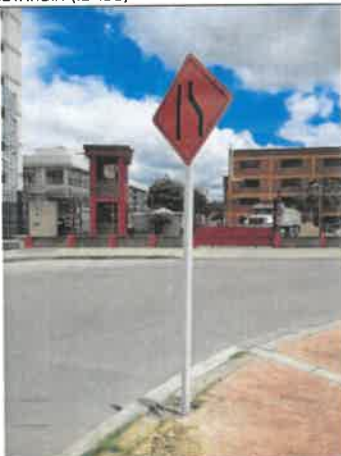
FOTO No. 3. Se revisó y verificó la instalación de señalización, parque CANDELARIA LA NUEVA II SECTOR 1ª ETAPA (19-479)
