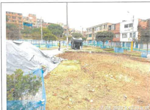
FOTO No. 125. Se revisó y verifico el cumplimiento del protocolo de bioseguridad covid-19 y la instalación de un campamento provisional, parque. URBANIZACIÓN LA ESTANCIA. 19-039
