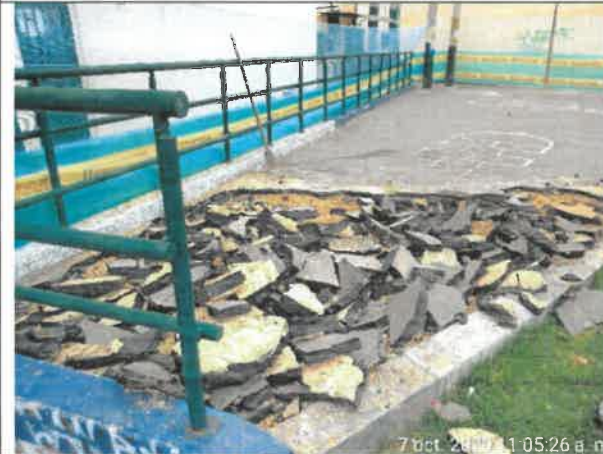
FOTO No. 145. Se revisó y verificó el cumplimiento del acopio de asfalto para la entrega al gestor autorizado, parque CANDELARIA LA NUEVA II SECTOR 1ª ETAPA (19-479)
