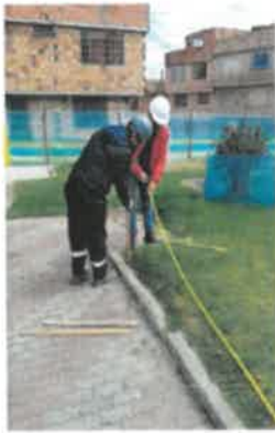
FOTO No 21. La interventoría ARQUITECTURA URBANA LTDA. Revisa y verifica que el contratista CONSORCIO OPORTO realice las actividades de localización y replanteo, se hace necesario desplazar la localización general hacia el costado sur oriental, para no afectar el árbol existente.
