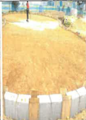
FOTO No 31. Una Vez verificado los niveles del relleno de la base granular, La interventoría ARQUITECTURA URBANA LTDA. Ubica las áreas que requieren ser subsanadas, previa a realizar las tomas de densidades, se deja evidencia en la Bitácora de obra.
