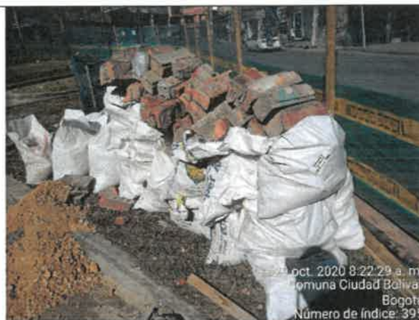
FOTO No. 191. Se revisó y verifico el acopio de material de excavación y demolición, parque URBANIZACIÓN LA ESTANCIA. 19-038
