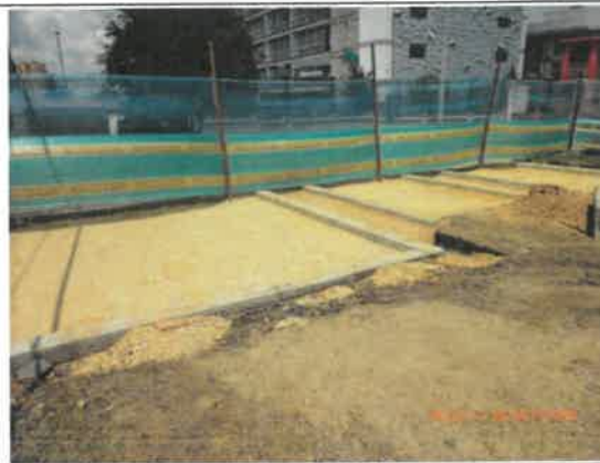
FOTO No 70 La interventoría ARQUITECTURA URBANA LTDA. Revisa y verifica que se realicen las actividades de compactación de la sub-base y de la instalación de los bordillos PREFABRICADO A 80 de acuerdo a las especificaciones técnicas de calidad y de instalación exigida por el INSTITUTO DISTRITAL DE RECREACIÓN Y DEPORTE I.D.R.D. El contratista entrega pruebas de laboratorio de los prefabricados de los bordillos, por solicitud de la interventoría, los resultados de flexión y de rotura de los bordillos Cumplen con las especificaciones técnicas, - NTC 4109. Y entrega la certificación de calibración de la prensa
