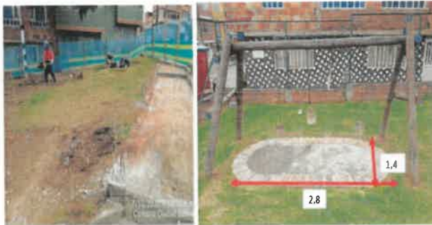
FOTO No 37 La interventoría ARQUITECTURA URBANA LTDA. Revisa y verifica que el contratista CONSORCIO OPORTO realice la actividad de demolición de concreto existente y excavación. El concreto para la demolición es de 3,92 M2. El espesor del concreto demolido corresponde a 8.0 cm.
