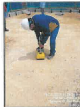
FOTO No 40. La interventoría ARQUITECTURA URBANA evidencia y determina los puntos para las tomas de densidades de las sub-base granular por parte del
