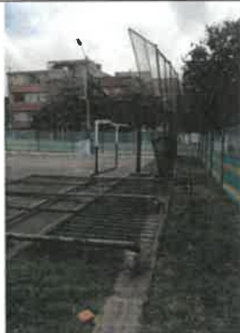
FOTO No 77. La interventoría ARQUITECTURA URBANA LTDA. Revisa y verifica que el contratista CONSORCIO OPORTO cumpla con las directrices que debe asumir en cuanto al desmonte de la malla contra impacto y al inicio de la excavación del cerramiento de malla contra impacto. El contratista deberá suministrar la disposición final de la malla contra impacto
