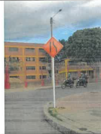
FOTO No. 97. Se revisó y verificó la instalación de señalización, parque CANDELARIA LA NUEVA II SECTOR 1ª ETAPA (19-479)
