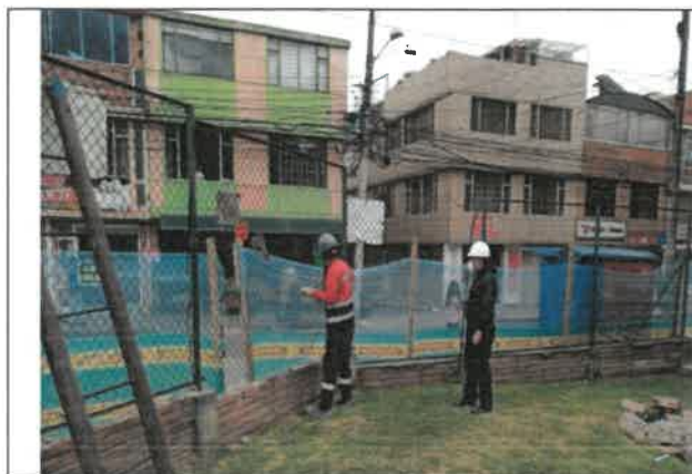
FOTO No. 210. Se revisó y verificó la demolición existente por parte de Arq. Nelson Mauricio Barrera Benavides. La interventora. PARQUE URBANIZACIÓN LA ESTANCIA. 19-039
