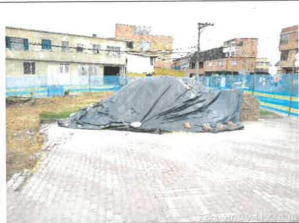
FOTO No. 128. Se revisó y verifico el cumplimiento de la protección de los acopios del material parque. URBANIZACIÓN LA ESTANCIA. 19-03
