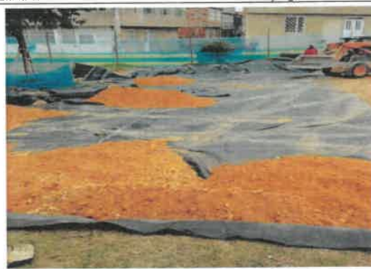
FOTO No 30. La interventoría ARQUITECTURA URBANA LTDA. revisa la documentación suministrada por el contratista y evidencia que el material es certificado por el proveedor y entrega resultados de las pruebas de laboratorio, como es del punzómetro, espesor y fluidez de fibras GEOTEXTIL
