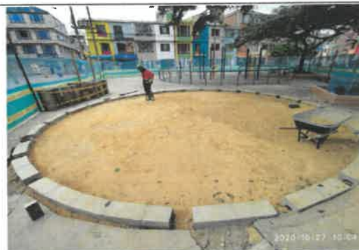
FOTO No 58. La interventoría ARQUITECTURA URBANA LTDA. Revisa y verifica que el contratista corrija los niveles encontrados, por lo tanto debe escarificar montículos encontrados. Se deja evidencia en bitácora de obra el día 27 de octubre de 2020.
