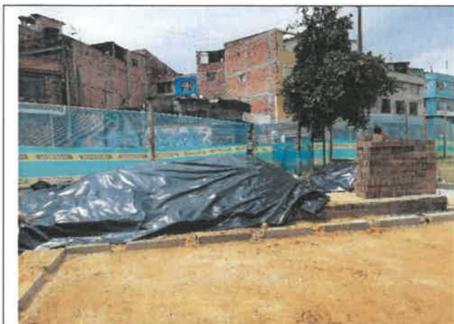
FOTO No. 159. Se revisó y verificó el cumplimiento de la protección de material pétreo, URBANIZACIÓN LA ESTANCIA 19-039
