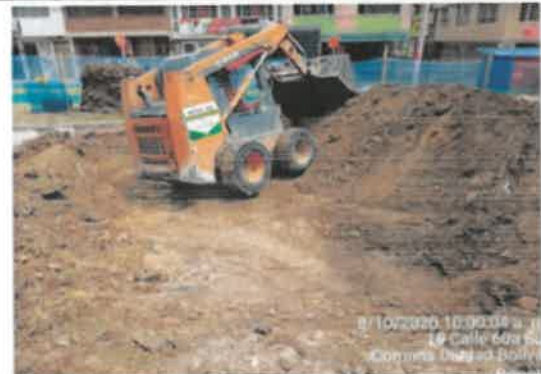
FOTO No 38 La interventoría ARQUITECTURA URBANA LTDA. Revisa y verifica que el contratista CONSORCIO OPORTO realice la actividad de excavación correspondiente al espesor de la estructura avalada por el especialista de geotecnia de la interventoría. La excavación es de 117,90 M2 x 0,35 de profundidad, de acuerdo a las carteras topográficas.
