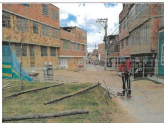
FOTO No. 207. Se revisó y verifiqué el cumplimiento de la instalación del cerramiento perimetral, parque. PARQUE URBANIZACIÓN LA ESTANCIA. 19-038
