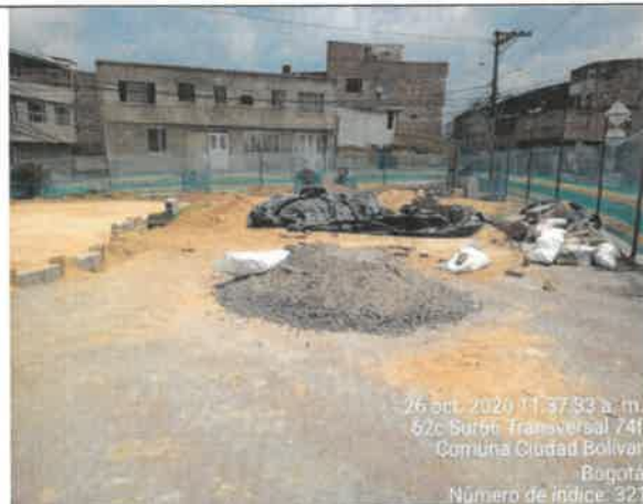
FOTO No. 111. Se revisó y verificó el acopio temporal de material pétreo, con su respectivo material de protección de polietileno, parque URBANIZACIÓN LA ESTANCIA (19-038)
