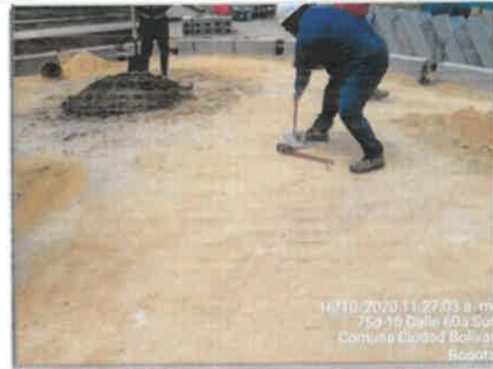
FOTO No 24. La interventoría ARQUITECTURA URBANA LTDA. Una vez realizada la actividad de relleno de sub base b 400, revisa y verifica que el contratista CONSORCIO OPORTO realice la actividad de la toma de densidades en el área de juegos infantiles y de la plazoleta, en donde la interventoría determina y localiza dos puntos por área para realizar las tomas y poder determinar que la compactación sea la óptima., que corresponde al 95%, dados por los resultados del PROCTOR.
