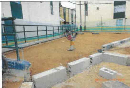
FOTO No 75. La interventoría ARQUITECTURA URBANA LTDA. Revisa y verifica que el contratista CONSORCIO OPORTO realice la actividad de compactación de la SUB BASE B 400 de acuerdo al espesor de 25 cm avalado por la interventoría de la estructura del piso.
