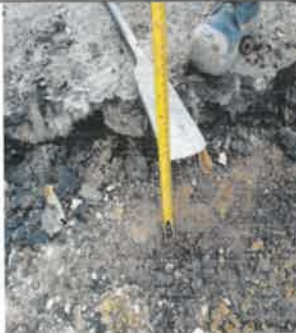
FOTO No 49. La interventoría ARQUITECTURA URBANA LTDA. Revisa y verifica que el contratista CONSORCIO OPORTO realice la actividad de demolición de la carpeta asfáltica. Se evidencian dos espesores: un área de 20 cm y otra de 14 cm.
