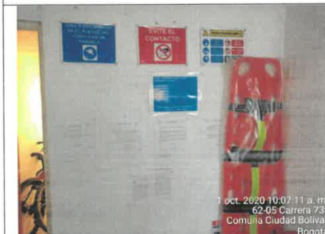
FOTO No. 119 Se revisa y verifica la instalación de los equipos de emergencia en el campamento (camilla, férula cervical, botiquín y extintor)
