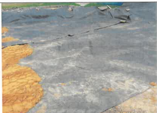
FOTO No 29 La interventoría ARQUITECTURA URBANA LTDA. Ha determinado que los lineamientos para la ejecución de actividades debe el contratista entregar las fichas técnicas de los materiales, y la certificación de calidad. Una vez es evidenciado que el suministro del GEOTEXTIL T2100 corresponde a GEOTEXTIL
