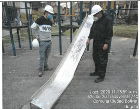
FOTO No. 118 Se realiza Verificación de las medidas de Seguridad Tomadas por el contratista CONSORCIO OPORTO en la desinstalación de los juegos existentes Dejándolos señalizados con cintas de seguridad y plástico. PARQUE URBANIZACIÓN LA ESTANCIA. 19-038
