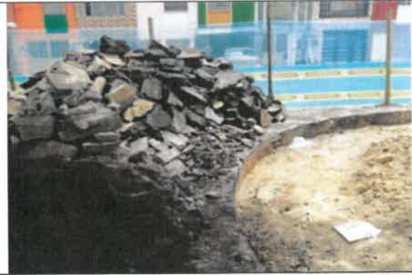
FOTO No 50. La interventoría ARQUITECTURA URBANA LTDA. Revisa y verifica que el contratista CONSORCIO OPORTO realice la actividad de excavación correspondiente al espesor de la estructura avalada por el especialista de geotecnia de la interventoría. 10cm, de placa, 15cm de base y 20 cm de SUBBASE B400. La excavación final fue de 40 cm. Se dejaron 5 cms sobre el nivel para manejo de aguas de escorrentía.
