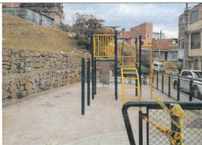
FOTO No. 161. Se revisa y verifica la instalación de la señal de peligro, parque LAS HUERTAS 19-287
