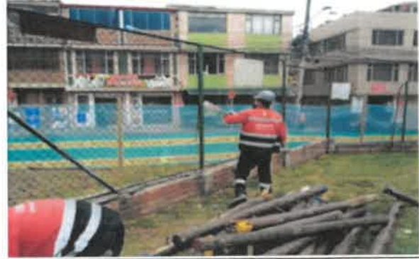
FOTO No 36. La interventoría ARQUITECTURA URBANA LTDA. Revisa y verifica que el contratista CONSORCIO OPORTO realice la actividad de desmonte del juego infantil en madera, el cual por su deterioro se da de baja mediante un acta de desmonte de mobiliario. Para considerar procedente la actividad de retiro de material de obra por parte del contratista, debe soportar con los vales que certifiquen la disposición final de los materiales de demolición y de desmonte.
