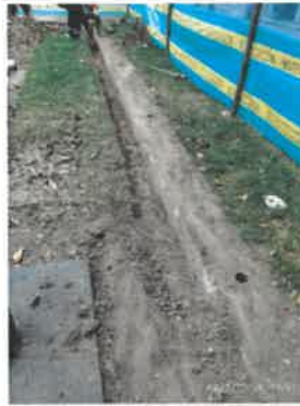
FOTO No 78. La interventoría ARQUITECTURA URBANA LTDA. Indica la ubicación de la excavación atendiendo a las dimensiones de las especificaciones técnicas del I.D.R.D. y conservará la cimentación existente para no incurrir en gastos innecesarios de demolición de la cimentación. Se deja evidencia en bitácora de obra en la primera quincena del mes de octubre de 2020
