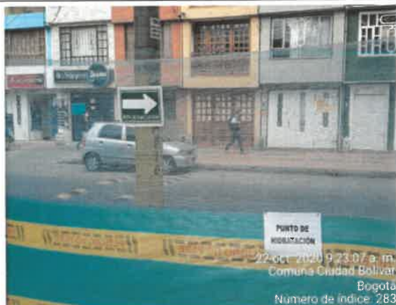
FOTO No. 98. Instalación señalización, parque URBANIZACIÓN LA ESTANCIA 19-150
