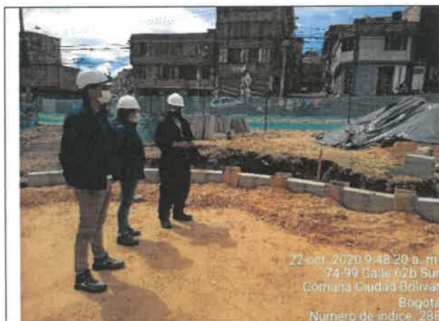
FOTO No. 170. Se realiza visita de obra por los profesionales de la interventoría ARQUITECTURA URBANA LTDA., parque URBANIZACIÓN LA ESTANCIA. 19-150
