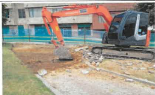
FOTO No 27. La interventoría ARQUITECTURA URBANA LTDA. Revisa y determina que la excavación mecánica cumpla con los niveles determinados por el especialista de geotecnia de la interventoría que corresponde a 25 cm de base y 10 de placa. El nivel de descole de aguas lluvias lo determina el andén perimetral del costado occidental, y se hará un tratamiento mediante cañuelas prefabricadas.
