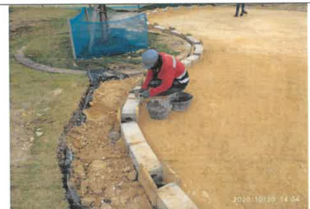
FOTO No 33. La interventoría ARQUITECTURA URBANA LTDA. Revisa y verifica que el contratista CONSORCIO OPORTO realice la actividad de instalación y emboquillado de los bordillos prefabricados A-80. El contratista entrega pruebas de laboratorio de los prefabricados de los bordillos, por solicitud de la interventoría. Los resultados de flexión y de rotura de los bordillos Cumplen con las especificaciones técnicas, - NTC 4109. Y entrega la certificación de calibración de la prensa
