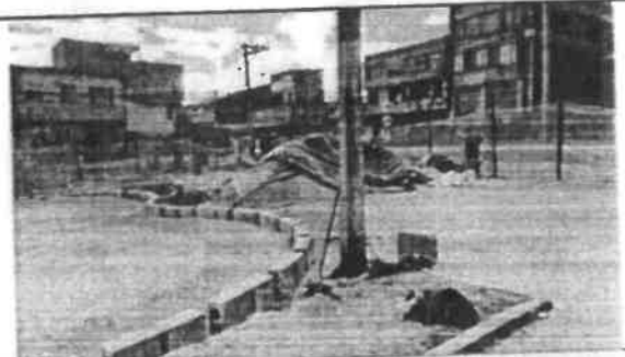
FOTO No 8: El contratista CONSORCIO OPORTO realiza actividad de instalación de relleno en zona de juegos, plazoleta y senderos a nivel de subbase granular.
