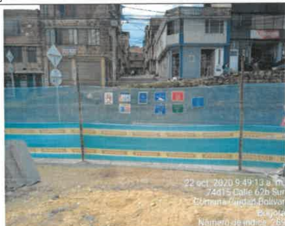
FOTO No. 100. Instalación señalización, parque URBANIZACIÓN LA ESTANCIA 19-038
