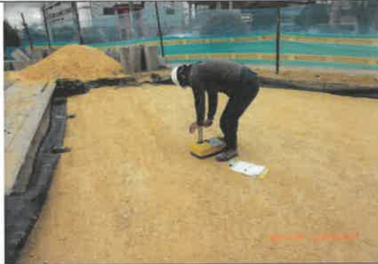
FOTO No 73. La interventoría ARQUITECTURA URBANA LTDA. Evidencia las densidades realizadas por el contratista en el área de los juegos infantiles, CUMPLE con un resultado superior al del proctor, y se da la recomendación en bitácora de obra de mantener húmedo el terreno. Los resultado en uno de los puntos corresponden a los siguientes valores: Compactación: 102,4 %, lineamiento de PROCTOR: 95%. Humedad: 7,8% óptimo: 9%.
