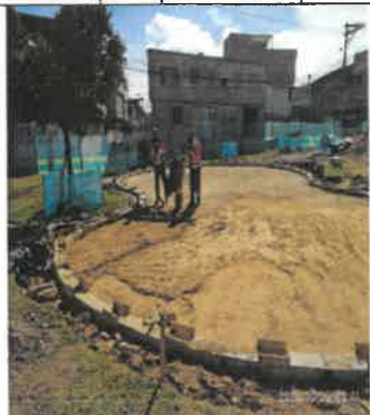
FOTO No 31. Una Vez verificado los niveles del relleno de la base granular, La interventoría ARQUITECTURA URBANA LTDA. Ubica las áreas que requieren ser subsanadas, previa a realizar las tomas de densidades, se deja evidencia en la Bitácora de obra.
