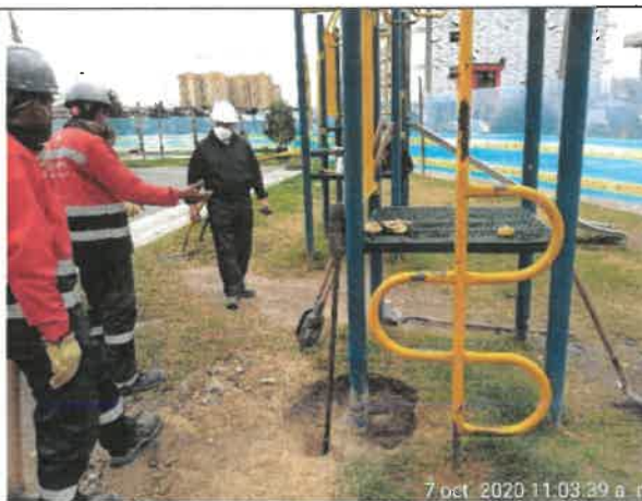
FOTO No. 148. Se revisó y verificó el desmonte del juego por Arq. Nelson Mauricio Barrera Benavides de la interventoría parque CANDELARIA LA NUEVA II SECTOR 1ª ETAPA (19-479)
