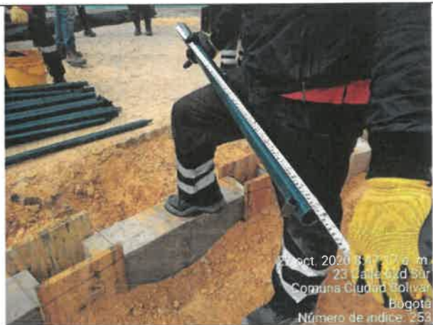
FOTO No. 171. Se revisó y verifico las condiciones técnicas por los profesionales de ARQUITECTURA URBANA LTDA., parque URBANIZACIÓN LA ESTANCIA. 19-150
