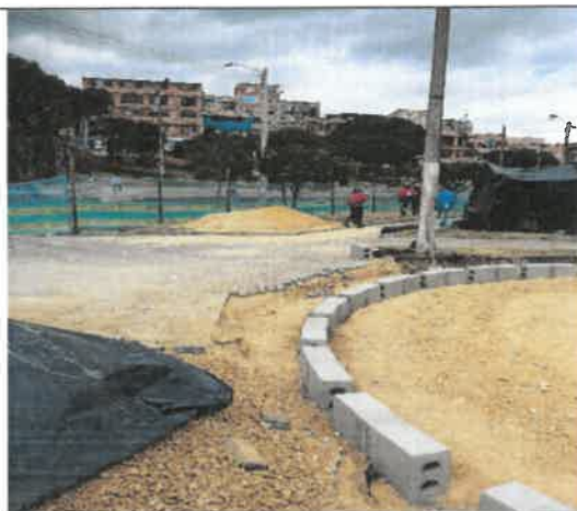
FOTO No. 158 Instalación de SUBBASE B-400.
