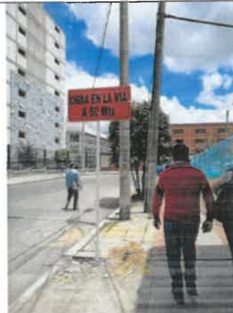
FOTO No. 4. Se revisó y verificó la instalación de señalización, parque CANDELARIA LA NUEVA II SECTOR 1ª ETAPA (19-479)
