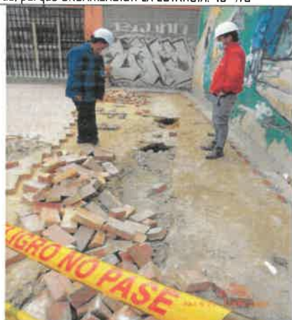
FOTO No. 164. Se revisó y verifico el área de excavación, parque URBANIZACIÓN LA ESTANCIA. 19-479
