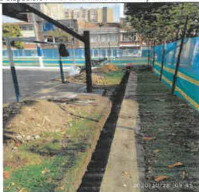
FOTO No 79 La interventoría ARQUITECTURA URBANA LTDA. Indica la ubicación de la excavación atendiendo a las dimensiones de las especificaciones técnicas del I.D.R.D. y el distanciamiento hacia la cancha deportiva atiende a las recomendaciones. La excavación corresponde a 32 M3. La interventoría socializa en comité de obra 17 del día 29 de octubre el tratamiento para la poda del árbol de caucho existente.
