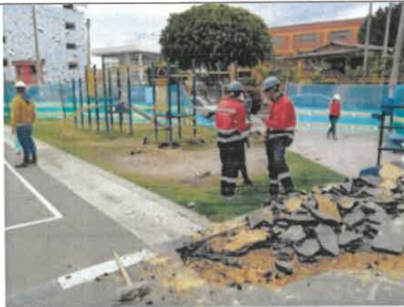
FOTO No 63. La interventoría ARQUITECTURA URBANA LTDA. Revisa y verifica que el contratista CONSORCIO OPORTO realice la actividad de DEMOLICIÓN DE LA CARPETA ASFÁLTICA. El grosor de la carpeta asfáltica fue del área donde se ubicarán los biosaludables fue de 10 cm. Sin embargo se evidencia que el contratista esta actividad no utilizó compresor con dos martillos 185. Esta actividad deberá ser ajustada en los A.P.U.s, y será tenida en cuenta en la elaboración de la memorias que soporten el pago del ACTA No 1
