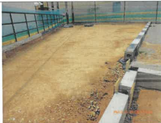
FOTO No 71 La interventoría ARQUITECTURA URBANA LTDA. Revisa y solicita que para realizar la toma de densidades debe estar libre de material suelto.
