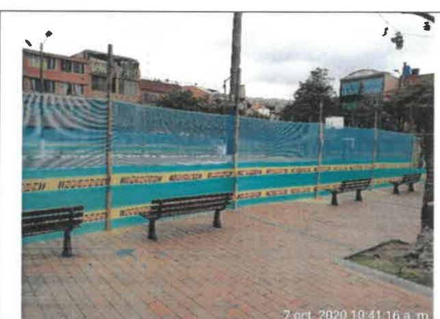
FOTO No. 138. Se revisó y verifico el cumplimiento de la instalación del cerramiento, parque. URBANIZACIÓN LA ESTANCIA. 19-149.
