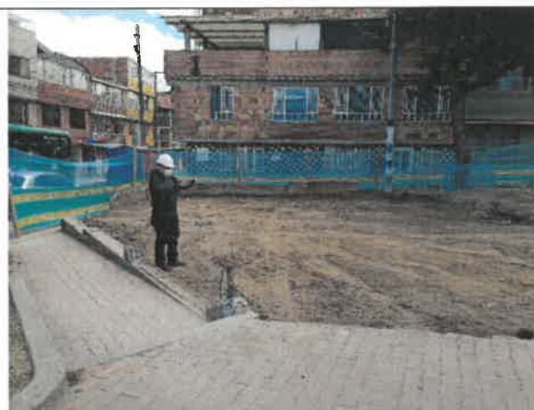
FOTO No. 154. No se evidencia personal en obra
