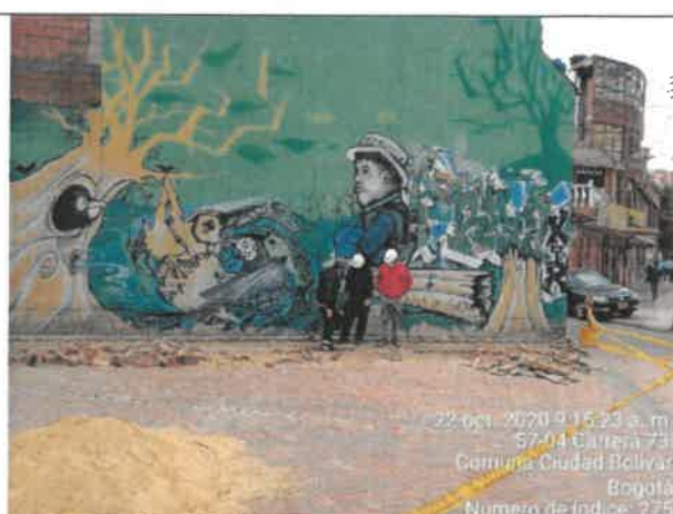
FOTO No. 163. Se revisó y verifico el área de excavación, parque URBANIZACIÓN LA ESTANCIA. 19-479
