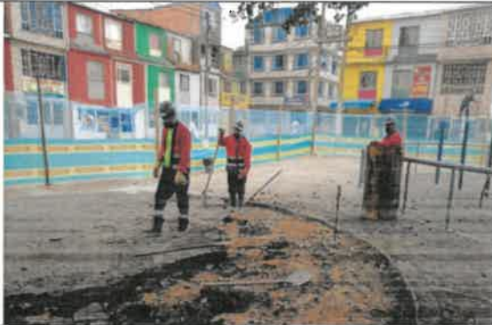
FOTO No. 202. Se revisó y verifico el cumplimiento del protocolo de bioseguridad covid-19 y la demolición de la placa de juegos, parque. URBANIZACIÓN LA ESTANCIA. 19-150
