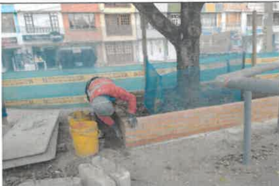
FOTO No 57. La interventoría ARQUITECTURA URBANA LTDA. Revisa y verifica que la actividad de muro en ladrillo en tabicón que conforman las jardineras cumpla con las especificaciones técnicas del I.D.R.D. El contratista debe entregar certificados de calidad de los materiales. Sin estas especificaciones de calidad la actividad no se avalará por parte de la interventoría.
