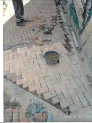
FOTO No 86. La interventoría ARQUITECTURA URBANA LTDA. Solicita mediante bitácora de obra reutilizar los adoquines desmontados, los cuales no presentan deterioro.
