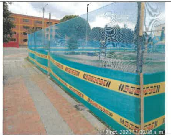
FOTO No. 142. Se revisó y verifico el cumplimiento de la instalación del cerramiento parque. CANDELARIA LA NUEVA II SECTOR 1ª ETAPA (19-479).
