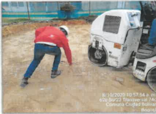
FOTO No 23. La interventoría ARQUITECTURA URBANA LTDA. Revisa y verifica que el contratista CONSORCIO OPORTO mantenga el área de compactación de la sub-rasante libre de material orgánico. Los niveles son los determinados por recomendación del especialista en geotecnia de la interventoría, subbase 20 con: base 15 cm y 10 cm placa contrapiso.
