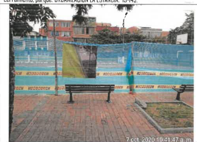
FOTO No. 140. Se revisó y verifico el cumplimiento de la instalación del pendón, parque. URBANIZACIÓN LA ESTANCIA. 19-149.
