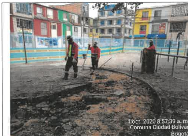
FOTO No. 117. Verificación las medidas de seguridad implementadas por el contratista CONSORCIO OPORTO en la demolición y retiro del asfalto parque URBANIZACIÓN LA ESTANCIA. 19-150
