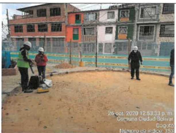
FOTO No. 181. Se revisa y verifica la ubicación del densímetro nuclear por parte de la interventoría ARQUITECTURA URBANA LTDA., parque URBANIZACIÓN LA ESTANCIA. 19-150
