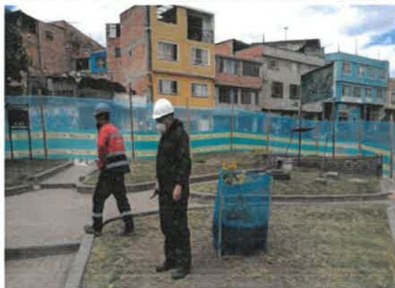
FOTO No. 209 Se revisó y verifico el cumplimiento de la protección de los individuos arbóreos, parque. PARQUE URBANIZACIÓN LA ESTANCIA. 19-038
