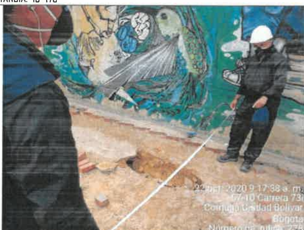
FOTO No. 165. Se revisó y verifico el área de excavación, parque URBANIZACIÓN LA ESTANCIA. 19-479
