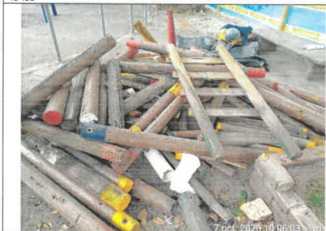
FOTO No. 135. Se revisó y verificó el cumplimiento del PMT, parque. URBANIZACIÓN LA ESTANCIA. 19-150
