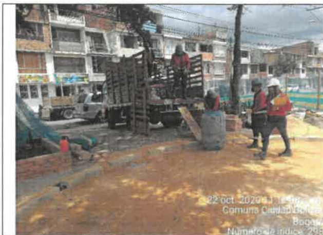
FOTO No. 168. Se revisó y verifico el cumplimiento del cerramiento, parque URBANIZACIÓN LA ESTANCIA 19-150
