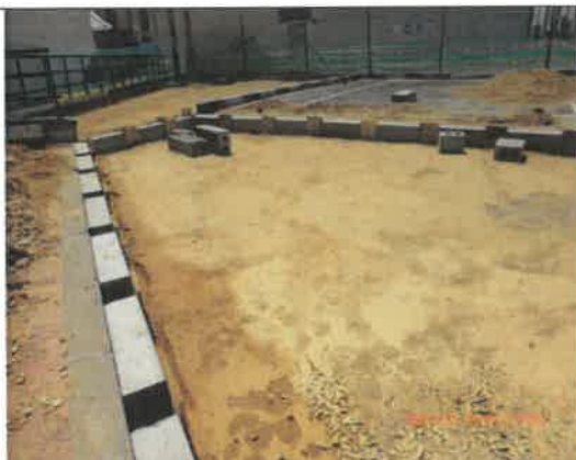
FOTO No 69 La interventoría ARQUITECTURA URBANA LTDA. Revisa y verifica que el contratista CONSORCIO OPORTO realice la actividad de compactación de la SUB BASE B 400 de acuerdo al espesor de 25 cm avalado por la interventoría de la estructura del piso.
