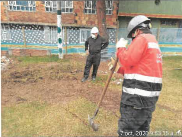
FOTO No. 129. Se revisó y verifico el cumplimiento de la instalación del cerramiento perimetral, parque. PARQUE URBANIZACIÓN LA ESTANCIA. 19-038
