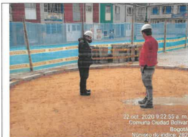
FOTO No. 166 Se revisó y verifico la instalación de la sub base, parque URBANIZACIÓN LA ESTANCIA 19-150
