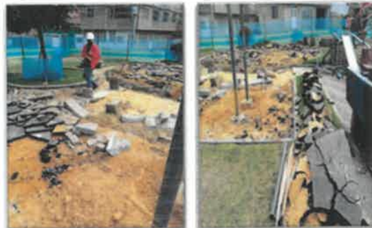
FOTO No 26. La interventoría ARQUITECTURA URBANA LTDA. Evidencia que la actividad de demolición no la ejecutó como lo especifica del A.P.U con compresor y dos martillos. Por lo anterior la interventoría solicita al contratista realizar los ajustes correspondientes, para poder ser avalada esta actividad por la interventoría.
