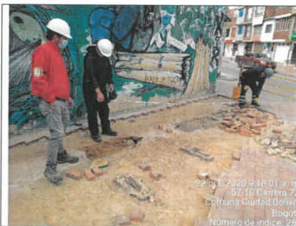
FOTO No. 162. Se revisó y verifico nivelación y ubicación de la tubería de agua negras, parque URBANIZACIÓN LA ESTANCIA. 19-479
