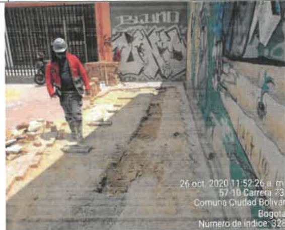
FOTO No. 90. Compactación de base y reinstalación de adoquín PARQUE URBANIZACIÓN LA ESTANCIA 19-483
