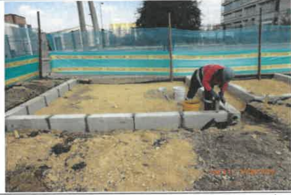
FOTO No 74 La interventoría ARQUITECTURA URBANA LTDA. Revisa y verifica que el contratista CONSORCIO OPORTO con el soporte técnico de las certificaciones de los prefabricados, inicia con la actividad de instalación de los bordillos PREFABRICADOS A-80. El contratista entrega pruebas de laboratorio de los prefabricados de los bordillos, por solicitud de la interventoría, los resultados de flexión y de rotura de los bordillos Cumplen con las especificaciones técnicas, - NTC 4109. Y entrega la certificación de calibración de la prensa
