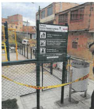
FOTO No. 160. Se revisa y verifica la instalación de la señal de peligro, parque LAS HUERTAS 19-287
