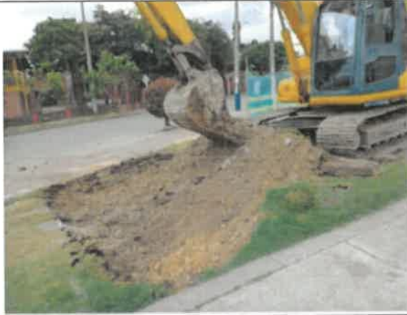
FOTO No 65. La interventoría ARQUITECTURA URBANA LTDA. revisa y verifica que el contratista CONSORCIO DPORTO realice la actividad de excavación correspondiente al espesor de la estructura del piso del área de juego infantil de 45 cm avalada por el especialista de geotecnia de la interventoría
