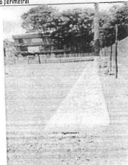
FOTO No 34: El contratista CONSORCIO OPORTO realiza actividad de cerramiento perimetral
