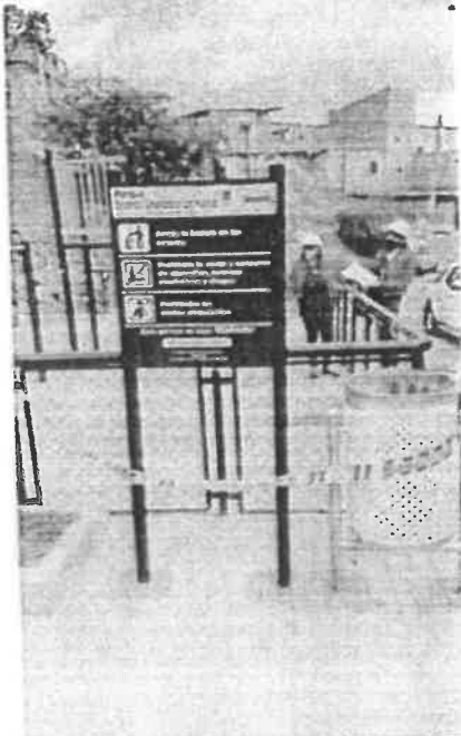
FOTO No 19: El contratista CONSORCIO OPORTO realiza actividad de instalación de valla de información.
