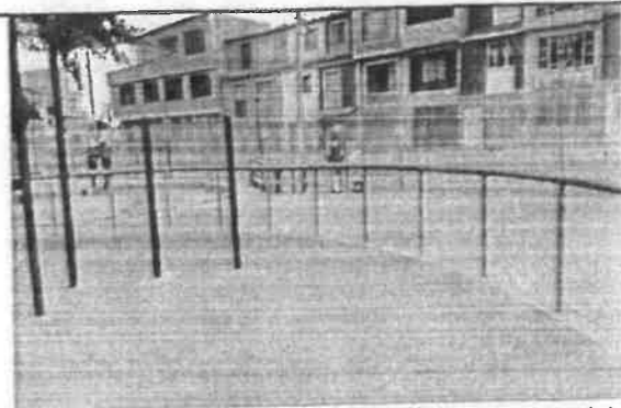
FOTO No 44: El contratista CONSORCIO OPORTO realiza actividad de cerramiento perimetral
