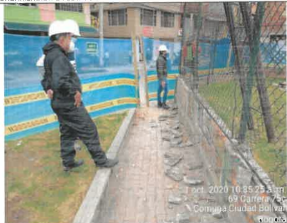
FOTO No. 120 Se realiza Verificación de las medidas de Seguridad Tomadas por el contratista CONSORCIO OPORTO en la desinstalación del cerramiento PARQUE URBANIZACIÓN LA ESTANCIA. 19-039
