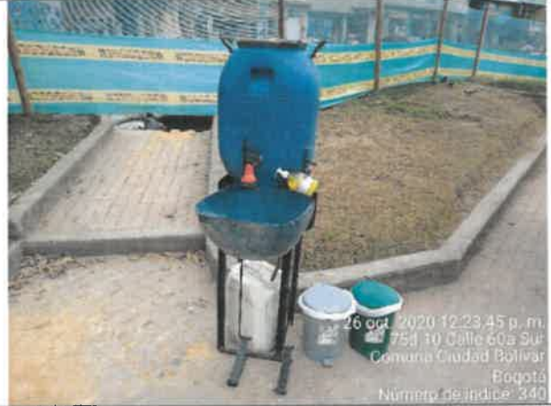
FOTO No. 177. Se revisa y verifica la instalación del lavamanos, parque LAS HUERTAS 19-038
