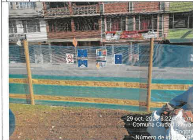
FOTO No. 192. Se revisó y verifico la ubicación de señalización del protocolo y el plan de emergencia, parque URBANIZACIÓN LA ESTANCIA. 19-038
