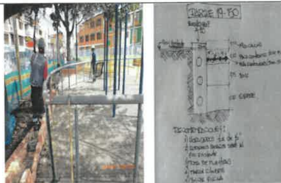
FOTO No 60 La interventoría ARQUITECTURA URBANA LTDA. Da lineamientos técnicos para que el contratista CONSORCIO OPORTO en cuanto a las dimensiones y manejo de las capas que componen la estructura del piso y del manejo de aguas de escorrentía. Se deja constancia en bitácora de obra el día 27 de octubre de 2020
