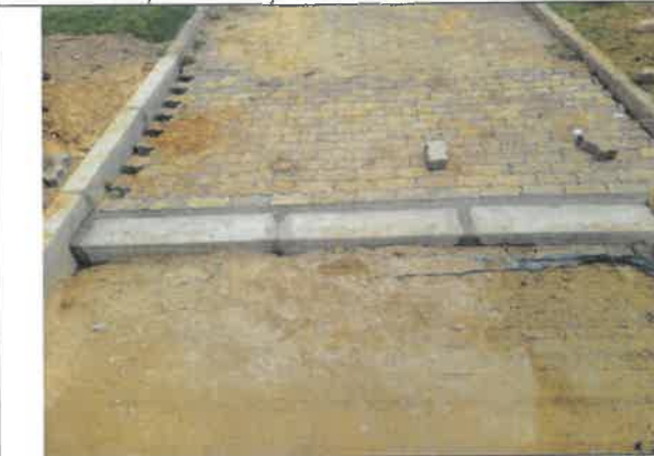
FOTO No 34. La interventoría ARQUITECTURA URBANA LTDA. Solicita al contratista confinar el área del adoquín existente para evitar el desprendimiento del mismo. Se deja evidencia en bitácora de obra actividad realizada el día 30 de octubre de 2020
