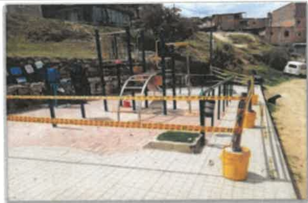
FOTO No 7. Se determina prolongar la tubería de la baranda existente M-80 con el propósito de controlar el acceso al parque, atendiendo a las recomendaciones de las especificaciones técnicas de la baranda del I.D.R.D.: elemento de delimitación y control del espacio público, el cual protege y guía al peatón . Se deja registro en bitácora de obra. El contratista CONSORCIO OPORTO inicia fabricación de complemento de baranda en taller.
