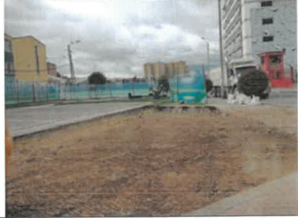
FOTO No 66. La interventoría ARQUITECTURA URBANA LTDA. Revisa y verifica que el contratista CONSORCIO DPORTO realice la actividad de excavación correspondiente al área de juegos infantiles de 45 cm que corresponde al espesor de la estructura, avalada por el especialista de geotecnia de la interventoría. La disposición final del material de excavación deberá ser soportada el destino final en las canteras autorizadas por el área ambiental de la interventoría.
