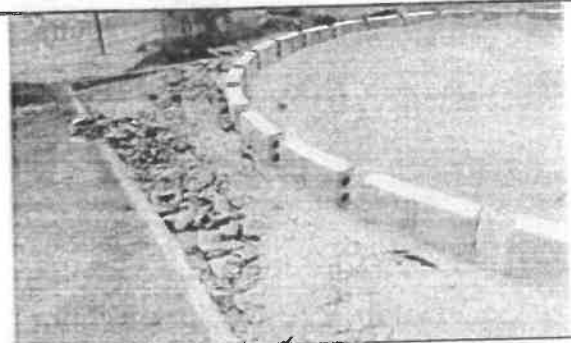
FOTO No 2: El contratista CONSORCIO OPORTO realiza actividad de instalación de bordillos de confinamiento.
