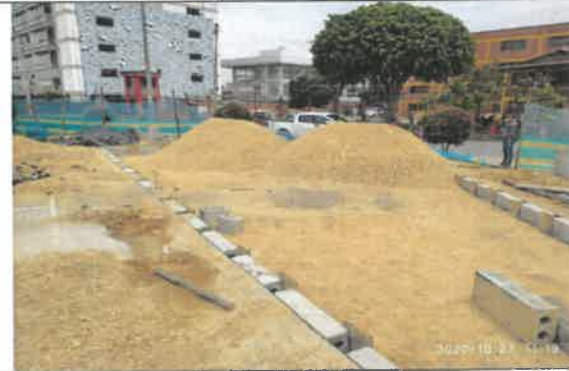
FOTO No 76. La interventoría ARQUITECTURA URBANA LTDA. Revisa y verifica que las certificaciones del agregado de la BASE B-600 cumplan con las especificaciones técnicas enunciadas en las del I.D.R.D. Entrega certificaciones de calidad de porcentajes finos, de angularidad, de desgaste, E.Q de la arena.
