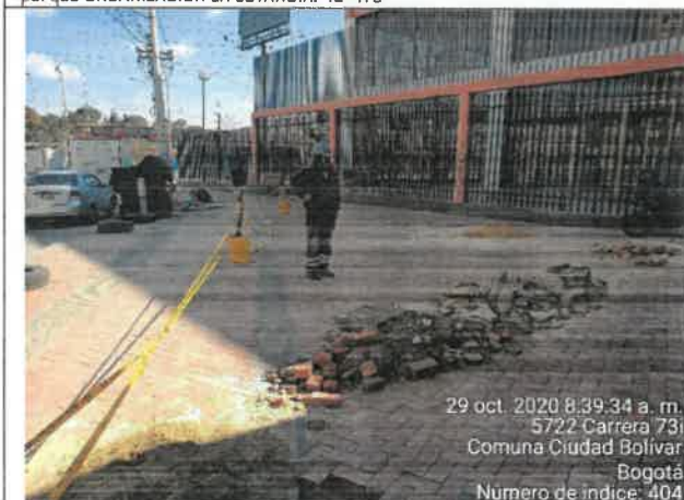
FOTO No. 200. Se revisó y verifico la señalización del parque, parque URBANIZACIÓN LA ESTANCIA. 19-479
