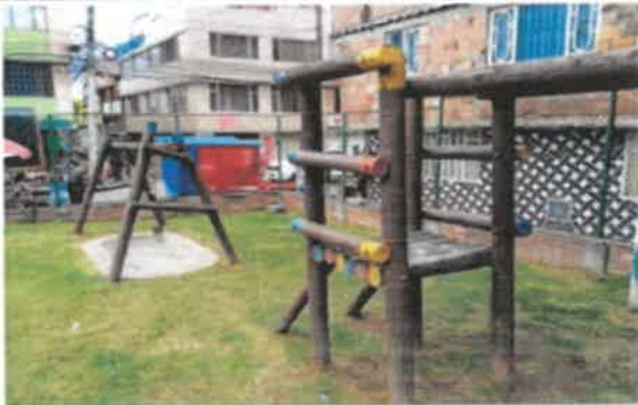
FOTO No 35. La interventoría ARQUITECTURA URBANA LTDA. Revisa y verifica que el contratista CONSORCIO OPORTO realice la actividad de desmonte del juego infantil en madera, el cual por su deterioro se da de baja mediante un acta de desmonte de mobiliario. La disposición final de los elementos desmontados que se evidencien que no se reutilizarán, deben ser enviados a las empresas que estén debidamente aprobadas por el área ambiental de la interventoría.
