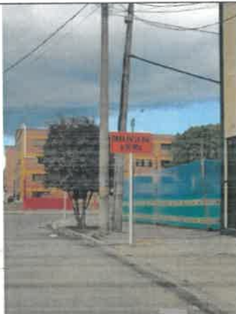
FOTO No. 96. Se revisó y verificó la instalación de señalización, parque CANDELARIA LA NUEVA II SECTOR 1ª ETAPA (19-479)
