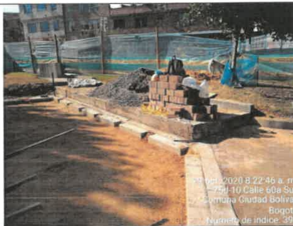
FOTO No. 112. Se revisó y verificó el acopio temporal de material prefabricado parque URBANIZACIÓN LA ESTANCIA (19-038)
