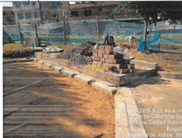
FOTO No. 193. Se revisó y verifico la utilización de los elementos de protección personal, parque URBANIZACIÓN LA ESTANCIA. 19-038
