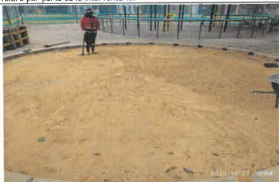
FOTO No 59 La interventoría ARQUITECTURA URBANA LTDA. Revisa y verifica que el contratista corrija los niveles encontrados, por lo tanto debe escarificar montículos encontrados. Se deja evidencia en bitácora de obra el día 27 de octubre de 2020 y debe compactar nuevamente.
