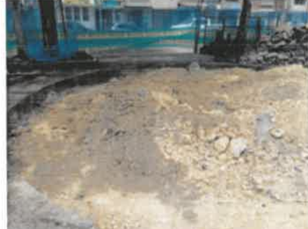
FOTO No 50. La interventoría ARQUITECTURA URBANA LTDA. Revisa y verifica que el contratista CONSORCIO OPORTO realice la actividad de excavación correspondiente al espesor de la estructura avalada por el especialista de geotecnia de la interventoría. 10cm, de placa, 15cm de base y 20 cm de SUBBASE B400. La excavación final fue de 40 cm. Se dejaron 5 cms sobre el nivel para manejo de aguas de escorrentía.
