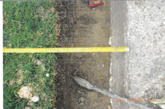
FOTO No 82 La interventoría ARQUITECTURA URBANA LTDA. Revisa y verifica que las dimensiones de la excavaciones del cimiento y de los pilotines correspondan a la de la especificaciones técnicas del I.D.R.D. 0,40x0,30.
