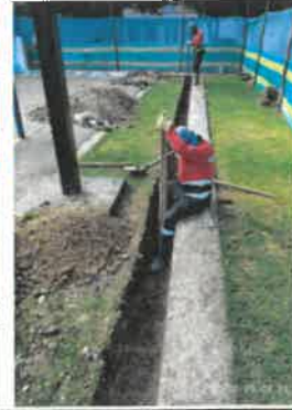
FOTO No 78. La interventoría ARQUITECTURA URBANA LTDA. Indica la ubicación de la excavación atendiendo a las dimensiones de las especificaciones técnicas del I.D.R.D. y conservará la cimentación existente para no incurrir en gastos innecesarios de demolición de la cimentación. Se deja evidencia en bitácora de obra en la primera quincena del mes de octubre de 2020
