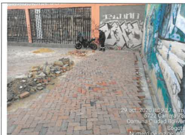
FOTO No. 198. Se revisó y verifico nivelación y ubicación de los adoquines, parque URBANIZACIÓN LA ESTANCIA. 19-479
