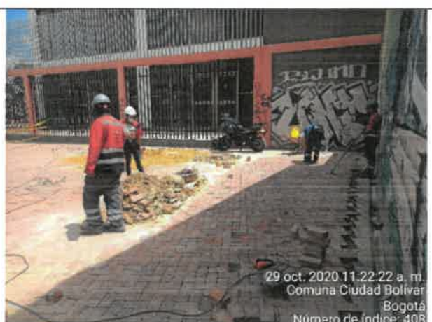
FOTO No. 199. Se revisó y verifico el aseo del área que se encuentra intervenida, parque URBANIZACIÓN LA ESTANCIA. 19-479
