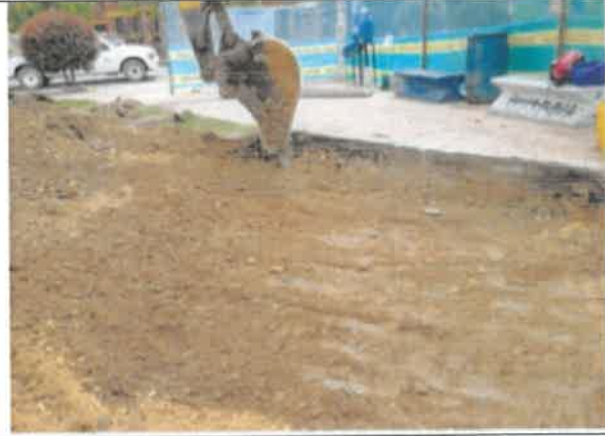
FOTO No 64. La interventoría ARQUITECTURA URBANA LTDA. Revisa y verifica que el contratista CONSORCIO OPORTO realice la actividad de excavación correspondiente y corresponde a la avalada por el especialista de geotecnia de la interventoría. 10cm de placa, 15 cm de base y 20 cm de sub-base. Las cantidades se soportarán en las memorias de cálculo, en cuanto a la excavación. La disposición final del material de excavación deberá ser soportada el destino final en las canteras autorizadas por el área ambiental de la interventoría.
