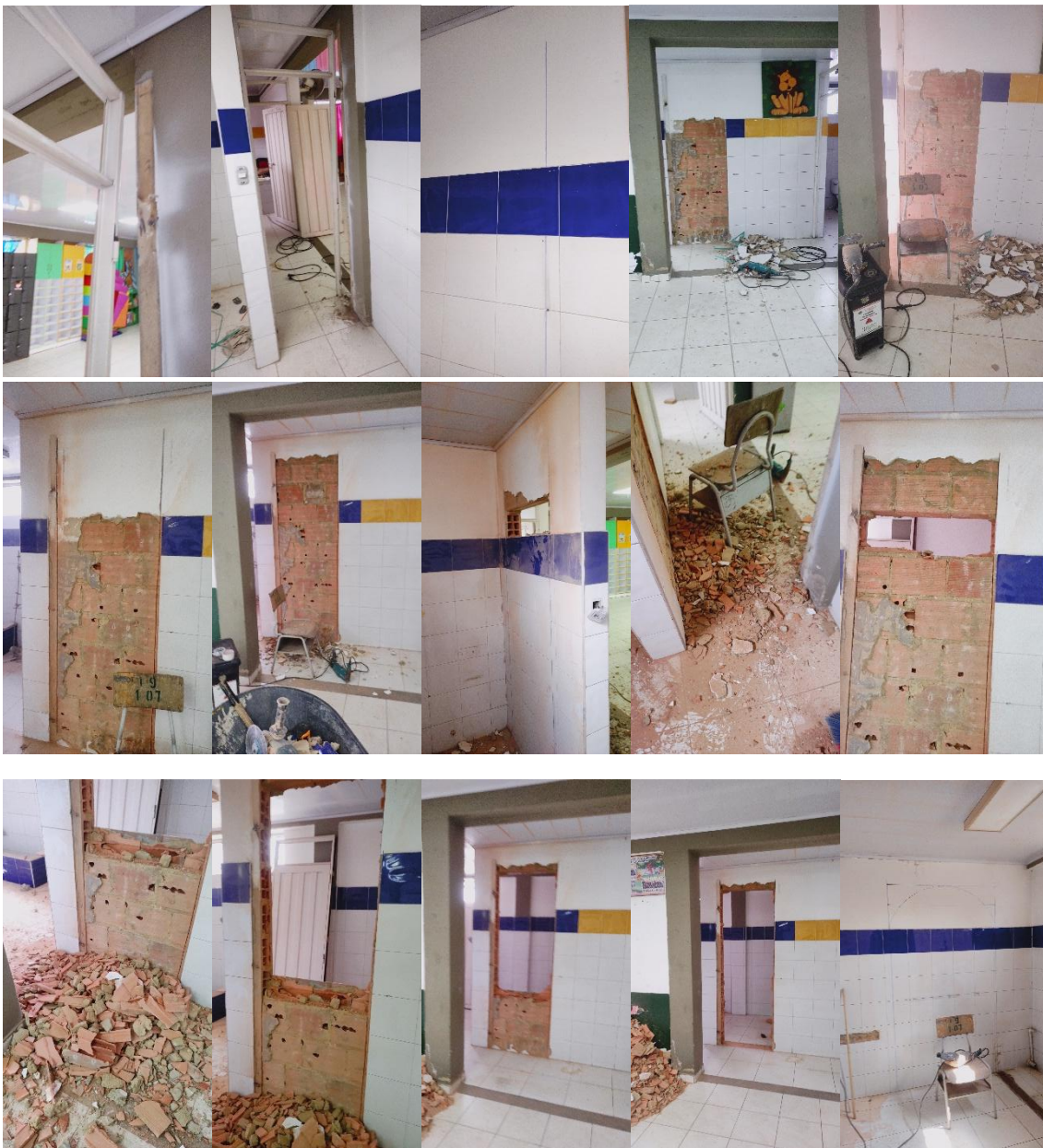
DESMONTE DE PUERTA BAÑO CORTE CON PULIDORA Y DEMOLICION PARA REUBICACION DE PUERTA Y CORTE DE MURO, DEMOLICION MURO PARA BODEGA DE ALMACENAMIENTO Y MANEJO DE ESCOMBRO
