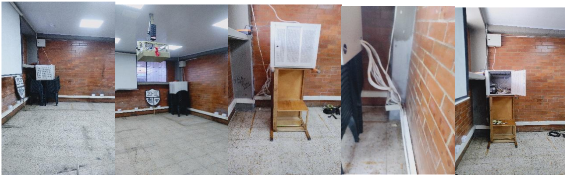
INSTALACION DE RAC MODIFICACION DEL MISMO PARA ANCLAJE EN MURO Y ORGANIZACIÓN DE CABLEADO Y CANALETA PARA EL MISMO
