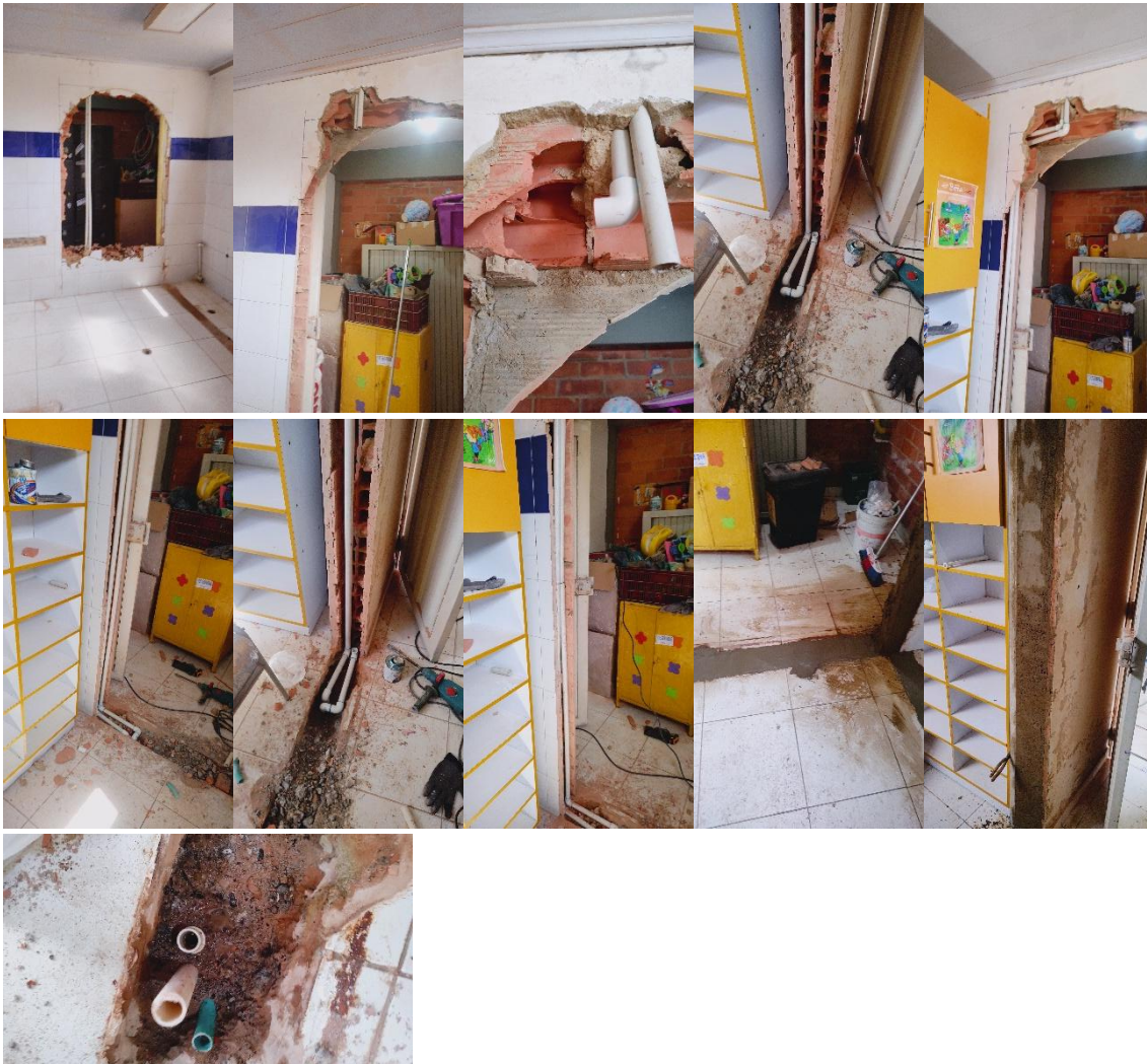
CAMBIO Y REDIRECCIONAMIENTO DE TUBERÍA HIDRÁULICA EN MURO DE DEMOLICIÓN
