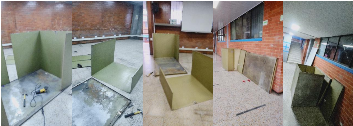
INSTALACION DE RAC MODIFICACION DEL MISMO PARA ANCLAJE EN MURO Y ORGANIZACIÓN DE CABLEADO Y CANALETA PARA EL MISMO
