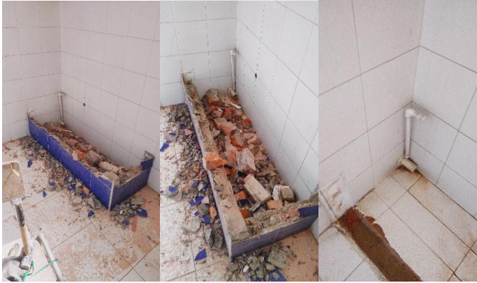
DESMONTE DE PUERTA BAÑO CORTE CON PULIDORA Y DEMOLICION PARA REUBICACION DE PUERTA Y CORTE DE MURO, DEMOLICION MURO PARA BODEGA DE ALMACENAMIENTO Y MANEJO DE ESCOMBRO
