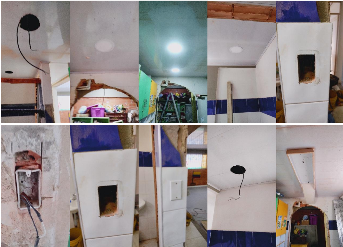
ALISTAMIENTO DE MATERIAL PARA PROCESO DE RESANE DE MUROS Y PISOS
