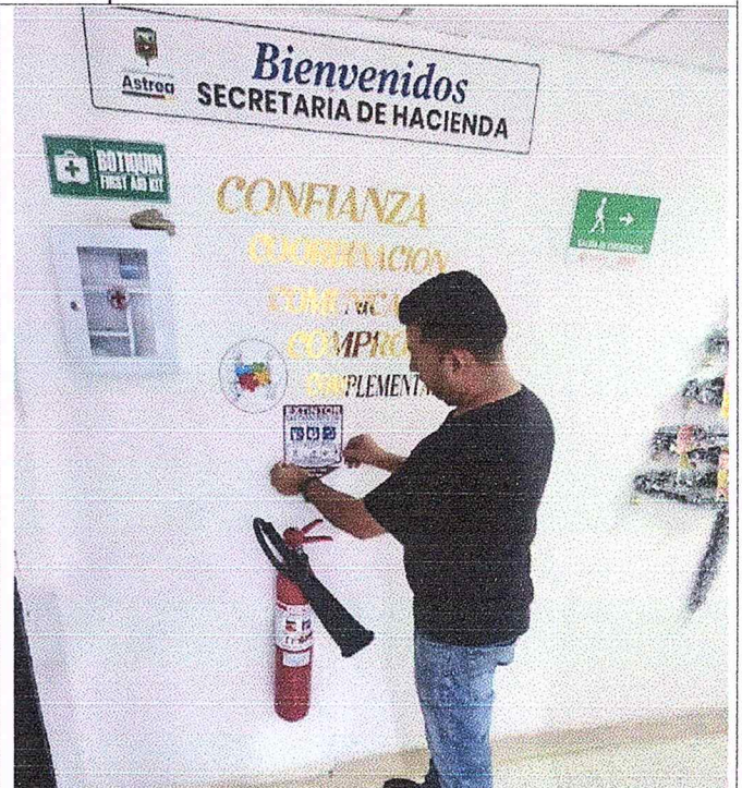
Instalación de extintor de 20 libras de CO2 en las instalaciones y sedes administrativas del municipio de Astrea Cesar.
