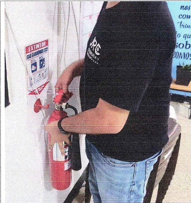
Instalación de extintor de 10 libras de CO2 en las instalaciones y sedes administrativas del municipio de Astrea Cesar.
