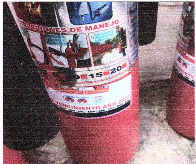
Fecha de caducidad de la recarga del extintor
