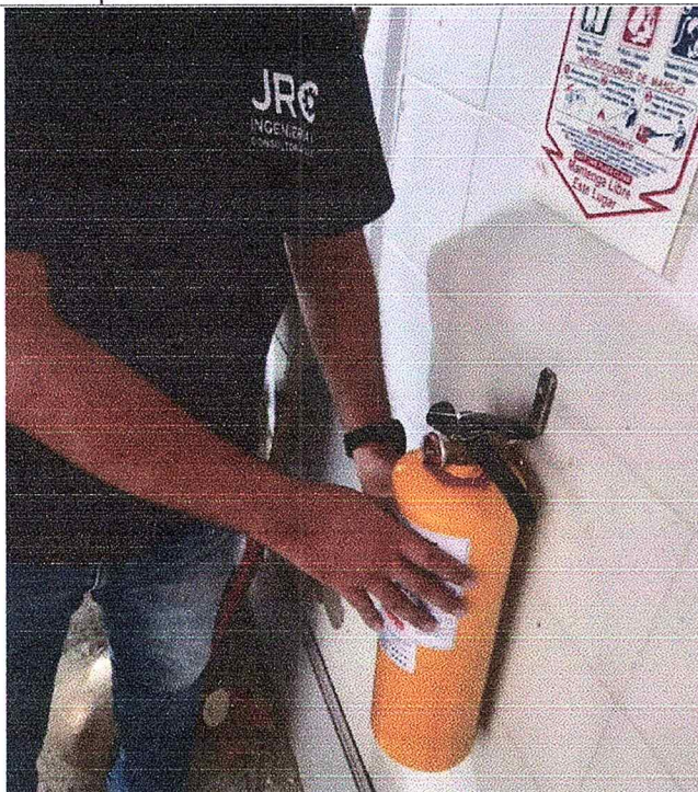
Instalación de extintor de 10 libras multipropósito en las instalaciones y sedes administrativas del municipio de Astrea Cesar.
