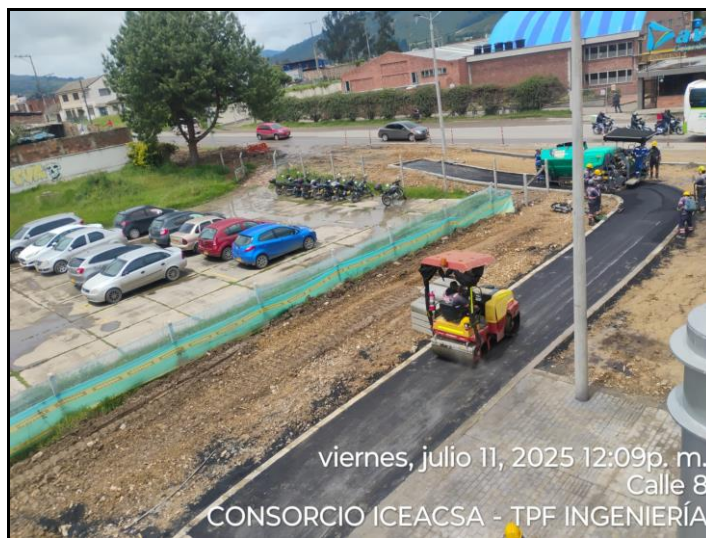
Imagen 1. Compactación únicamente con rodillo
