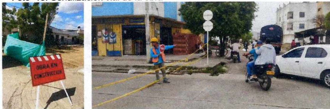
Foto 13. Señalización vial de la obra
