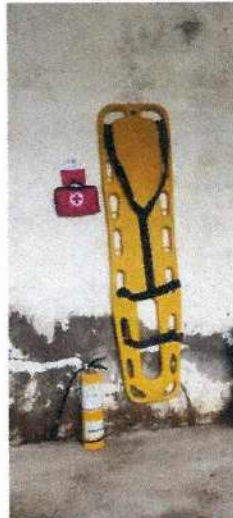
Foto 10. Botiquín, camilla y extintor de obra
