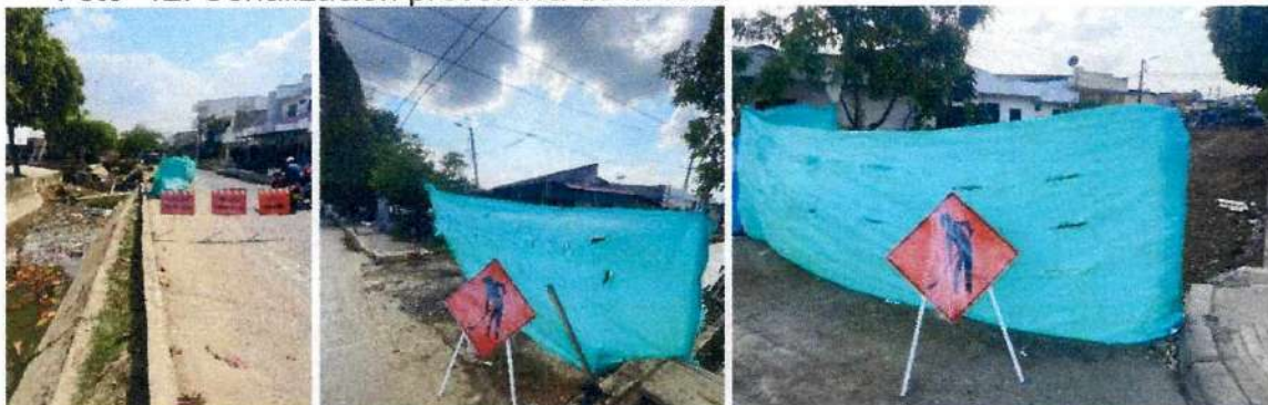
Foto 12. Señalización preventiva de la obra
