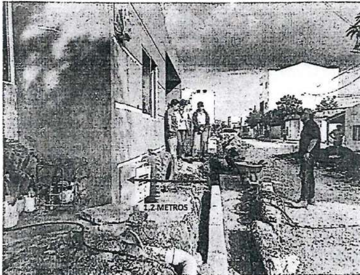
Vista exterior - Se evidencia en la línea demarcada el área destinada para el andén.
