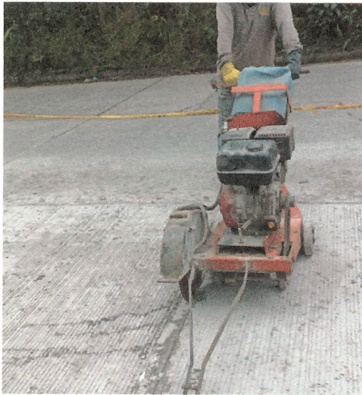
IMAGEN 15. Corte de pavimento.
