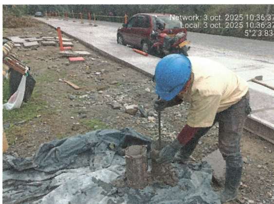
IMAGEN 11. Toma de muestras de concreto.
