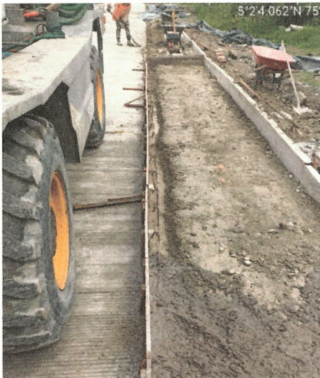
IMAGEN 7. Vaciado de andén.
