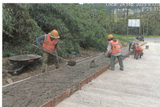
IMAGEN 14. Vaciado de anden.
