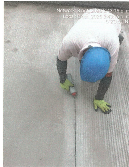
IMAGEN 16. Corte de pavimento.
