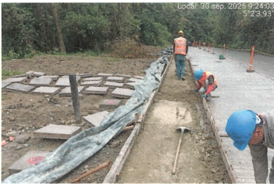
IMAGEN 9. instalación de afirmado.
