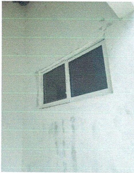
EVIDENCIA No 08: continuacion de pañete y primera mano de pintura vinilo puesto de salud de la Union.
