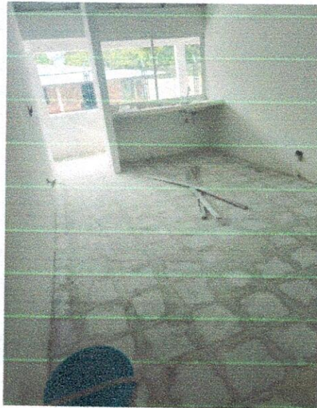
EVIDENCIA No 08: continuacion de pañete y primera mano de pintura vinilo puesto de salud de la Union.
