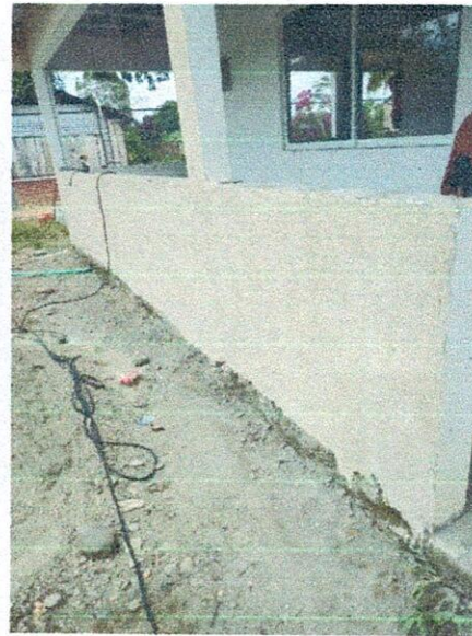
EVIDENCIA No 08: continuacion de pañete y primera mano de pintura vinilo puesto de salud de la Union.
