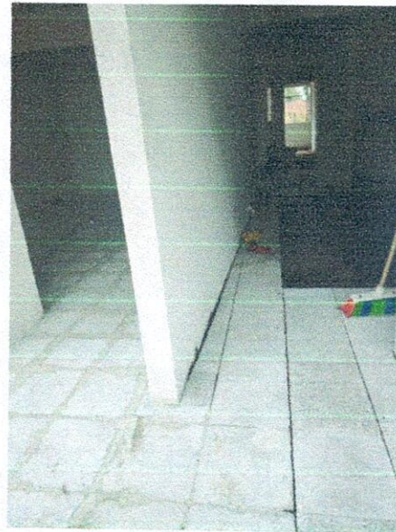
EVIDENCIA No 08: continuacion de pañete y primera mano de pintura vinilo puesto de salud de la Union.
