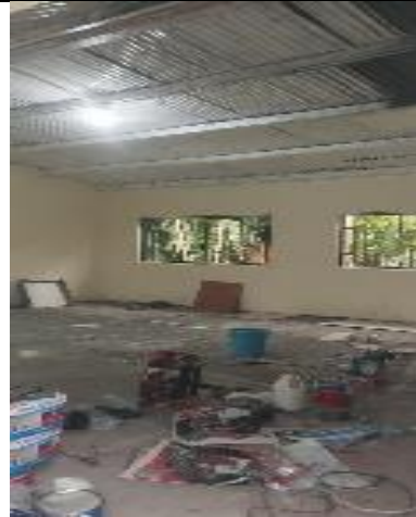
Foto No. 20 ejecución de actividades.
