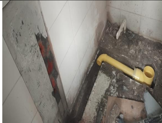
Foto No. 32 ejecución de actividades.
