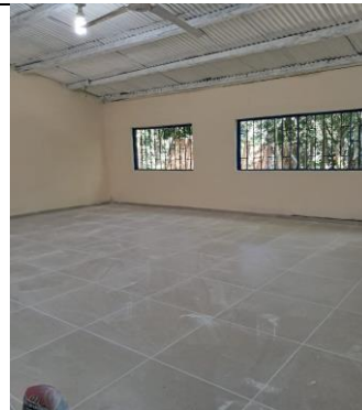
Foto No. 24 ejecución de actividades.
