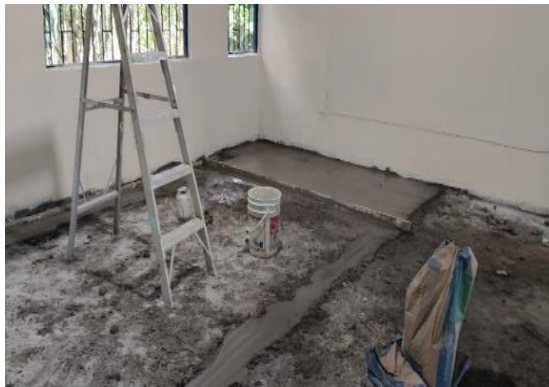
Foto No. 9 ejecución de actividades.
