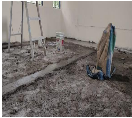
Foto No. 8 ejecución de actividades.
