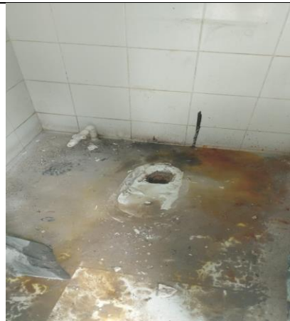
Foto No. 30 ejecución de actividades.
