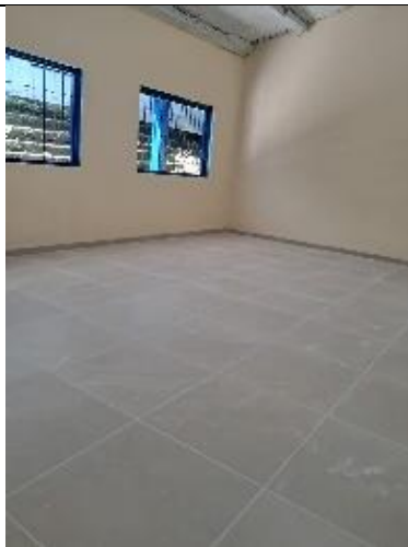
Foto No. 21 ejecución de actividades.
