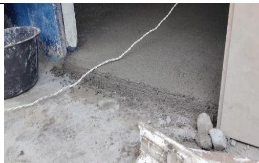
Foto No. 12 ejecución de actividades.
