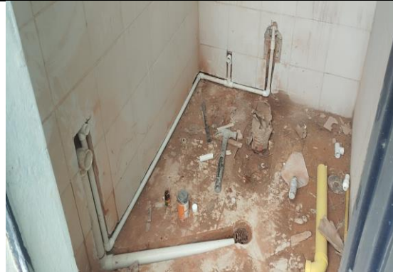
Foto No. 38 ejecución de actividades.
