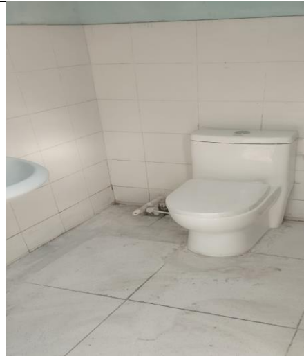
Foto No. 34 ejecución de actividades.
