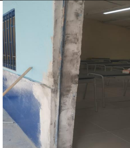
Foto No. 44 ejecución de actividades.
