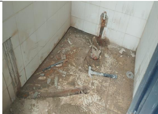
Foto No. 36 ejecución de actividades.
