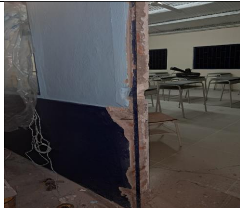
Foto No. 40 ejecución de actividades.
