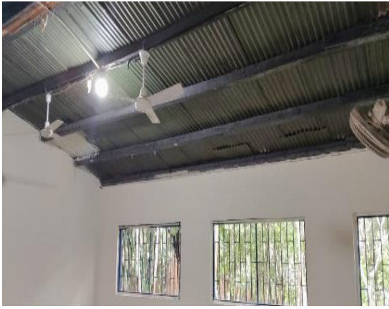
Foto No. 13 ejecución de actividades.
