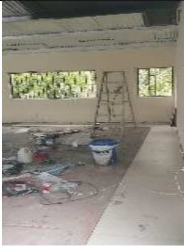
Foto No. 19 ejecución de actividades.
