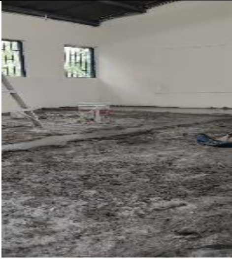
Foto No. 7 ejecución de actividades.
