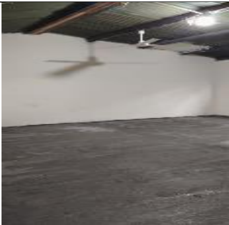
Foto No. 17 ejecución de actividades.
