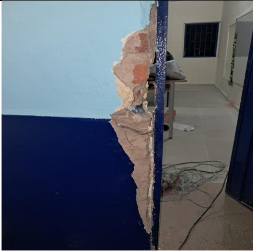
Foto No. 43 ejecución de actividades.
