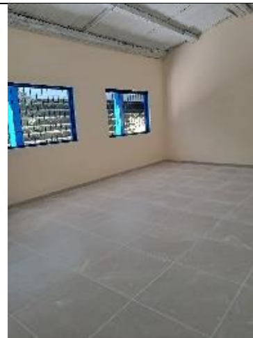
Foto No. 22 ejecución de actividades.
