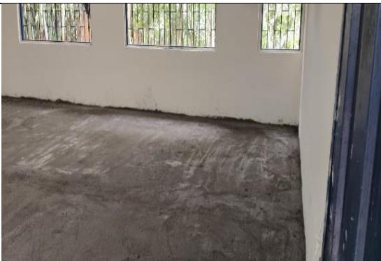
Foto No. 15 ejecución de actividades.
