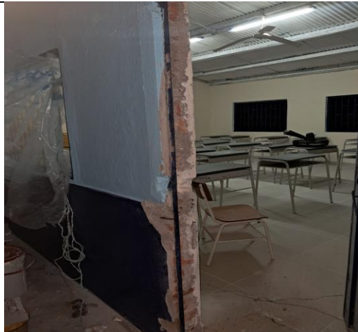
Foto No. 41 ejecución de actividades.
