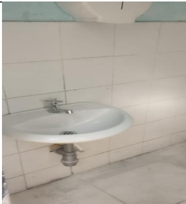
Foto No. 35 ejecución de actividades.
