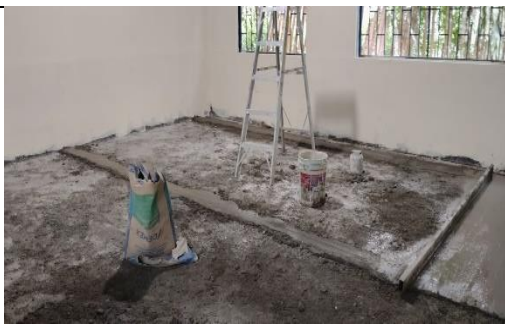
Foto No. 11 ejecución de actividades.
