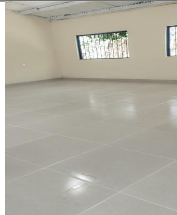
Foto No. 28 ejecución de actividades.
