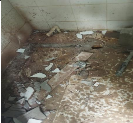
Foto No. 31 ejecución de actividades.
