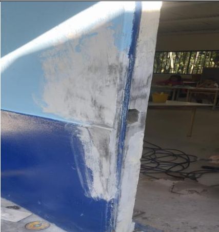
Foto No. 45 ejecución de actividades.
