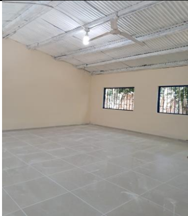
Foto No. 25 ejecución de actividades.
