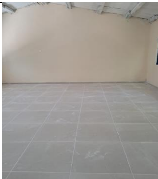
Foto No. 23 ejecución de actividades.
