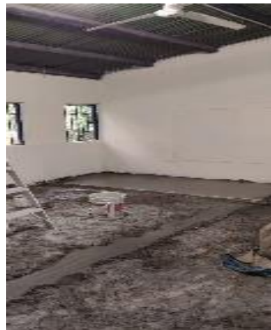
Foto No. 10 ejecución de actividades.
