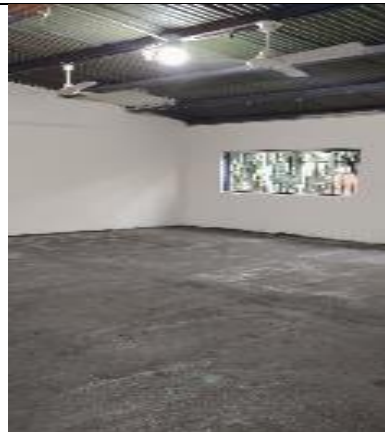
Foto No. 18 ejecución de actividades.
