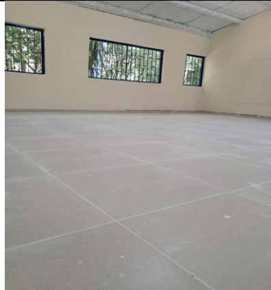
Foto No. 26 ejecución de actividades.
