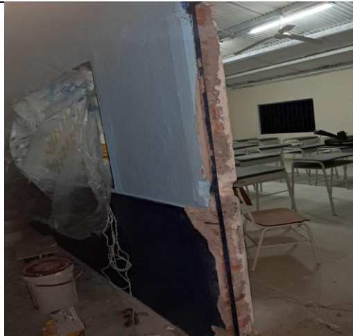
Foto No. 42 ejecución de actividades.
