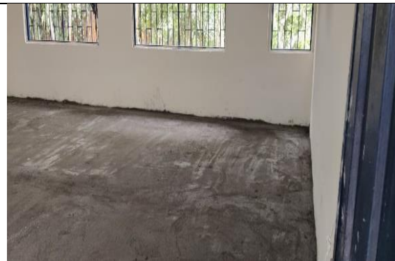
Foto No. 16 ejecución de actividades.
