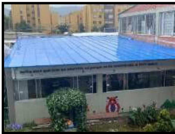
VISTA FRONTAL DE CUBIERTA
