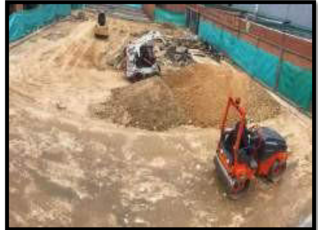
COMPACTACIÓN DE SUELO ZONA 1 Y 2
