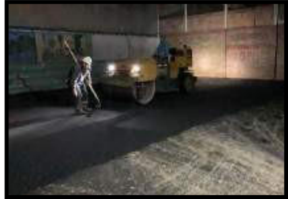
APLICACIÓN DE ASFALTO Y COMPACTACIÓN DE SUELO
