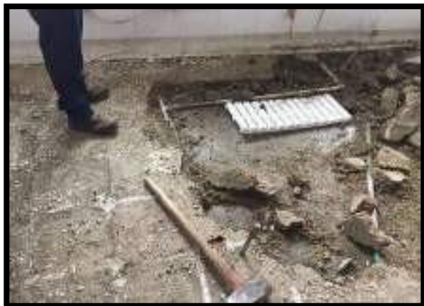
DEMOLICIÓN DE AFINADO DE PISO
