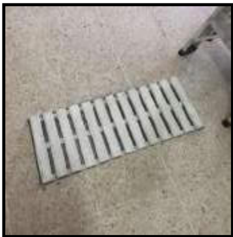
INSTALACION DE REJILLAS EXISTENTES
