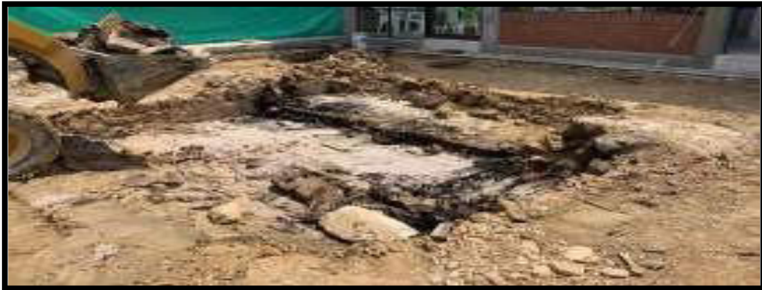
EXCAVACIÓN DE FALLO
