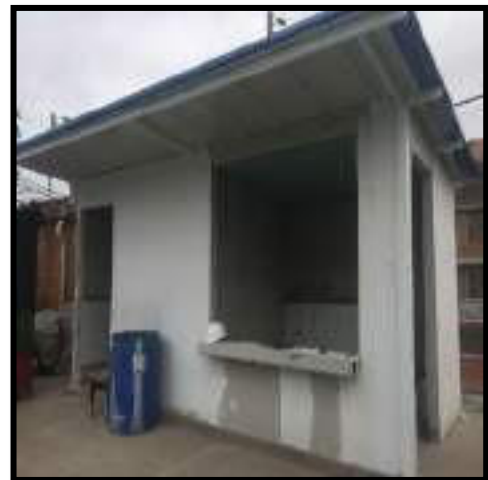
PINTURA DE MUROS EN SUPERBOARD
