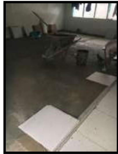
INSTALACIÓN DE ENCHAPE PISO
