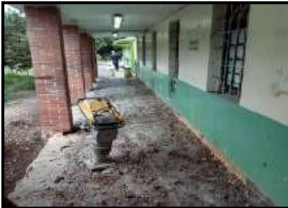
RELLENO DE MATERIAL RECEBO
