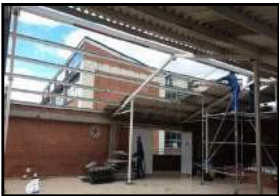
DESMONTE DE CUBIERTA
