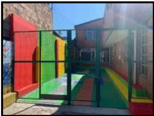
ZONA NIÑOS-INSTALACIÓN DE PISO PVC
