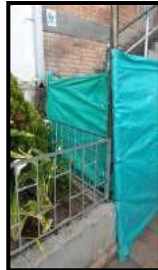
REFUERZO DE CERRAMIENTO CON PARALES METALICOS
