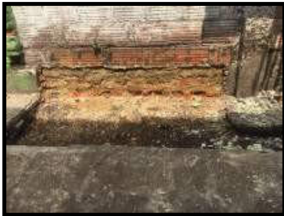
LIMPIEZA DE ZANJA PARA PLACA NUEVA
