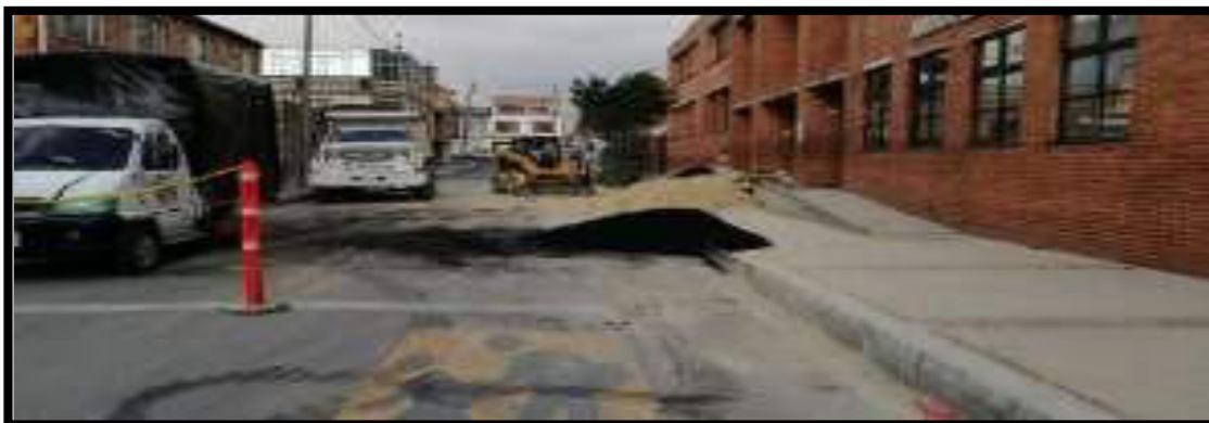
INGRESO DE MATERIAL ASFALTO
