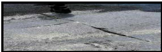
DEMOLICIÓN MANUAL DE PAVIMENTO ASFALTICO
