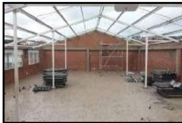
DESMONTE DE CUBIERTA
