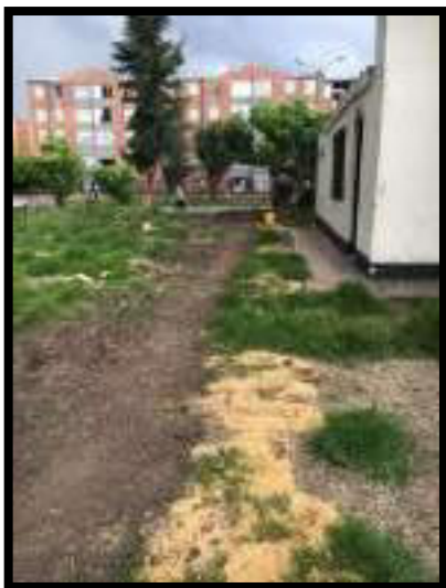
RELLENO DE ZANJA DE ACOMETIDA
