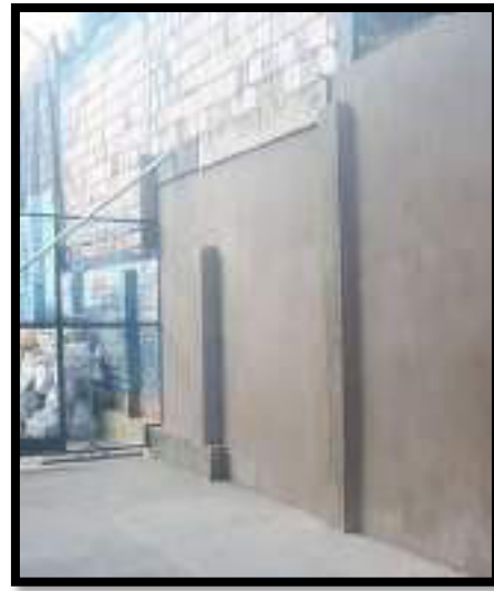
CONSTRUCCIÓN DE VIGA DE AMARRE
