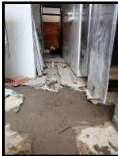
FUNDICION DE PLACA DE CONTRAPISO
