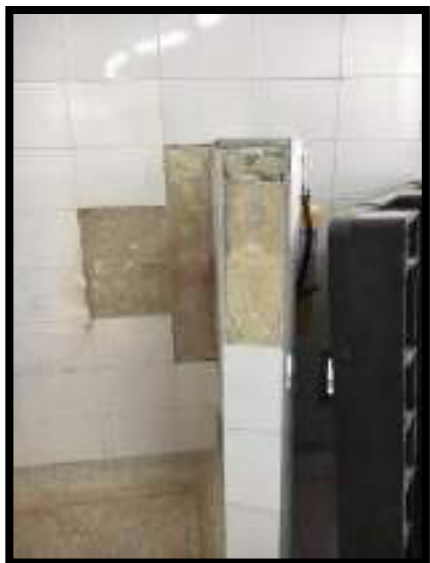
DEMOLICIÓN DE ENCHAPES FISURADOS EN MURO
