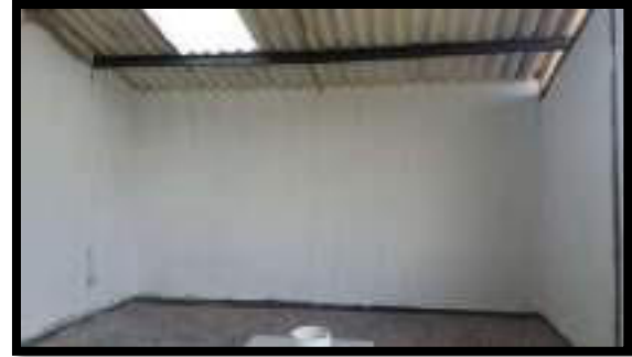
SEGUNDA CAPA DE PINTURA EN MURO
