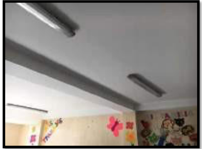
INSTALACIÓN DE LAMPARAS PARA SALONES
