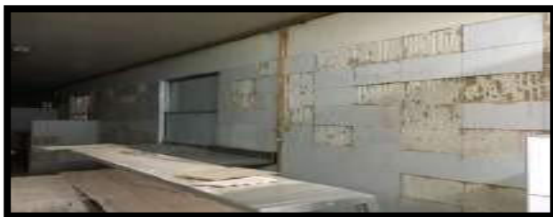
DESMONTE DE ENCHAPES FISURADOS DE MURO
