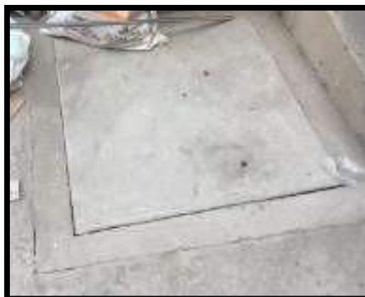
FUNDICIÓN DE TAPA PARA CAJA DE INSPECCIÓN
