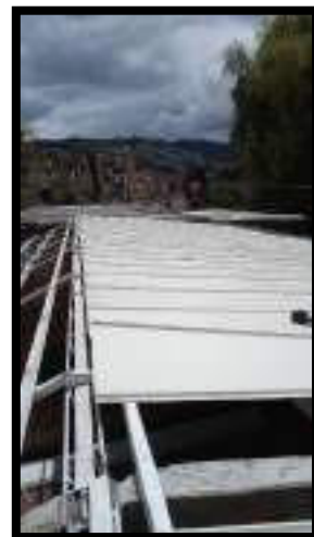
MONTAJE DE PANELES DE CUBIERTA TIPO SANDWICH
