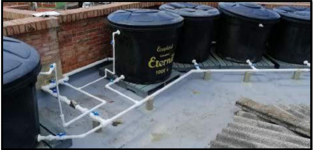
INSTALACIÓN REDES TANQUES
