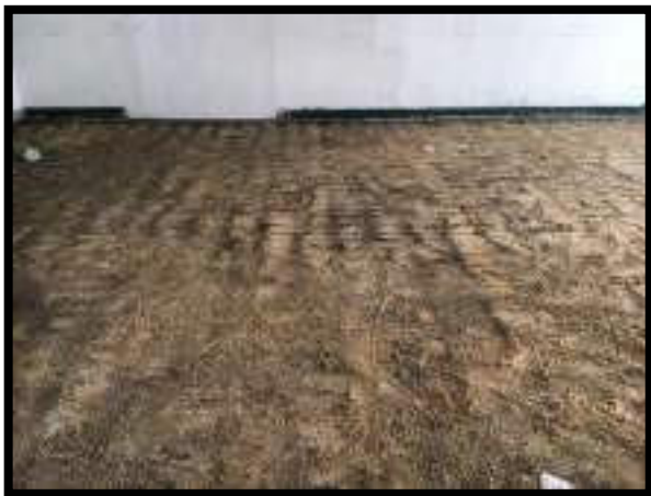
DESMONTE DE ADOQUIN EN SALONES
