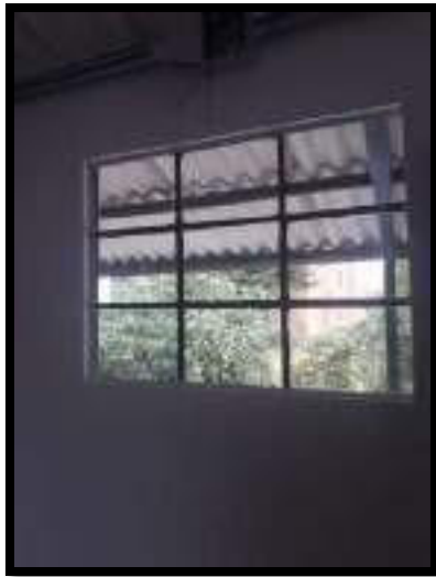
CAMBIO DE VIDRIOS DAÑADOS
