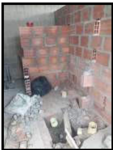
INICIO DE INSTALACION DE MAMPOSTERIA PARA MUROS
