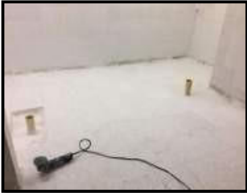
INSTALACION DE BALDOSA Y CARCAMO
