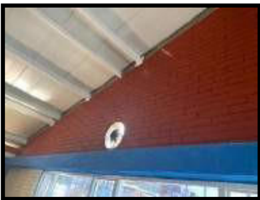
LIMPIEZA DE MUROS
