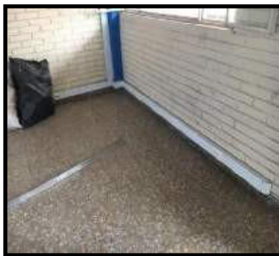
INSTALACIÓN DE CANALETA METALICA
