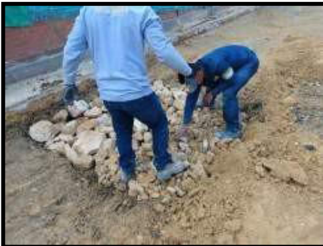
RELLENO DE MATERIAL PIEDRA RAJÓN (REPARACIÓN)
