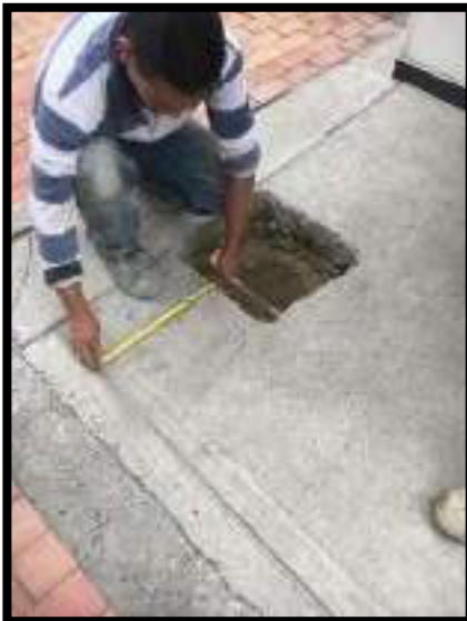
EXCAVACIÓN PARA PEDESTALES (ZONA DE CANCHA)
