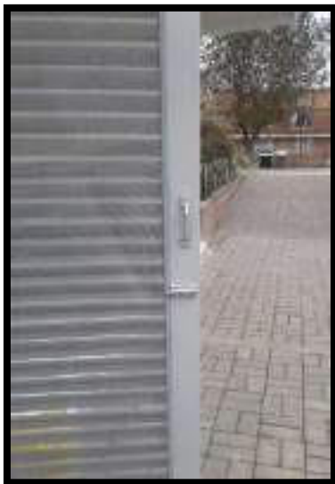
INSTALACION DE MANIJA PARA PUERTA CUARTO DE REFRIGERIOS
