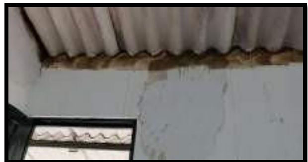
RESANE DE FISURAS EN MUROS
