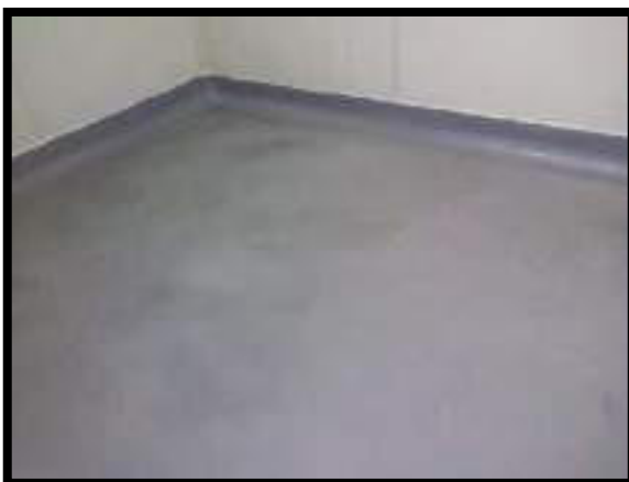
APLICACIÓN DE MATERIAL IMPERMEABILIZANTE-ARREGLOS- CUARTOS FRIOS
