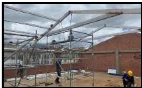
MONTAJE DE CERCHAS METALICAS
