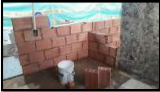
CONSTRUCCION DE MUROS EN MAMPOSTERIA
