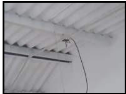
APLICACIÓN DE PINTURA PARA CUBIERTA
