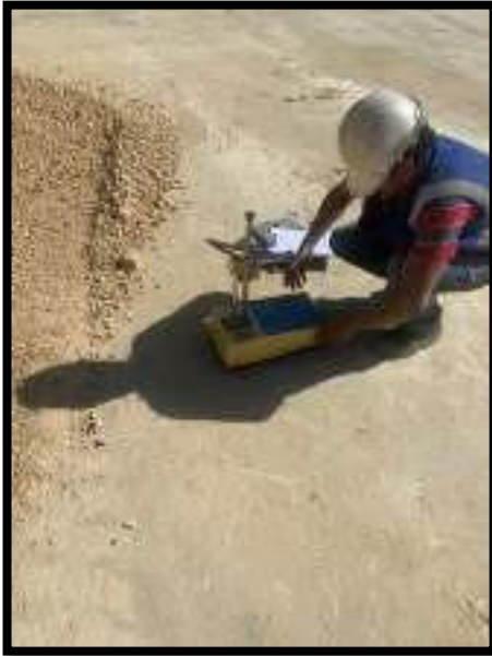
TOMA DE DENSIDADES EN MATERIAL BASE
