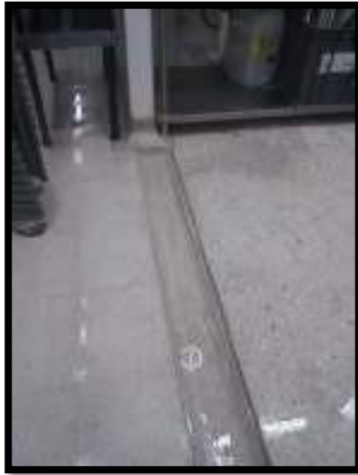
FINALIZA ARREGLO DE CARCAMO DE COCINA
