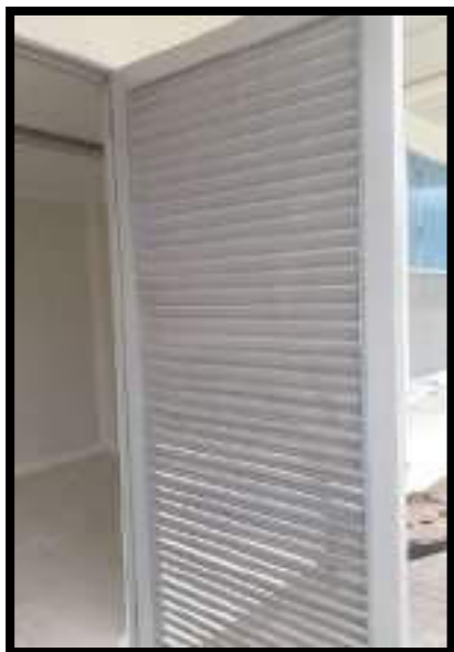
PINTURA DE PUERTA
