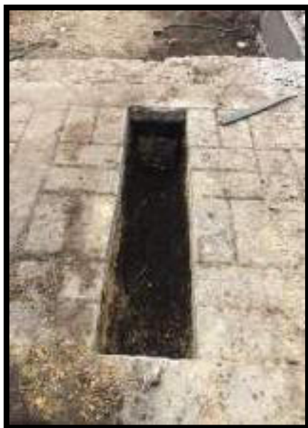
EXCAVACIÓN MANUAL PARA RED SANITARIA
