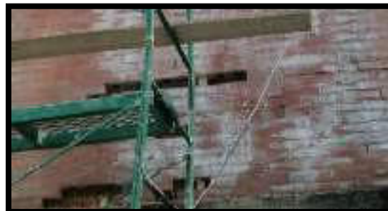
REPOSICION DE MAMPOSTERIA SUELTA
