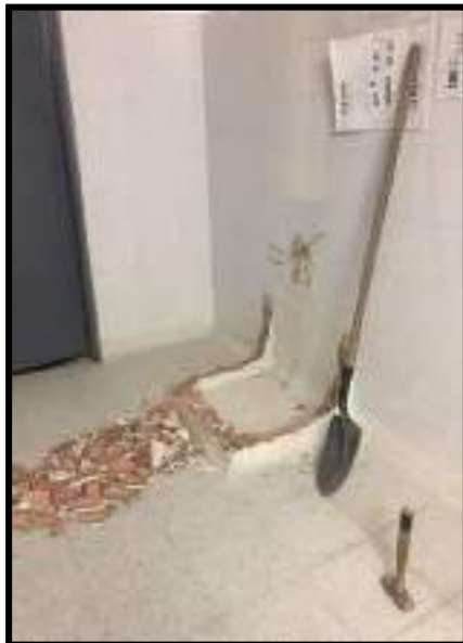
DEMOLICIÓN DE POCETA
