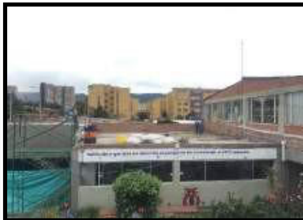
RETIRO DE ESCOMBRO Y CERCHAS SOBRE PLACA
