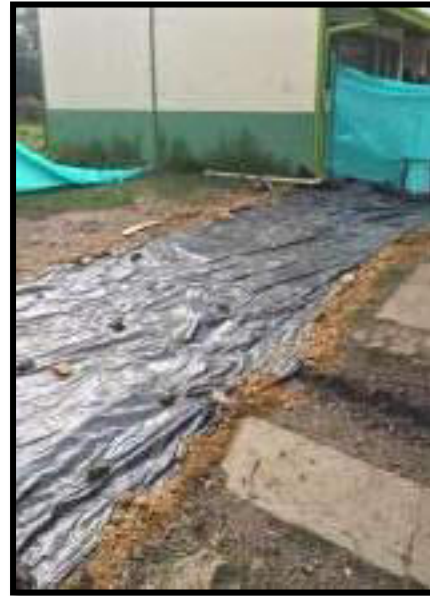
CUBRIMIENTO CON PLÁSTICO SOBRE MATERIAL
