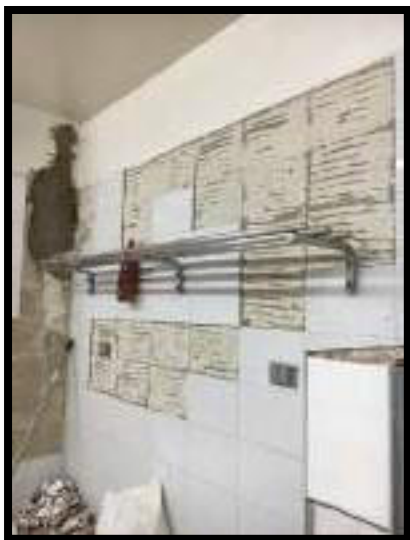
DESMONTE DE ENCHAPES FISURADOS DE MURO
