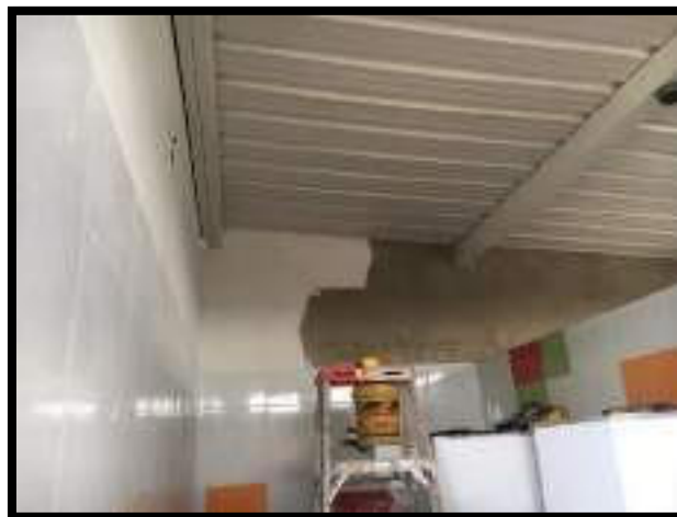
ESTUCO DE MURO SUPERIOR
