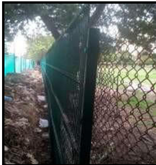
INSTALACIÓN DE CERRAMIENTO
