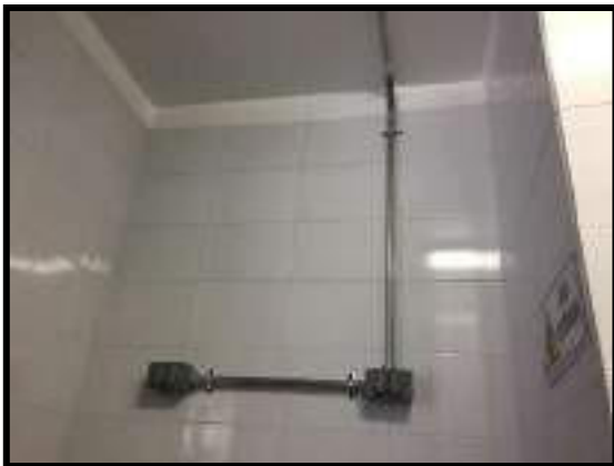
SALIDAS ELECTRICAS Y TUBERIA EMT
