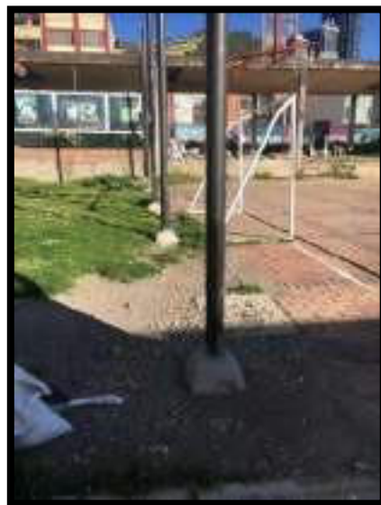
MONTAJE DE POSTES Y CONSTRUCCIÓN DE PEDESTALES
