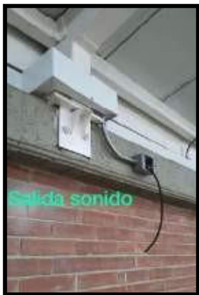
INSTALACION DE SALIDAS ELECTRICAS NUEVAS EN SALON MULTIPLE
