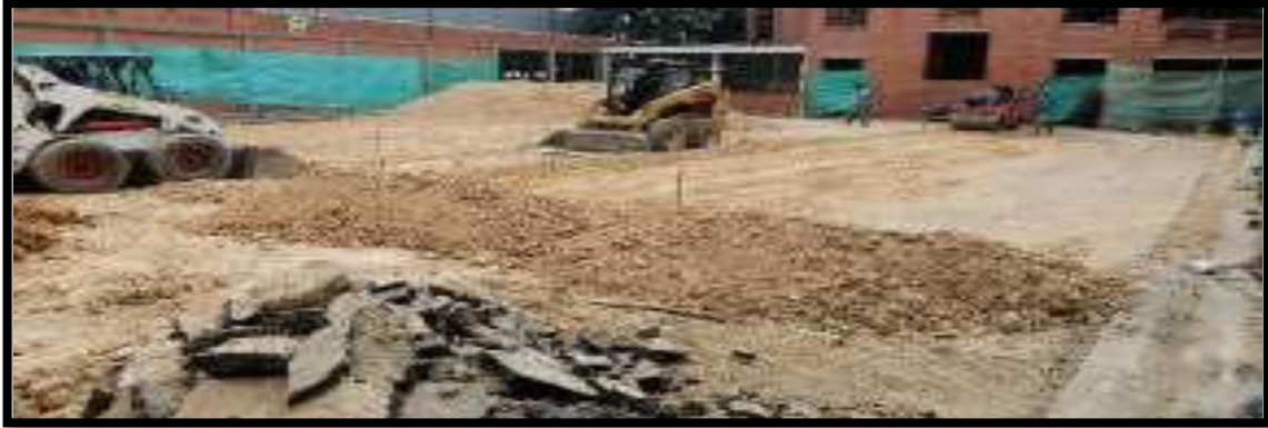
NIVELACIÓN DE MATERIAL B600
