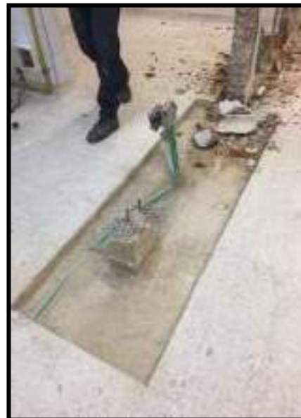
DEMOLICIÓN DE MURO
