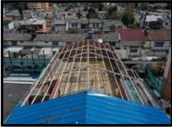
MONTAJE DE PANELES DE CUBIERTA TIPO SANDWICH
