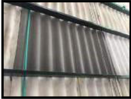
CAMBIO DE TEJAS DAÑADAS
