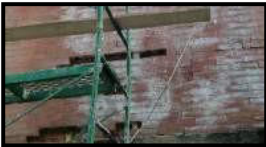
DEMOLICION DE ENCHAPE PARED
