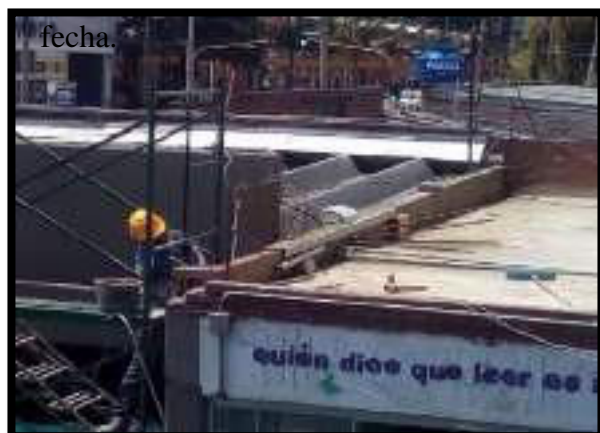
APLICACIÓN DE MORTERO DE NIVELACIÓN IMPERMEABILIZADO
