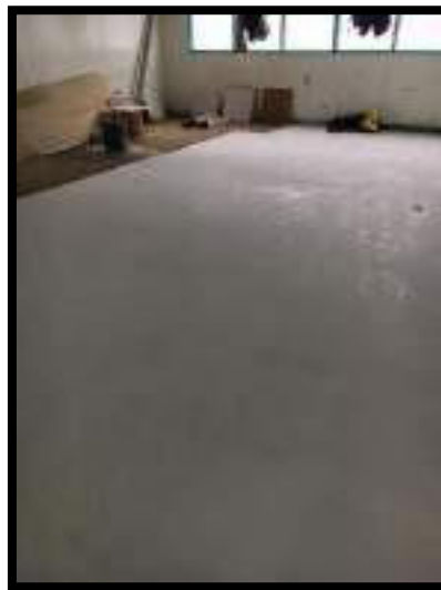
INSTALACIÓN DE ENCHAPE DE PISO
