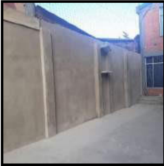
PAÑETE DE MUROS LISO
