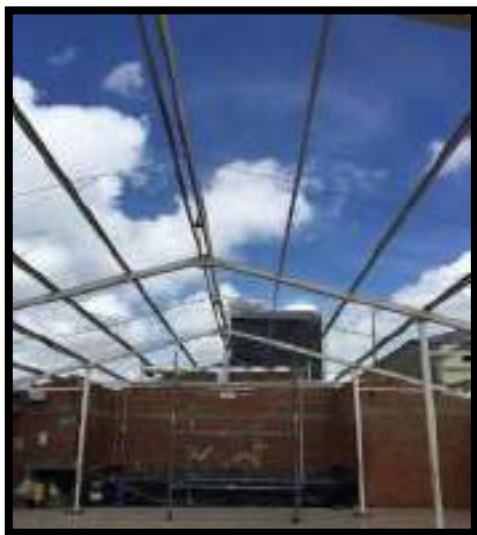
DESMONTE CUBIERTA EN ASBESTO CEMENTO-
