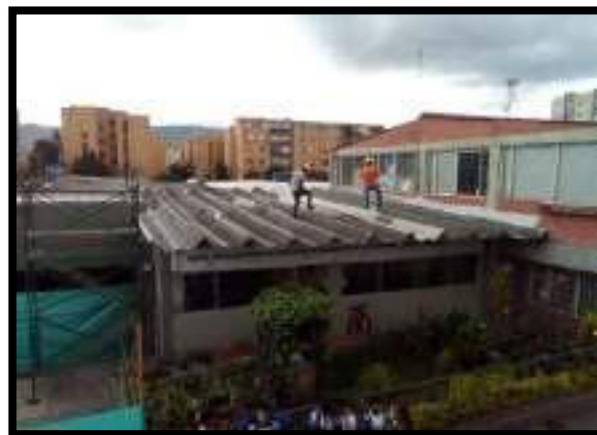
DESMONTE DE CUBIERTA
