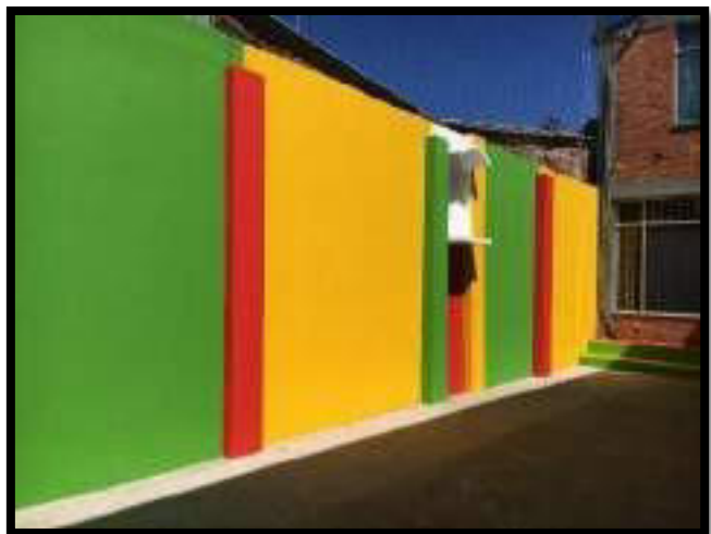
APLICACIÓN DE PINTURA EN MURO
