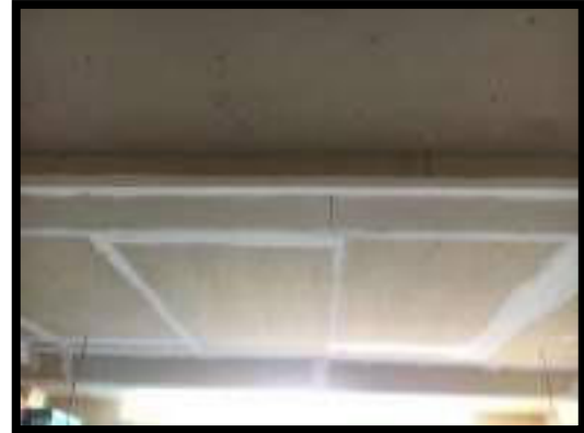
EMPASTADO DE JUNTAS LAMINAS DE SUPERBOARD
