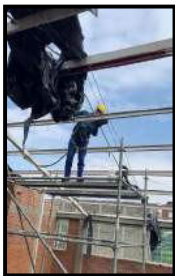
MONTAJE DE ESTRUCTURA
