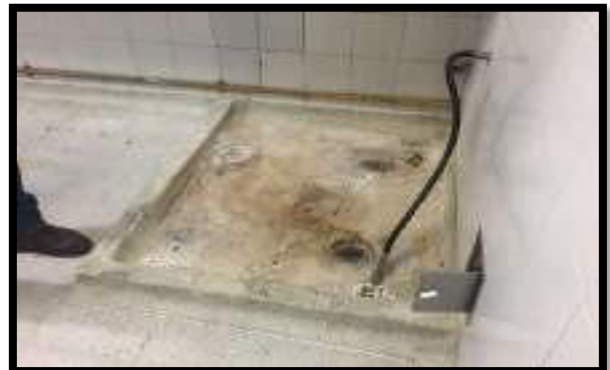
ESTADO ACTUAL DE CÁRCAMO ANTES DE DEMOLER
