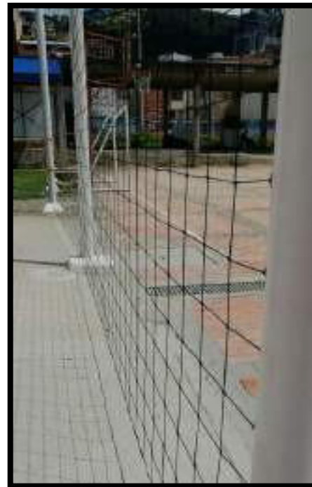
INSTALACIÓN DE MALLA PARA CANCHA
