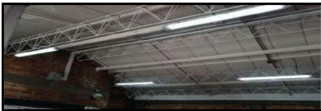
CUBIERTA SALÓN N°01
