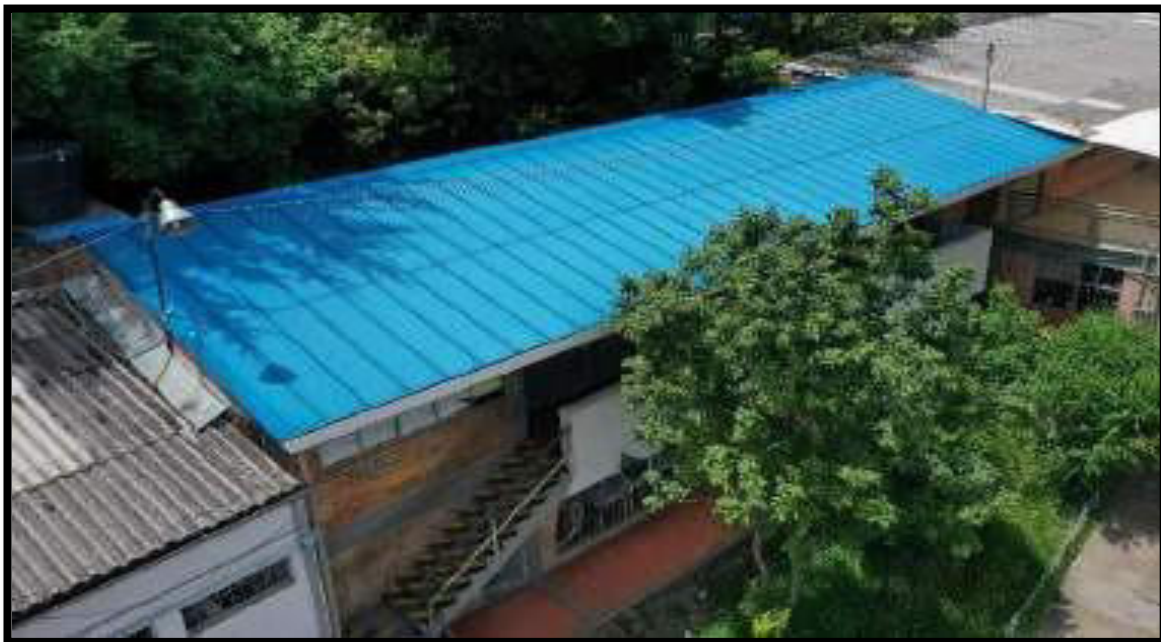
ACABADO FINAL CUBIERTA SALONES
