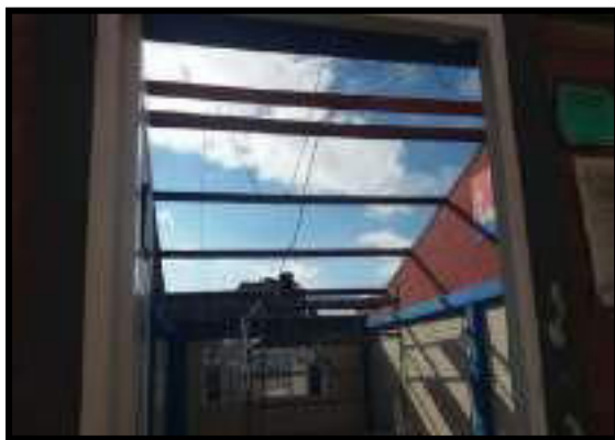
DESMONTE DE CUBIERTA
