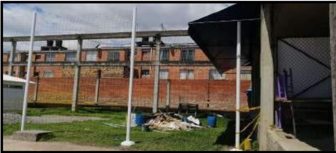
INSTALACIÓN DE MALLA PARA CANCHA
