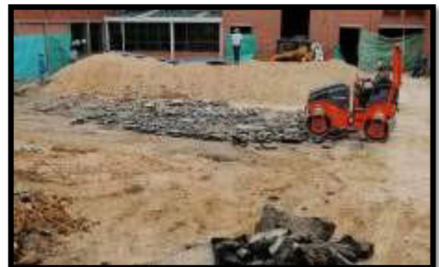
REPARACIÓN DE FALLOS
