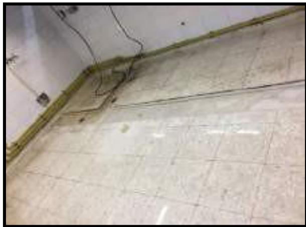
REPOSICION DE ENCHAPE PARED Y SALIDAS
