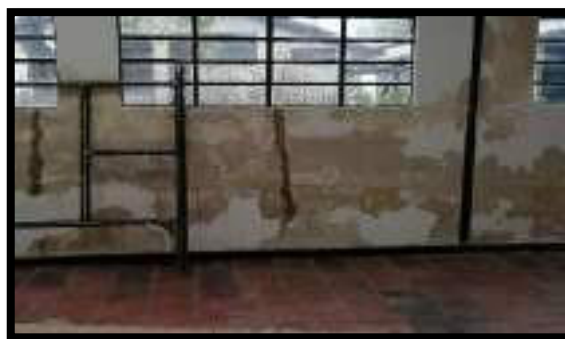
DILATACION Y RESANE DE FISURAS
