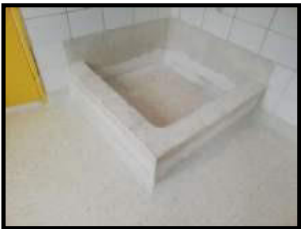
RESANE E IMPERMEABILIZACION DE POCETA
