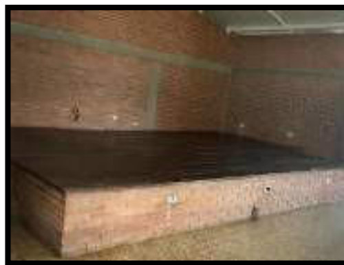
LIMPIEZA DE ENTABLADO (TARIMA SALÓN MULTIPLE)
