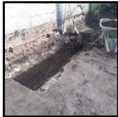
RELLENO DE ZANJA PARA PLACA NUEVA
