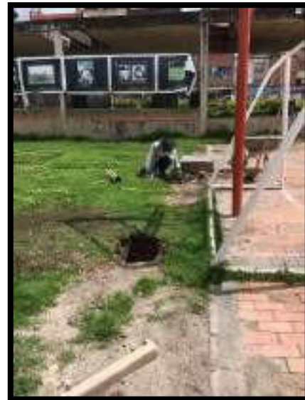
EXCAVACIÓN EN ZONA VERDE PARA INSTALACIÓN
