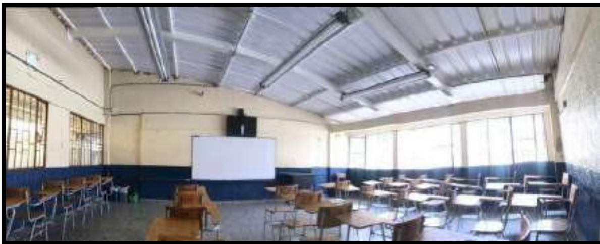
ACABADO FINAL DE CUBIERTA DE SALONES
