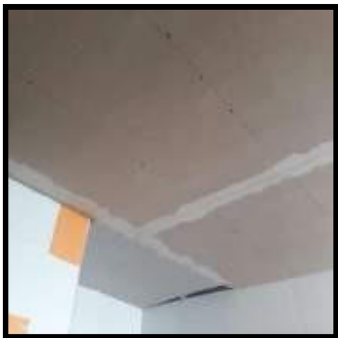
INSTALACIÓN DE LAMINAS DE SUPERBOARD EN BAÑOS
