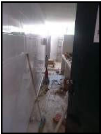
DEMOLICIÓN DE PISO
