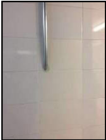
REPOSICION DE ENCHAPE PARED
