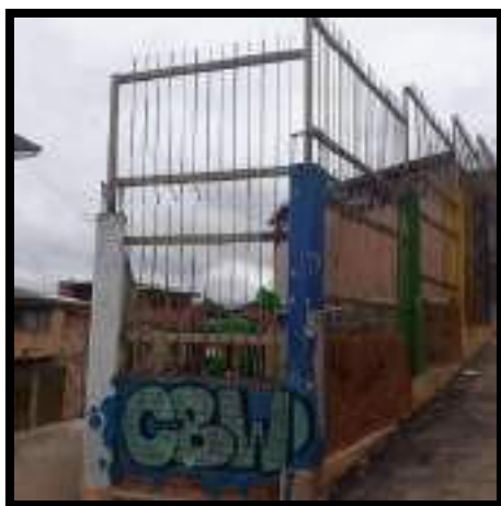
DESMONTE DE CERRAMIENTO PERIMETRAL EN LONA
