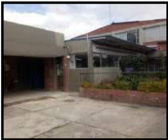
RETIRO DE ESCOMBROS Y MATERIAL DE OBRA
