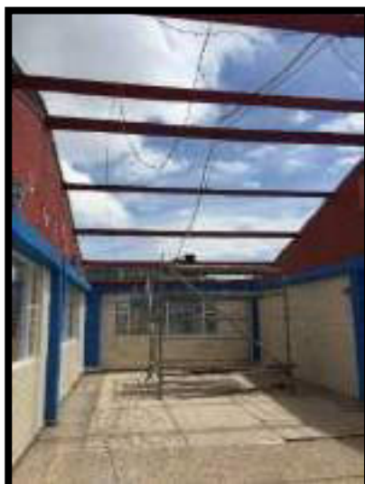
DESMONTE CUBIERTA EN ASBESTO CEMENTO- BIBLIOTECA
