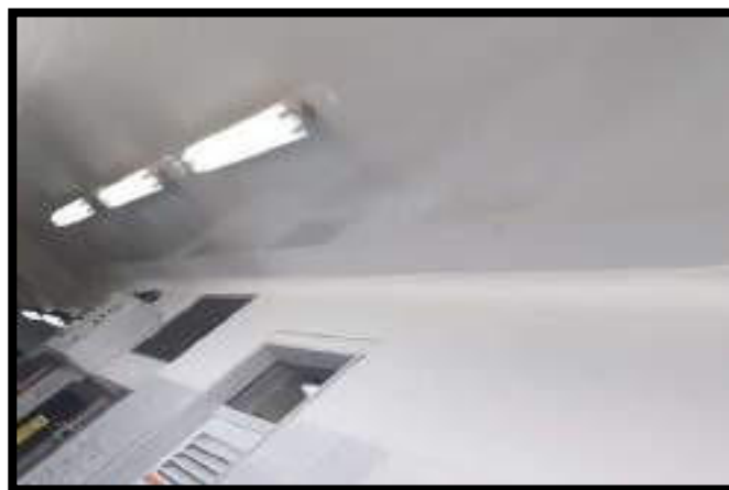
INSTALACIÓN DE MEDIA CAÑA EN PVC Y APLICACIÓN DE PINTURA EN MURO
