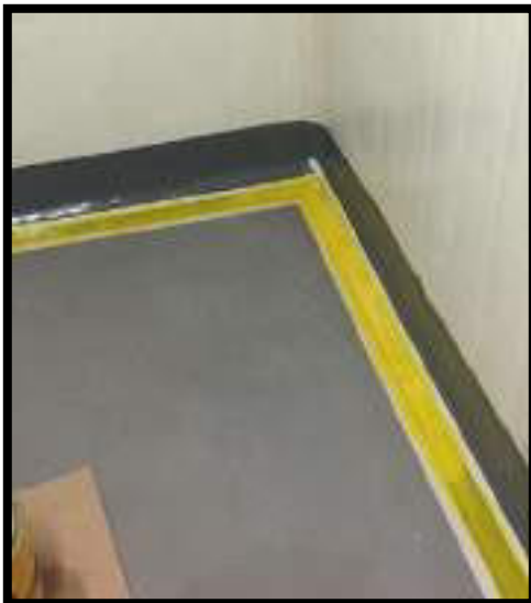
PINTURA MEDIAS CAÑAS Y CINTA DE SEGURIDAD
