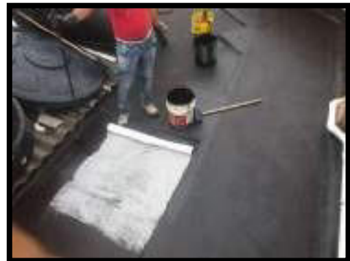
APLICACIÓN DE IMPERMEABILIZANTE
