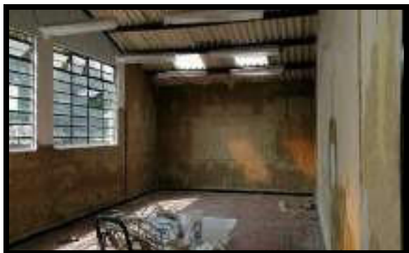
APLICACIÓN DE ESTUCO TRADICIONAL PARA MURO
