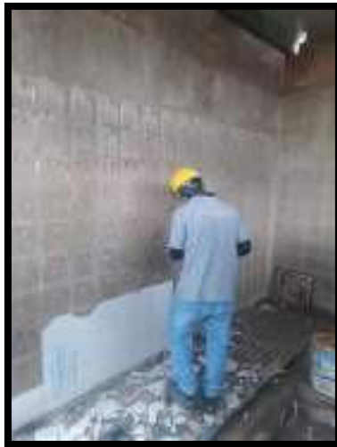
DEMOLICION DE ENCHAFE PARED
