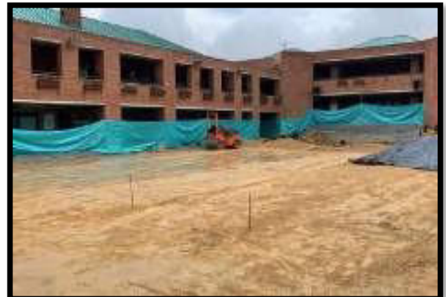
NIVELACIÓN Y COMPACTACIÓN DE MATERIAL B400
