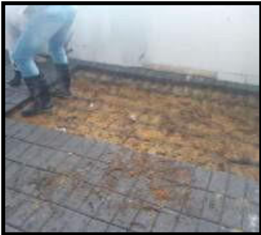
DESMONTE DE ADOQUIN EN SALONES
