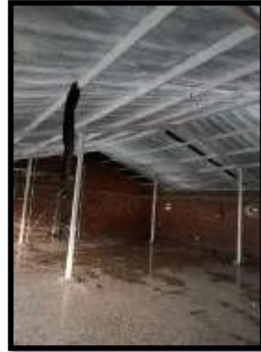
CUBRIMIENTO DE ESTRUCTURA CON PLASTICO
