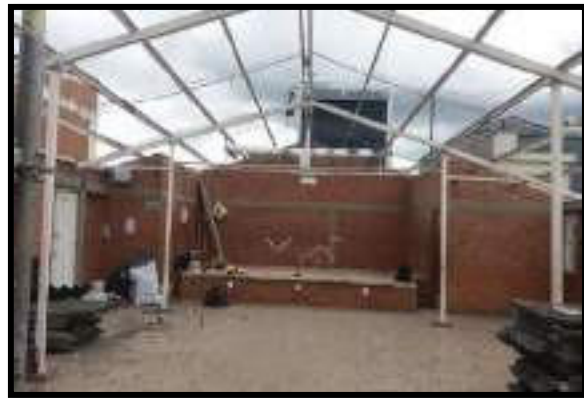
RETIRO DE ILUMINARIA
