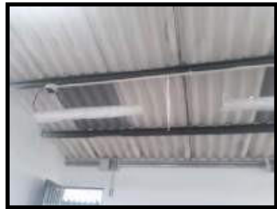
CAMBIO DE TEJAS DE ASBESTO CEMENTO DAÑADAS
