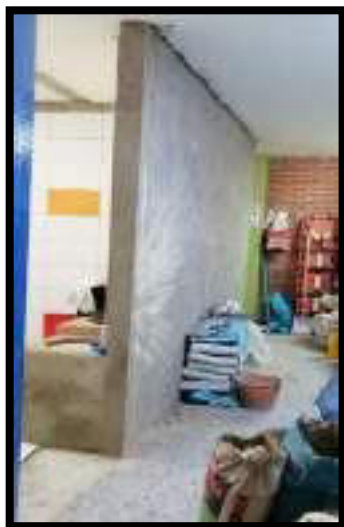
FINALIZA PAÑETE DE MURO EXTERIOR
