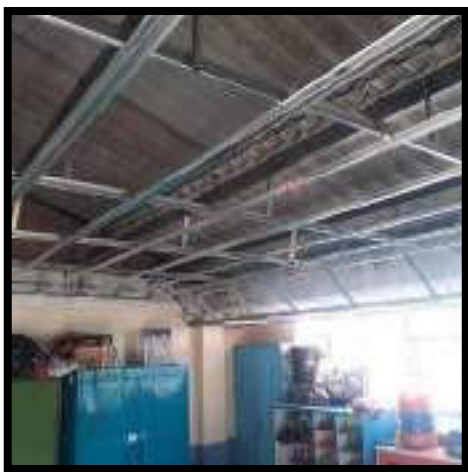
INSTALACION DE ESTRUCTURA CIELO RASO EN SUPERBOARD EN SALONES
