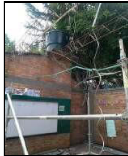
RETIRO DE CUBIERTA
