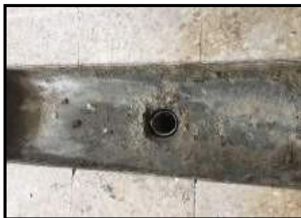
DEMOLICIÓN DE CÁRCAMOS
