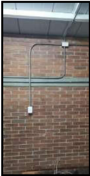
INSTALACIÓN DE TUBERIA EMT Y SALIDAS ELÉCTRICAS
