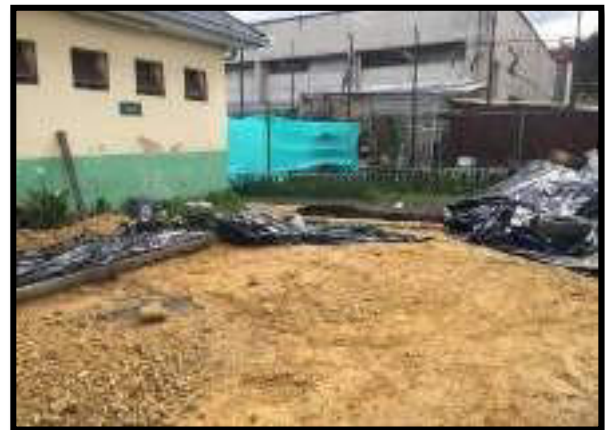
RELLENO DE MATERIAL RECEBO
