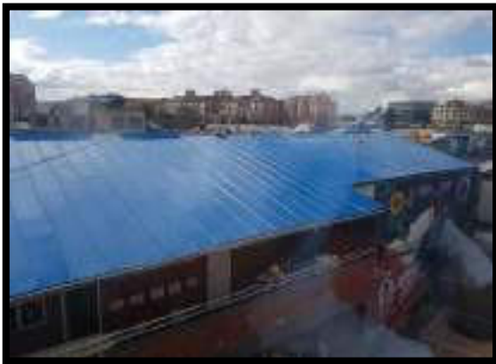
FINALIZA MONTAJE DE CUBIERTA TIPO SANDWICH
