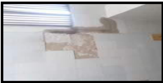
RESANE DE FISURA EN MURO
