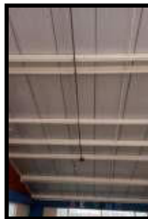
INSTALACIÓN DE TUBERIA EMT PARA ILUMINACION
