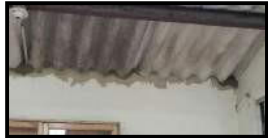
ENCORAZADA DE REMATES EN MURO/TEJA
