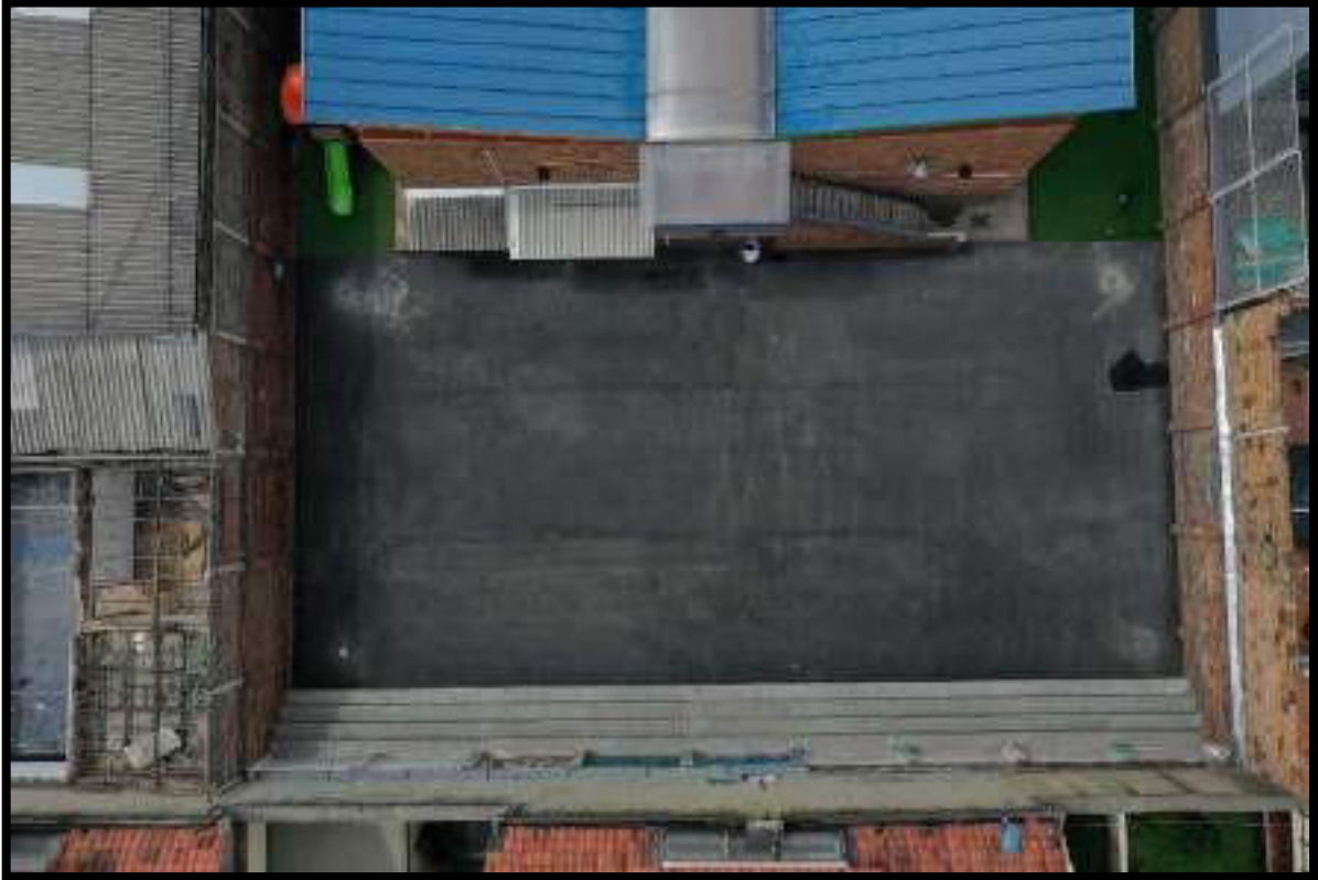
ACABADO FINAL PATIO LÚDICO
