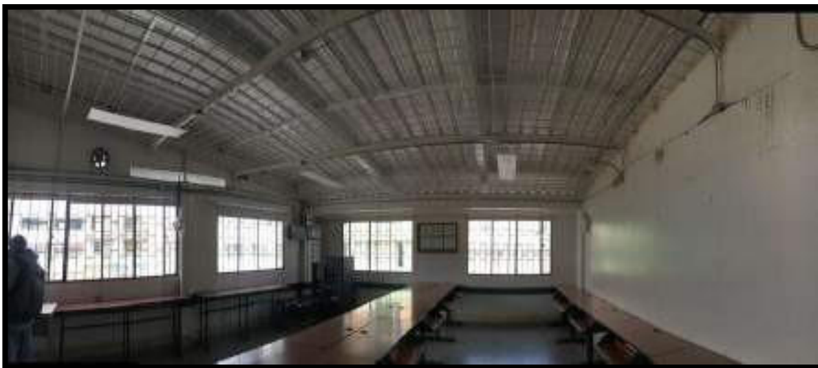
ACABADO FINAL DE CUBIERTA DE SALONES
