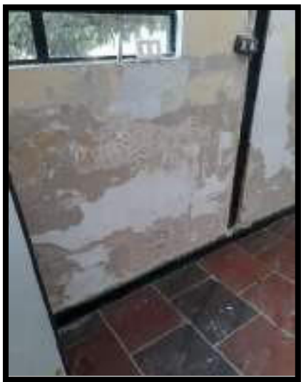
DESCARIFICACION DE MUROS
