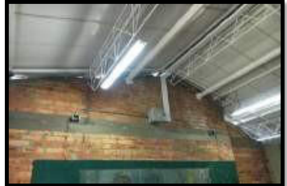
INSTALACION DE LUMINARIAS Y PUNTOS PARA PARLANTES
