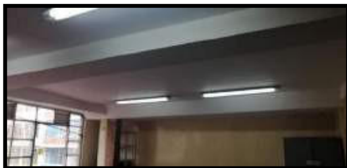
ACABADO FINAL DE CIELO RASO DE SALONES
