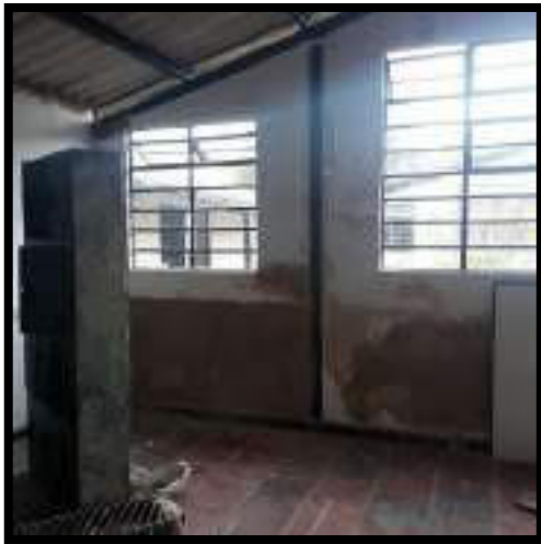
RESANE Y DILATACIONES DE FISURAS EN MUROS
