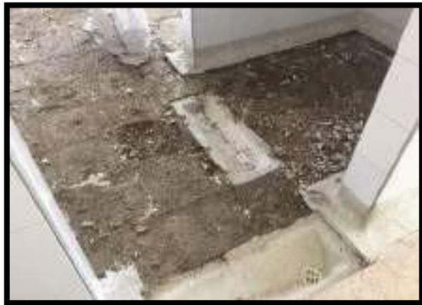
DEMOLICIÓN DE CÁRCAMOS
