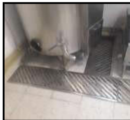
INSTALACION DE REJILLA PARA CÀRCAMO
