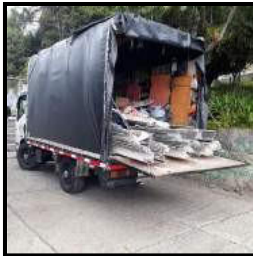
RETIRO DE ESCOMBROS Y SOBRANTES DE LA ZONA DE ACOPIO
