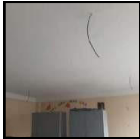
PINTURA DE CIELO RASO EN SALONES SEGUNDO PISO, ACABADO FINAL
