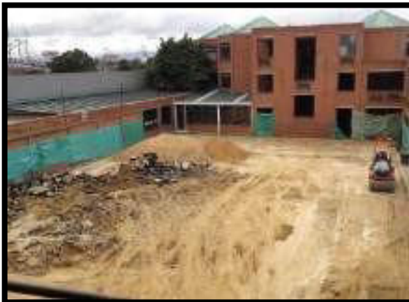
COMPACTACIÓN DE SUELO ZONA LATERAL
