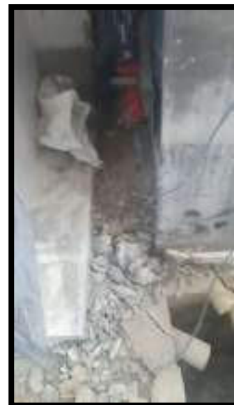
DEMOLICION DE ENCHAFE PISO
