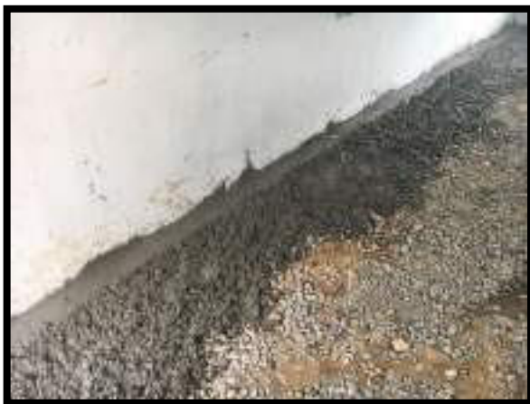
RELLENO, COMPACTACIÓN Y ALISTADO DE PISO
