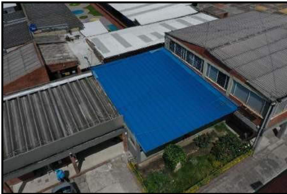
VISTA SUPERIOR DE CUBIERTA
