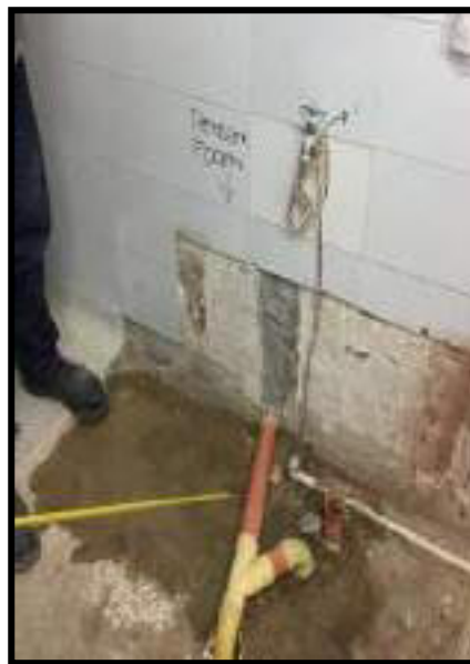
ADECUACIÓN DE RED SANITARIA POCETA DE LAVADO
