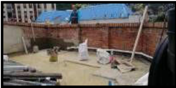
DESMONTE TOTAL DE MANTO IMPERMEABILIZANTE DE CUBIERTA
