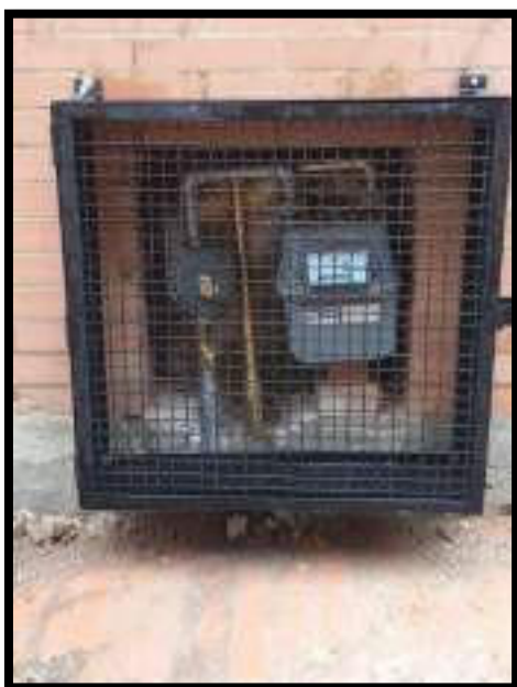
INSTALACION DE REGULADOR Y REJILLA
