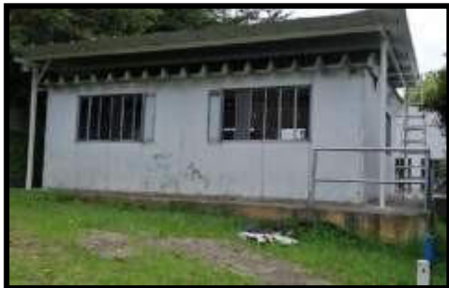
MONTAJE DE CUBIERTA TIPO SANDWICH
