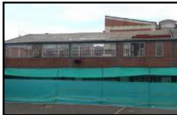
INSTALACIÓN DE MAMPARA
