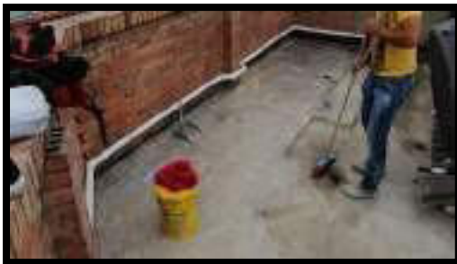
LIMPIEZA DE CUBIERTA
