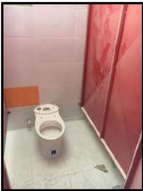
INSTALACIÓN DE APARATOS SANITARIOS
