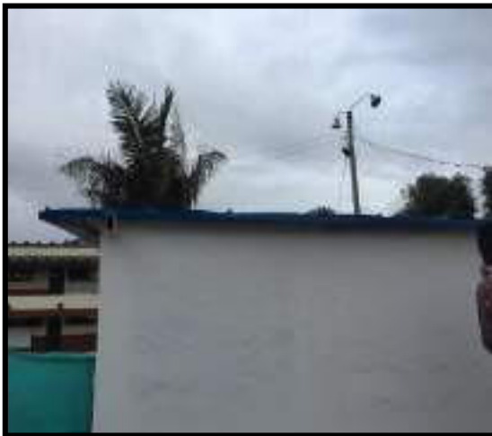
INSTALACION DE CUBIERTA TIPO SANDWICH
