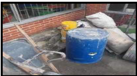
INGRESO DE MATERIAL DE OBRA
