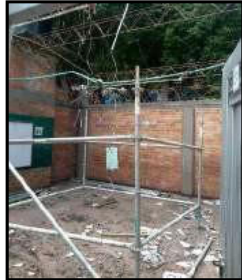
DESMONTE DE CUBIERTA
