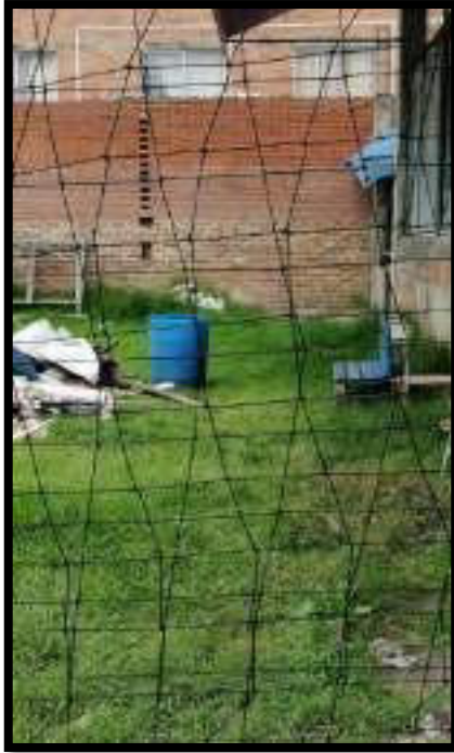
INSTALACIÓN DE MALLA PARA CANCHA
