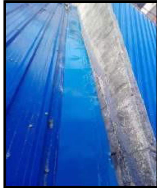
INSTALACIÓN DE FLANCHES
