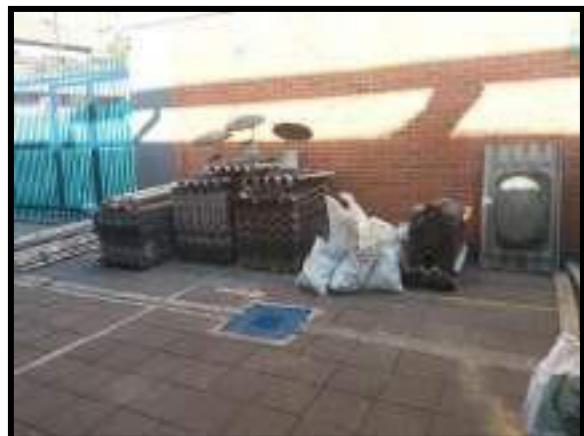
ACOPIO DE MATERIAL ASBESTO
