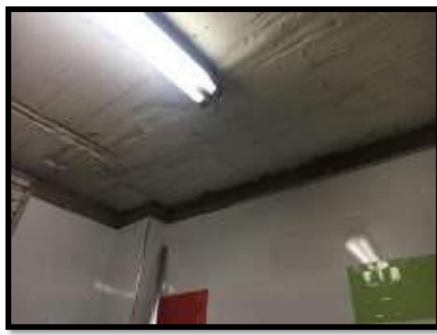
INSTALACION DE ESTRUCTURA CIELO RASO EN SUPERBOARD EN BAÑO
