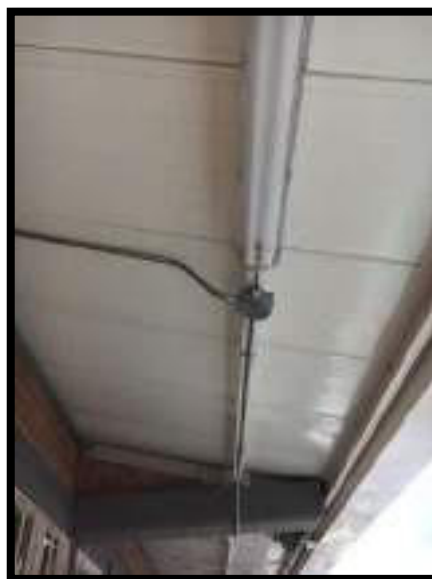
INSTALACION DE CAJAS DE PASO PARA LUMINARIAS
