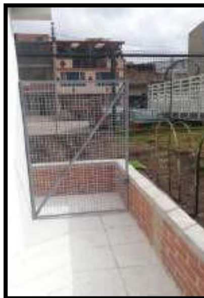
CORTE Y PINTURA DE PUERTA
