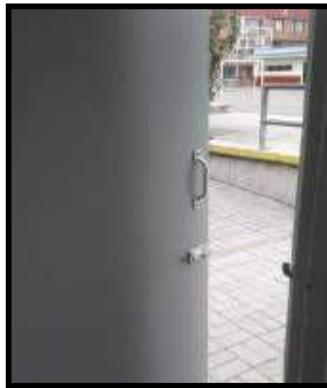
INSTALACION DE MANIJA PARA PUERTA TIENDA ESCOLAR
