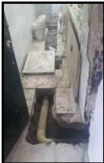
REPOSICION DE TUBERIA
