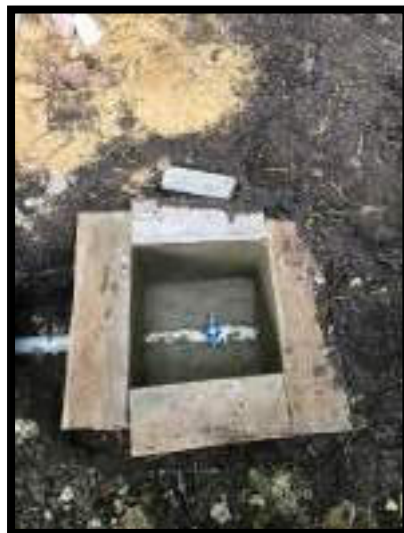
FUNDICION DE CAJA DE PASO
