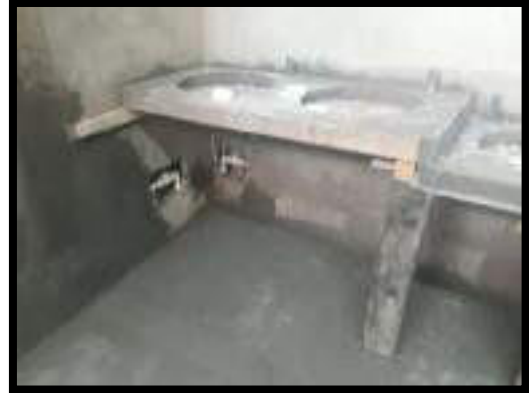
FUNDICIÓN DE MESÓN PARA LAVAMANOS
