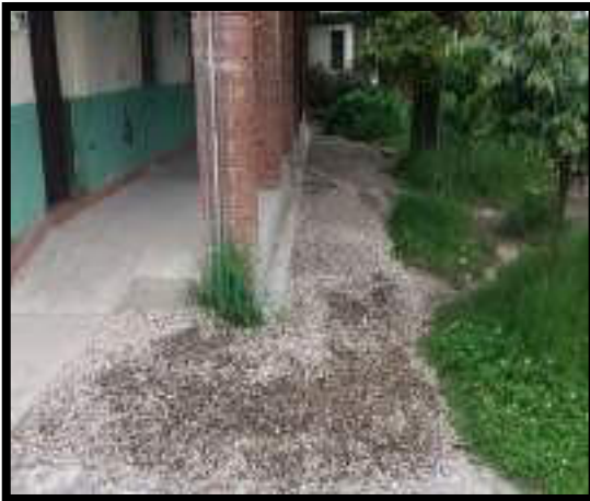
EXTENDIDO DE GRAVA
