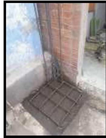
FUNDICIÓN DE ZAPATA
