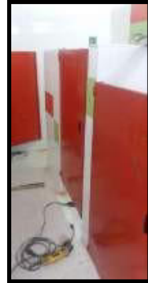
INSTALACIÓN DE PUERTAS METALICAS PARA SANITARIOS
