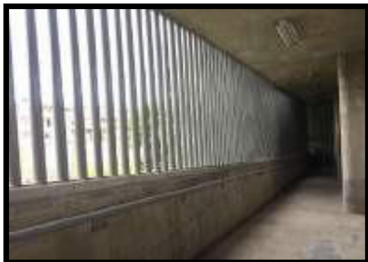
FINALIZA RASPAJE DE MUROS
