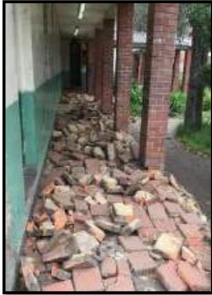
DEMOLICIÓN DE PISO
