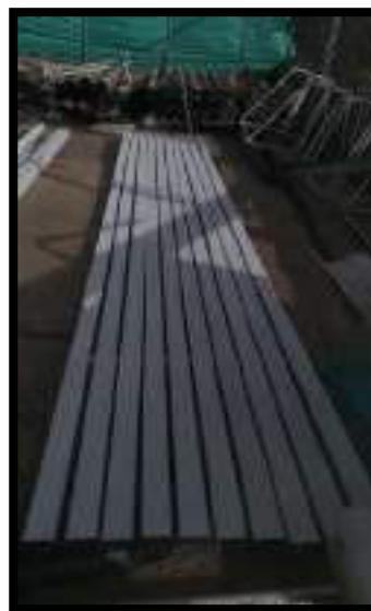
PINTURA DE PERFILERIA METALICA
