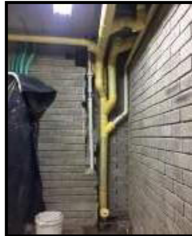
DEMOLICION DE BLOQUE EN CUARTO ELECTRICO
