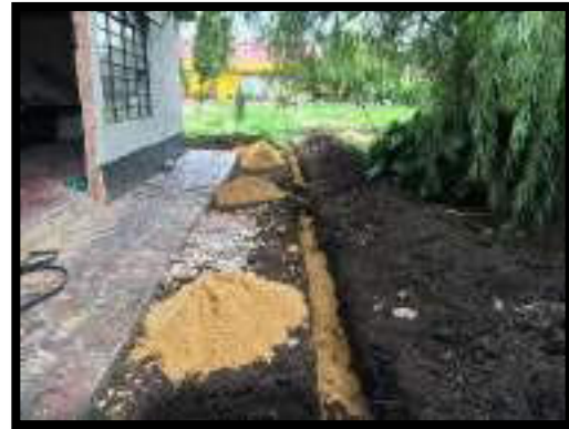
EXCAVACIÓN DE ACOMETIDA
