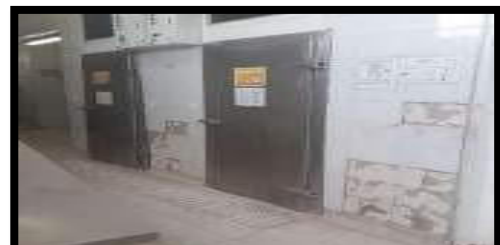
DESMONTE DE ENCHAPES FISURADOS DE MURO
