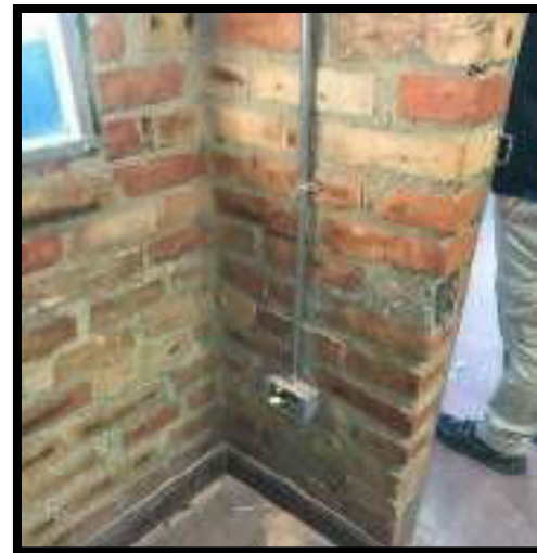
SALIDAS ELECTRICAS Y TUBERIA EMT
