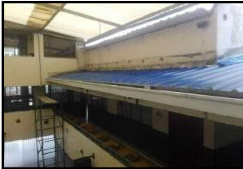
INSTALACIÓN DE CANAL
