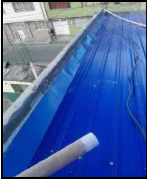
INSTALACIÓN DE FLANCHES
