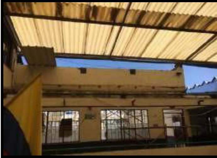
INSTALACIÓN DE PLATINAS
