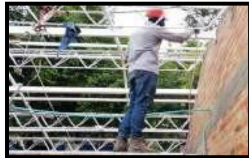
APLICACIÓN DE PINTURA PARA ESTRUCTURA
