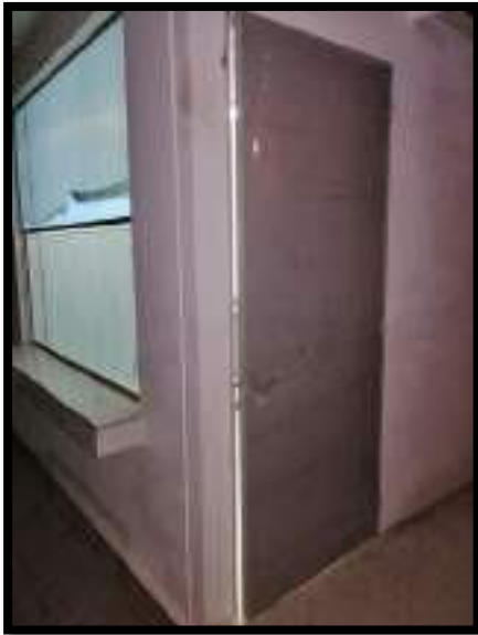
INSTALACION PUERTA- TIENDA ESCOLAR
