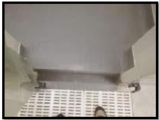
CUARTO FRIO- IMPERMEABILIZACION
