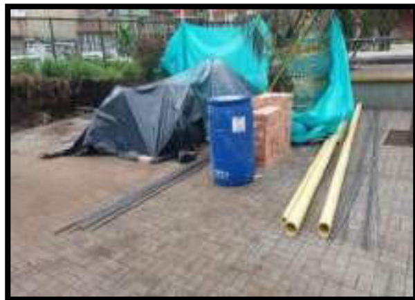
ACOPIO DE MATERIAL DE OBRA
