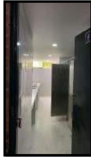
FINALIZA OBRA EN BAÑOS
