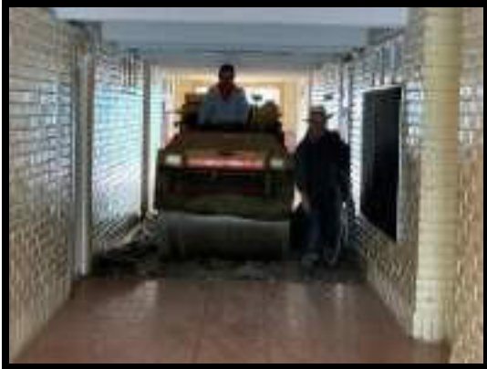
INGRESO DE MAQUINARIA PARA COMPACTACIÓN
