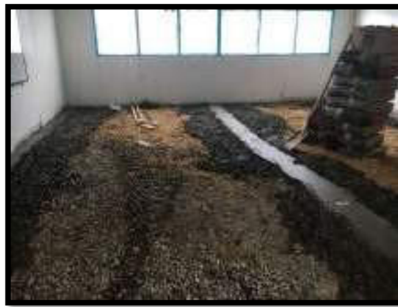
RELLENO, COMPACTACIÓN Y ALISTADO DE PISO
