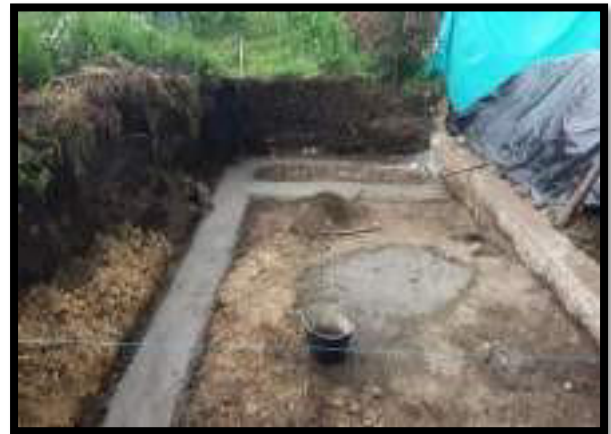
FUNDICIÓN DE SOLADO
