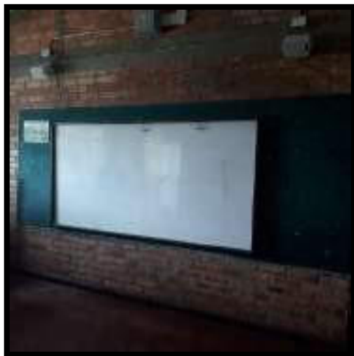
MONTAJE DE TABLERO PARA SALÓN SEGUNDO PISO
