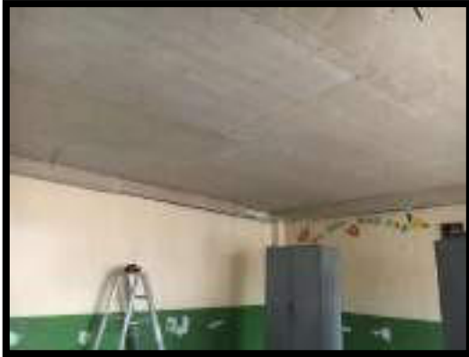
INSTALACIÓN DE LAMINAS DE SUPERBOARD EN LOS SALONES
