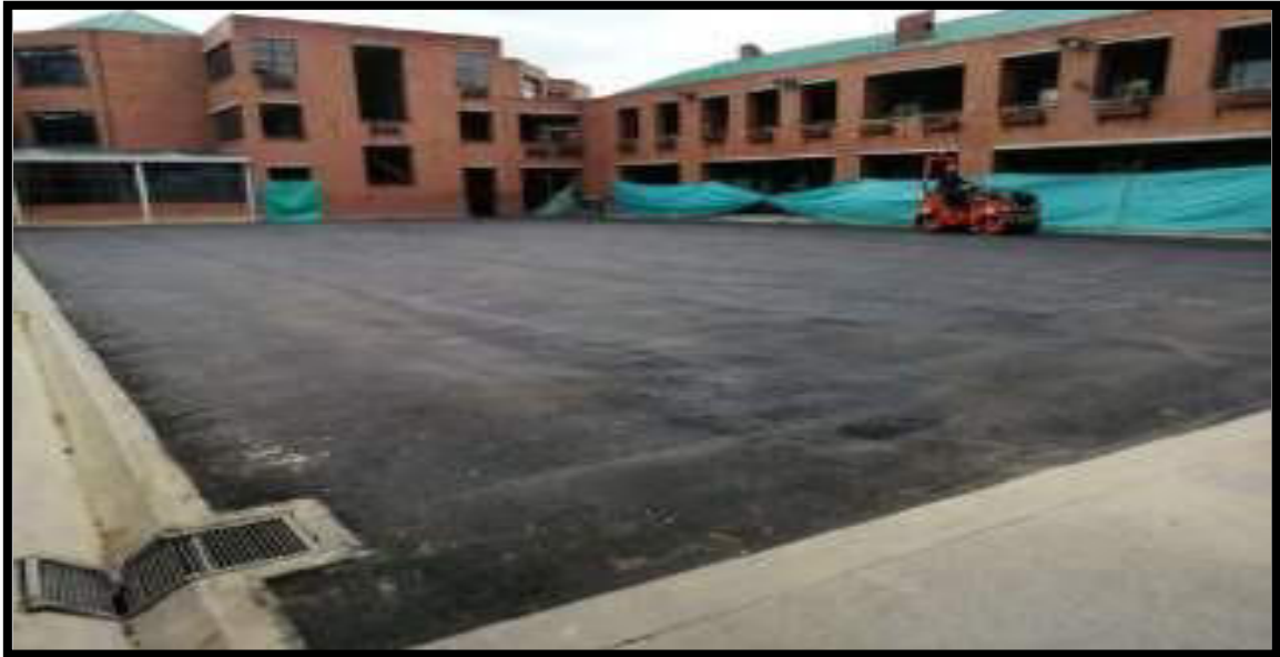
ACABADO FINAL DEL ASFALTO
