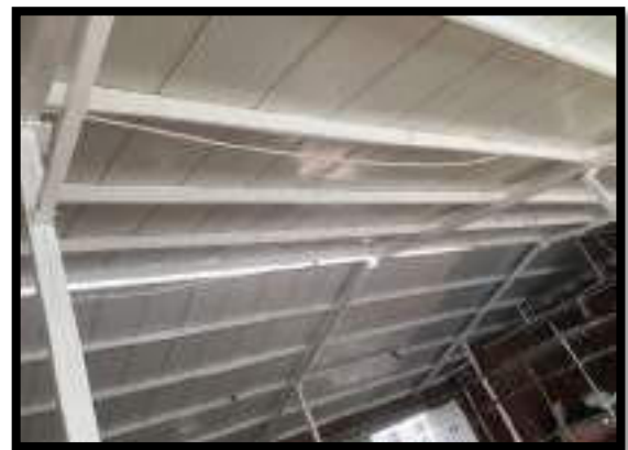
FINALIZA MONTAJE DE CUBIERTA TIPO SANDWICH
