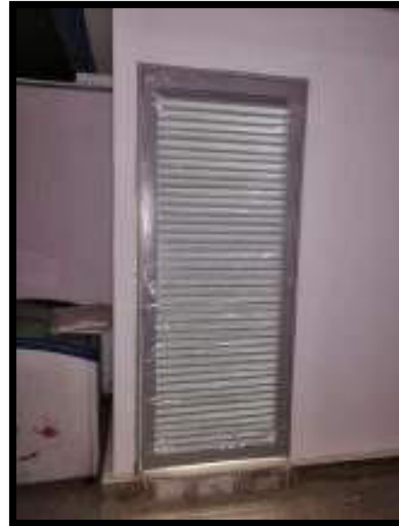
INSTALACION DE PUERTA- CUARTO DE REFRIGERIOS
