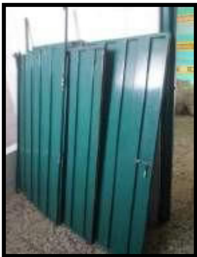
DESMONTE DE DIVISIONES METALICAS DE BAÑOS
