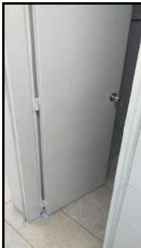
INSTALACIÓN PUERTA TIPO ENTAMBORADA
