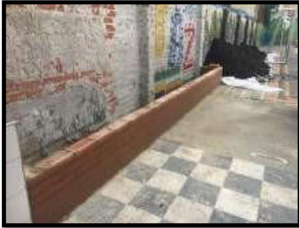
CONSTRUCCIÓN DE JARDINERA NUEVA
