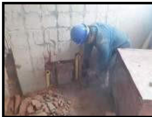
REGATAS E INSTALACION DE TUBERIA
