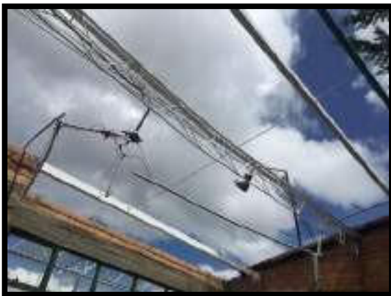
PINTURA DE PERFILERIA METALICA
