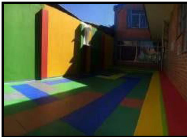
ZONA NIÑOS-INSTALACIÓN DE PISO PVC
