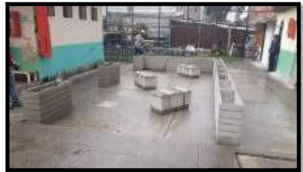
INSTALACION DE MATERAS Y BANCAS EN CONCRETO
