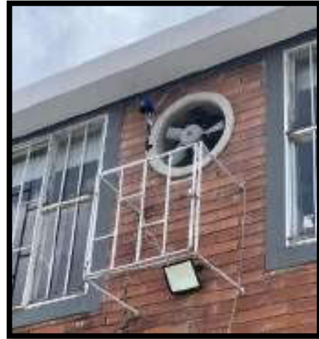
CONEXIÓN E INSTALACIÓN DE REFLECTOR
