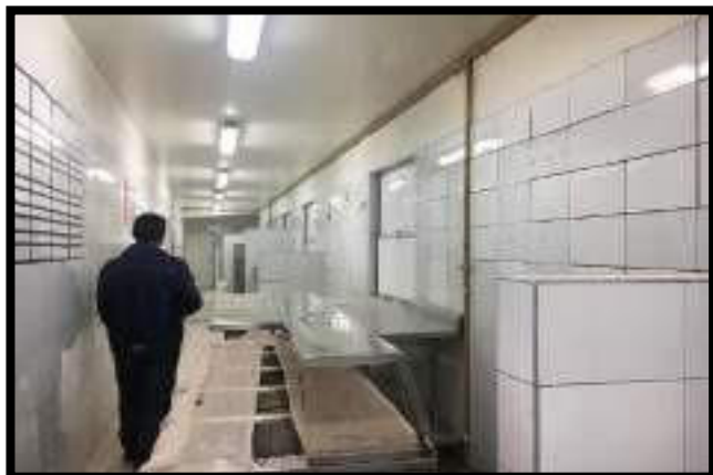
MONTAJE DE ENCHAPES DE MURO
