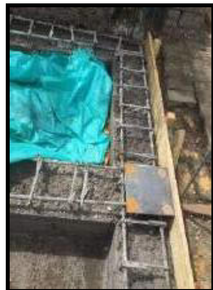
DESENCOFRAO DE VIGAS DE AMARRE
