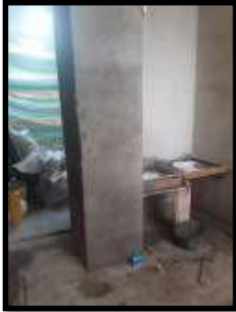
PAÑETE DE MUROS
