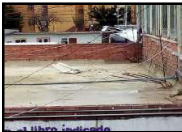
ADECUACIÓN DE MURO LATERAL
