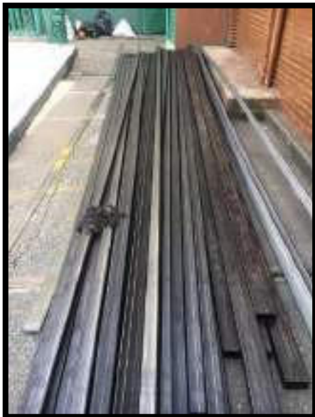
INGRESO DE PERFILERIA DE SOPORTE PARA INSTALACIÓN DE CUBIERTA NUEVA
