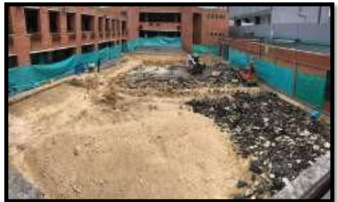
RELLENO CON MATERIAL SOBRANTE PARA INICIAR
