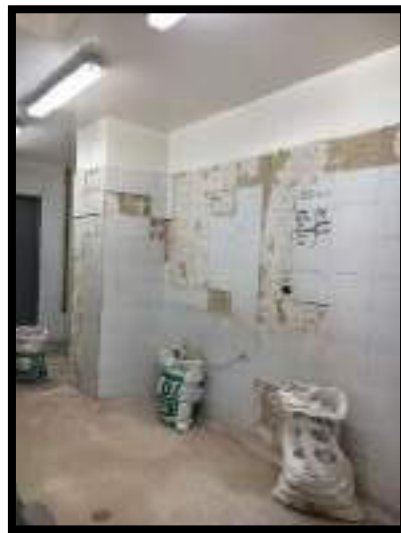
DEMOLICIÓN DE ENCHAPES FISURADOS EN MURO
