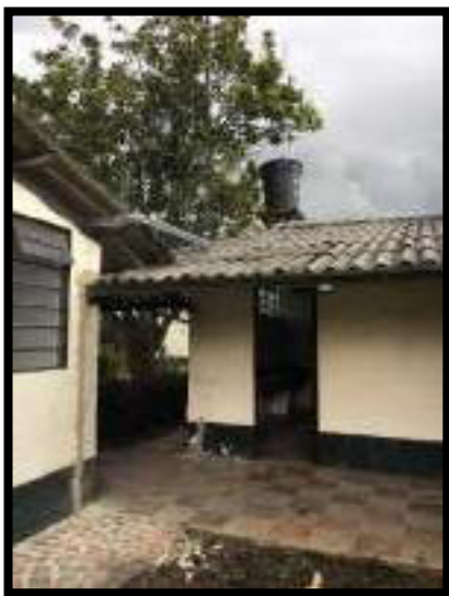
FUNDICION DE CAJA DE PASO
