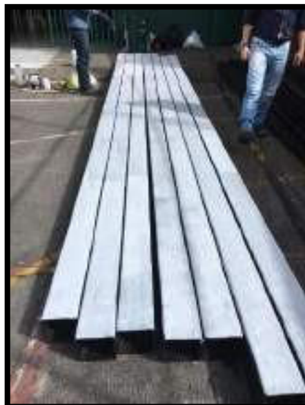
PINTURA EN SITIO DE PERFILERIA DE SOPORTE
