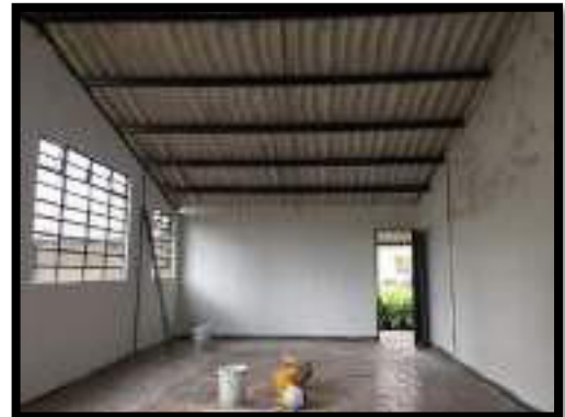
APLICACIÓN DE UNA MANO DE PINTURA EN MUROS
