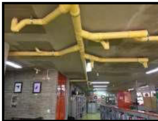
TUBERIA NUEVA HIDROSANITARIA A LA VISTA-BIBLIOTECA
