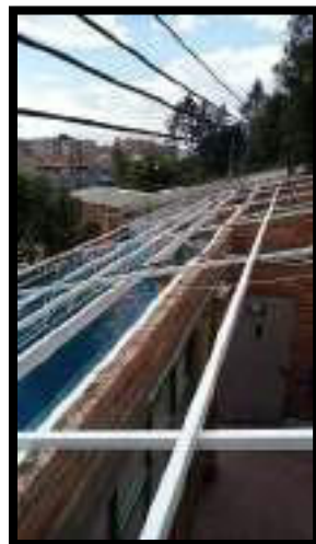
FINALIZA REFUERZO DE PERFILERÍA METÁLICA
