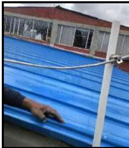
REMATES LATERALES DE TEJAS TIPO SANDWICH
