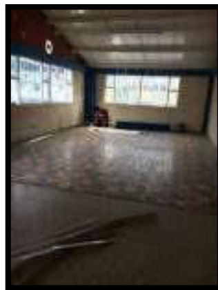
DESMONTE DE TAPETE DE BIBLIOTECA
