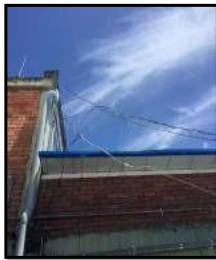
FINALIZA INSTALACION DE BAJANTE DE ALL
