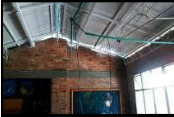
DESMONTE DE RED ELECTRICA EXISTENTE
