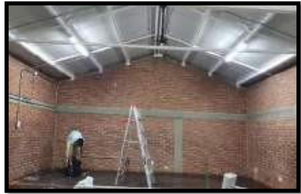
INSTALACIÓN DE LUMINARIAS EN ZONA DE TARIMA
