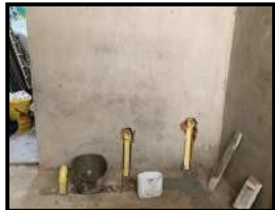
INSTALACION DE TUBERIA SANITARIA
