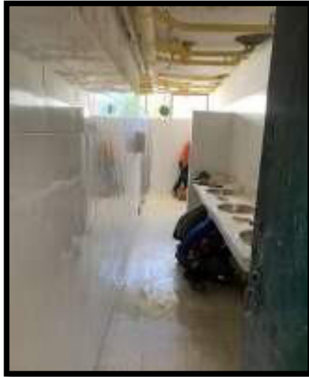
TUBERIA HIDROSANITARIA A LA VISTA- 2DO PISO
