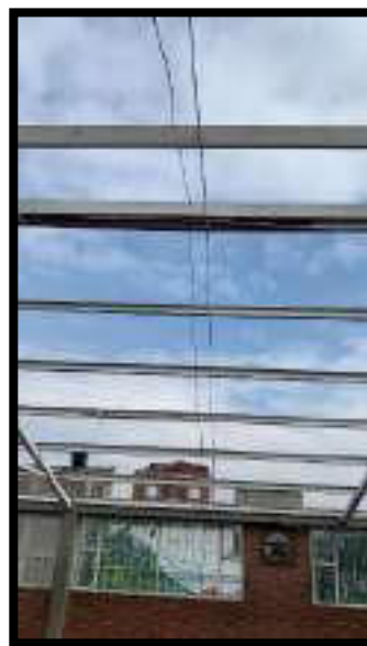
MONTAJE DE ESTRUCTURA
