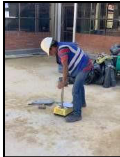
TOMA DE DENSIDADES EN MATERIAL BASE
