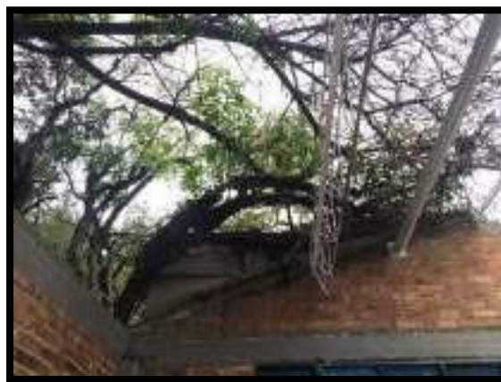
PINTURA DE PERFILERIA METALICA
