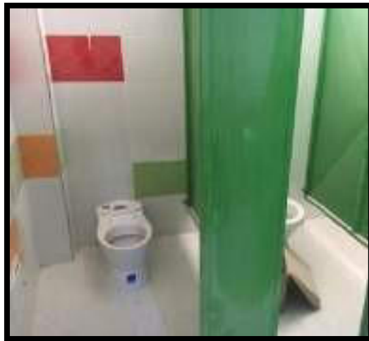
INSTALACIÓN DE APARATOS SANITARIOS
