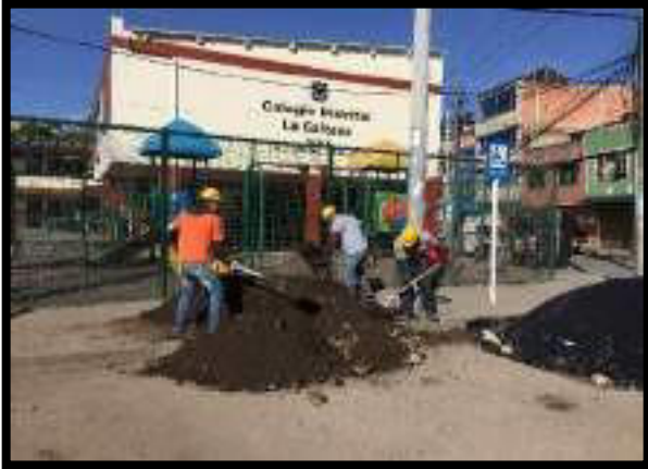
TRASIEGO DE MATERIAL ESCOMBRO Y
