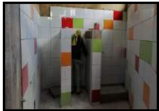
INSTALACIÓN DE ENCHAPE MUROS
