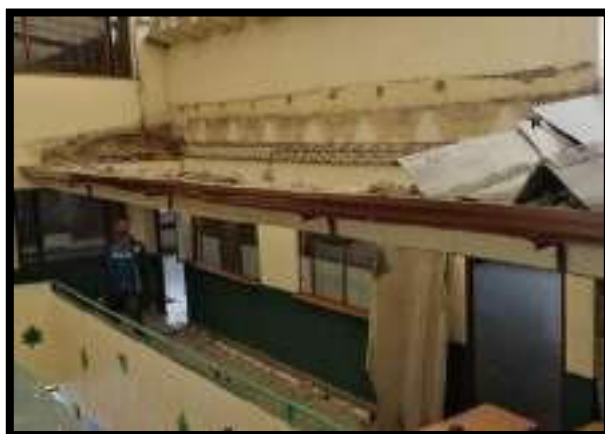
DESMONTE DE CUBIERTA EXISTENTE EN ZONA DE CORREDOR
