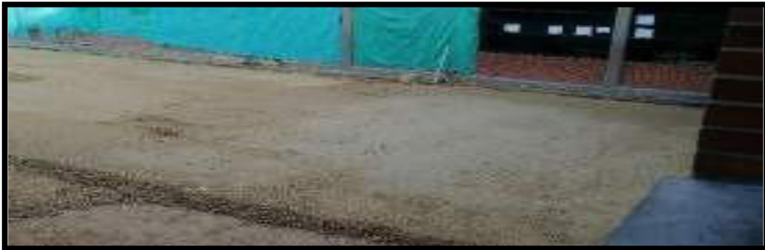
NIVELACIÓN Y COMPACTACIÓN DE MATERIAL B600
