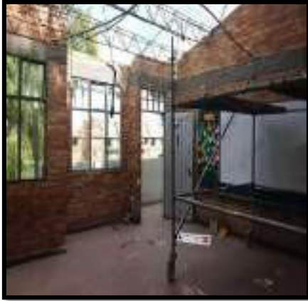
RETIRO DE CUBIERTA
