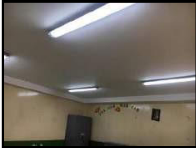
INSTALACIÓN DE LAMPARAS PARA SALONES
