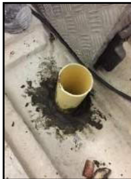
REPOSICION DE TUBERIA SANITARIA
