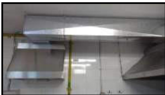
INSTALACION DE CAMPANA
