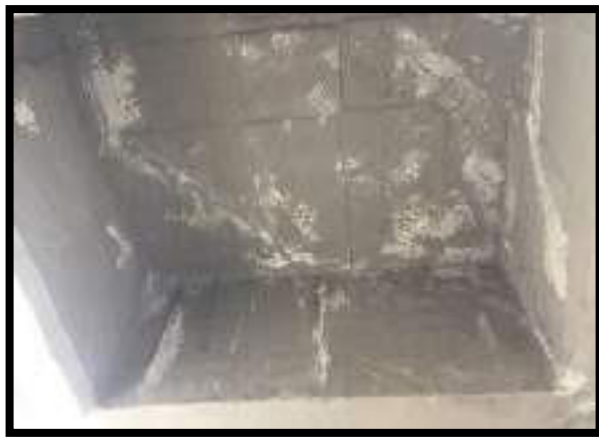
LIMPIEZA DE PLACA ALIGERADA PARTE INFERIOR
