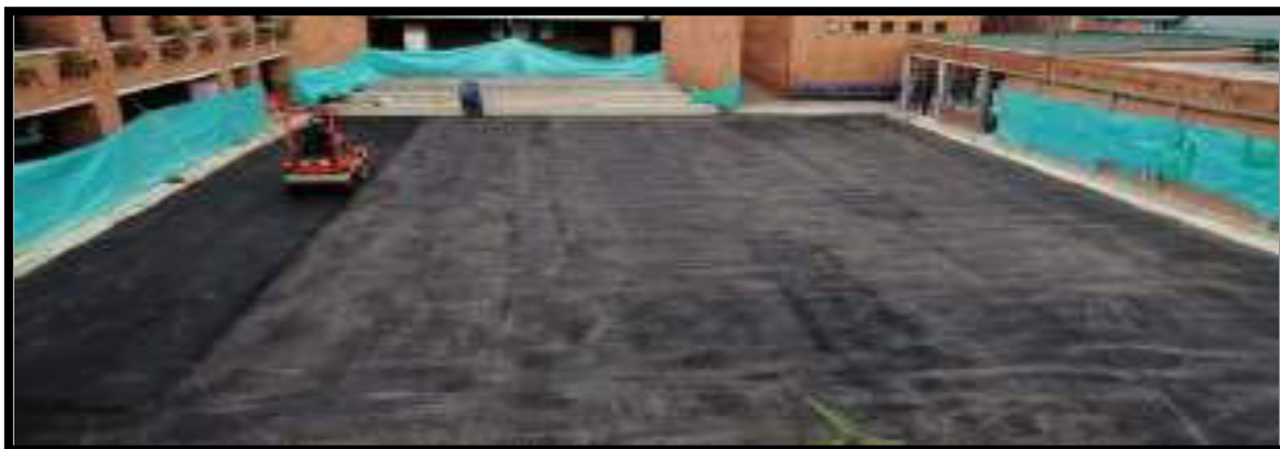
COMPACTACIÓN DE ASFALTO ZONA LATERAL
