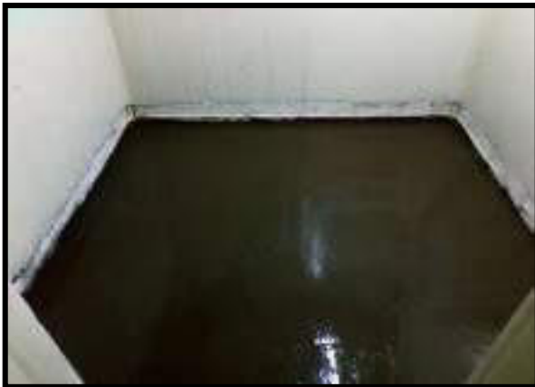
FUNDICIÓN DE PLACA EN CUARTO FRIO
