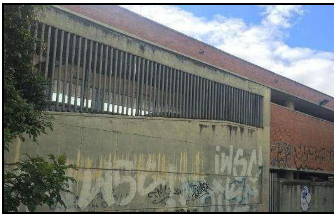
VISTA EXTERIOR DE CERRAMIENTO
