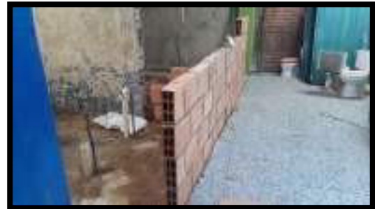
CONSTRUCCION DE MUROS EN MAMPOSTERIA
