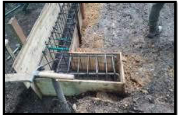
FIGURADO DE ACERO Y ENCOFRADO DE VIGAS
