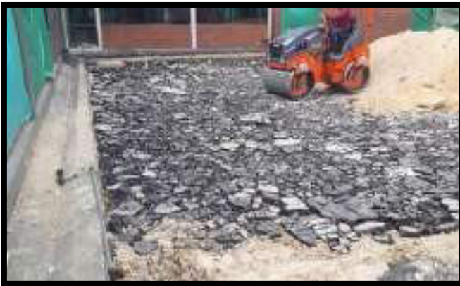
COMPACTACIÓN DE RELLENO DE TRITURADO
