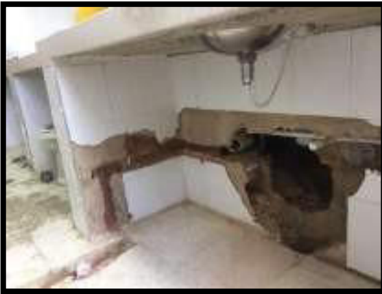
DESMONTE DE TUBERIA DE SUMINISTRO
