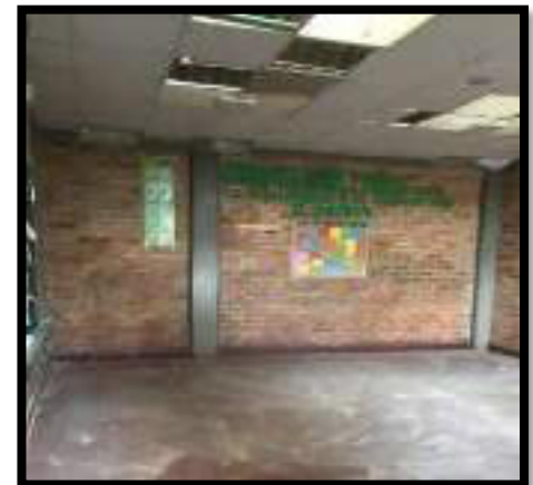
DESMONTE CIELO RASO
