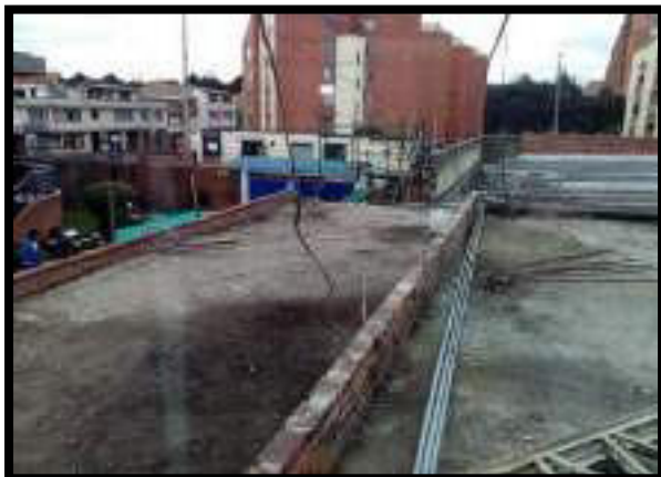
INSTALACIÓN DE MEDIA CAÑA PERIMETRAL
