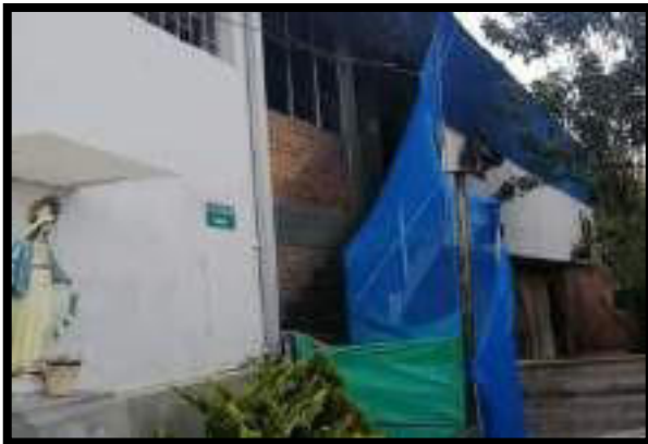
INSTALACION DE CERRAMIENTO SEGUNDO PISO
