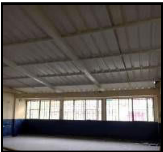
INSTALACIÓN DE TEJA TIPO UPVC EN SALÓN DE SISTEMAS
