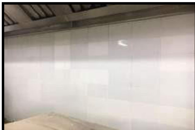
ACABADO FINAL DE ENCHAPE DE MURO
