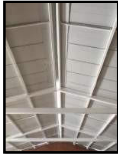
INSTALACION DE CUMBRERA INTERIOR
