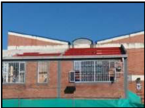
DESMONTE DE CUBIERTA
