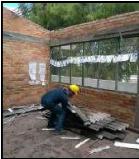
RETIRO DE CUBIERTA
