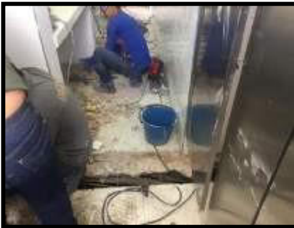
DESMONTE DE TUBERIA HIDROSANITARIA GALVANIZADA
