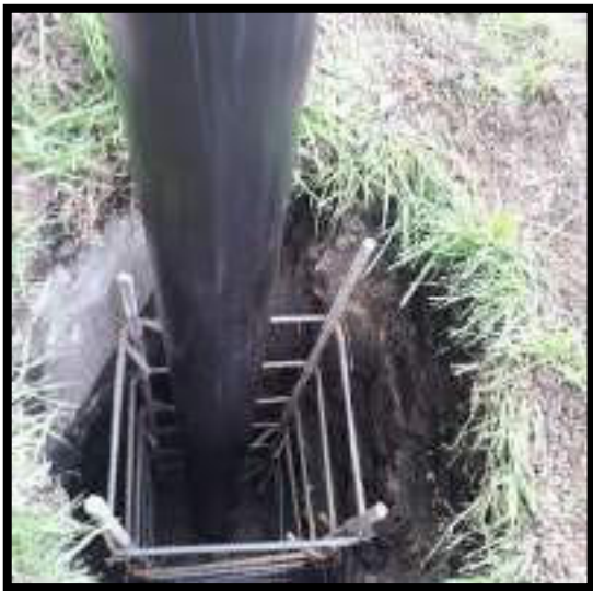
ARMADO DE PEDESTALES PARA FUNDICIÓN DE POSTES
