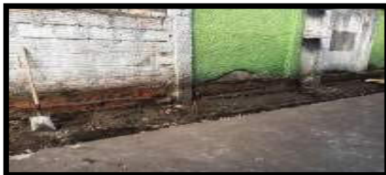
EXCAVACIÓN ÁREA DE JARDINERA PARA CONSTRUCCIÓN POSTERIOR DE PLACA
