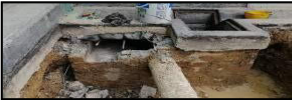
REPARACIÓN CAJA DE INSPECCIÓN POR FILTRACIÓN
