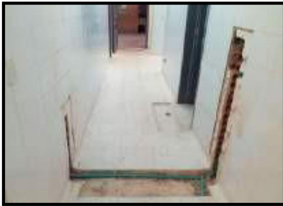
CORTE Y DEMOLICIÓN DE PISO Y MUROS
