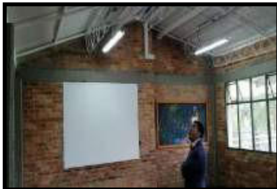
INSTALACIÓN DE SUPERBOARD EN VENTANA
