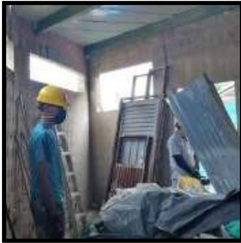
ASEO Y RETIRO DE ESCOMBRO
