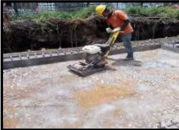
COMPACTACIÓN DE MATERIAL RECEBO
