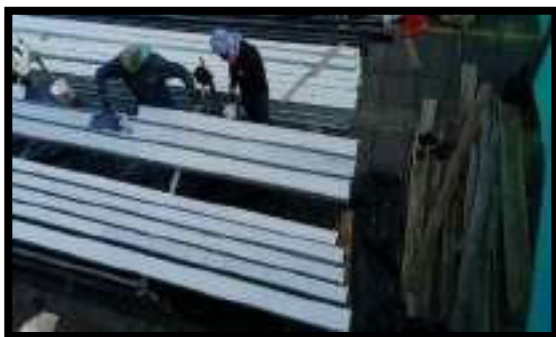
APLICACIÓN DE PINTURA DE PERFILES
