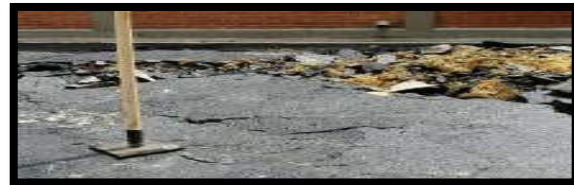
DEMOLICIÓN MANUAL DE PAVIMENTO ASFALTICO
