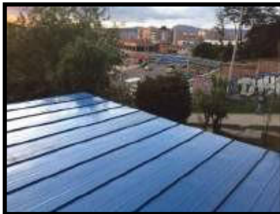
MONTAJE DE CUBIERTA TIPO SANDWICH
