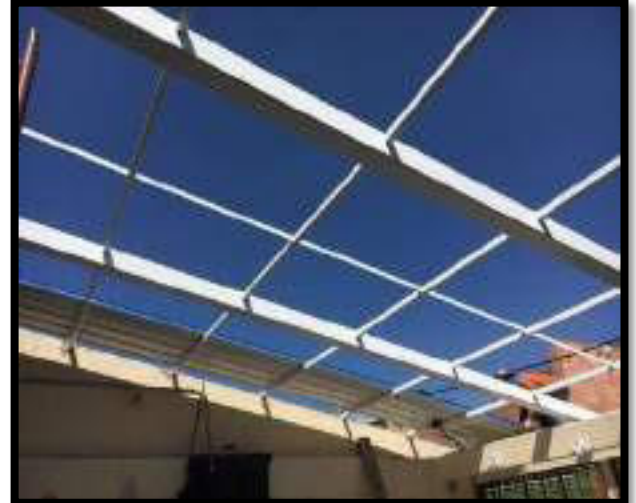
MONTAJE DE ESTRUCTURA PARA EL SOPORTE DE CUBIERTA
