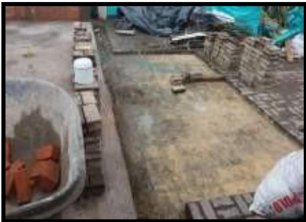
RETIRO DE ADOQUÍN EN CONCRETO
