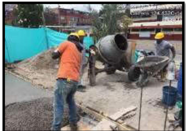
PREPARACIÓN DE MEZCLA DE CONCRETO
