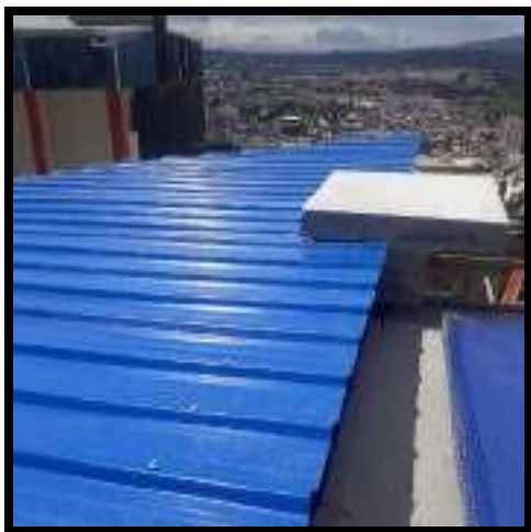
FINALIZA INSTALACIÓN DE CUBIERTA Y PLACA DE SOPORTE DE TANQUE
