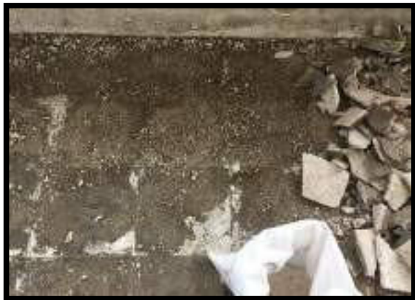
DEMOLICIÓN DE BALDOSA
