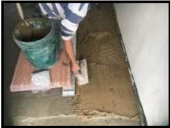
INSTALACIÓN DE ENCHAPE PISO
