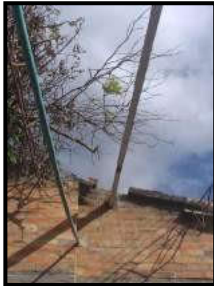
INSTALACION DE PLATINAS Y PERFILES
