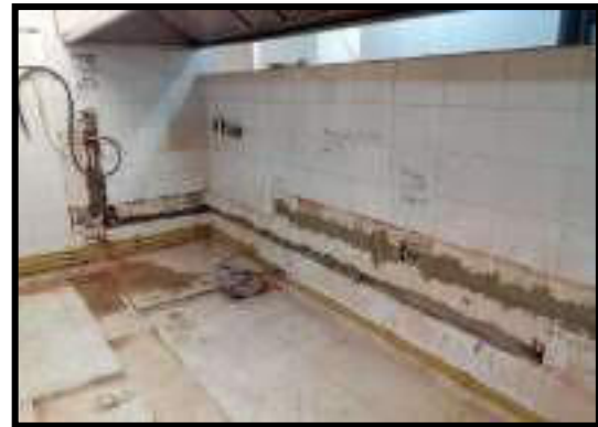
REPOSICION DE ENCHAPE PARED Y BALDOSA
