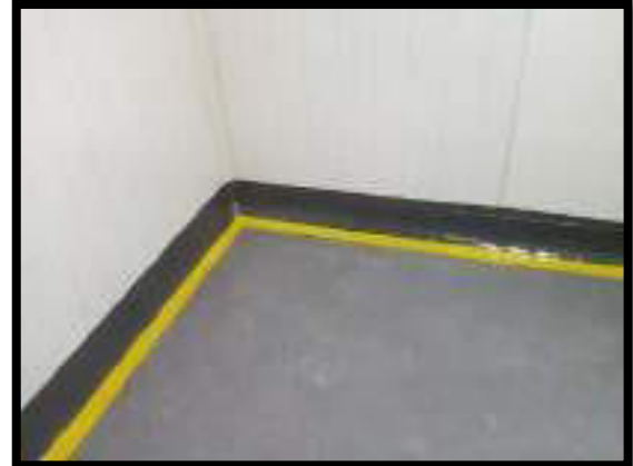
ACABADO FINAL CUARTOS FRIOS
