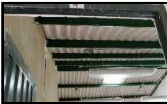
APLICACIÓN DE PINTURA PARA TEJAS EN CEMENTO
