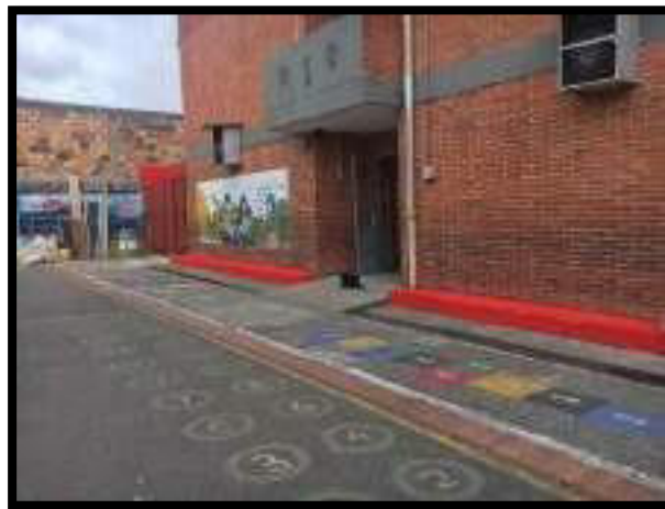
APLICACIÓN DE PINTURA DE GRADA EN ZONA DE CANCHAS
