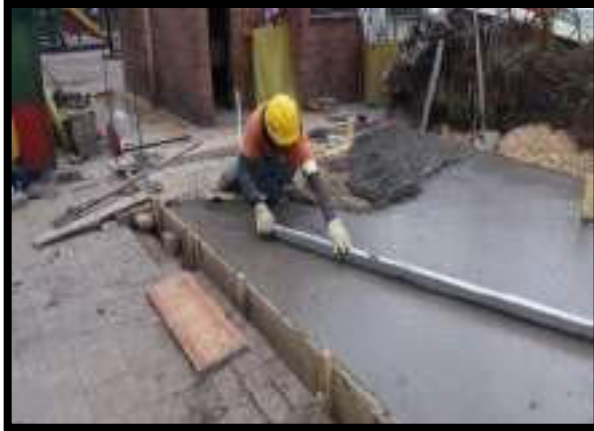
FUNDICIÓN DE PLACA EN CONCRETO
