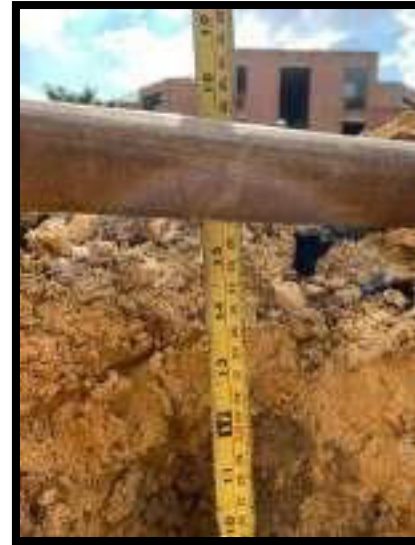
APIQUE A 0,40 CM REVISIÓN DEL SUELO
