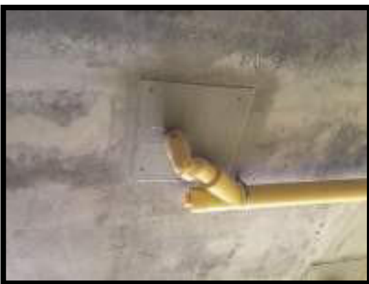
INSTALACION DE TAPAS EN DRYWALL
