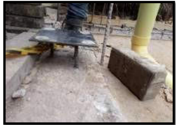
INSTALACIÓN DE PLATINAS EN VIGAS DE AMARRE
