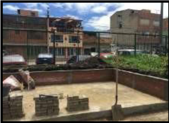
FUNDICIÓN DE PLACA EN CONCRETO
