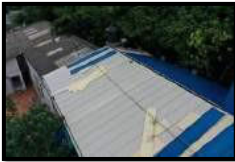
MONTAJE DE PANELES DE CUBIERTA TIPO SANDWICH
