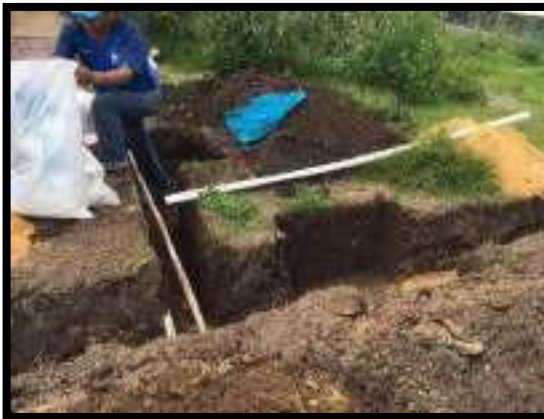
INSTALACIÓN DE RED DE SUMINISTRO PARA CONEXIÓN DE TANQUES
