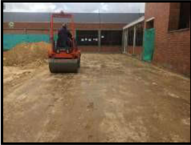
COMPACTACIÓN DE SUELO ZONA 1 Y 2
