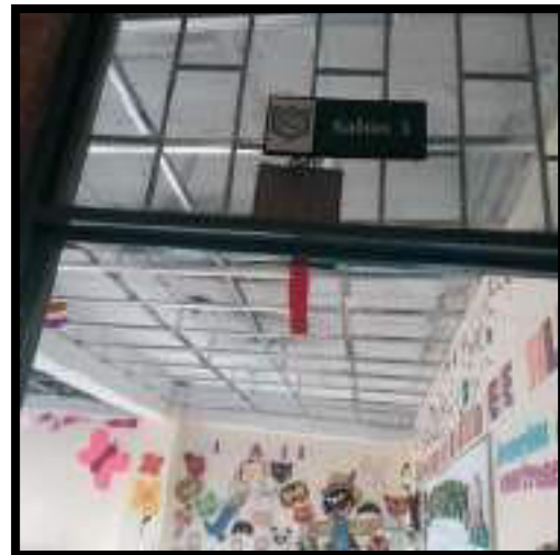
INSTALACION DE ESTRUCTURA PARA CIELO RASO EN SUPERBOARD
