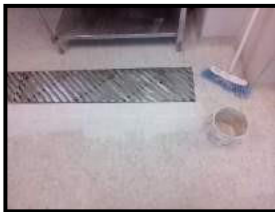
INSTALACION DE MARCO PARA REJILLA DE CARCAMO
