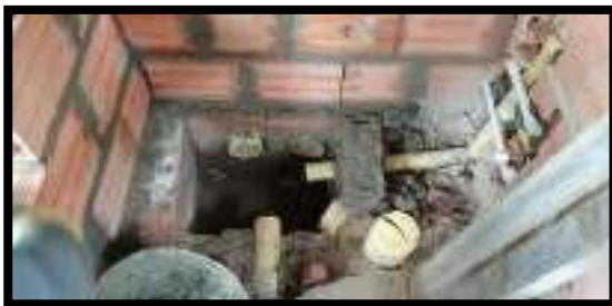
CONEXIÓN DE TUBERIAS A CAJA DE INSPECCION
