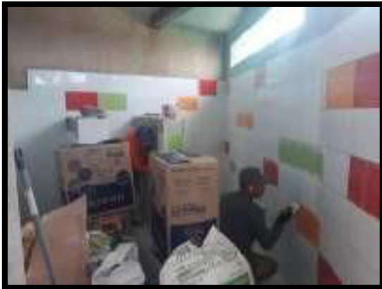
EMBOQUILLADO DE ENCHAPES PARA MUROS
