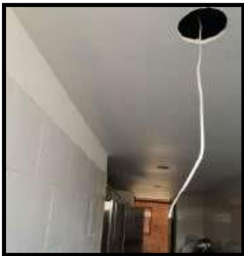
INSTALACION DE CIELO RASO EN PVC E ILUMINACION
