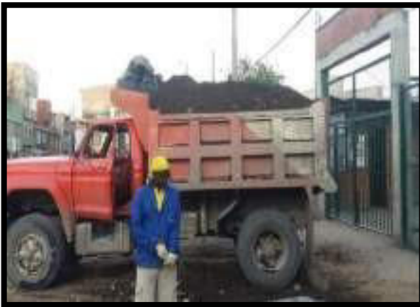
CARGUE MANUAL DE MATERIAL DE TIERRA
