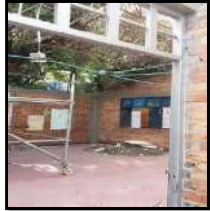
RETIRO DE CUBIERTA
