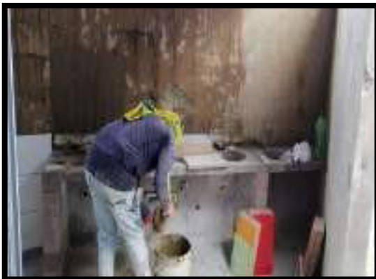
CONSTRUCCIÓN DE MESÓN PARA LAVAMANOS EN GRANITO
