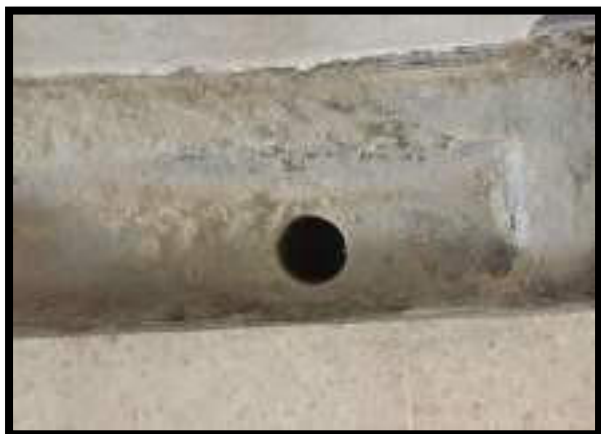
LIMPIEZA DE CÁRCAMO
