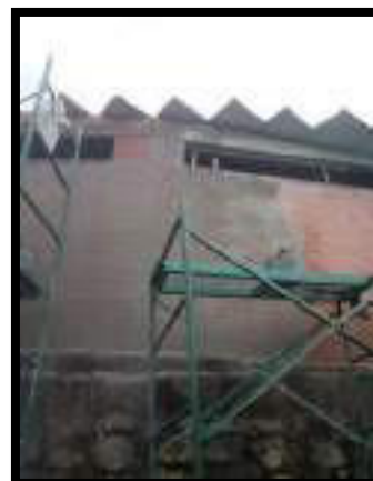
RE EMBOQUILLADA DE MURO EXTERIOR
