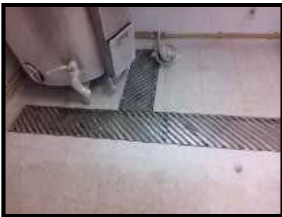
INSTALACION DE MARCO PARA REJILLA DE CARCAMO
