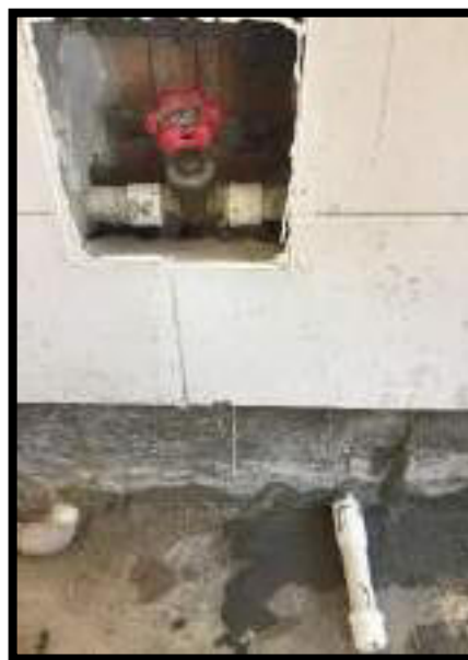
ADECUACIÓN REGISTRO Y PUNTO HIDRÁULICOS
