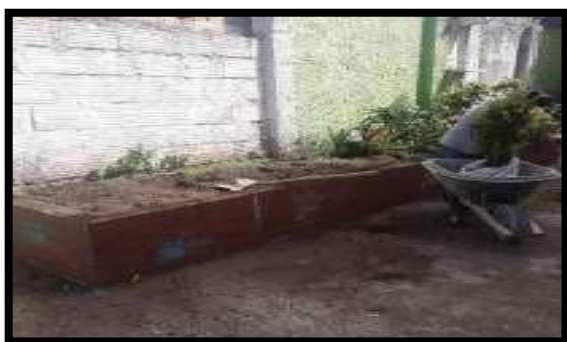
RETIRO DE SIEMBRA, Y DEMOLICIÓN DE JARDINERA
