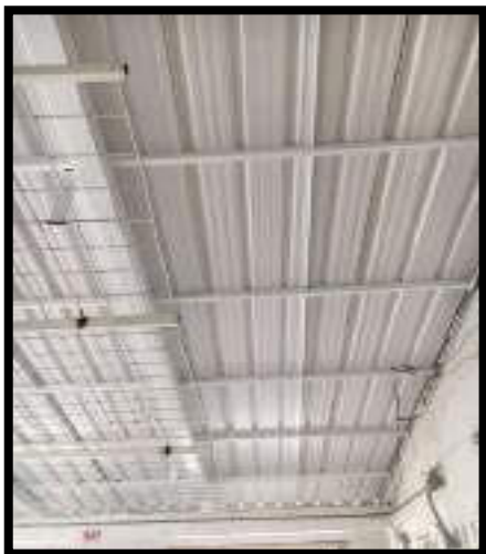
INSTALACIÓN DE TEJA TIPO UPVC EN SALÓN DE SISTEMAS
