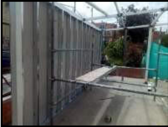
INSTALACION DE SUPERBOARD
