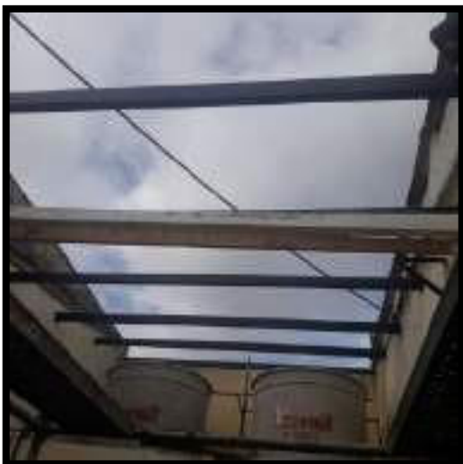
DESMONTE DE CUBIERTA Y PERFILERÍA EXISTENTE EN ZONA DE ESCALERAS
