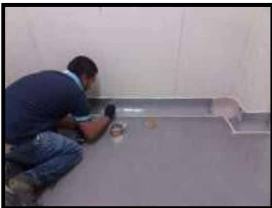
IMPERMEABILIZACION CUARTOS FRIOS
