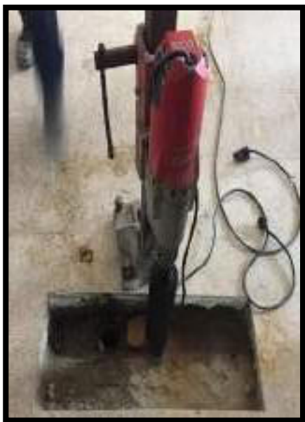
PERFORACIÓN CON TALADRO SACANUCLEO
