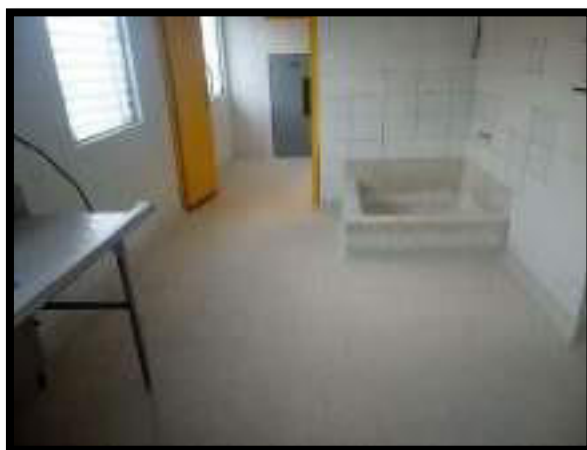
FINALIZACION DE ACTIVIDADES AREA DE LAVADO
