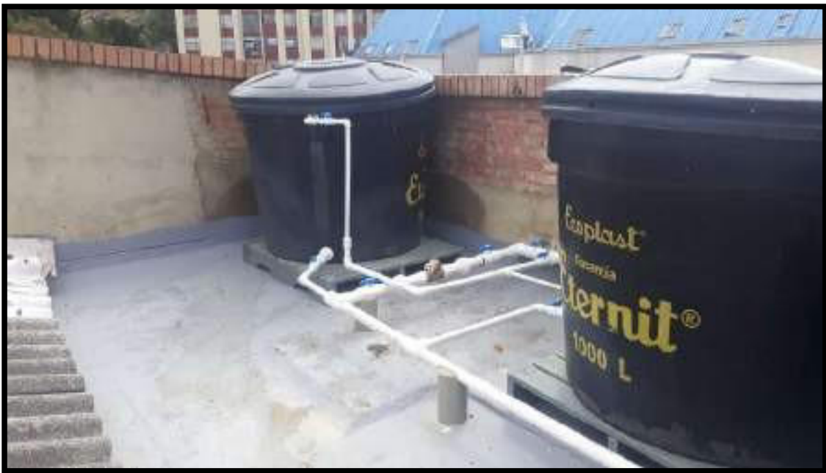
INSTALACIÓN REDES TANQUES
