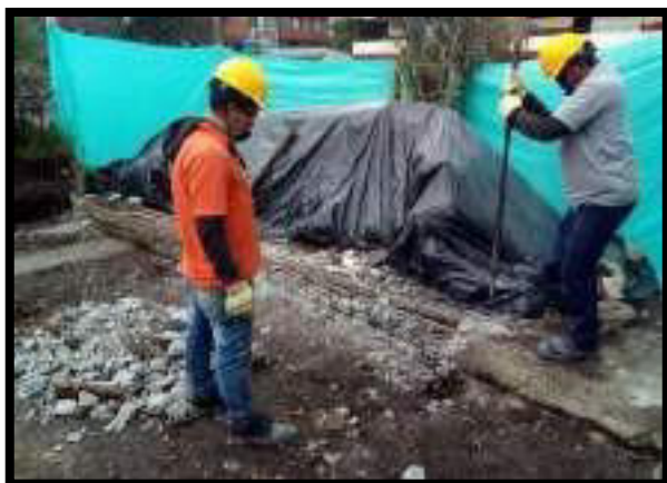
DEMOLICIÓN DE VIGAS DE AMARRE
