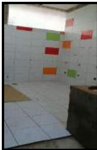
INSTALACIÓN DE ENCHAFE PARA MURO Y PISO
