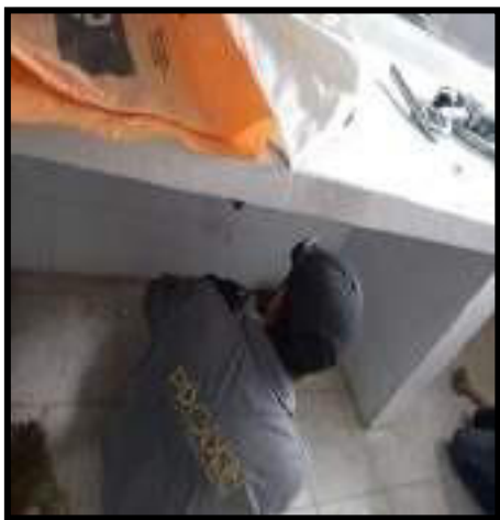
DESMONTE DE APARATOS SANITARIO
