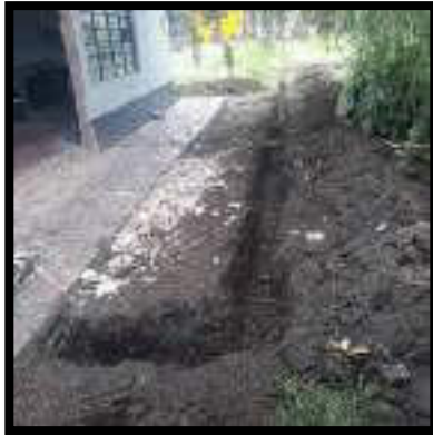
INICIO DE EXCAVACIÓN PARA ACOMETIDA
