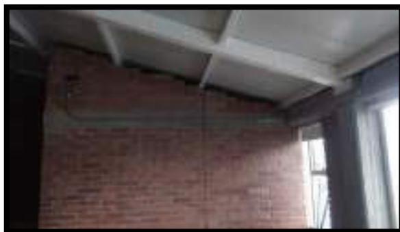
INSTALACIÓN DE TUBERIA EMT PARA RED ELECTRICA
