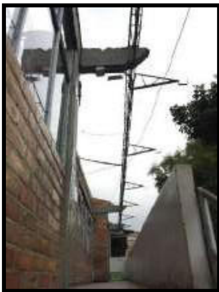
DESMONTE CUBIERTA DE ASBESTO
