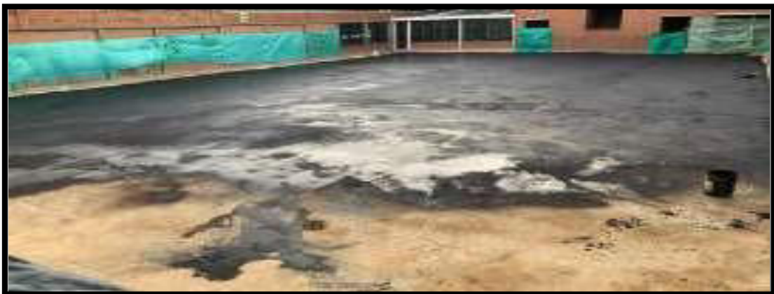
IMPRIMACIÓN DE EMULSIÓN ASFALTICA
