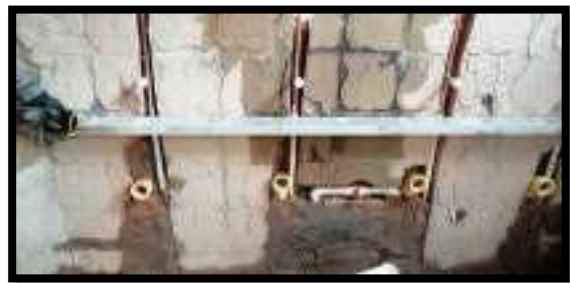
NIVELACION DE PUNTOS PARA LAVAMANOS
