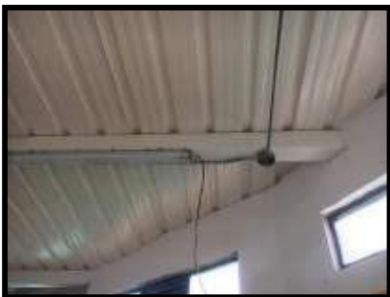
INSTALACIÓN DE LUMINARIAS Y RED ELECTRICA EN EMT
