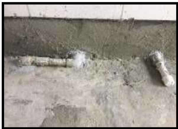
APLICACIÓN DE SELLO EN TUBERÍAS HIDRÁULICAS
