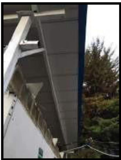
MONTAJE DE CUBIERTA TIPO SANDWICH Y DESMONTE DE CUBIERTA CANALETA 90
