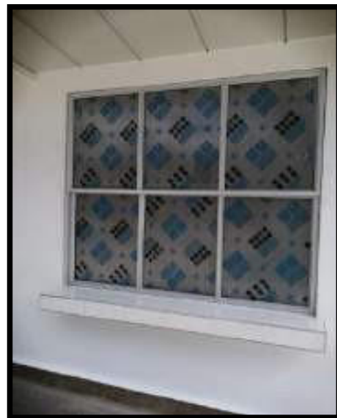
INSTALACIÓN DE VENTANA EN POLICARBONATO
