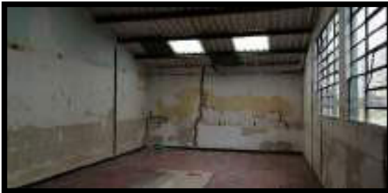
CAMBIO DE TEJAS DAÑADAS
