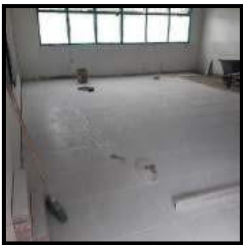
INSTALACIÓN DE MEDIAS CAÑAS PERIMETRALES
