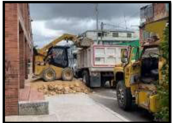
RETIRO DE MATERIAL DE RELLENO
