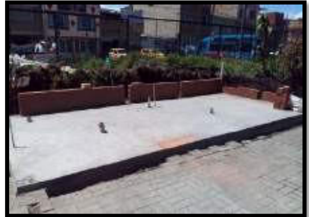
INSTALACIÓN DE MURO EN BLOQUE MACIZO
