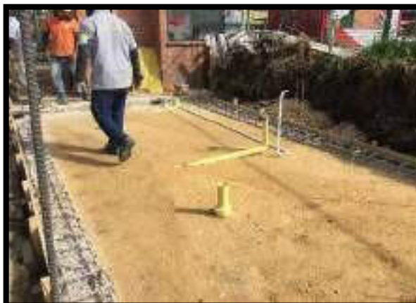
INSTALACIÓN DE REDES
