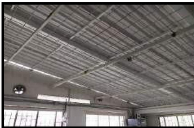
INSTALACIÓN DE TEJA TIPO UPVC EN SALÓN DE SISTEMAS
