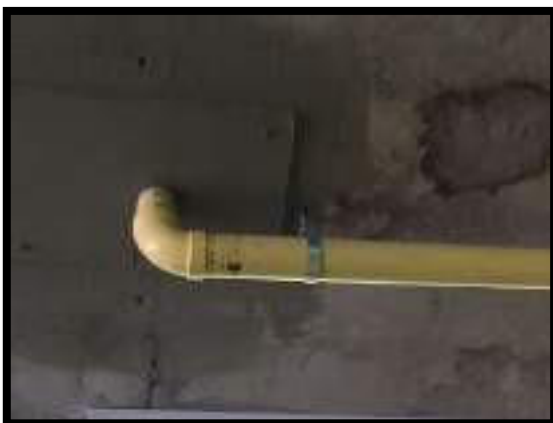
REPOSICION DE TUBERIA HIDROSANITARIA
