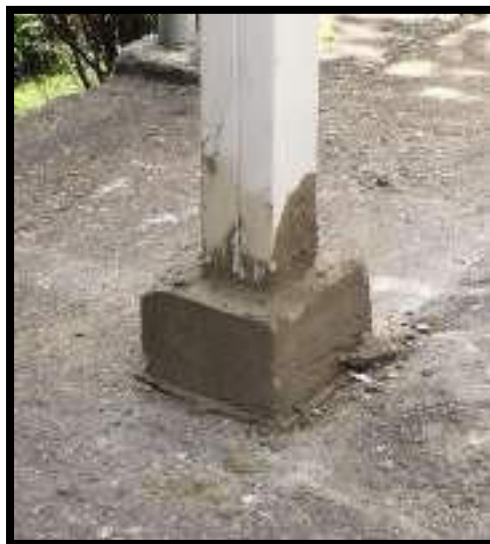
CONSTRUCCIÓN DE PEDESTALES PARA PORTICOS
