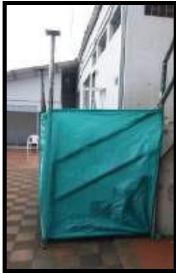
REFUERZO DE CERRAMIENTO CON PARALES METALICOS
