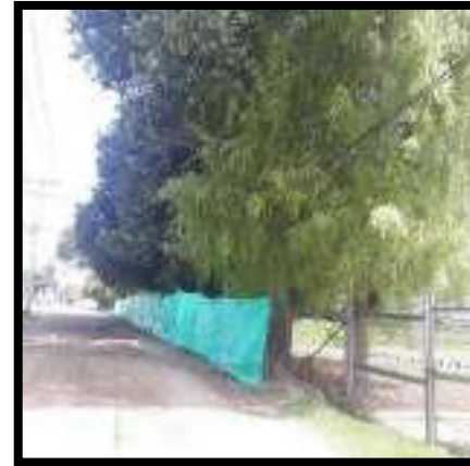
CERRAMIENTO Y LIMPIEZA DE ÁREA DE INTERVENCIÓN
