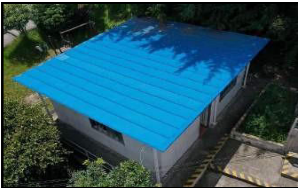
ACABADO FINAL CUBIERTA ISLA
