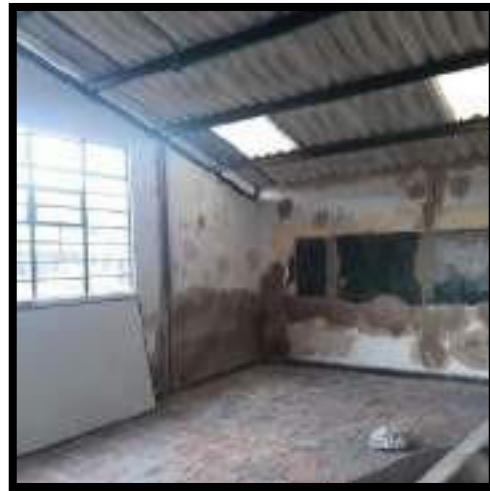
RESANE Y DILATACIONES DE FISURAS EN MUROS
