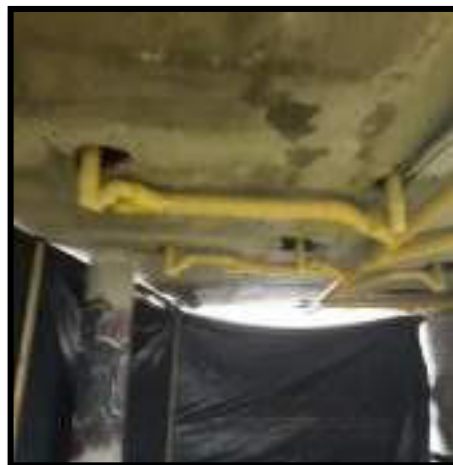
REPOSICION DE TUBERIA SANITARIA
