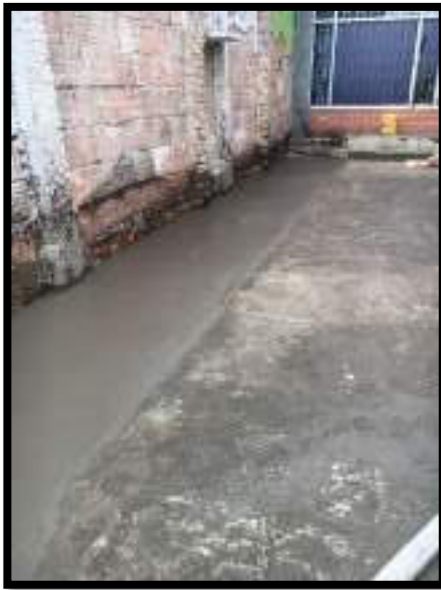
FUNDICIÓN DE PLACA Y NIVELACIÓN DE PISO
