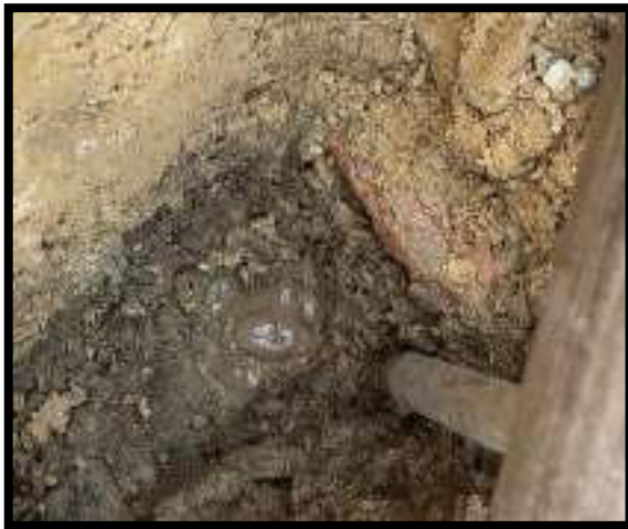
VERIFICACIÓN DEL RECEBO HUMEDO
