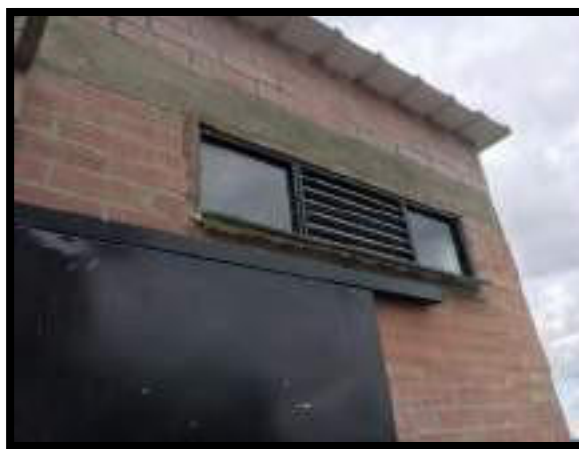
INSTALACIÓN DE VIDRIOS PARA VENTANEÍA
