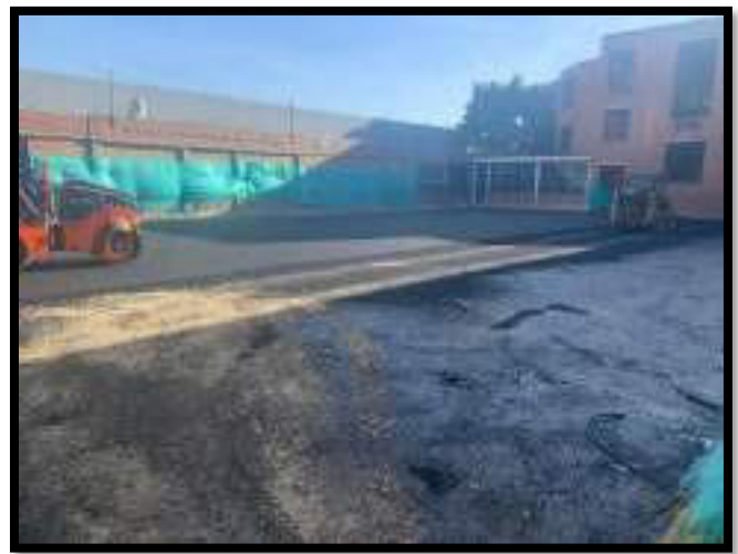
COMPACTACIÓN DE ASFALTO
