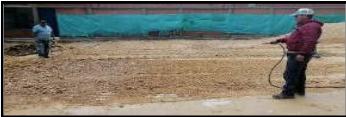
HUMECTACIÓN DE MATERIAL B600
