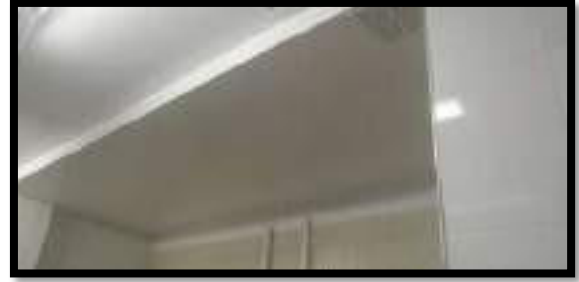
PINTURA DE TECHO EN COCINA
