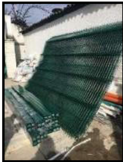
INGRESO DE MATERIAL DE CERRAMIENTO
