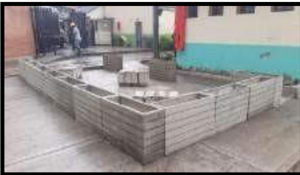
INSTALACION DE MATERAS Y BANCAS EN CONCRETO
