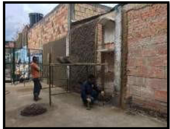
REPOSICIÓN DE PAÑETE EN MUROS
