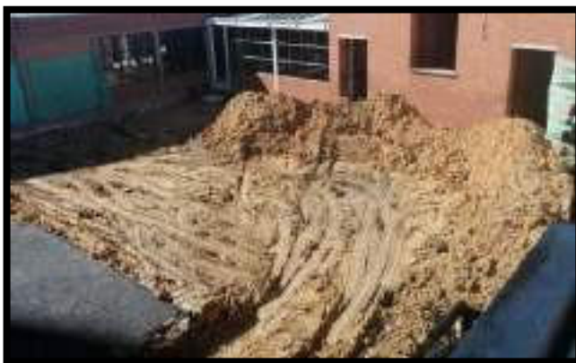
EXCAVACIÓN MECANICA EN ZONA 1 Y 2
