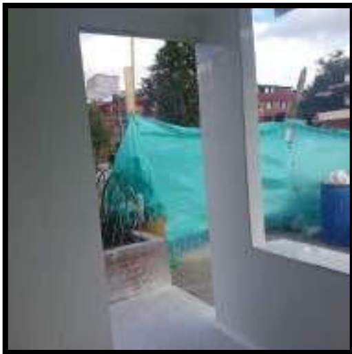
PINTURA Y RESANES EXTERIORES
