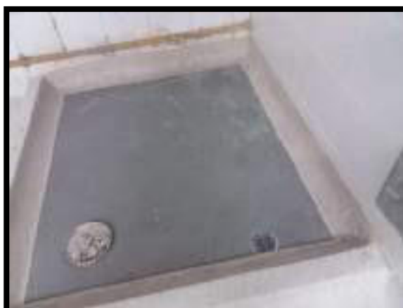
APLICACIÓN DE MATERIAL IMPERMEABILIZANTE- ARREGLOS ZONA DE MARMITA
