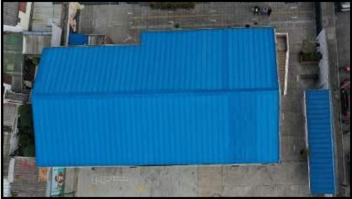
VISTA SUPERIOR CUBIERTA
