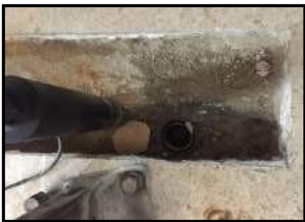
PERFORACIÓN CON TALADRO SACANUCLEOS
