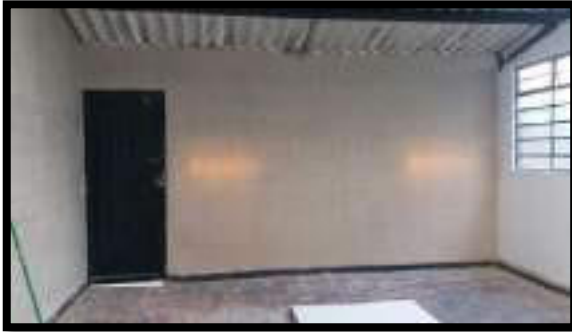
PRIMERA CAPA DE PINTURA EN MURO
