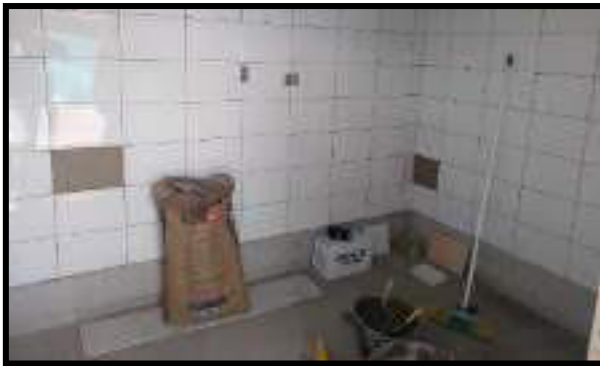
INSTALACION DE ENCHAFE PARED
