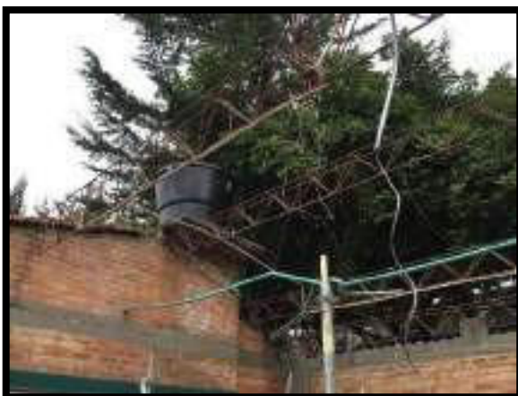
DESMONTE CUBIERTA DE ASBESTO
