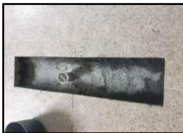
IMPERMEABILIZACIÓN DE CÁRCAMO
