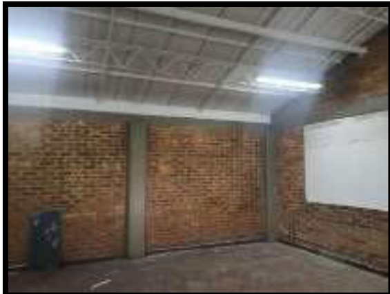
INSTALACIÓN DE LÁMINA DE SUPERBOARD EN LOS REMATES DE MURO CON CUBIERTA
