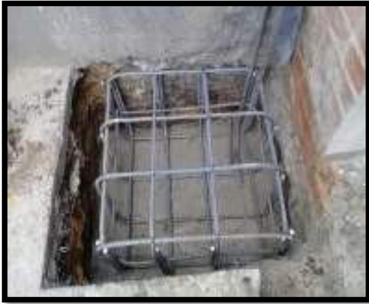
ARMADO DE ZAPATA
