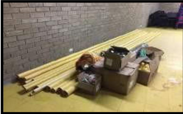
ACOPIO DE MATERIAL DE OBRA
