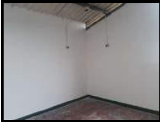
ACABADO FINAL DE MUROS (3 MANOS DE PINTURA)
