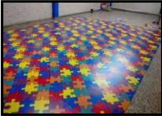
INSTALACIÓN DE TAPETE LUDICO EN BIBLIOTECA
