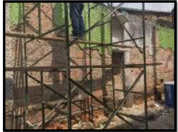
DEMOLICIÓN DE ENCHAPE MURO
