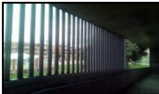
INSTALACION DE TUBERIA EN VANO
