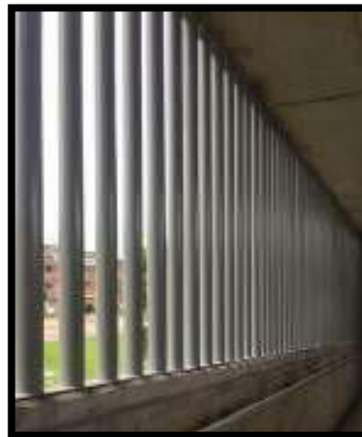
FINALIZA PINTURA DE TUBERIA
