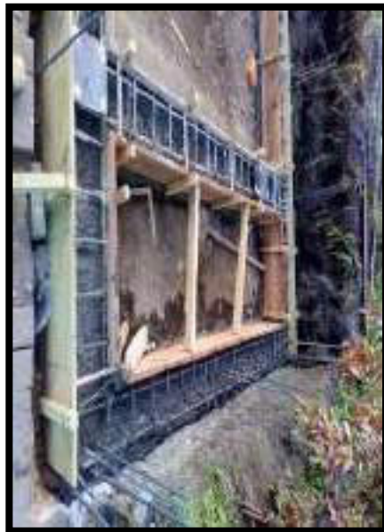
FUNDICIÓN DE VIGAS DE AMARRE
