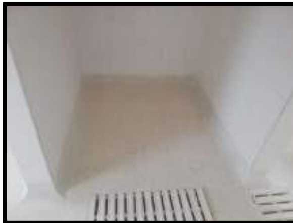
ACABADO DE PISO GRANITO Y MEDIA CAÑA PULIDA
