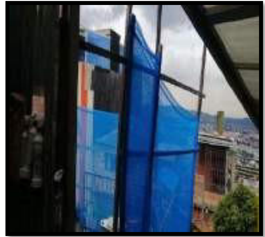
INSTALACION DE CERRAMIENTO
