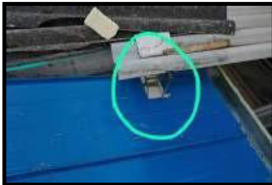
CORTES EN SITIO DE PANEL DE CUBIERTA
