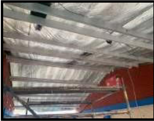
FINALIZA INSTALACIÓN ESTRUCUTURAL
