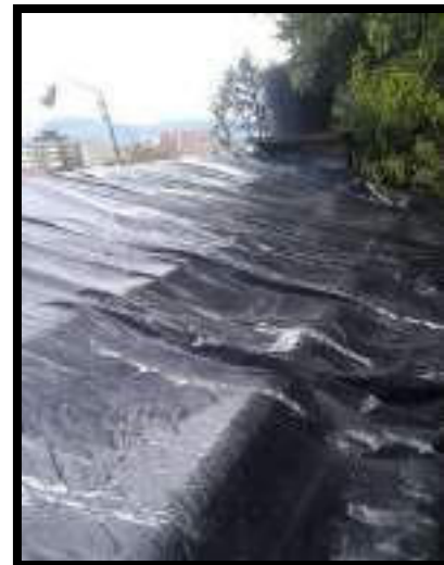
RECUBRIMIENTO DE CUBIERTA CON PLASTICO
