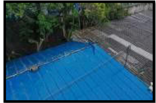
MONTAJE DE PANELES DE CUBIERTA TIPO SANDWICH
