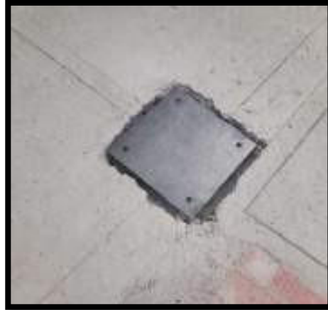
INSTALACIÓN DE PLATINAS PARA MONTAJE DE POSTES
