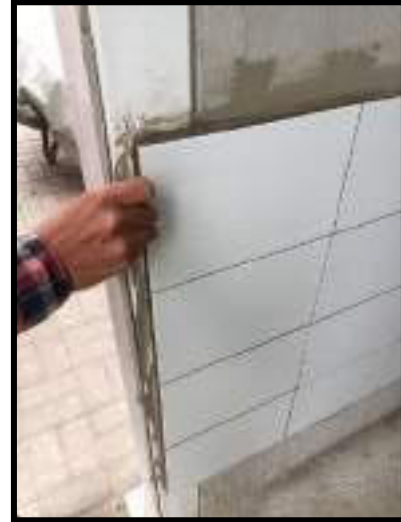
INSTALACION DE ENCHAPE PARED
