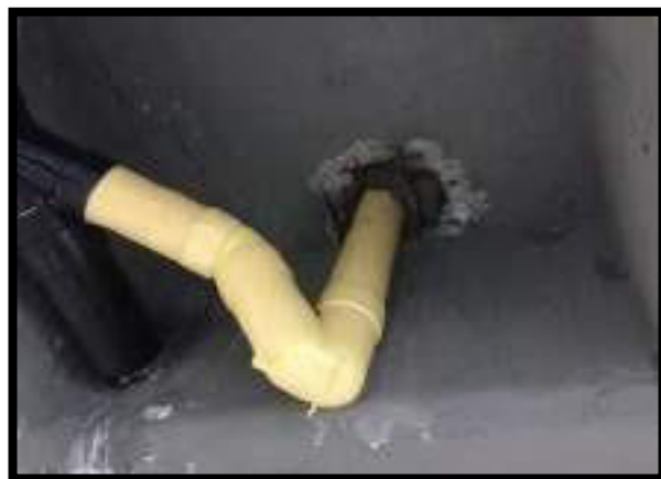
ADECUACIÓN PUNTO DE DESAGUE
