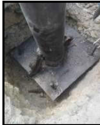
INSTALACIÓN DE PLATINAS PARA MONTAJE DE POSTES
