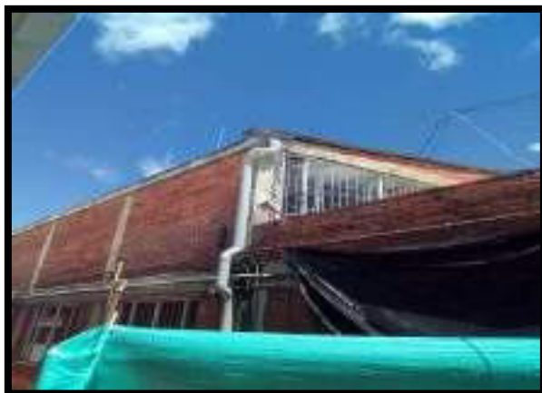
TRASLADO DE BAJANTE ALL 4"
