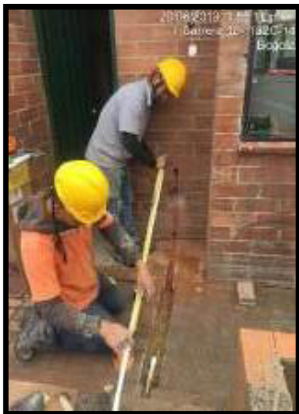
CORTES DE MURO Y PLACA – INSTALACIÓN DE RED
