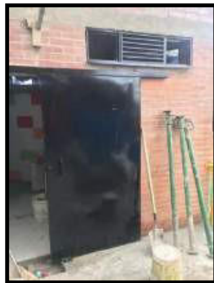
INSTALACIÓN DE PUERTA CORREDIZA METALICA Y VENTANERÍA
