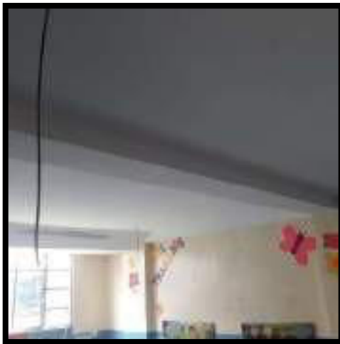
PINTURA DE CIELO RASO EN SUPERBOARD
