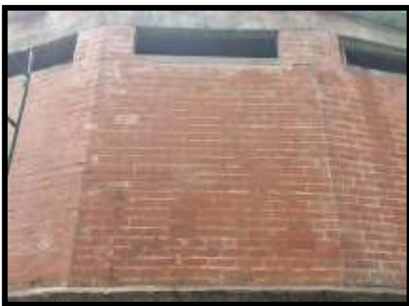
REPOSICIÓN DE PIEZA DAÑADAS EN MURO
