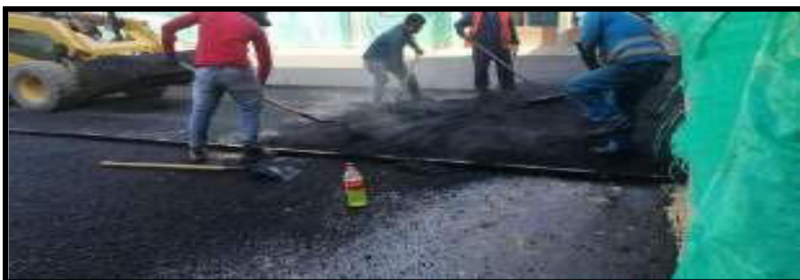
EXTENDIDO DE ASFALTO
