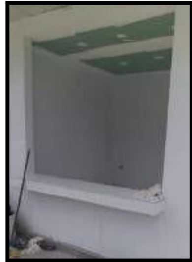
INSTALACION DE CIELO RASO EN SUPERBOARD
