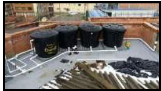
PRUEBA Y LLENADO DE TANQUES DE ALMACENAMIENTO
