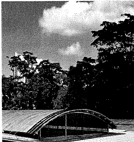
DESMONTE DE CUBIERTA POLICARBONATO
