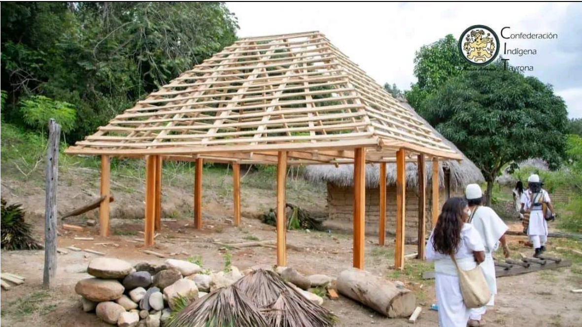
Ilustración 1 - Construcción típica de la zona
