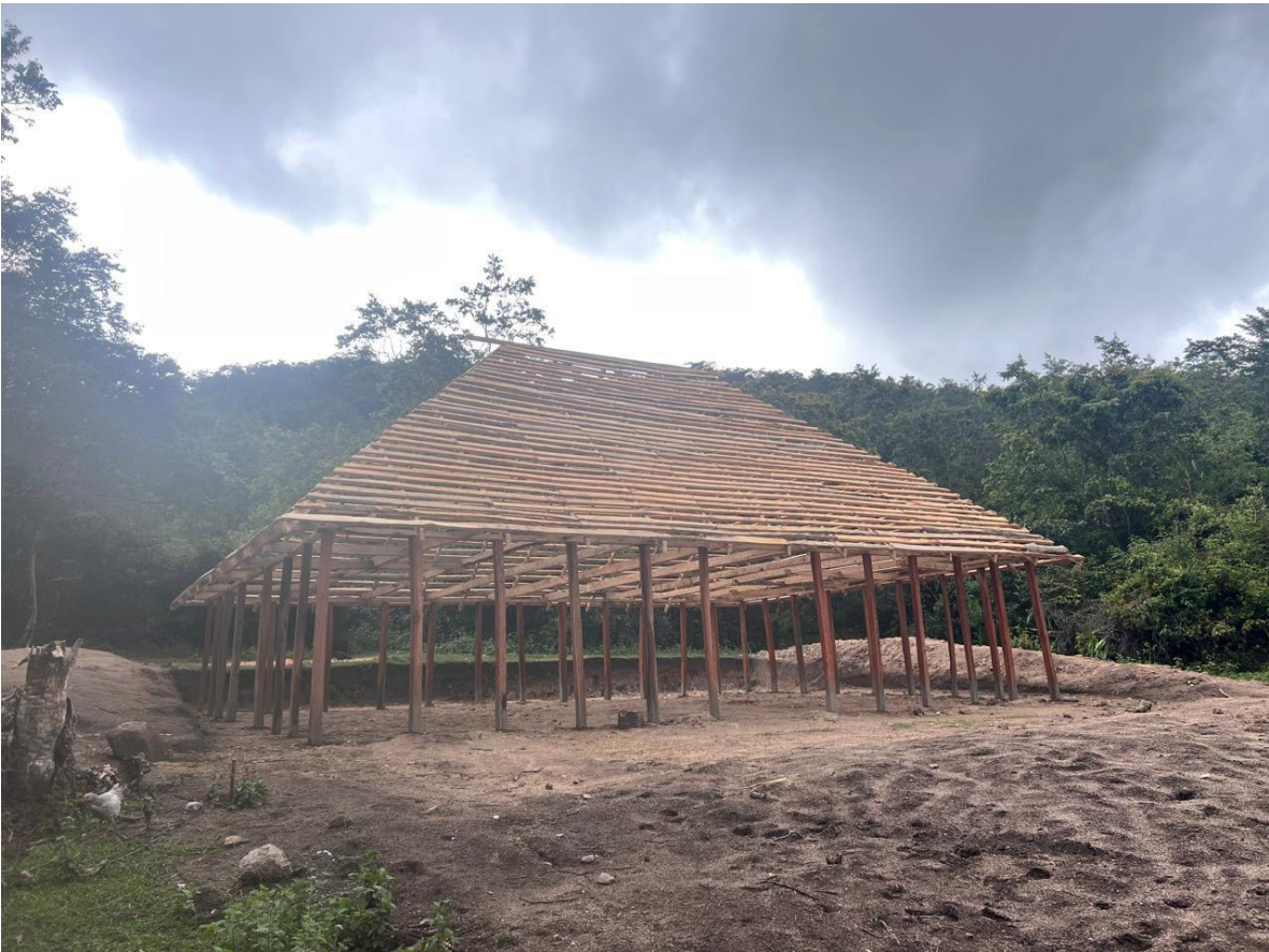
Ilustración 2 - Construcción típica de la zona
