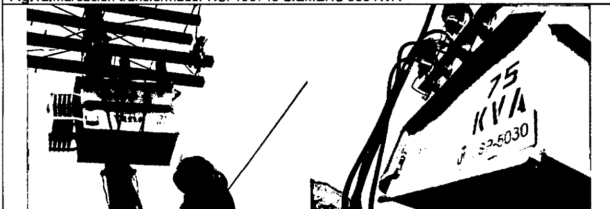
Fig.13.Marcación transformador NS: 5030815 TESLA 75 KVA
