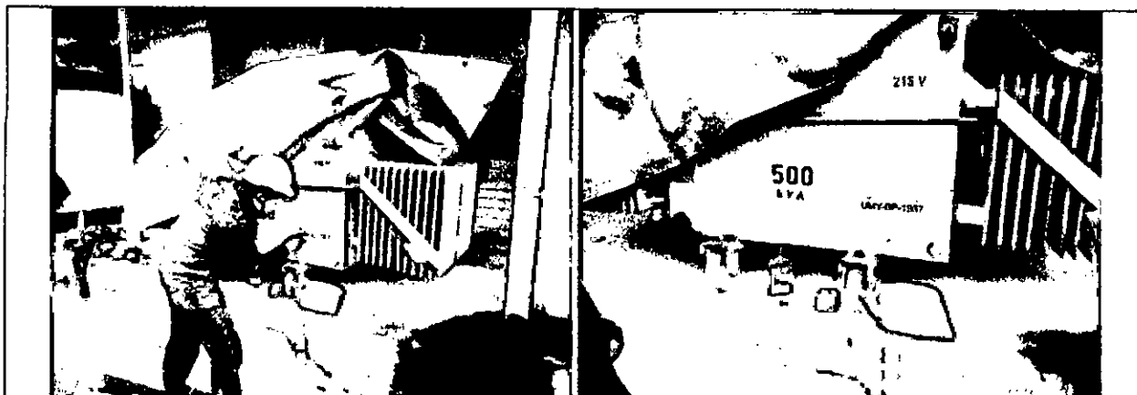
Fig.12.Marcación transformador NS: 196740 SIEMENS 500 KVA
