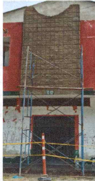
Resane con revoque homogéneo liso con mortero de dosificación 1:4
