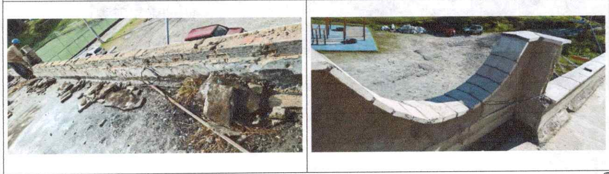
Retiro de lagrimales en mal estado e instalación de lagrimales nuevos
