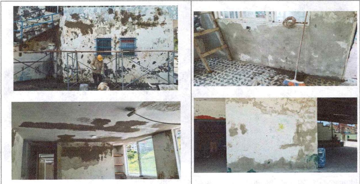
Revoque homogéneo liso con mortero de dosificación 1:4 e impermeabilizado con aditivo tipo sika
