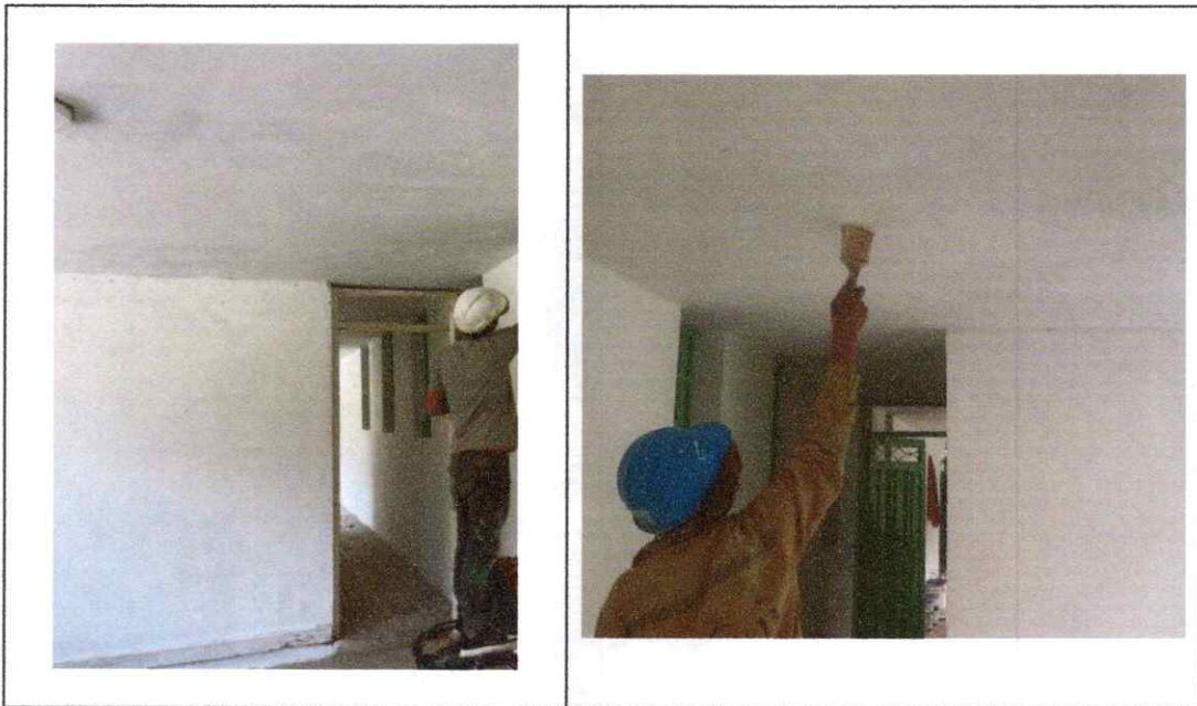
ONP 2. Suministro, transporte y aplicación a tres manos de pintura tipo 1 base agua en paredes interiores de salones segundo piso:
