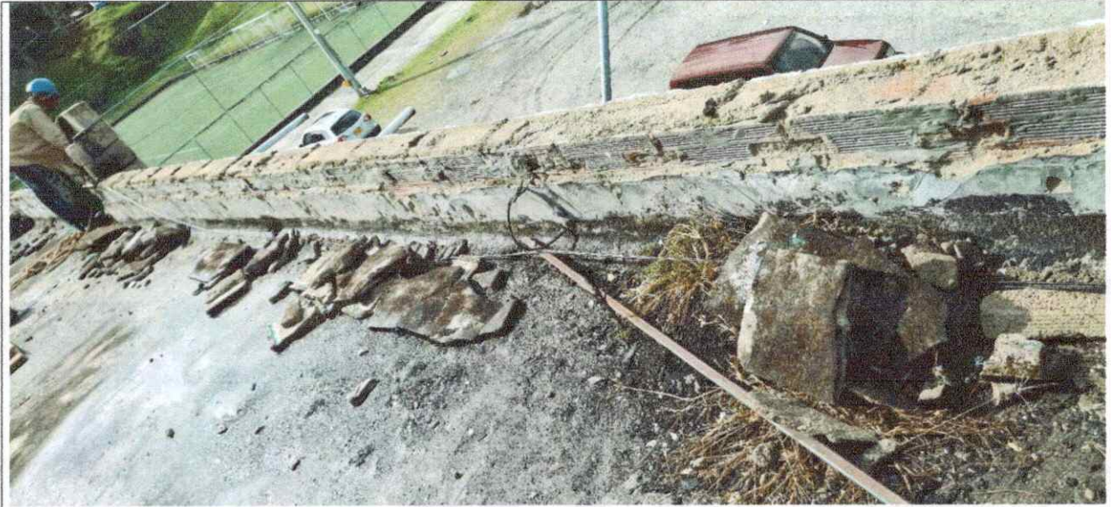
Limpeza de muro en fachada, en bloque de concreto, y aplicación de hidrófugo
