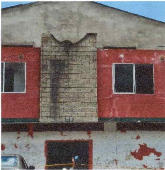
Resane con revoque homogéneo liso con mortero de dosificación 1:4
