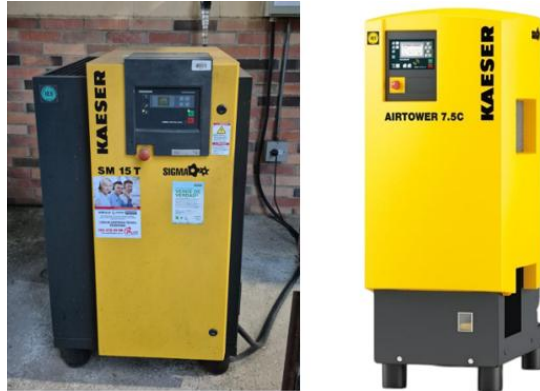
Figura 1 Compresores marca Kaeser. A la izquierda: Compresor KAESER de Tornillo SM 15 T; a la derecha: Compresor KAESER de Tornillo Airtower 7.5C.
