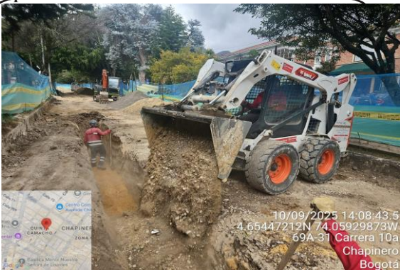
FRENTE DE OBRA: CALLE 70
