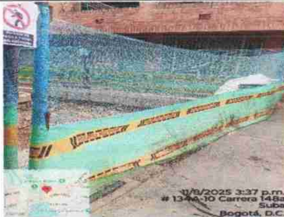
Imagen 1. Mantenimiento Cerramiento CIV 3330
