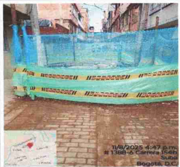
Imagen 2. Mantenimiento Cerramiento CIV 3471
