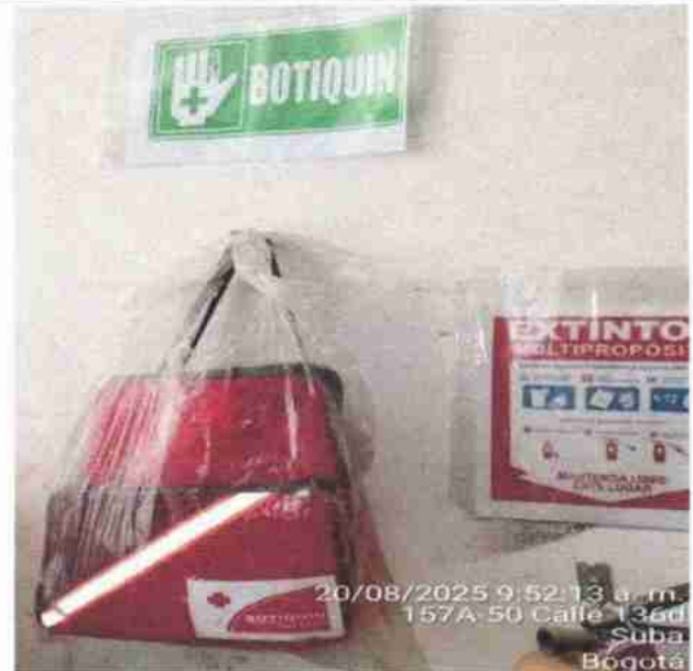
Imagen 26. Elementos de emergencia villa Cindy CIV 4209
