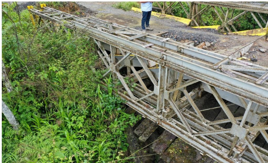
Fotografía 1. ESTRUCTURA METALICA – PUENTE PUERTO CONEJO
