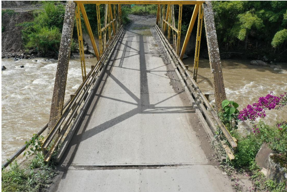
Fotografía 2. ESTRUCTURA METALICA - PUENTE MARIANO OSPINA
