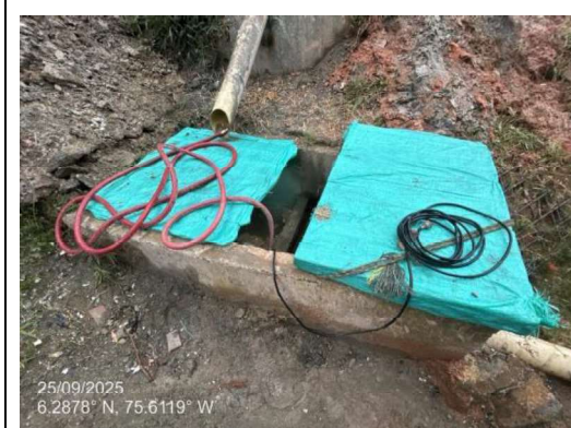
Fotografía 5. Sistema de lavado de llantas con recirculación de agua.
