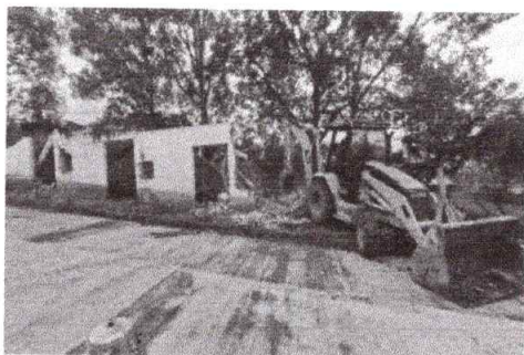
DEMOLICIÓN DE PLACA DE PISO EN CONCRETO DE E = 10 CM. (INCLUYE RETIRO Y ACARREO LIBRE HASTA 5 KM.)
