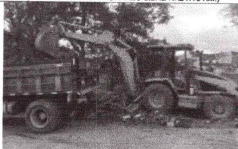
DEMOLICIÓN OBRAS EN CONCRETO SIMPLE, INCLUYE CARGUE Y RETIRO DE SOBANTES CON ACARREO LIBRE HASTA 5 KM.).
