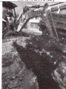
MEJORAMIENTO DE PISO CON MATERIAL DE AFIRMADO COMPACTADO CON PLANCHA VIBRADORA. (INCLUYE ACARREO LIBRE HASTA 5
