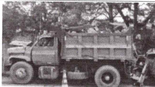
EXCAVACIÓN DE CORTES Y CANALES SIN CLASIFICAR (INCLUYE ACARREO LIBRE HASTA 5 KM.)
