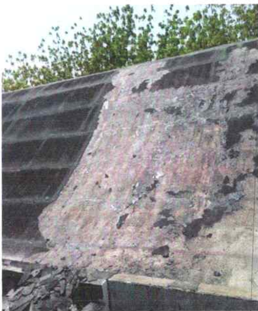
Impermeabilización con manto asfáltico (Antes)
