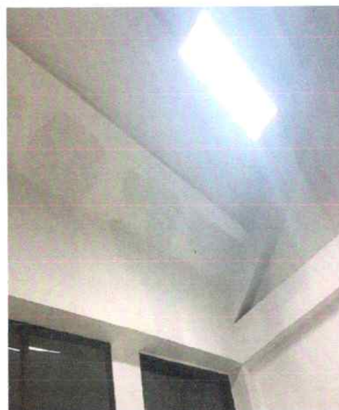
Estado de los muros ( Después)
