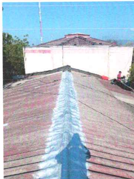
Caballote de la cubierta en Eternit (Después)
