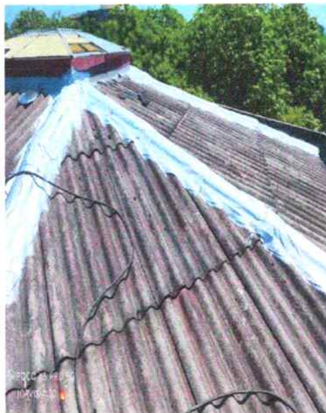
Caballetes de cubierta en Eternit (Después)
