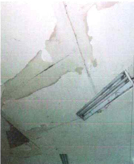
Cielo raso y luminarias (Antes)
