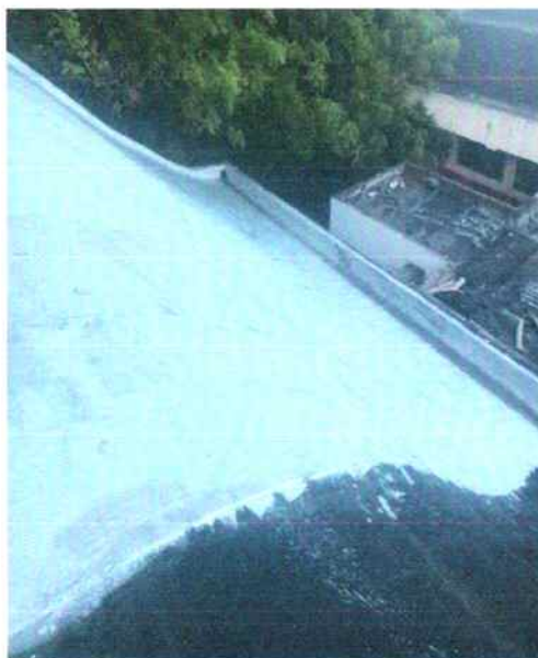
Impermeabilización con manto asfáltico ( Después)
