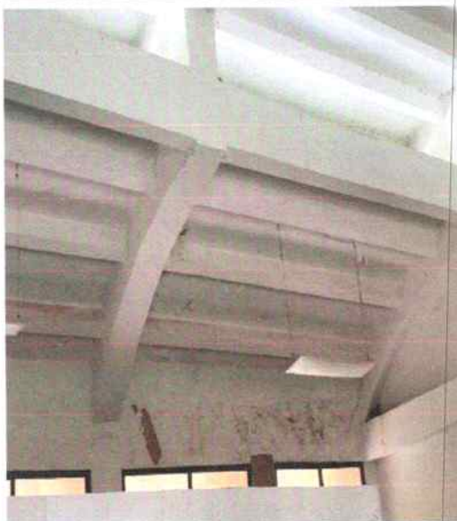
Estado de los muros (Antes)
