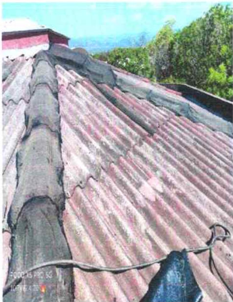
Caballetes de cubierta en Eternit (Antes)
