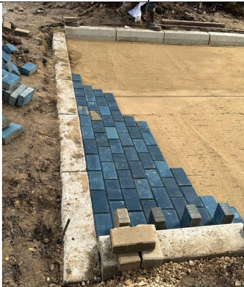
Instalación adoquines - prueba
