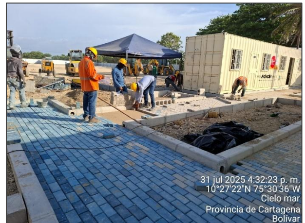
Instalación de adoquines en campamento
