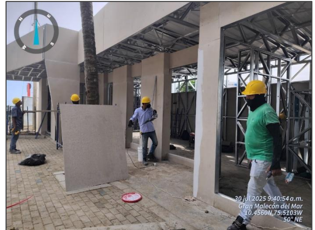
Construcción del campamento
