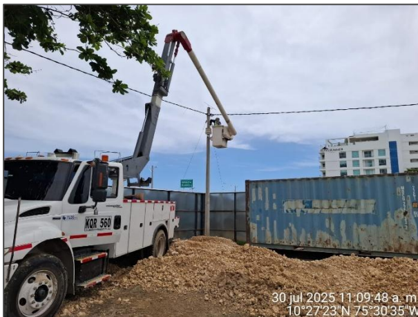
Instalación del provisional de energía
