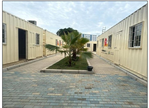
Contenedores de oficinas
