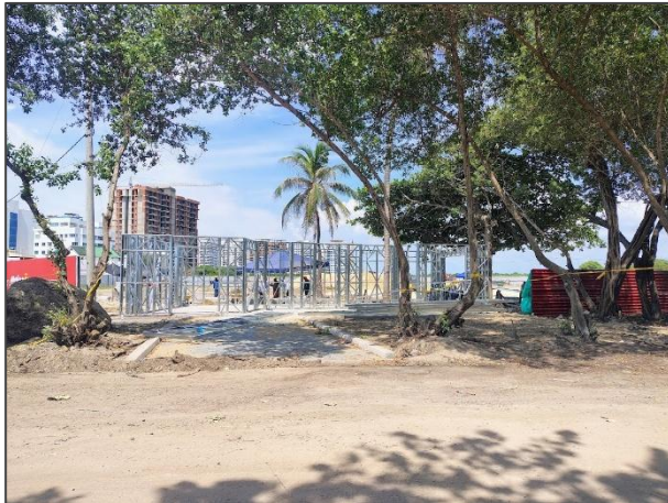
Construcción del campamento
