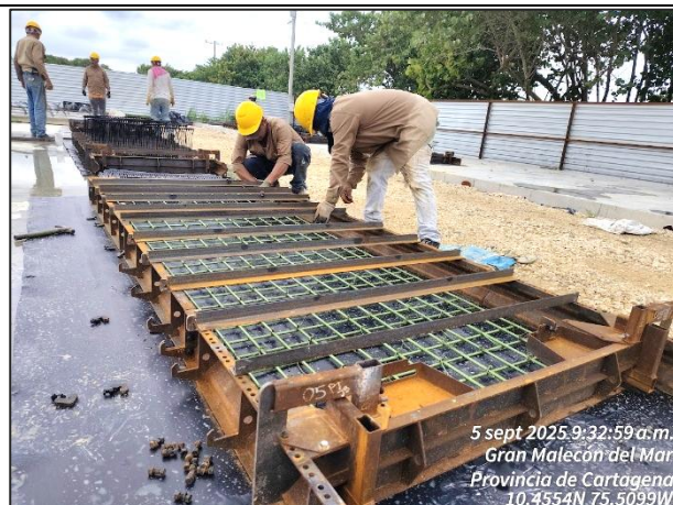
Armado de formaletas típicas
