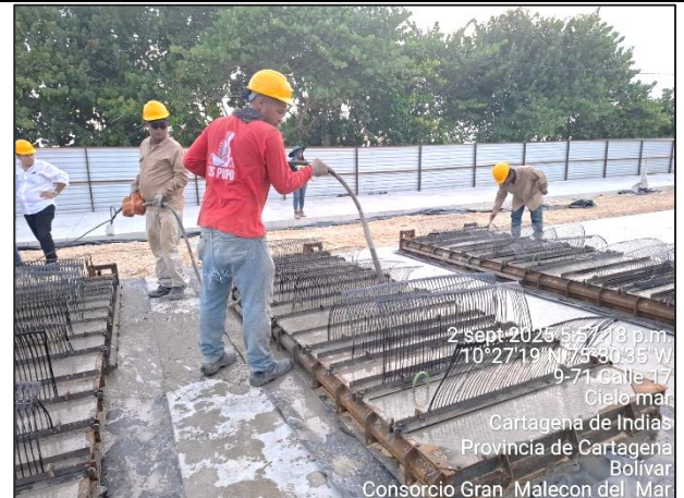
Fundida y proceso de vibrado de paneles
