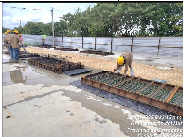
Armado de formaletas para muro
