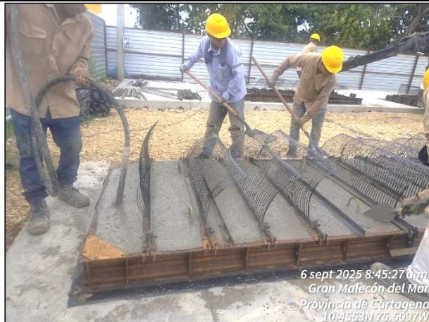
Fundida y proceso de vibrado de paneles
