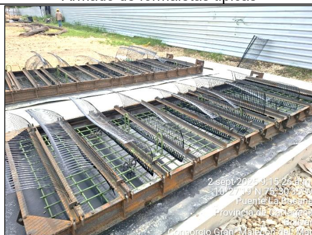
Armado de formaletas típicas
