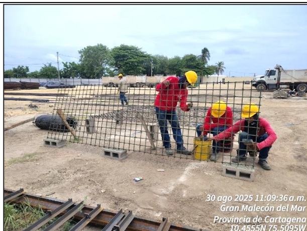
Aplicación de pintura epóxica de parrillas
