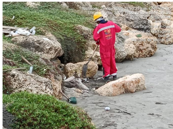
Orden y aseo tramo bocana
