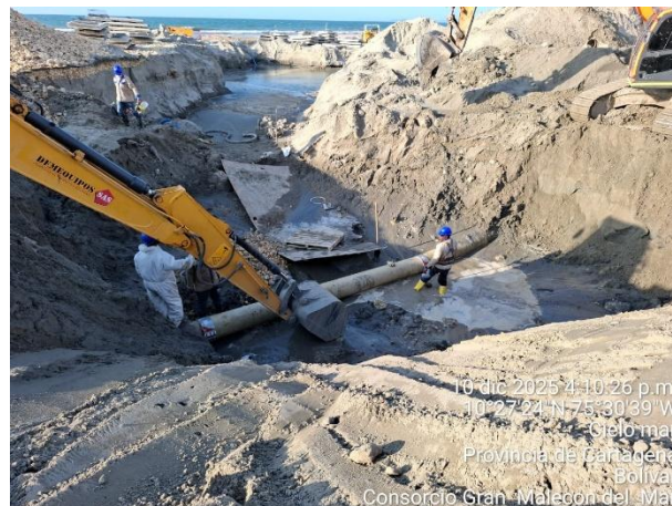
Arreglo de tubería de 16"
