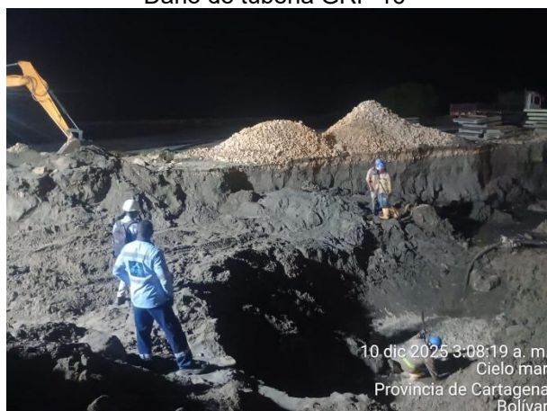
Arreglo de tubería de 16"
