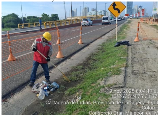
Orden y aseo cuneta en mirador del sol
