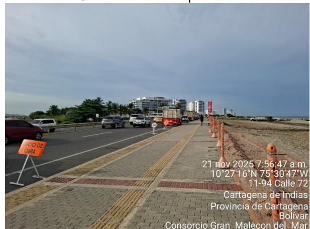
Señalización y cerramiento en el tramo bocana
