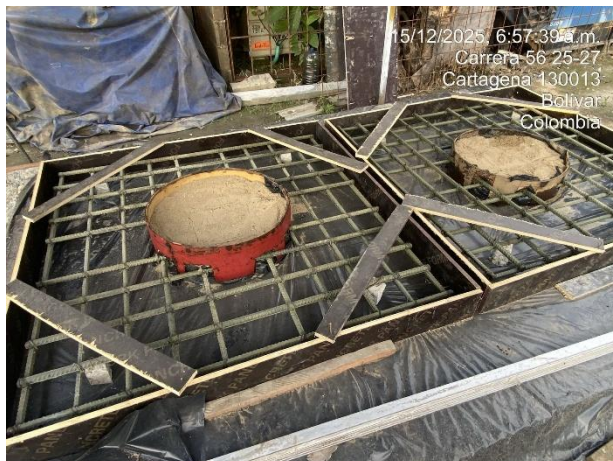
Armado de la formaleta capiteles
