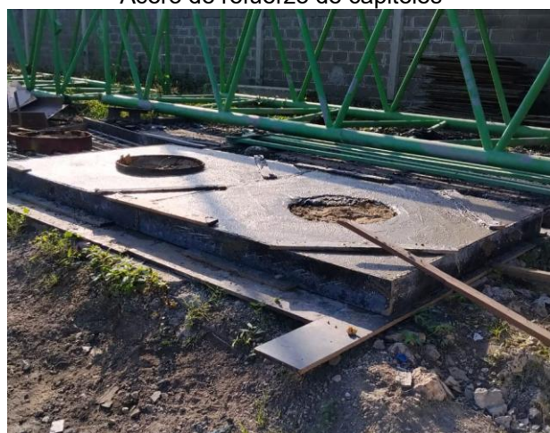
Construcción de capiteles
