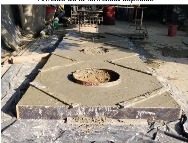
Construcción de capiteles
