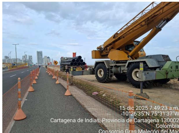
Señalización – sendero peatonal
