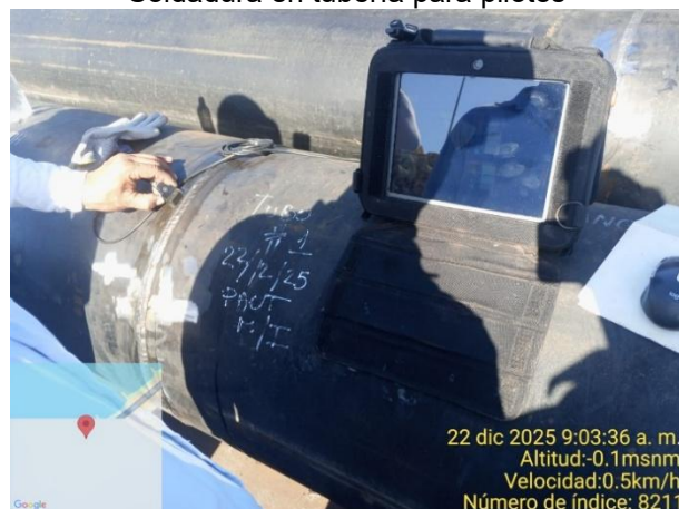
Pruebas PAUT a soldadura de tubería de pilotes
