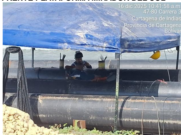
Soldadura en tubería para pilotes
