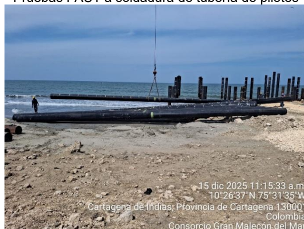
Izaje de tubería
