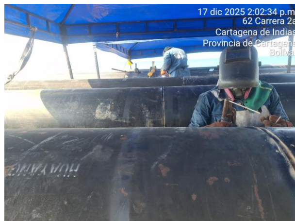
Soldadura en tubería para pilotes
