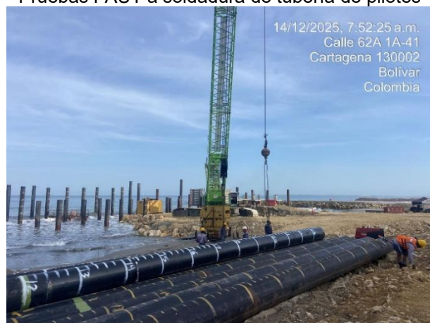
Acopio de tubería para pilotes
