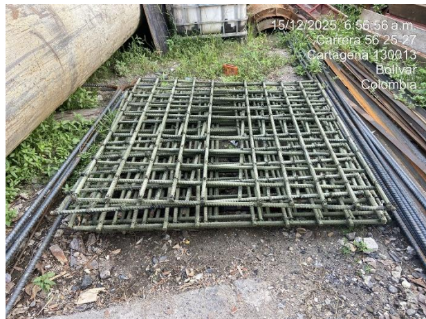
Acero de refuerzo de capiteles
