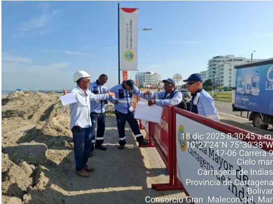
Inspección Aguas de Cartagena por tubería existente encontrada en sitio
