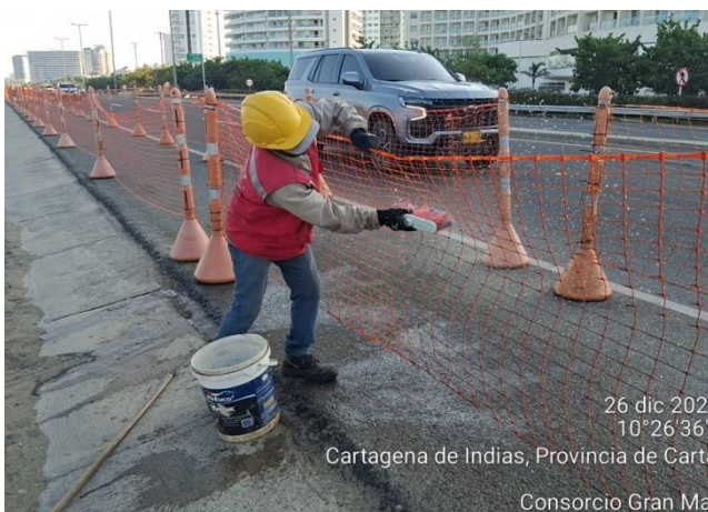
Mantenimiento de señalizaciones
