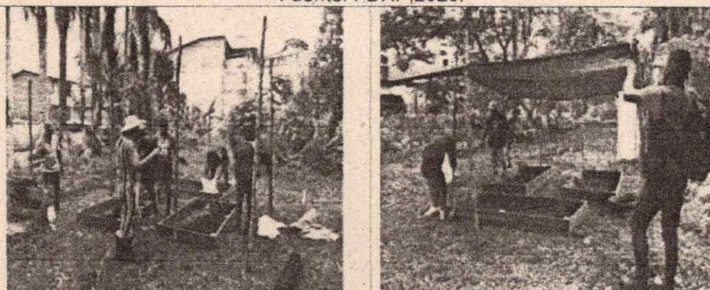
Imagen 89 y 90. Implementación De Ecotecnia en el Barrio Brisas del Mar Fuente: FDRP,2025.
