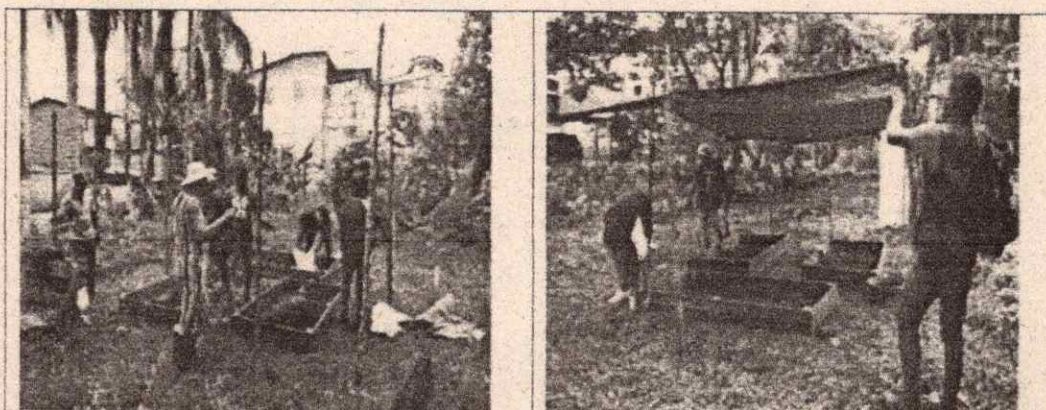
Imagen 77 y 78. Implementación De Ecotecnia en el Barrio Brisas del Mar Fuente: FDRP, 2025.
