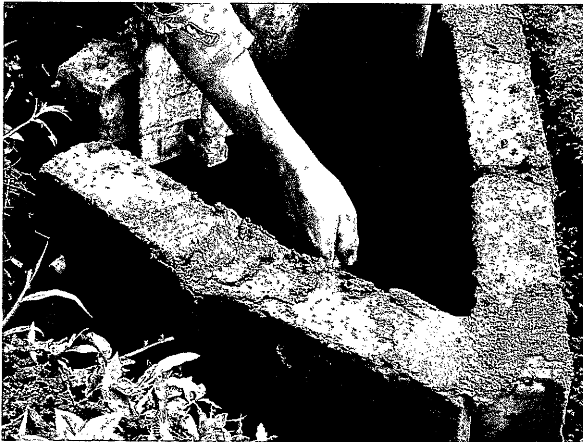
Construcción de cajuelas para los puntos de conexión rápida del sistema, por medio de válvulas de paso
