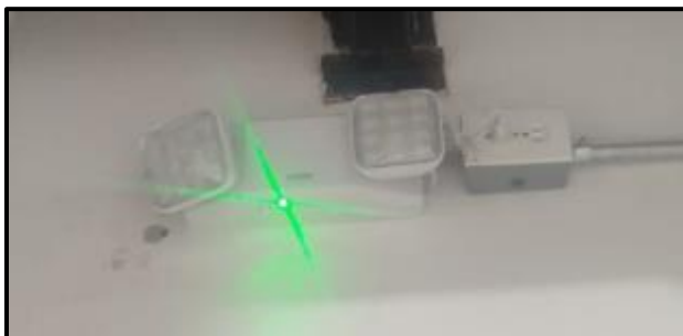
Ilustración 88 Instalación de lampara de emergencia piso 3
