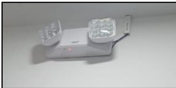
Ilustración 86 Instalación de lampara de emergencia piso 1
