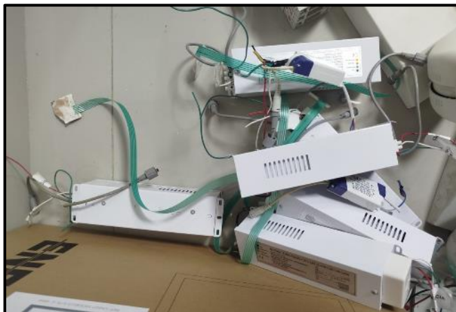
Ilustración 41 Retiro de cargadores y sensores en mal estado de las luminarias retiradas
