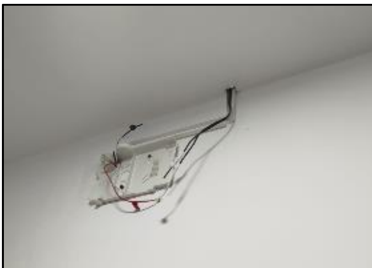
Ilustración 84 Retiro de Lámpara de emergencia a intervenir quinto piso
