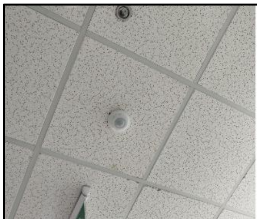
Ilustración 55 Instalación de nuevo sensor
