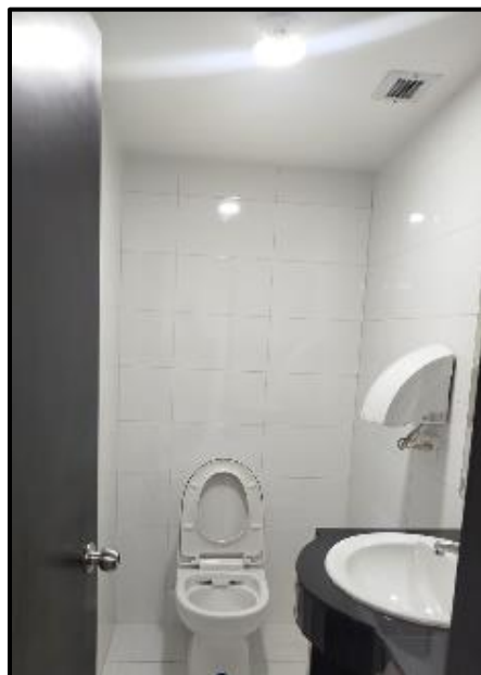
Ilustración 72 Luminaria instalada en baño de damas
