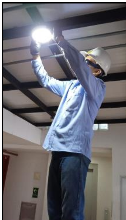
Ilustración 80 Instalación de luminarias
