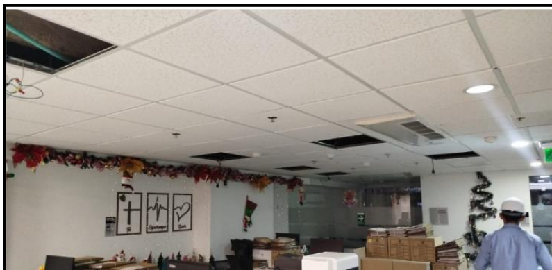
Ilustración 21 Retiro de paneles en zona de cobro coactivo
