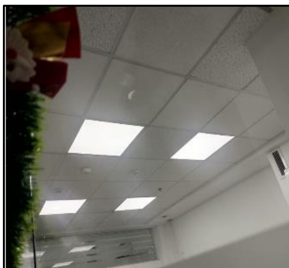
Ilustración 8 Instalación de panel en unidad de correspondencia
