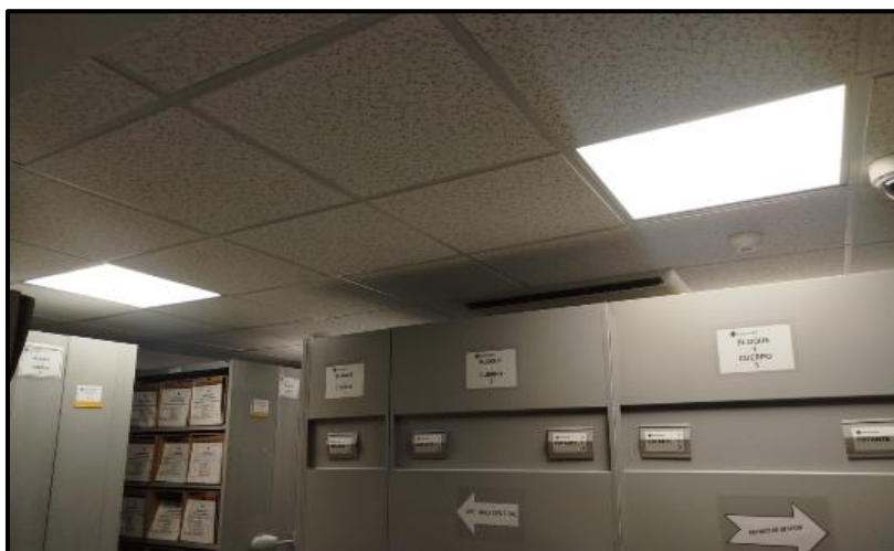
Ilustración 25 Instalación de paneles en archivo central y de gestión
