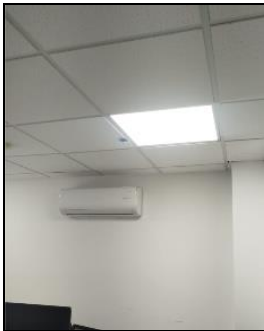
Ilustración 30 Instalación de panel en sala de juntas
