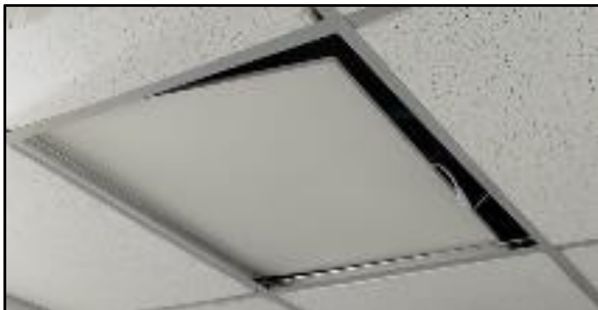
Ilustración 3 Panel a intervenir en zona de cafetería
