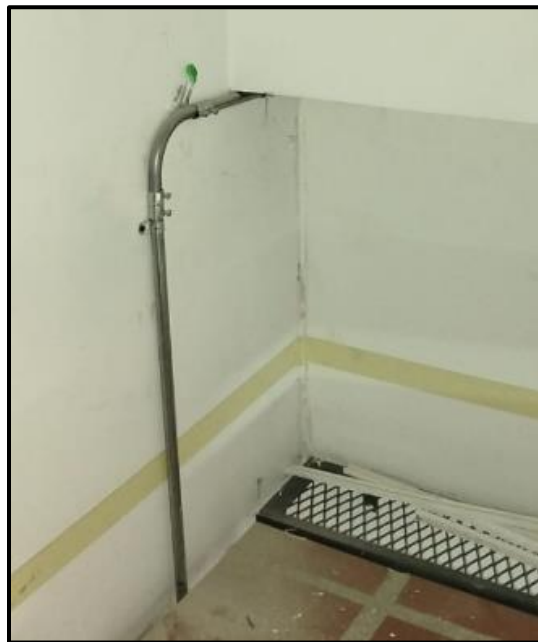
Ilustración 90 Instalación de tubera metálica para adecuación de conexiones
