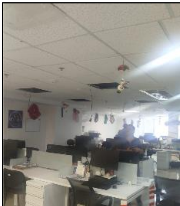
Ilustración 27 Retiro de paneles en zona de grupo delegado de vigilancia fiscal
