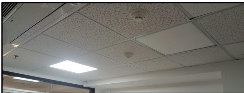
Ilustración 34 Panel a intervenir en contraloría provincial 1
