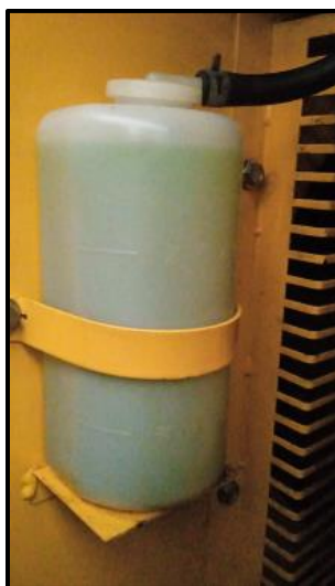
Ilustración 100 verificación del líquido refrigerante
