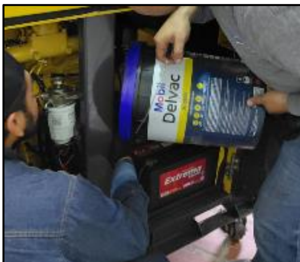
Ilustración 98 Cambio de aceite para el generador
