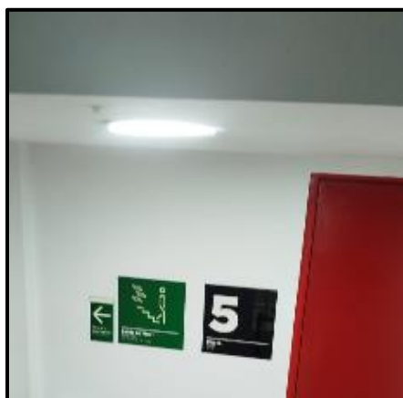
Ilustración 43 Instalación de luminaria en escaleras de emergencia piso 5
