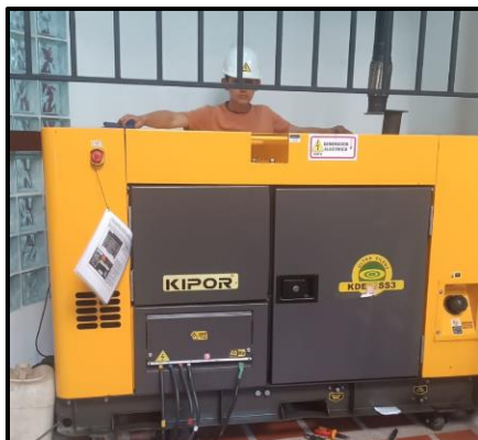
Ilustración 99 Limpieza externa del generador
