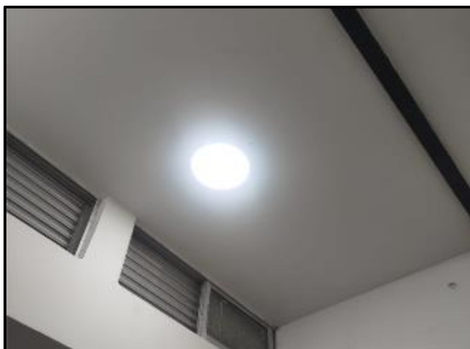
Ilustración 45 Instalación de luminaria en escalera de emergencia piso 7
