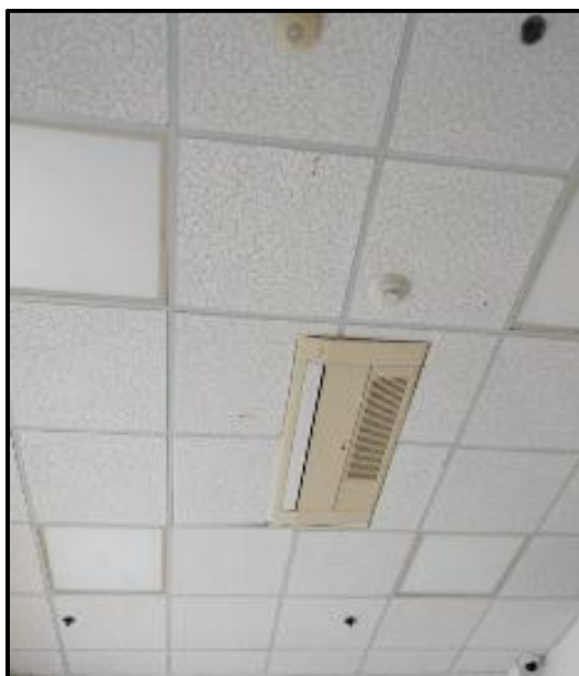
Ilustración 13 Paneles a intervenir en zona de coordinación de responsabilidad fiscal
