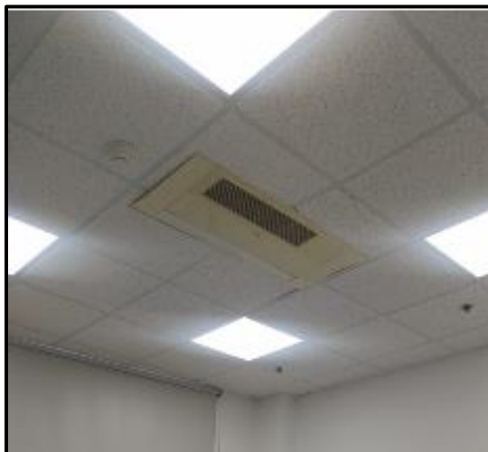
Ilustración 18 Paneles instalados en zona de coordinación de responsabilidad fiscal
