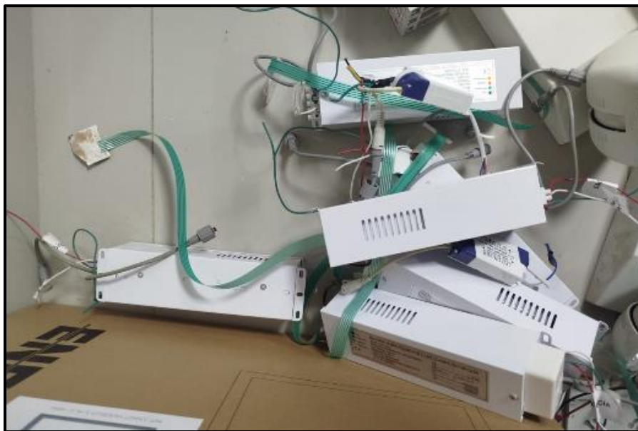
Ilustración 46 Retiro de cargadores y sensores en mal estado de las luminarias retiradas
