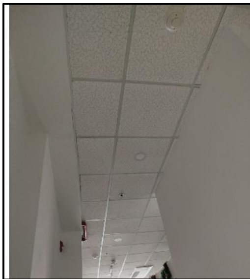
Ilustración 52 luminarias a intervenir en zona de pasillo
