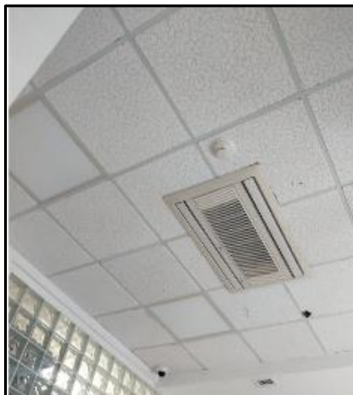
Ilustración 14 Paneles a intervenir en sala de video conferencia
