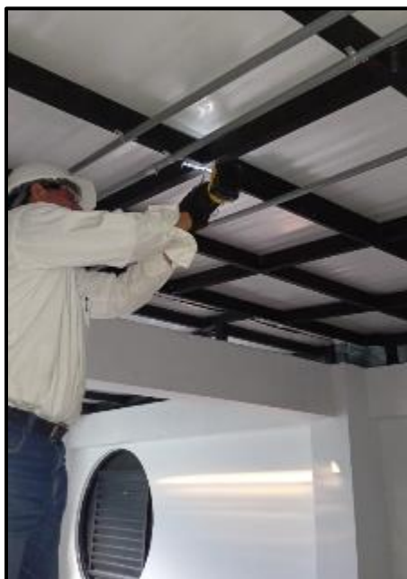
Ilustración 79 Instalación de soporte de luminarias
