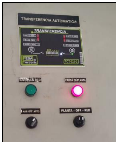
Ilustración 121 Visualización externa y verificación del funcionamiento de la transferencia electrónica automática
