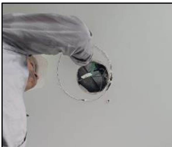
Ilustración 40 Adecuación del cielo raso mediante ampliación del vano para nueva luminaria.
