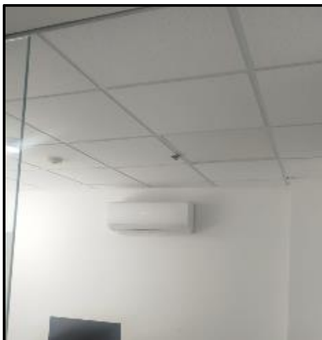
Ilustración 28 Panel a intervenir en zona de sala de juntas
