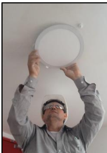
Ilustración 42 Instalación de luminaria en escaleras de emergencia piso 6
