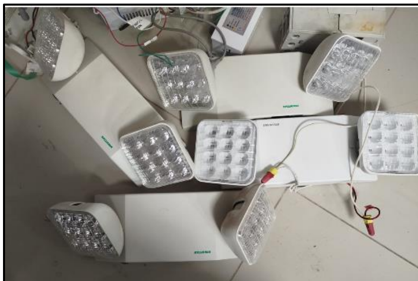
Ilustración 85 retiro de las lámparas de emergencia de los pisos (1,2,3,5)
