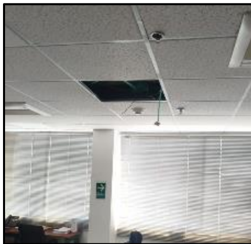
Ilustración 33 Retiro de panel en zona de gerencia departamental colegiada
