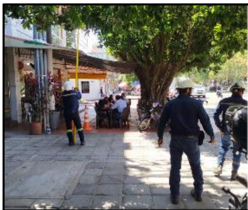
Ilustración 113 Cuadrilla de supervisión de Enerca
