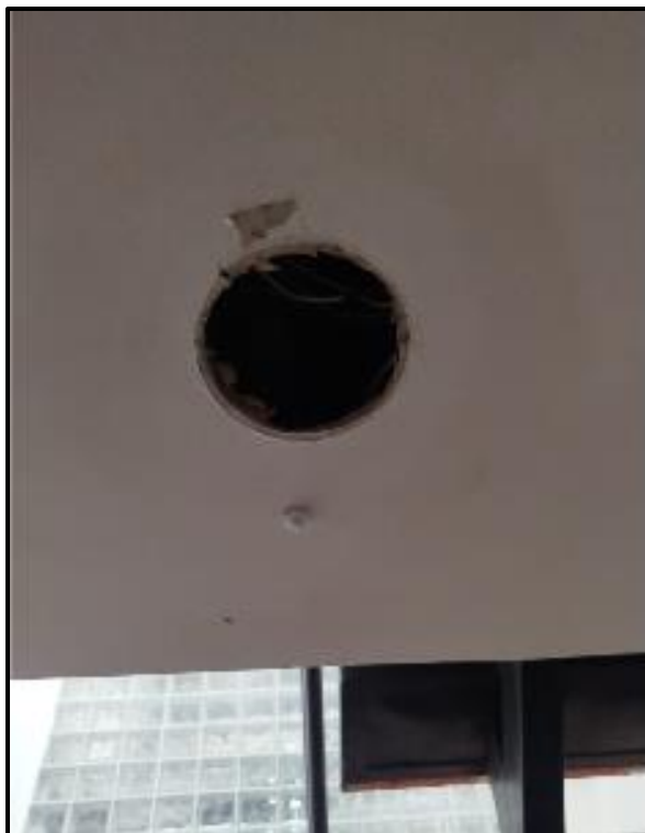
Ilustración 39 Retiro de luminaria de incrustar en escaleras de emergencia piso 5
