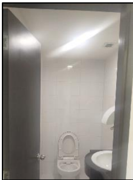
Ilustración 70 Luminaria a intervenir en baño de damas
