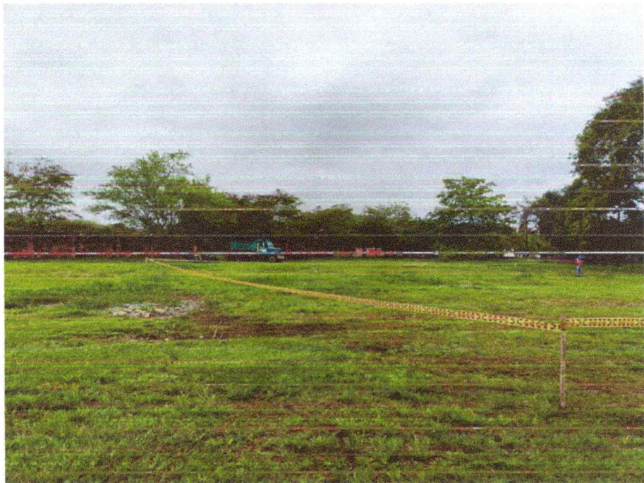
FOTO 3. Área del Proyecto, demarcada con cinta de seguridad y estacas.
